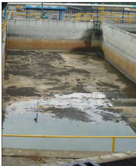
Figura 2.4. La generación de metano está relacionada con el tratamiento de aguas residuales, el cultivo de arroz y la fermentación entérica, entre otras actividades.
