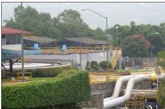
Figura 6.26. La infraestructura instalada para el tratamiento de las aguas residuales es insuficiente, además de que pocas de las plantas depuradoras incluyen el tratamiento y la disposición segura de los
