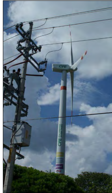
Figura 1.6. El desarrollo de tecnologías limpias y eficientes para la generación de energía permite la sustitución gradual de procesos basados en el consumo de combustibles fósiles (petróleo, gas y carbón). La seguridad energética y la disminución de las emisiones de bióxido de carbono presentan nuevos retos ambientales, económicos y estratégicos para las relaciones geopolíticas mundiales.
