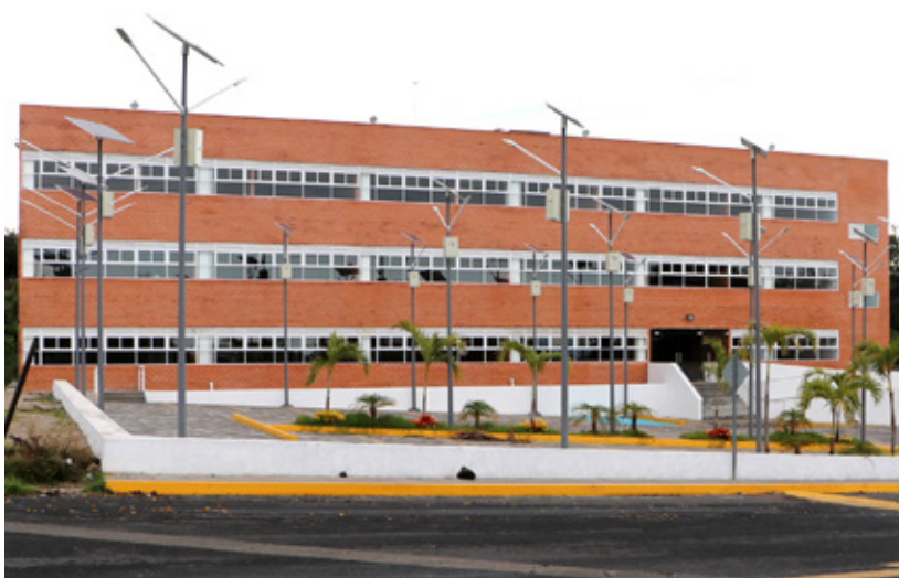
Edificio de la Facultad de Psicología de la máxima casa de estudios de Morelos.
