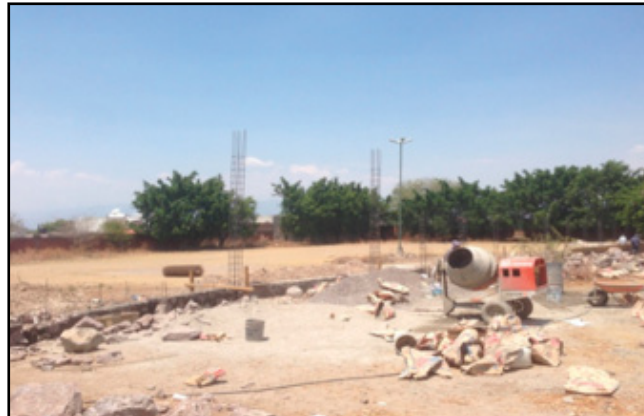
► Obra de construcción de las nuevas instalaciones de la Preparatoria No.3 Profesor Luis Ríos Alvarado, de Cuautla • Foto: Cortesía
