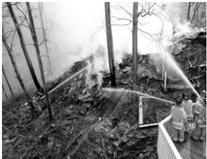
Daños posteriores a un incendio
