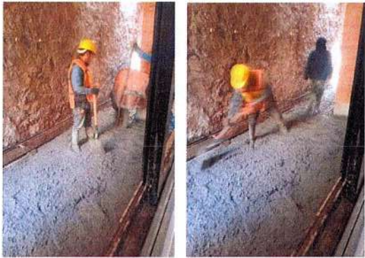
F93: Colado con concreto premezclado en pasillos exteriores
