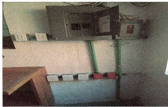
F85: Cambio de tablero, colocación de dimers, cambio de contactos
