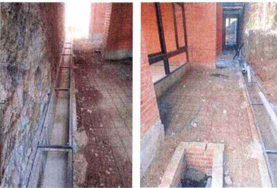
F94: Suministro y tendido de malla electrosoldada en pasillo
