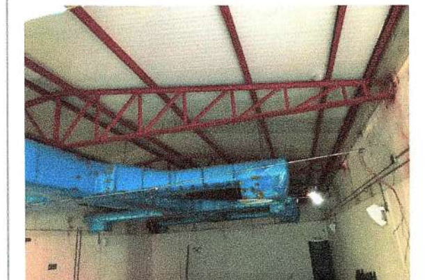
F23: Colocación de láminas multypanel
