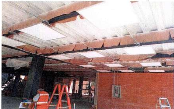
F49: Suministro y colocación de luminarias de 0.61 x 0.61 m
