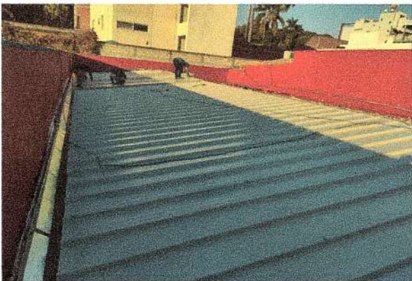
F21: Colocación de láminas multypanel
