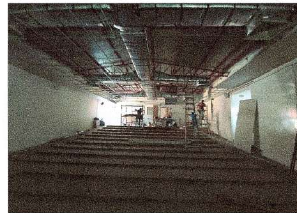
F37: Suministro y colocación de platabanda de tablaroca
