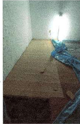
F34: Suministro y colocación de piso de duela en estrado
