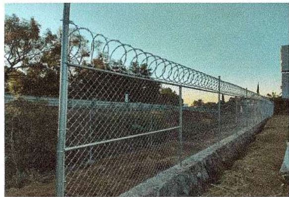
F25: Suministro y colocación de malla tipo ciclónica y cerca de navajas
