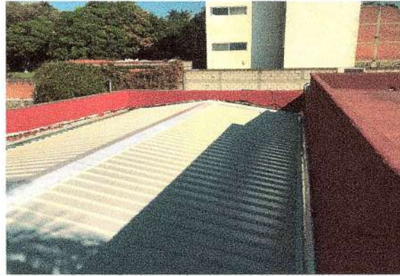
F79: Colocación de láminas multypanel
