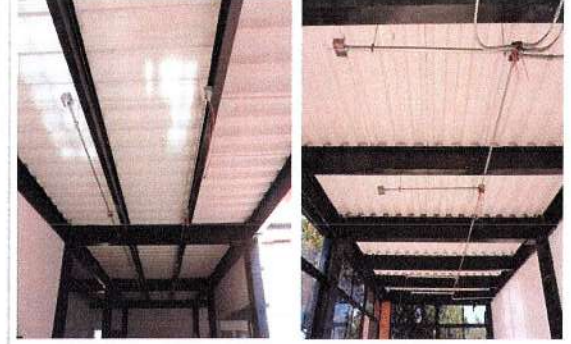
F131: Instalación eléctrica en salones.
