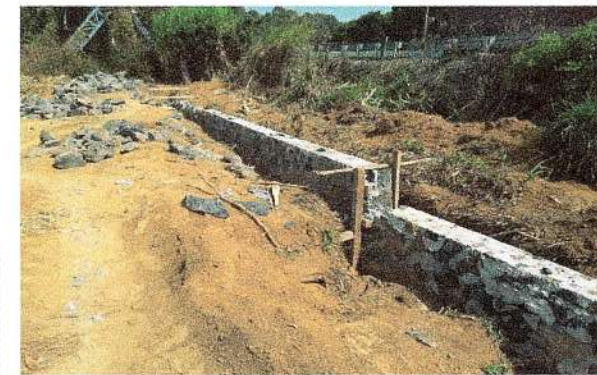
F13: Construcción de rodapie de mampostería
