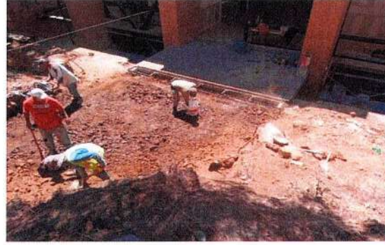
F112: Tendido de material en vestíbulo acceso principal
