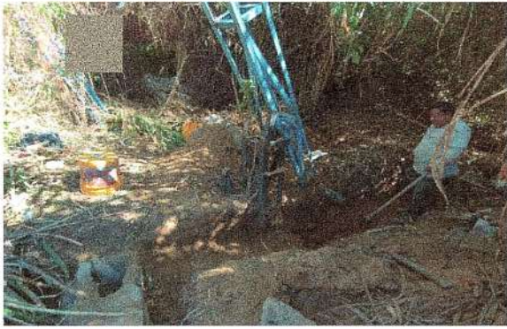
F14: Excavación de terreno
