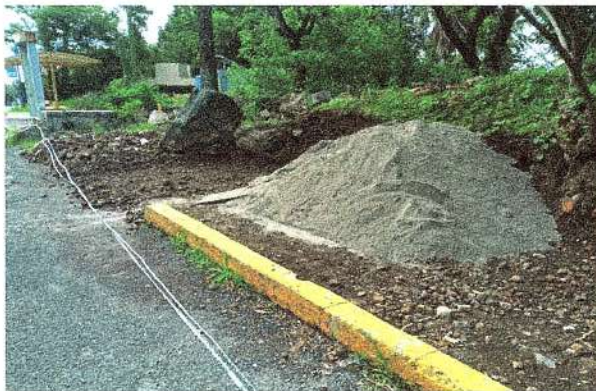
F33: Suministro de arena en área de andador.
