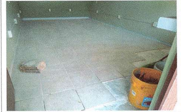
F8: Colocación de piso en sala de maestros.
