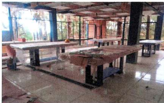
F76: Suministro y colocación de mesas de laboratorio
