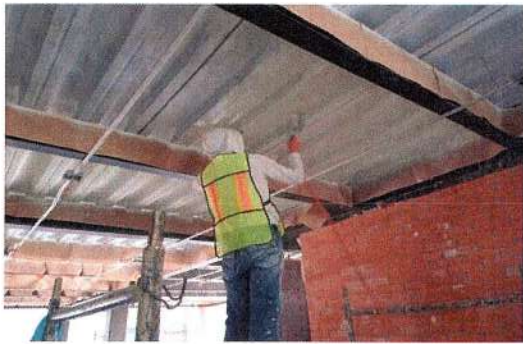
F42: Aplicación de pintura de esmalte en lámina losacero
