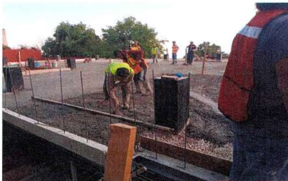
F22: Colado de entortado con concreto premezclado para dar pendientes
