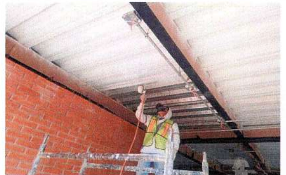
F41: Aplicación de pintura de esmalte en lámina losacero
