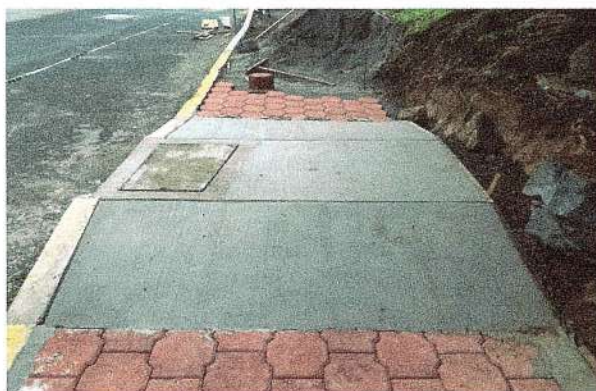
F39: Colado de rampa con concreto hecho en obra.
