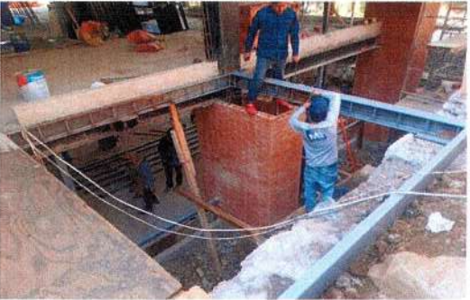
F36: Colocación de estructura metálica para puente
