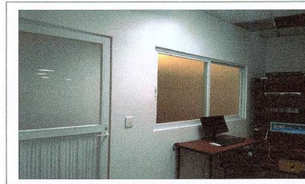
F11: Prueba de instalaciones eléctricas en cuarto de audio (apagador)
