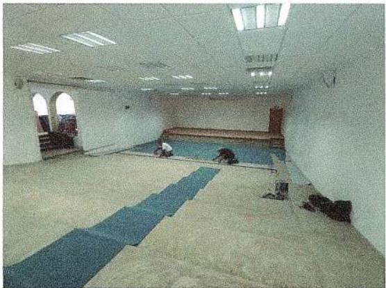
F66: Suministro y colocación de alfombra
