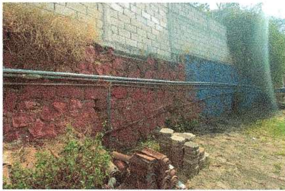
F84: Rehabilitación de instalación eléctrica para equipo de aire acondicionado
