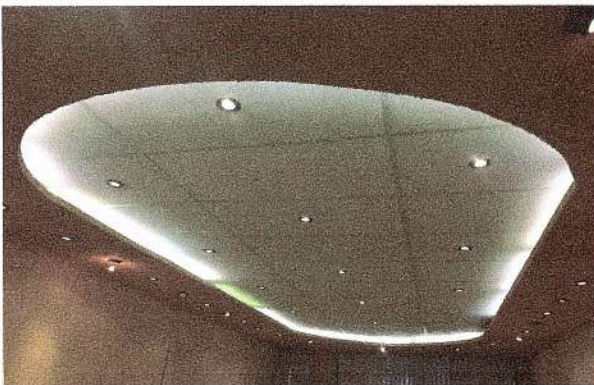
F11: Reemplazo de focos fundidos en auditorio
