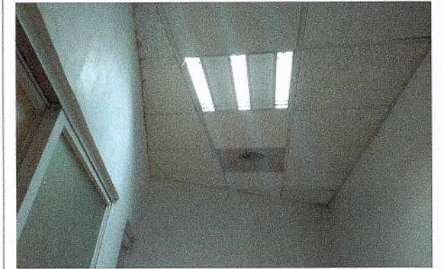
F23: Prueba de instalaciones eléctricas en vestidores (lámpara)
