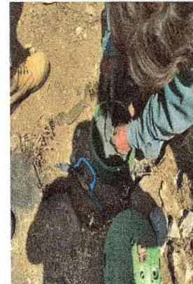
F49: Suministro y colocación de rehiletos para sistema de puesta a tierras
