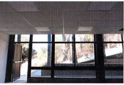
F153: Instalación de luminarias, plafón, colocación de cancelería en Auditorio.
