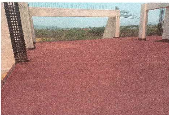
F3: Impermeabilización de Azotea.
