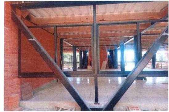
F104: Suministro y colocación de cancelería de aluminio negro
