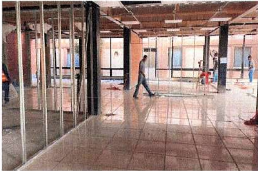
F51: Suministro y colocación de estructura metálica para muros divisorios de tablaroca
