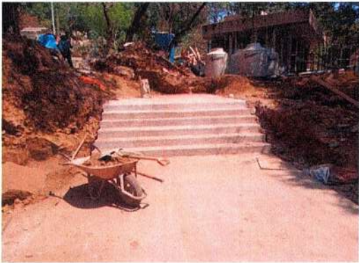
F114: Colado con concreto hecho en obra de escalones de andador de acceso principal
