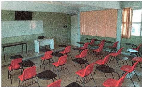
F13: Colocación de piso de loseta en salones.
