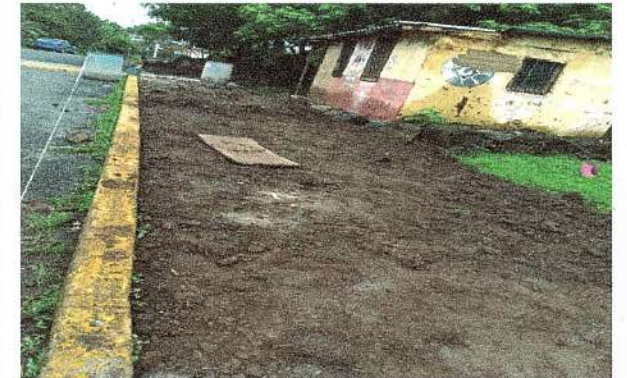
F28: Limpieza de terreno para habilitado de andador.
