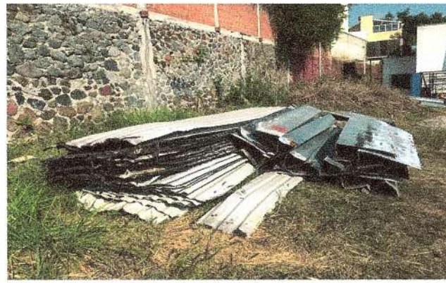
F7: Apilado de escombros de lámina y canalón desmontados
