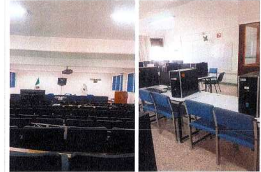
F8: 2 Sistemas de Aire Acondicionado de 3 Toneladas se ubicarán en el Auditorio del Edificio C Planta Baja. 2 Sistemas de Aire Acondicionado de 2 Toneladas se ubicarán en el Centro de Computo del Edificio C Planta Baja.
