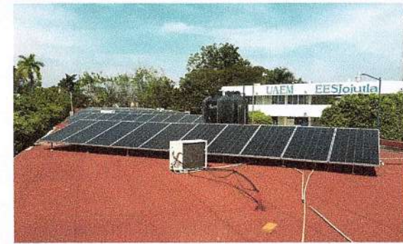
F23: Colocación de paneles solares
