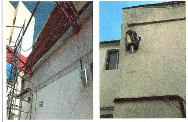
F17: Suministro y colocación de canal lateral
