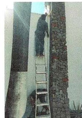
F56: Suministro y colocación de tubo de pvc de 4" para bajadas pluviales
