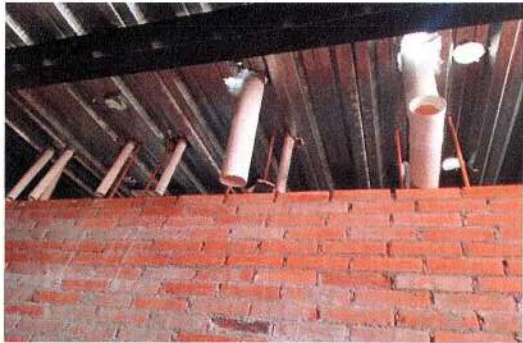
F27: Salidas de instalaciones hidráulicas y sanitarias
