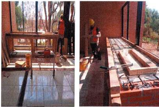
F60: Elaboración de barra de concreto en área de laboratorio
