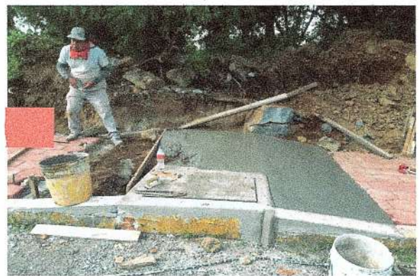
F38: Colado de rampa con concreto hecho en obra.
