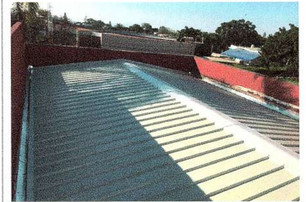
F80: Colocación de láminas multypanel
