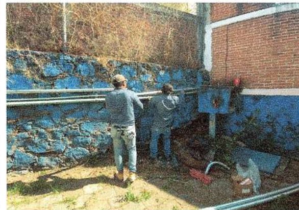
F58: Rehabilitación de instalación eléctrica para equipo de aire acondicionado
