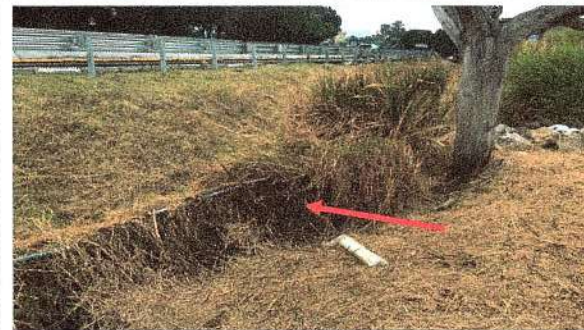
F4: Extremo sur de Mantenimiento de áreas perimetrales: retiro de malla existente deteriorada, deshierbe y limpieza del área, excavación y construcción de rodapie de mampostería de piedra, colocación de malla ciclónica con postes metálicos.
