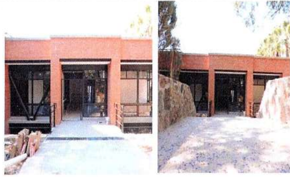
F157: Fachada principal Edificio del Centro de Investigaciones Biológicas (CIB), vestíbulo acceso principal con instalación de barandal.
