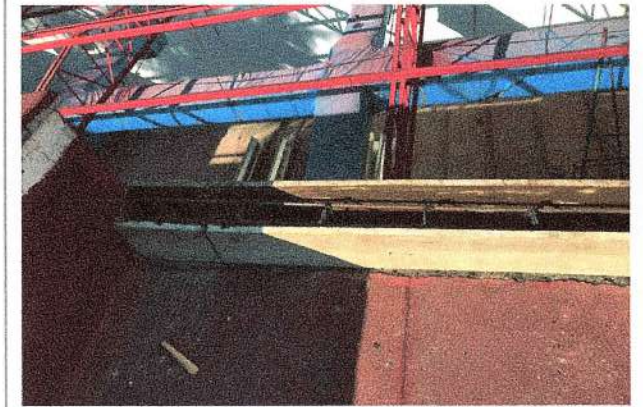
F11: Habilitado de acero y cimbra para cadena perimetral.
