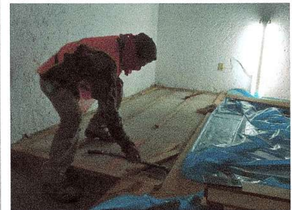
F32: Desmontaje de piso de duela dañado en estrado
