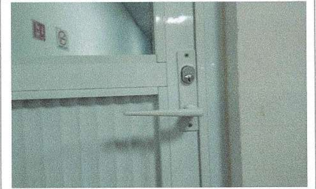
F17: Colocación de chapa en puerta de vestidores
