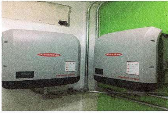
F15: Conexión y puesta en marcha de inversores de 10 kw para sistema fotovoltaico
