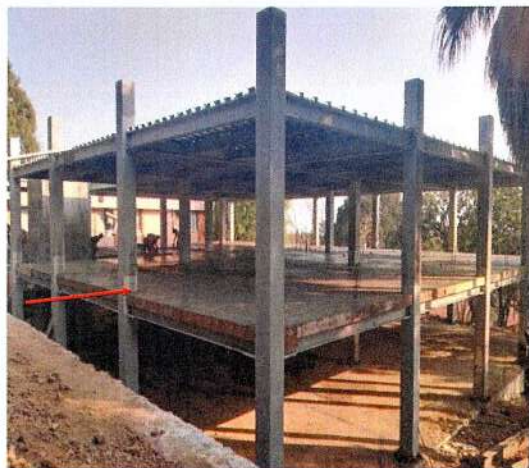
F1: Fachada Norte y Oeste - Construcción de la segunda etapa para la ampliación de laboratorios, cubículos de investigación, y oficinas académicas para el Centro de Investigaciones Biológicas antes CEIB (etapa final).
