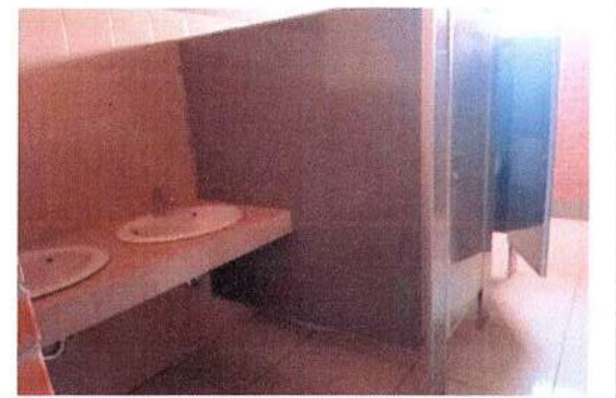
F146: Suministro y colocación de mamparas divisorias de sanitarios
