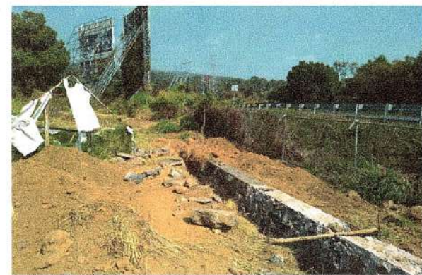
F10: Construcción de rodapie de mampostería
