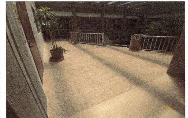
F49: Suministro y colocación de piso de loseta en pasillo de acceso.
