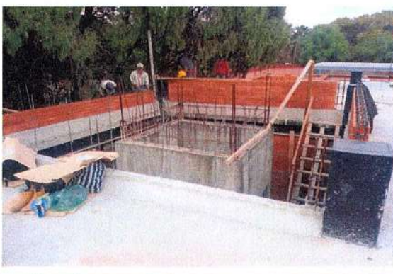
F85: Elaboración de pretil con ladrillo vintex en cubo de escalera
