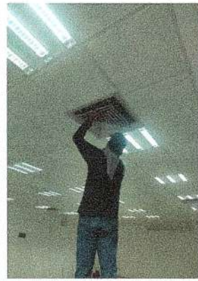
F64: Mantenimiento a equipo de aire acondicionado
