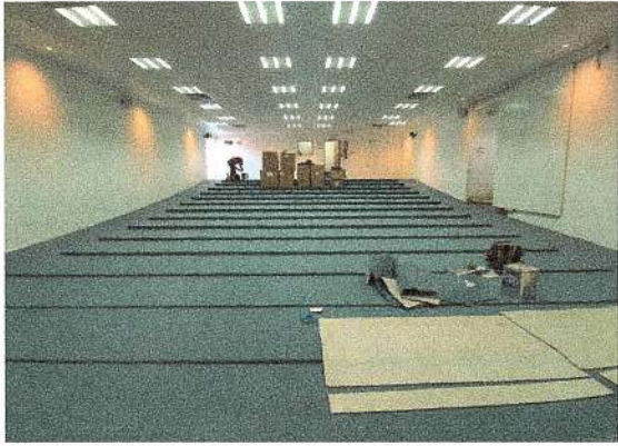
F69: Suministro y colocación de alfombra
