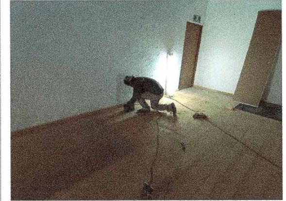
F35: Lijado de piso de duela como mantenimiento
