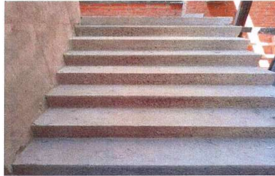
F148: Escalones con concreto hecho en obra acabado deslavadado
