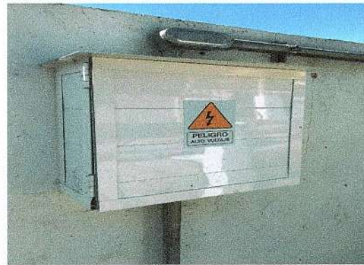
F19: Fabricación de nicho de aluminio para interruptor en caja moldeada de 3 polos por 100 amperes
