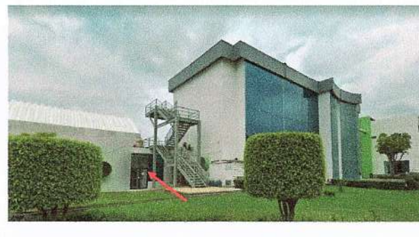
F2: Fachada lateral CIQ. Puerta de emergencia.
