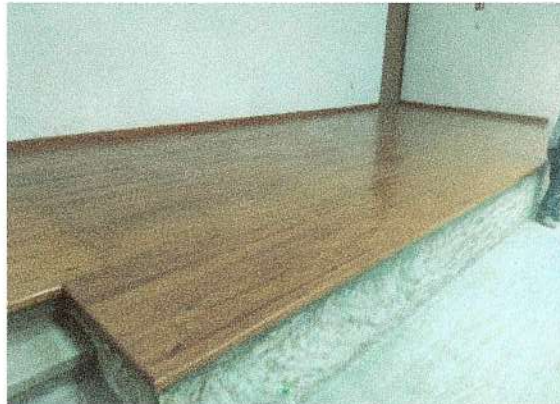
F82: Suministro y aplicación de barniz sobre piso de duela en estrado
