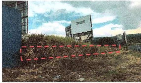
F2: Fachada Este, Mantenimiento en cerca perimetral con Autopista México-Cuernavaca.
