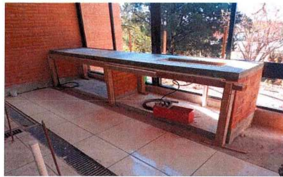
F61: Elaboración de barra de concreto en área de laboratorio
