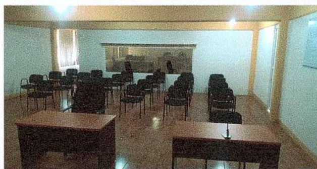
F17: Colocación de piso en sala de juicios orales.
