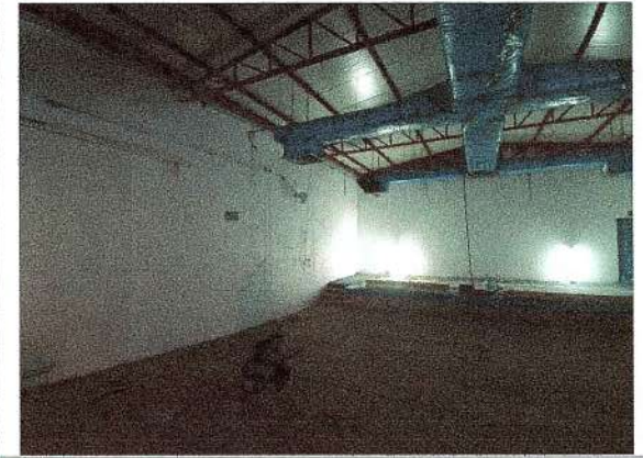
F26: Suministro y aplicación de pintura vinílica en muros interiores (primer mano)
