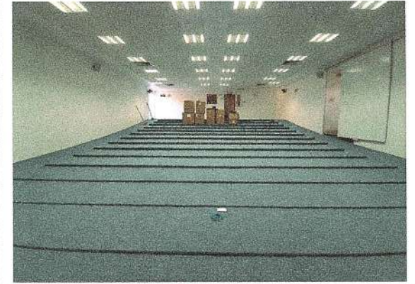
F71: Suministro y colocación de alfombra
