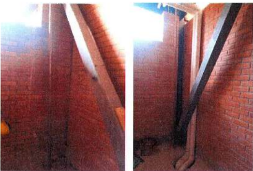
F30: Tendido de tubo de cobre para alimentación hidráulica
