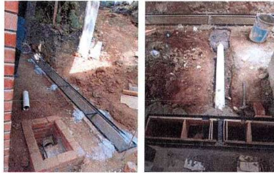
F70: Colocación de marco de herrería y conexión con tubo de pvc a canal pluvial
