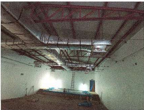
F30: Adecuación de instalación eléctrica
