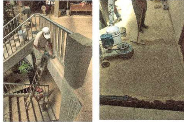
F18: Pulido de piso de granito en pasillo de acceso.
