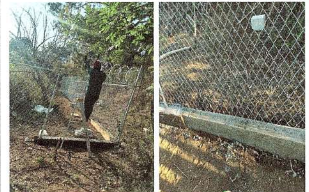
F22: Colado de cadena con concreto hecho en obra, suministro y colocación de malla tipo ciclónica y cerca de navajas
