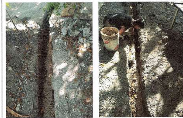
F8: Preparación de cepa con bentonita para sistema de puesta a tierra
