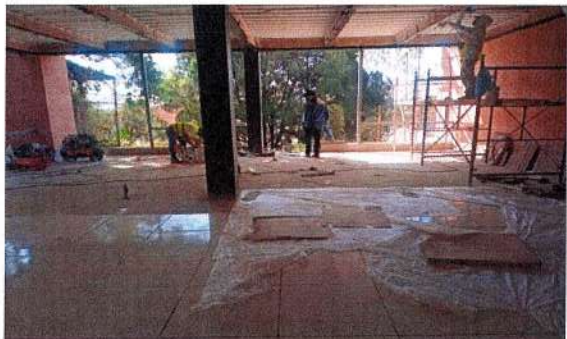
F46: Suministro y colocación de piso de loseta cerámica
