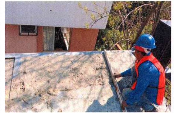
F14: Colado con concreto premezclado en volados
