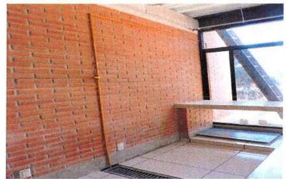
F140: Instalación de tubería de gas L.P.
