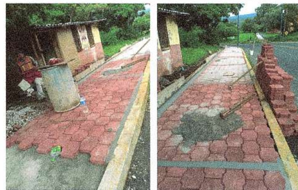
F30: Suministro y tendido de arena sobre adoqueros.
