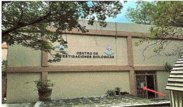
F1: Fachada principal del CIB.
