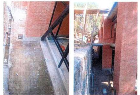
F95: Suministro y tendido de malla electrosoldada en pasillo
