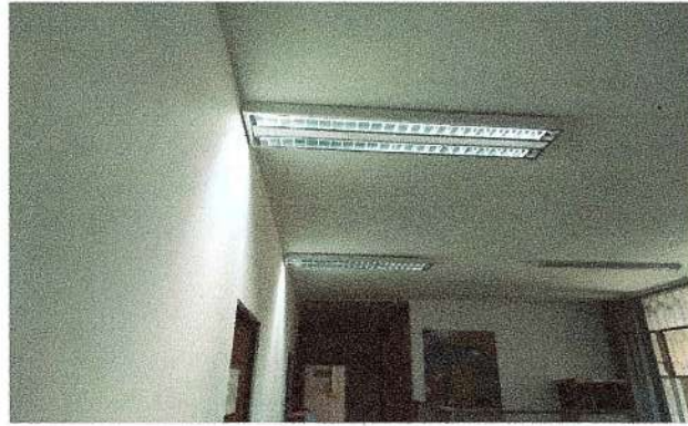
F9: Colocación de luminarias en cubículos
