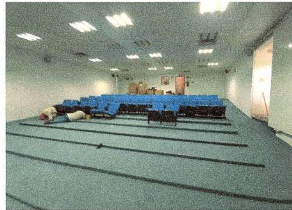
F73: Colocación de butacas retapizadas existentes
