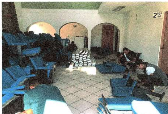
F52: Desmantelamiento de butaca existente para cambio de tapiz
