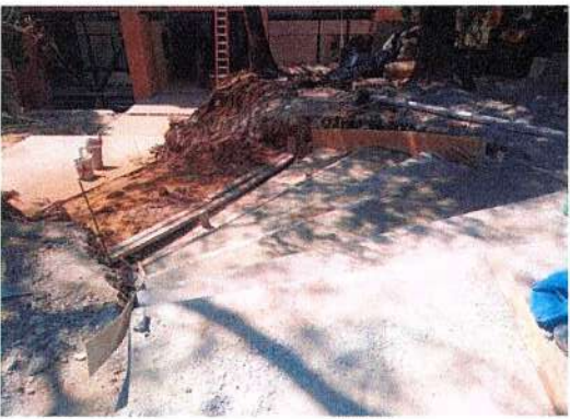
F117: Colado con concreto hecho en obra de escalones y descansos de andador de acceso principal
