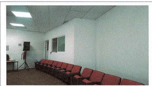
F13: Acabados en cuarto de audio (Colocación de puerta de aluminio, Aplicación de pintura, Colocación de ventana)
