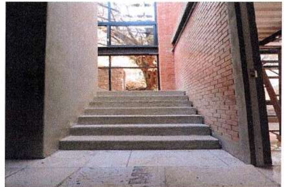
F142: Escalones con concreto hecho en obra acabado deslavado
