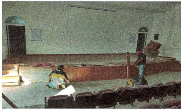
F6: Colocación de duela en estrado de auditorio.
