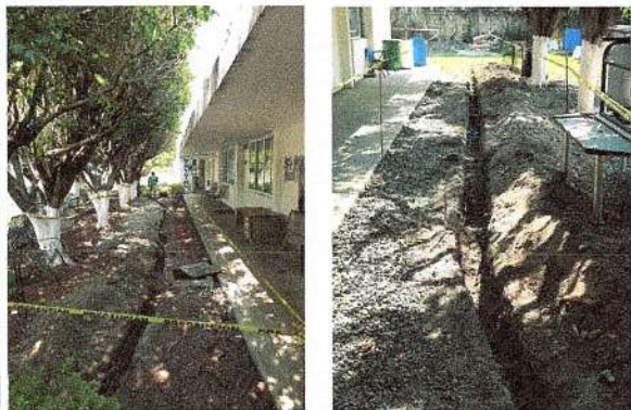
F6: Excavación para puesta a tierra de sistema fotovoltaico
