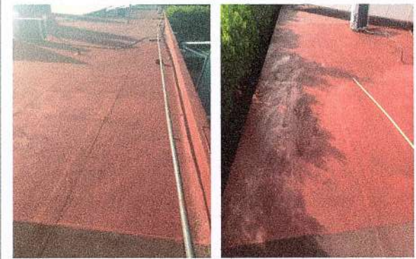
F20: Aplicación de impermeabilizante acrílico en losa de azotea de edificio B
