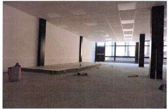
F128: Estrado de auditorio, colocación de cancelería, instalación de luminarias y plafón.
