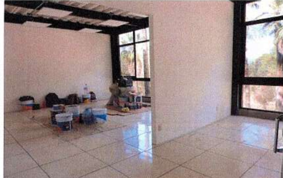
F125: Colocación de piso de loseta, muros divisorios de tablaroca y cancelería en color negro.
