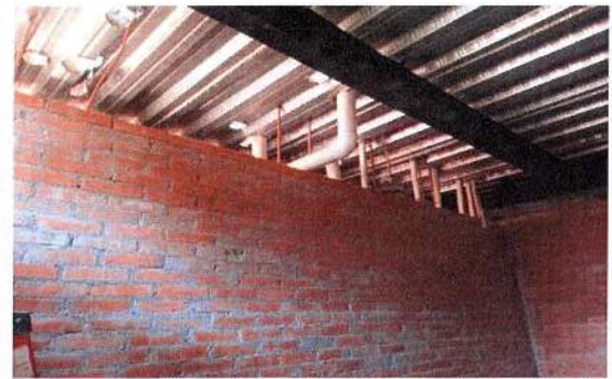
F29: Salidas de instalaciones hidráulicas y sanitarias
