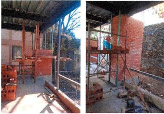
F6: Elaboración de muros vintex en columnas
