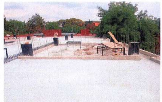
F59: Suministro y colocación de bases de herrería para tinacos
