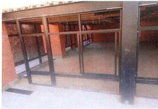
F105: Suministro y colocación de cancelería de aluminio negro
