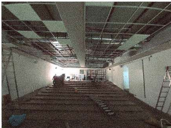
F39: Suministro y colocación de platabanda de tablaroca y plafon modular de 0.61 x 0.61 m
