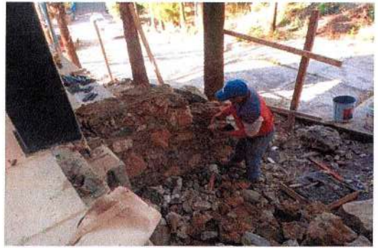
F72: Construcción de muro de contención en fachada poniente
