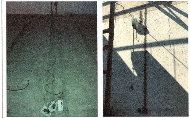
F14: Resane con concreto hecho en obra de ranuras para tuberías en muros y firme.
