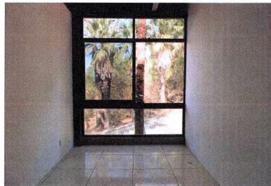
F144: Colocación de piso de loseta, marcos divisorios de tablaroca, aplicación de pintura y cancelería en color negro.
