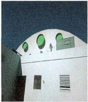
F6: Suministro y aplicación de pintura vitíca color blanco sobre muros.
