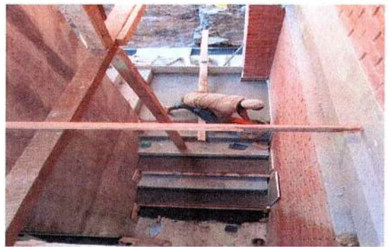
F100: Colado de escalones con concreto hecho en obra acabado deslavado
