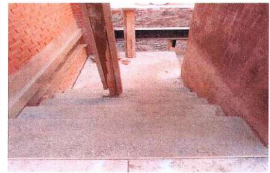
F101: Colado de escalones con concreto hecho en obra acabado deslavado
