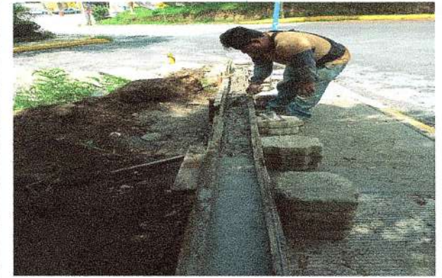
F25: Colado de guarnición de concreto hecho obra.
