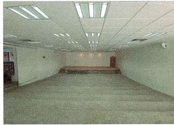
F46: Suministro y aplicación de pintura en muros (segunda mano)
