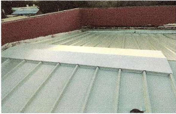
F78: Colocación de láminas multypanel
