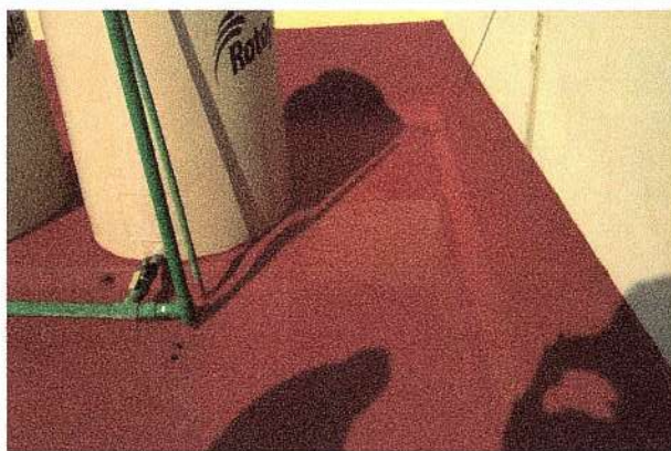
F10: Aplicación de impermeabilizante acrílico en losa de azotea
