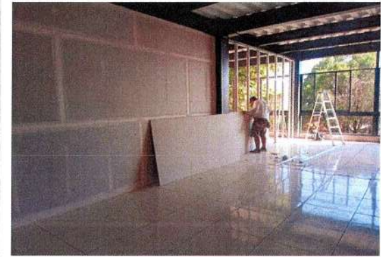
F89: Suministro y colocación de muro de tablaroca a dos caras
