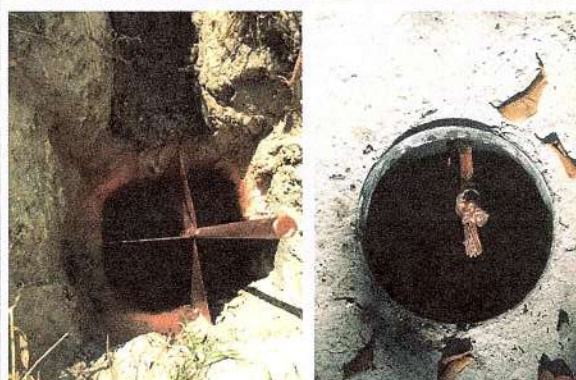
F10: Instalación de rehilete de cobre y elaboración de registro para medición de resistencia de sistema de puesta a tierra
