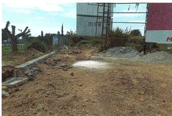
F9: Construcción de rodapie de mampostería
