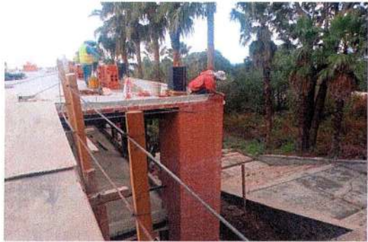
F81: Suministro y colocación de fachaleta vintex
