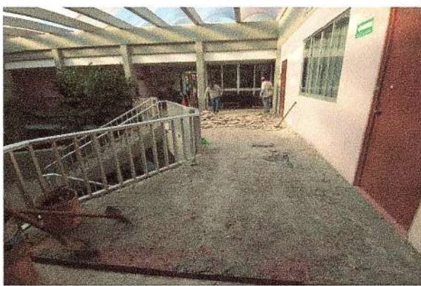
F12: Demolición de piso de granito existente en pasillo de acceso.
