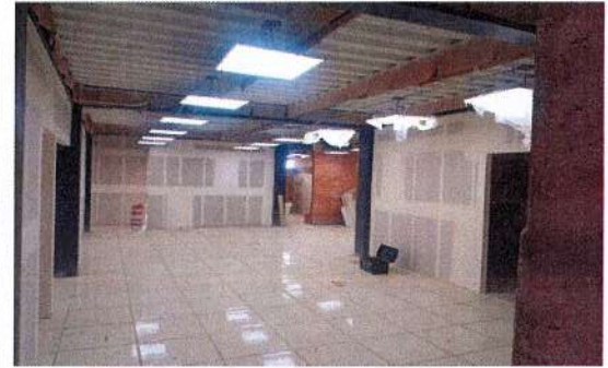
F56: Suministro y colocación de muros divisorios de tablaroca
