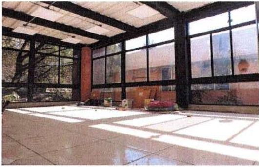
F129: Instalación de luminarias, colocación de cancelería y piso de loseta.
