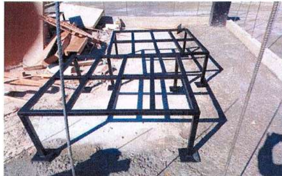
F58: Suministro de bases de herrería para tinacos
