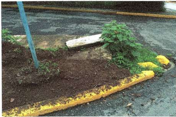
F23: Limpieza de terreno para habilitado de andador existente.
