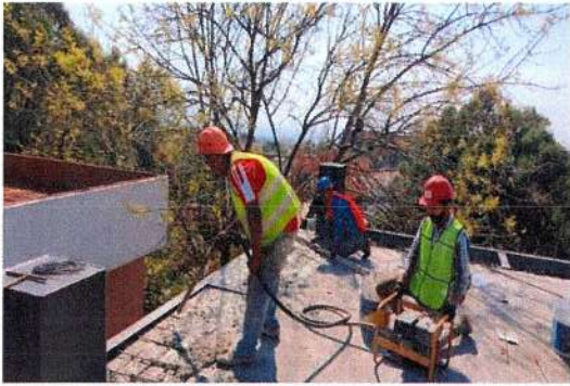
F15: Colado con concreto premezclado en volados
