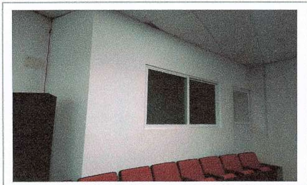
F9: Acabados en cuarto de audio (Colocación de puerta de aluminio, Aplicación de pintura, Colocación de ventana)
