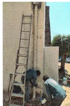
F57: Suministro y colocación de tubo de pvc de 4" para bajadas pluviales
