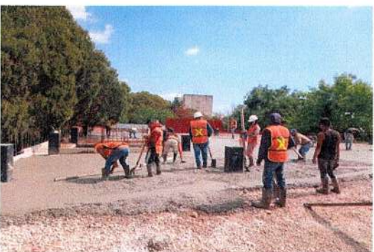
F21: Colado de entortado con concreto premezclado para dar pendientes
