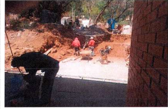
F113: Colado con concreto hecho en obra de vestíbulo de acceso principal
