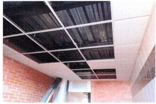
F110: Suministro y colocación de plafón modular de 0.61 x 0.61 m
