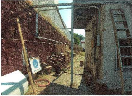
F60: Rehabilitación de instalación eléctrica para equipo de aire acondicionado
