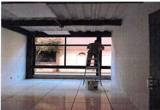
F126: Instalación de luminarias, colocación de cancelería y piso de loseta.
