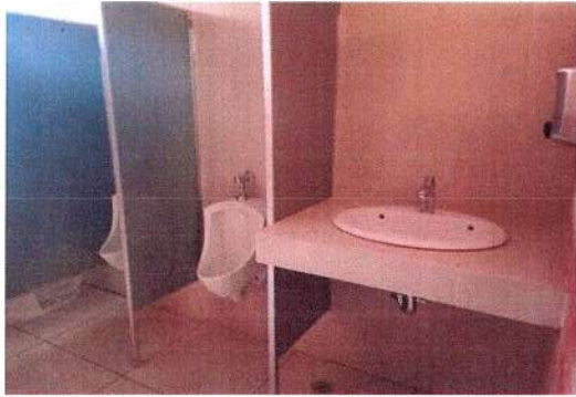
F147: Suministro y colocación de mamparas divisorias de sanitarios
