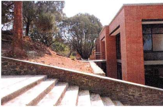
F159: Fachada principal Edificio del Centro de Investigaciones Biológicas (CIB), vestíbulo acceso principal con instalación de barandal.
