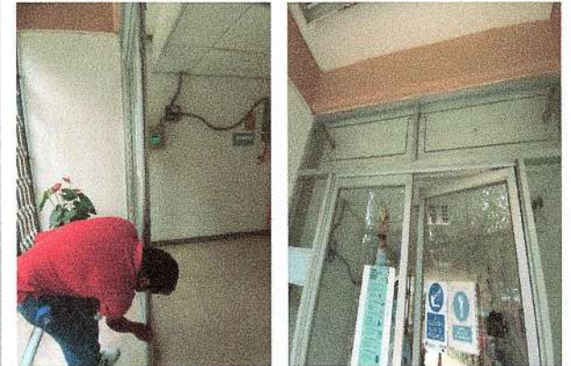
F22: Reparación de puerta de aluminio de acceso principal.
