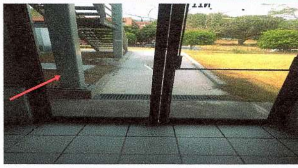
F4: Espacio interior hacia salida de emergencia
