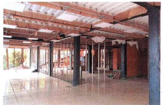
F50: Suministro y colocación de estructura metálica para muros divisorios de tablaroca
