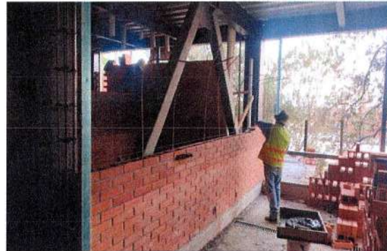
F7: Elaboración de muros vintex
