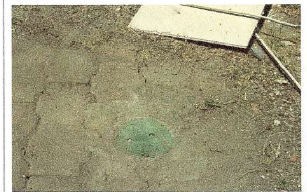
F86: Colocación de registros de sistema de puesta a tierras
