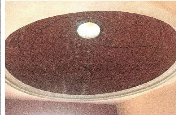
F4: Impermeabilización de Azotea y cupula
