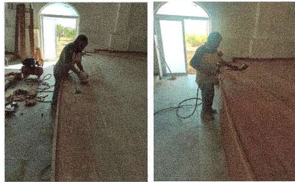
F7: Lijado de duela y aplicación de barniz sobre duela en estrado de auditorio.
