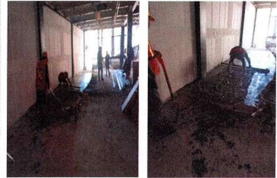
F98: Colado con concreto premezclado de estrado de auditorio
