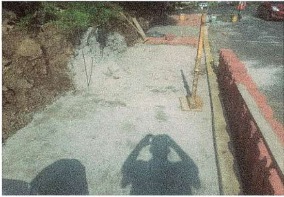
F41: Tendido de cama de arena y colocación de adocreto para andador.
