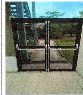
F8: Suministro y colocación de puerta de aluminio con barra antipánico de emergencia.
