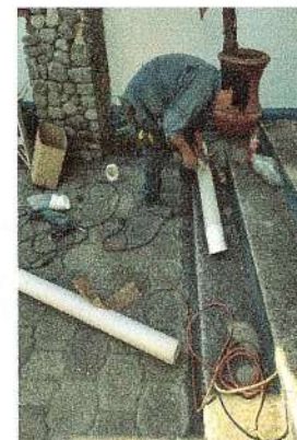
F56: Suministro y colocación de tubo de pvc de 4" para bajadas pluviales
