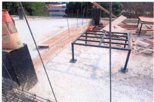
F57: Suministro de bases de herrería para tinacos
