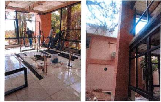
F62: Habilitado y colocación de cancelería de aluminio color negro
