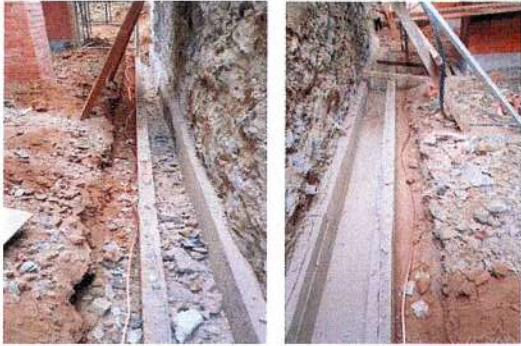
F33: Tendido de cable de cobre para sistema de puesta a tierra
