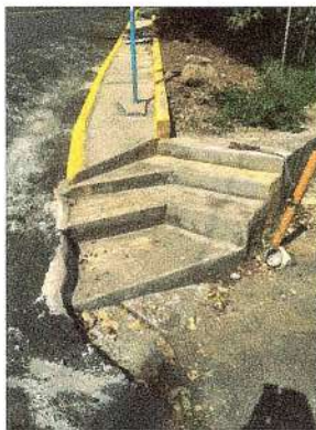
F51: Construcción de escalones de concreto hecho en obra.
