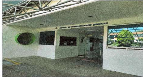
F7: Suministro y aplicación de pintura vitíca color blanco sobre muros.
