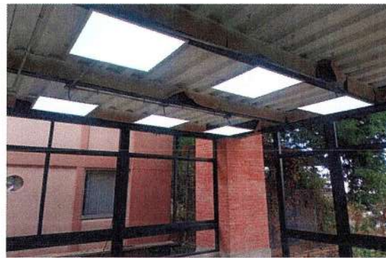
F79: Pruebas de instalación eléctrica en luminarias
