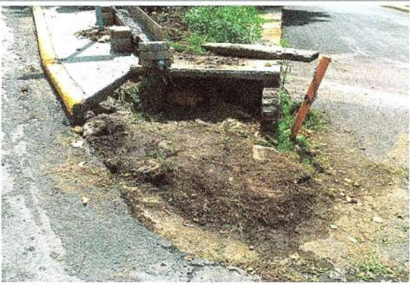
F9: Limpieza de área para elaborar escalones de concreto.
