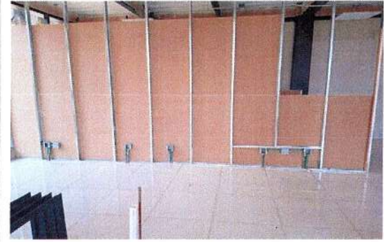
F53: Suministro y colocación de muros divisorios de tablaroca
