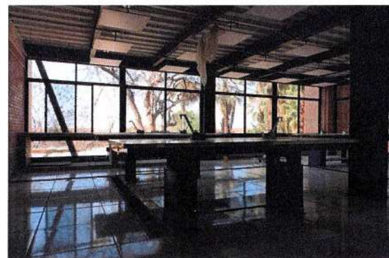
F136: Colocación de piso de loseta, luminarias, instalación de mesas de laboratorio y cancelería en color negro.
