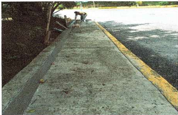
F26: Colado de guarnición y firme de banqueta de concreto hecho obra.
