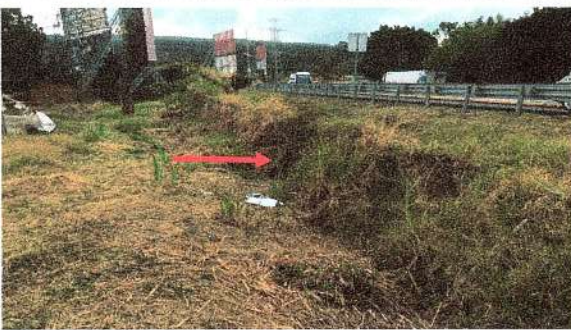
F3: Vista interior rea perimetral: retiro de malla existente deteriorada, deshierbe y limpieza del área, excavación y construcción de rodapie de mampostería de piedra, colocación de malla ciclónica con postes metálicos.
