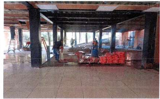
F44: Suministro y colocación de piso de loseta cerámica
