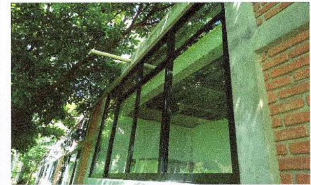
F29: Suministro y colocación de cancel en edificio de laboratorios.
