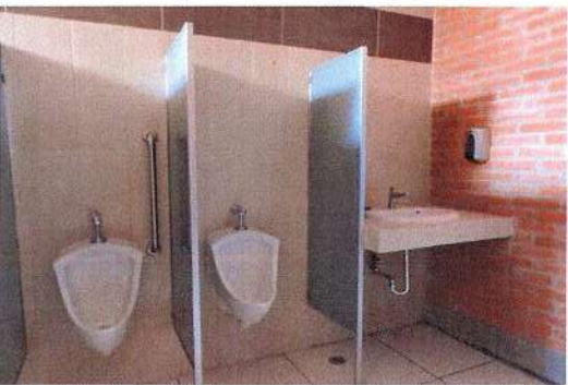
F150: Suministro y colocación de mamparas divisorias de sanitarios
