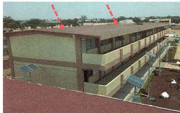
F2: fachada lateral de edificio donde se realizaran los trabajos
