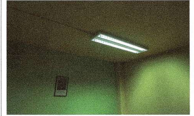
F10: Colocación de luminarias en cubículos
