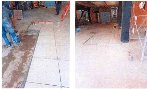
F43: Suministro y colocación de piso de loseta cerámica
