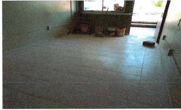
F7: Colocación de piso en sala de maestros.
