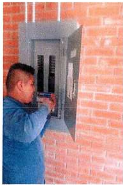
F78: Peinado de cables en tablero eléctrico
