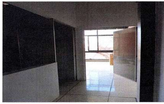
F154: Muros divisorios de tablaroca, colocación de piso de loseta, colocación de cancelería y puertas.
