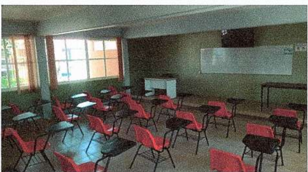
F16: Colocación de piso de loseta en salones.
