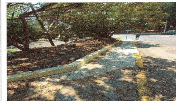
F58: Firme de banqueta de concreto hecho obra.
