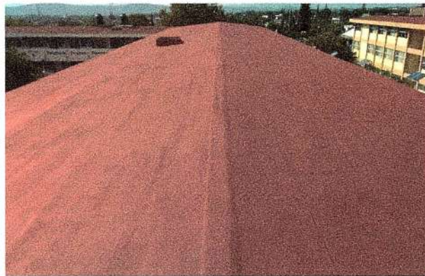
F7: Aplicación de impermeabilizante acrílico en losa de azotea
