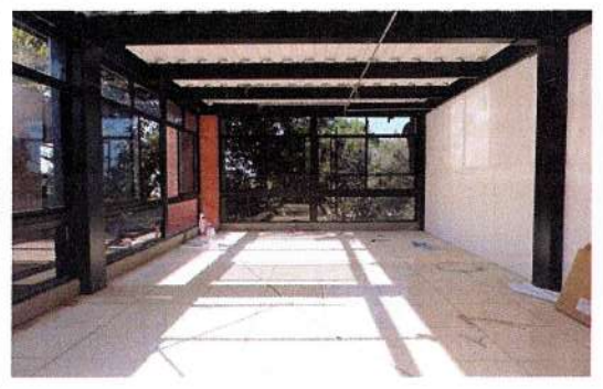
F152: Instalación de luminarias, colocación de cancelería y piso de loseta.
