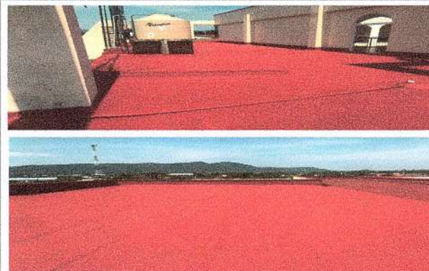
F10: Aplicación de impermeabilizante acrílico en losa de azotea.
