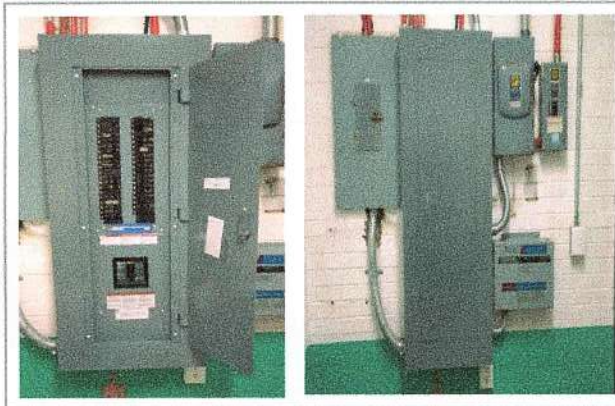
F17: Instalación de tablero general nuevo en planta alta
