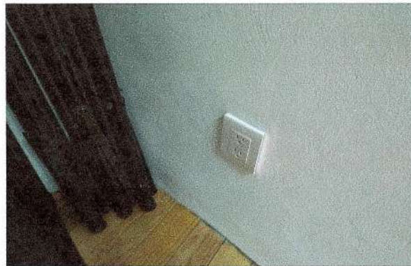
F21: Prueba de instalaciones eléctricas en vestidores (contactos)
