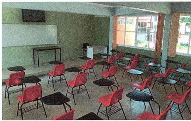
F11: Colocación de piso de loseta en salones.
