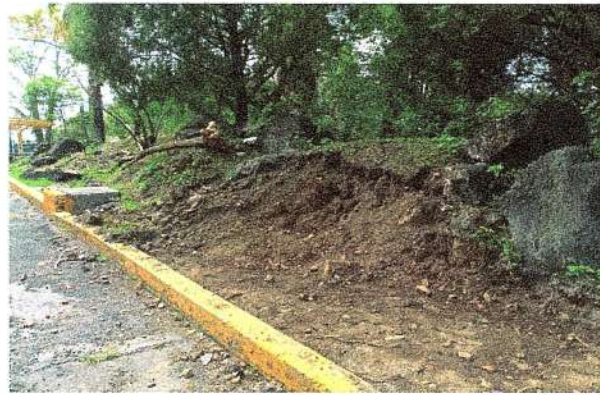
F24: Limpieza de terreno para habilitado de andador existente.
