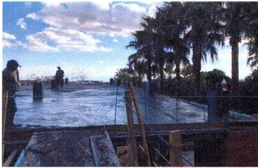
F24: Colado de entortado con concreto premezclado para dar pendientes
