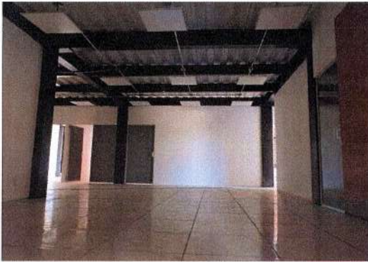
F132: Colocación de piso de loseta, luminarias, muros divisorios de tablarosa, aplicación de pintura blanca.
