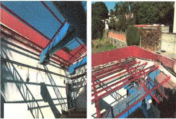
F18: Suministro y aplicación de impermeabilizante acrílico en pretil
