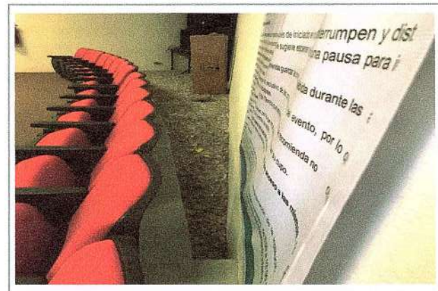
F8: Colocación de cancelería interior y exterior de aluminio así como suministro y colocación de puerta de aluminio
