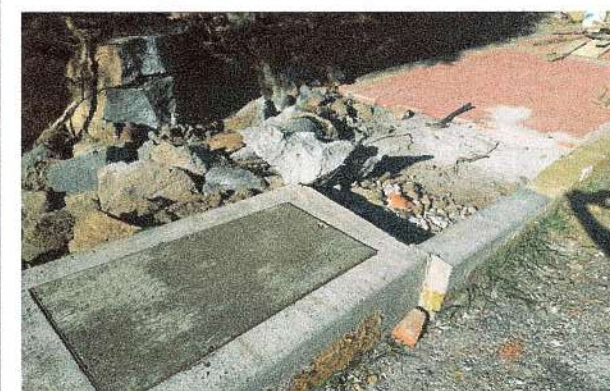
F37: Ajuste de altura de registros existentes.
