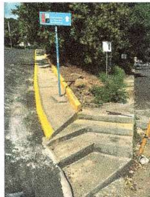
F51: Construcción de escalones de concreto hecho en obra.
