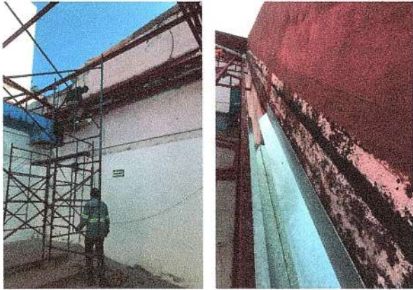
F15: Suministro y colocación de canal lateral
