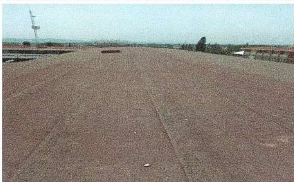
F3: Mantenimiento al Impermeabilizante del Edificio de la Unidad Académica.
