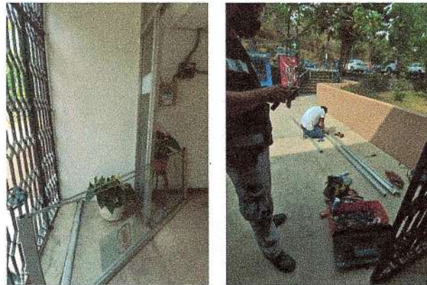
F21: Reparación de puerta de aluminio de acceso principal.
