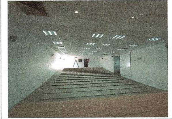
F47: Suministro y aplicación de pintura en muros (segunda mano)
