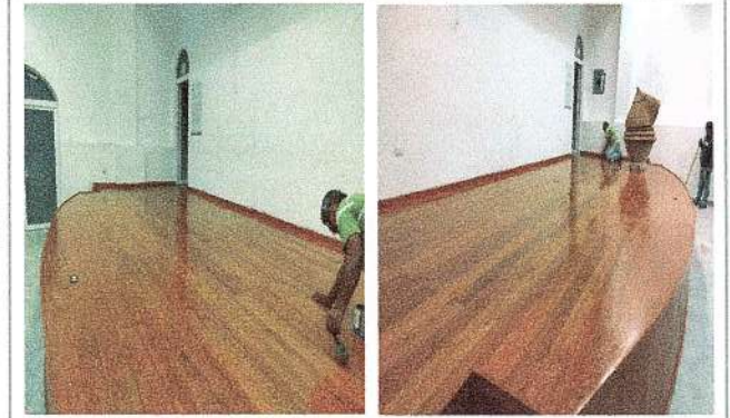
F8: Aplicación de barniz sobre duela en estrado de auditorio.
