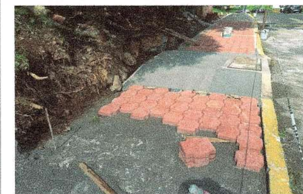
F40: Tendido de cama de arena y colocación de adoceto para andador.
