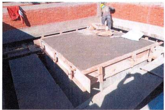
F99: Colado con concreto premezclado de losa de cubo de escaleras
