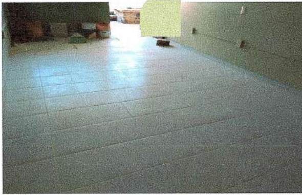
F6: Colocación de piso en sala de maestros.
