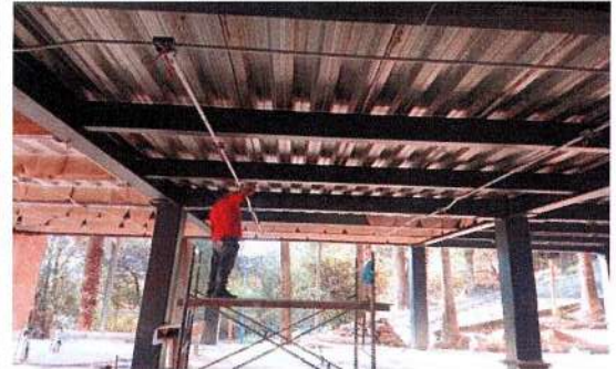
F38: Tendido de cable de cobre para instalación eléctrica
