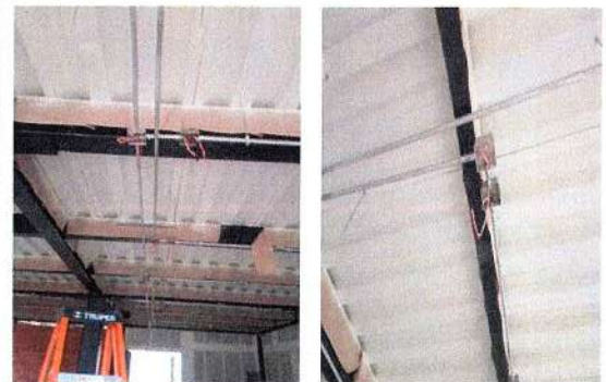
F77: Tendido de cable de cobre para instalación eléctrica
