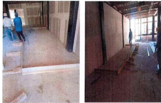
F97: Habilitado de cimbra para estrado de auditorio
