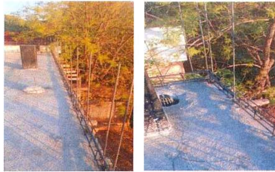
F16: Habilitado de acero de cadena perimetral
