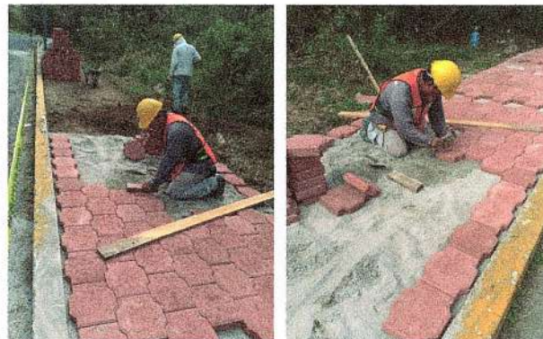
F27: Tendido de cama de arena y colocación de adoquero para andador.
