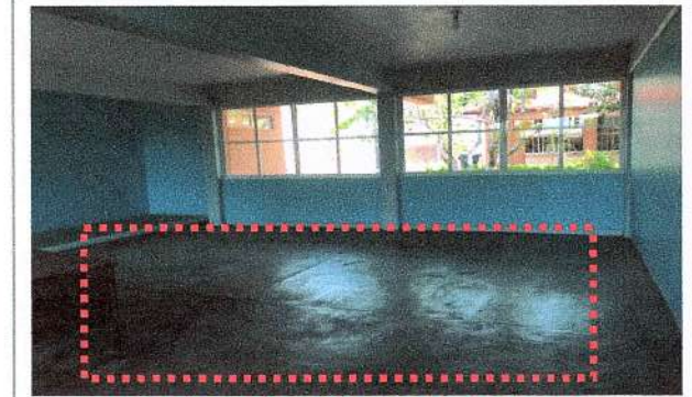
F5: Salón donde se colocará loseta.
