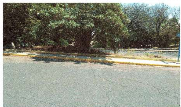
F56: Firme de banqueta de concreto hecho obra.
