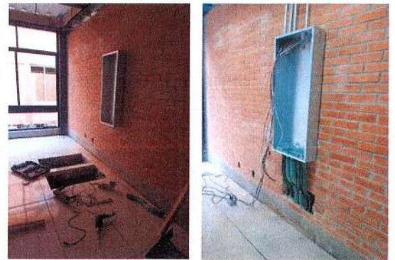
F68: Suministro y colocación de tablero eléctrico
