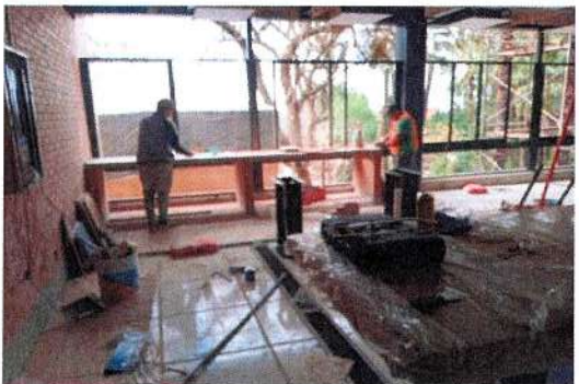
F75: Suministro y colocación de mesas de laboratorio
