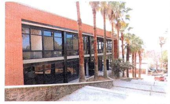
F158: Fachada lateral Edificio del Centro de Investigaciones Biológicas (CIB).
