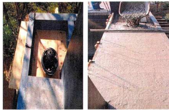
F13: Colocación de coladera de cúpula y colado con concreto premezclado en volados
