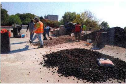
F18: Tendido de grava de tezontle para relleno de entortado en azotea
