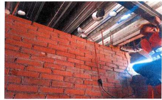
F26: Elaboración de muros de tabique rojo recocido
