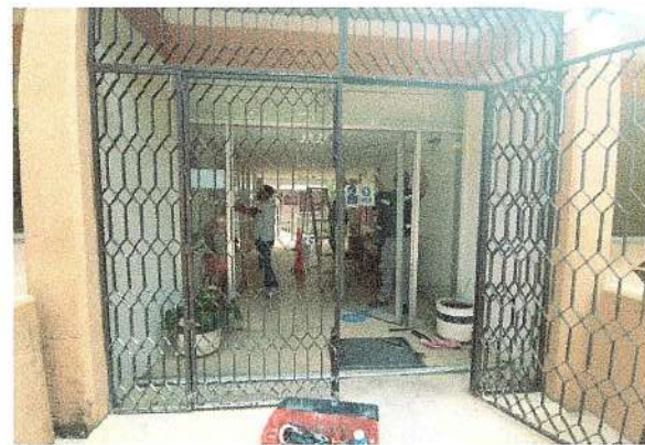
F20: Reparación de puerta de aluminio de acceso principal.
