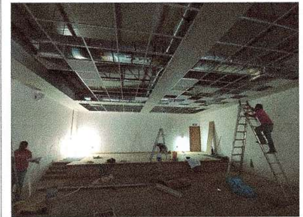
F38: Suministro y colocación de plafon modular de 0.61 x 0.61 m
