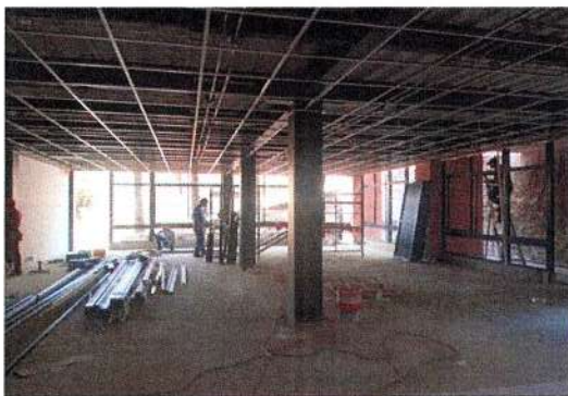
F108: Suministro y colocación de soportería de plafón modular de 0.61 x 0.61 m
