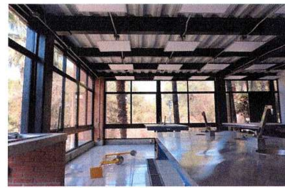
F133: Colocación de piso de loseta, luminarias, instalación de mesas de laboratorio y cancelería en color negro.
