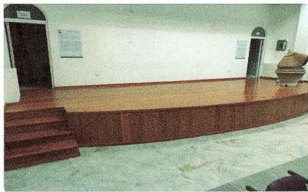
F16: Mantenimiento a duela (estrado de auditorio).
