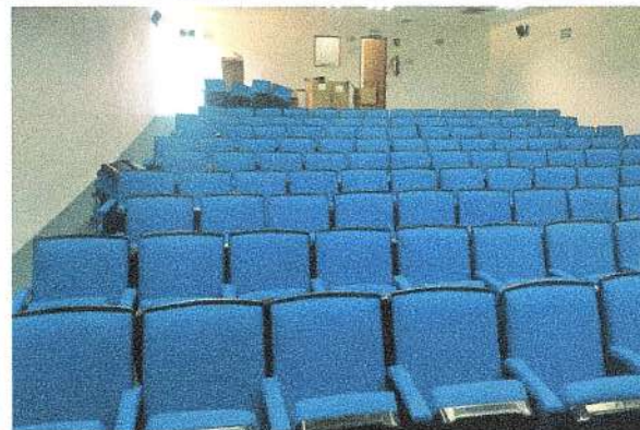
F76: Colocación de butacas retapizadas existentes
