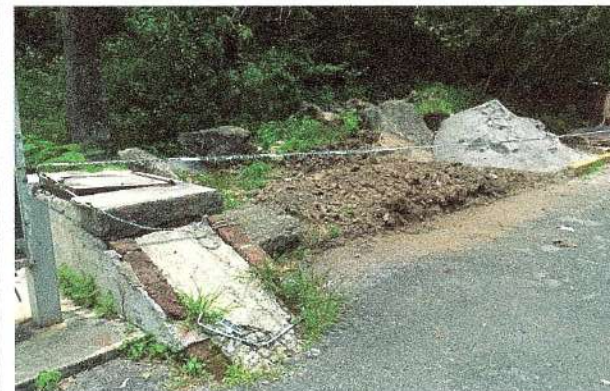
F34: Suministro de arena en área de andador.
