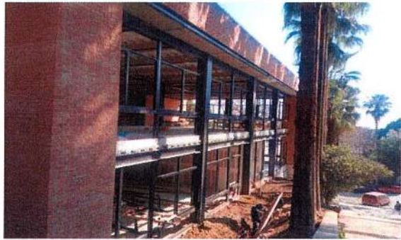
F64: Habilitado y colocación de cancelería de aluminio color negro
