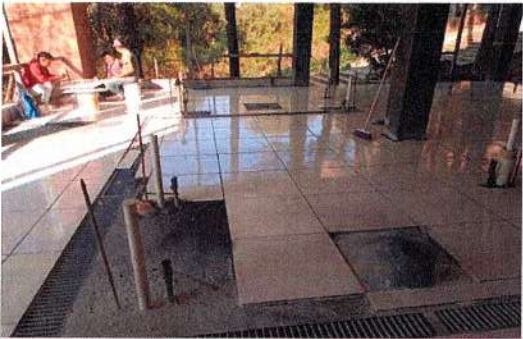
F45: Suministro y colocación de piso de loseta cerámica
