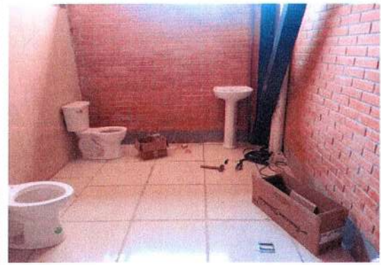
F119: Suministro y colocación de muebles de sanitarios (w.c., lavabos y mingitorios)
