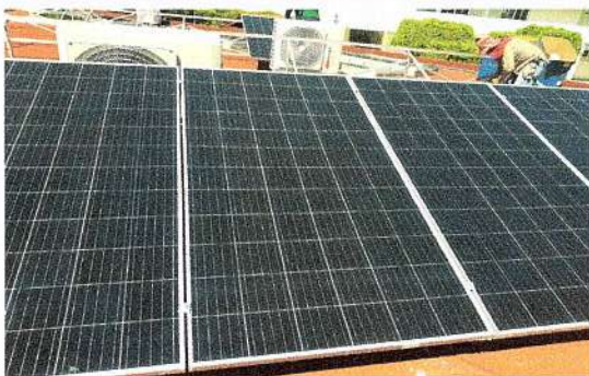
F21: Colocación de paneles solares
