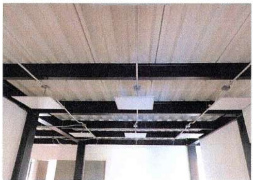
F135: Instalación de luminarias, en pasillos, área de laboratorios.
