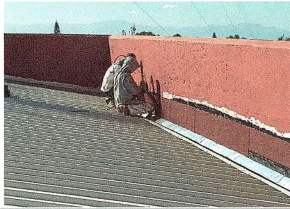
F25: Suministro y colocación de impermeabilizante prefabricado en pretel
