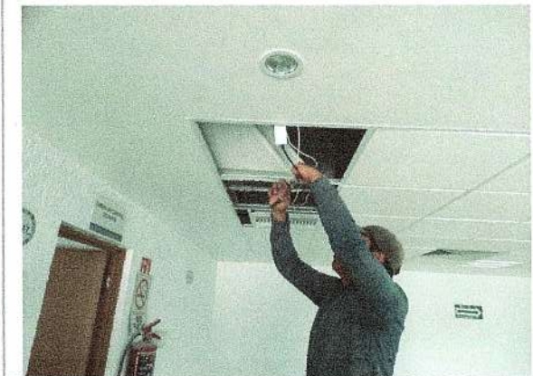
F41: Suministro y colocación de luminarias (diferentes modelos)
