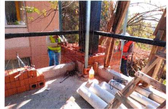
F8: Elaboración de muros vintex en columnas
