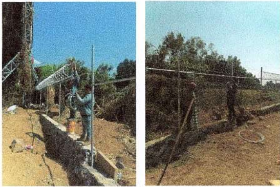
F17: Suministro y colocación de cerca de navajas (concertina)
