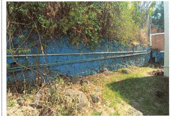
F83: Rehabilitación de instalación eléctrica para equipo de aire acondicionado
