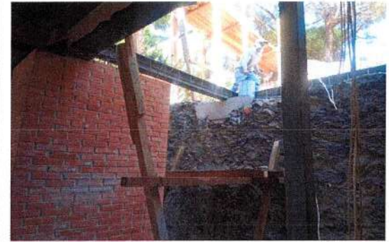
F35: Colocación de estructura metálica para puente
