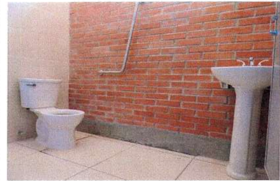
F149: Suministro y colocación de mamparas divisorias de sanitarios
