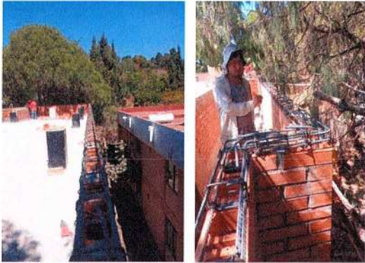
F87: Habilitado de acero para cadena de enrase en pretil
