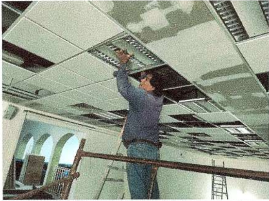
F42: Suministro y colocación de luminarias (diferentes modelos)
