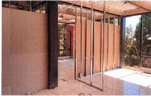
F54: Suministro y colocación de muros divisorios de tablaroca
