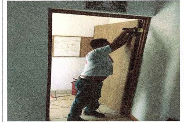
F65: Suministro y colocación de puertas de cabinas de audio
