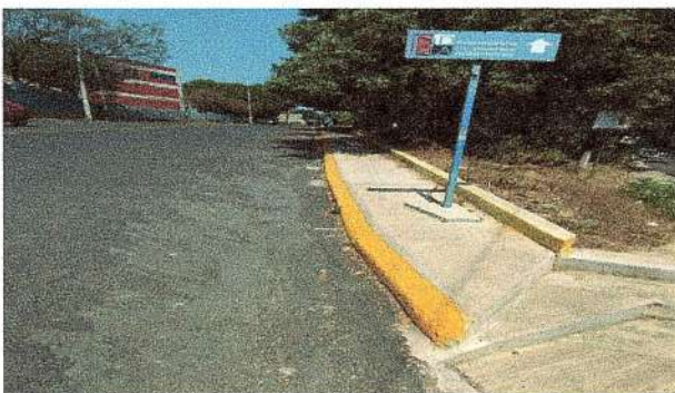
F57: Firme de banqueta de concreto hecho obra.
