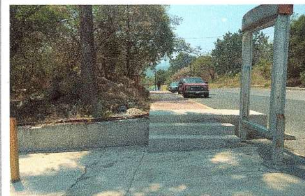
F52: Escalones con concreto hecho en obra.
