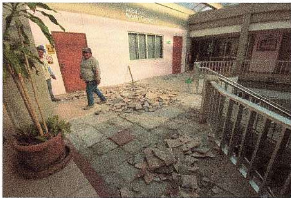
F11: Demolición de piso de granito existente en pasillo de acceso.
