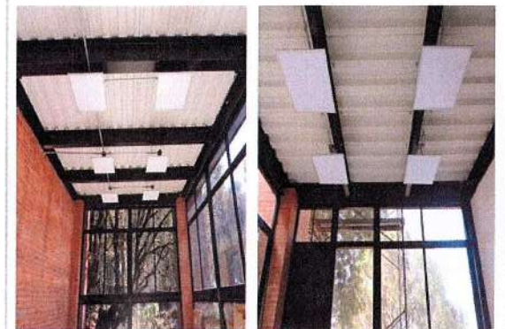
F134: Instalación de luminarias, en pasillos, área de laboratorios.
