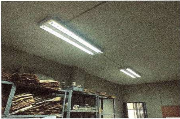
F8: Colocación de luminarias en cubículos
