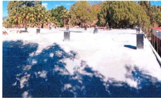
F25: Colado de entortado con concreto premezclado para dar pendientes
