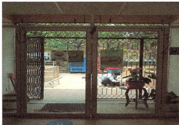
F7: Reparación de puerta de aluminio de acceso principal.
