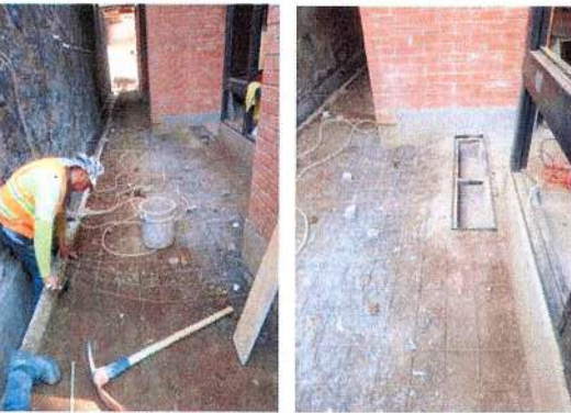
F93: Suministro y tendido de malla electrosoldada en pasillo
