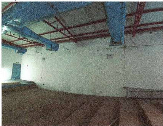
F27: Suministro y aplicación de pintura vinílica en muros interiores (primer mano)
