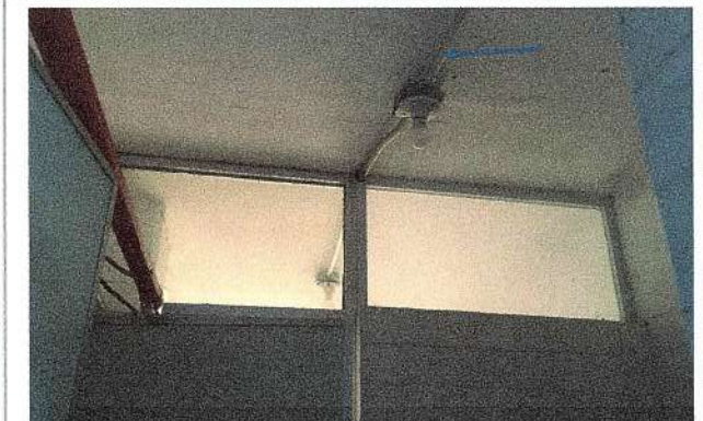
F13: Rehabilitación de apagadores
