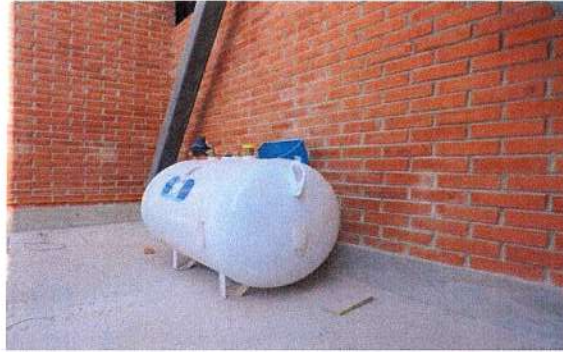
F139: Instalación de tubería de gas L.P.
