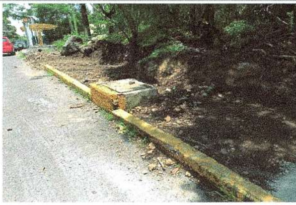
F10: Limpieza de terreno para habilitado de andador.
