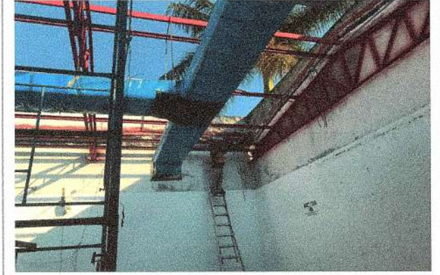
F8: Aplicación de pintura de esmalte en estructura existente.
