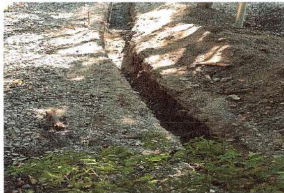
F7: Excavación para puesta a tierra de sistema fotovoltaico
