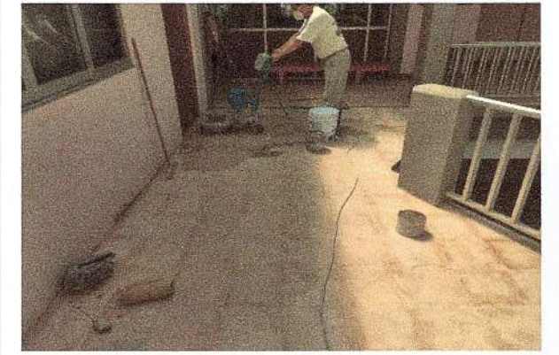
F19: Pulido de piso de granito en pasillo de acceso.
