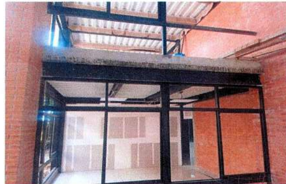
F106: Suministro y colocación de cancelería de aluminio negro
