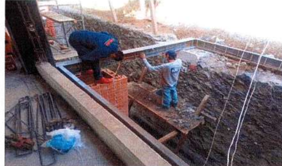
F37: Colocación de estructura metálica para puente
