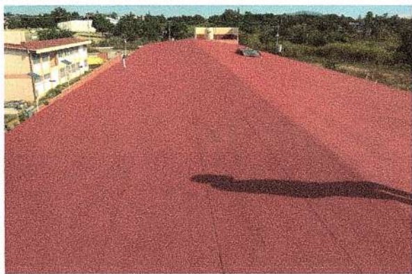
F6: Aplicación de impermeabilizante acrílico en losa de azotea
