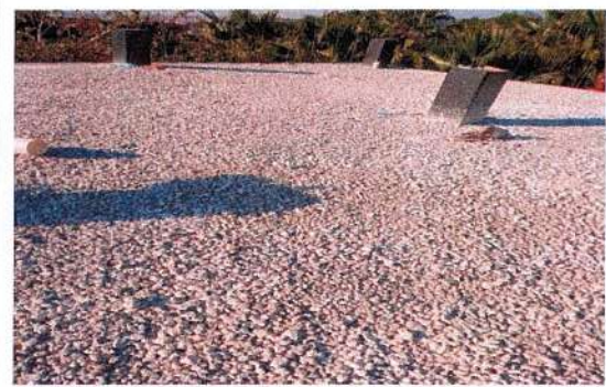
F20: Tendido de grava de tezontle para relleno de entortado en azotea
