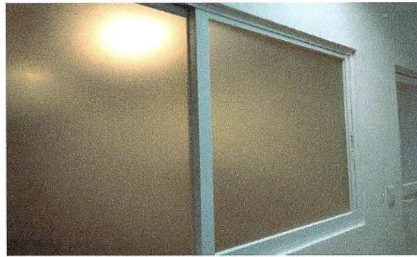
F16: Cancelería de aluminio y película en cristales de vestidores
