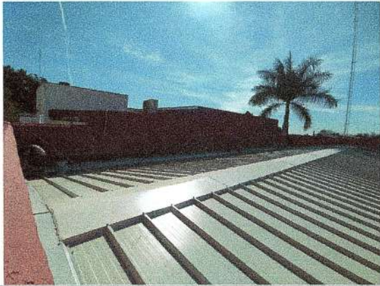
F24: Suministro y colocación de impermeabilizante prefabricado en pretel
