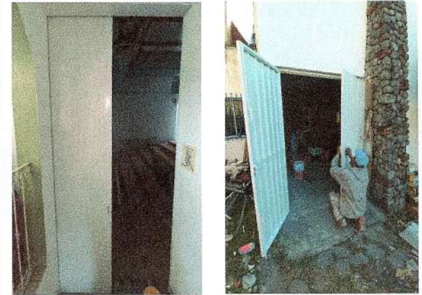
F29: Suministro y aplicación de pintura de esmalte en puertas de herrería
