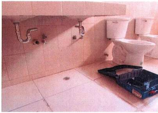
F120: Suministro y colocación de muebles de sanitarios (w.c., lavabos y mingitorios)
