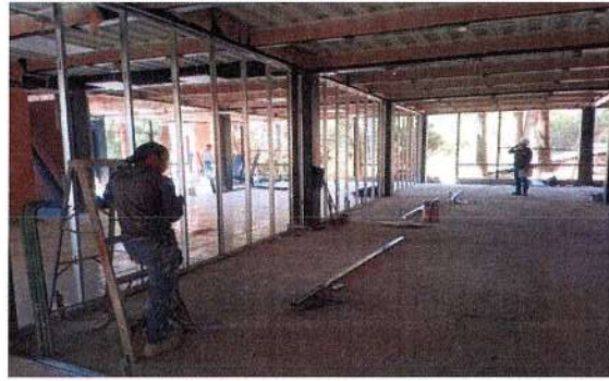
F52: Suministro y colocación de estructura metálica para muros divisorios de tablaroca
