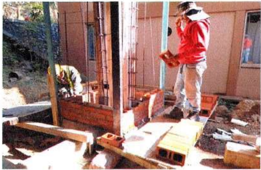
F9: Elaboración de muros vintex en columnas
