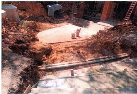
F118: Colado con concreto hecho en obra de escalones y descansos de andador de acceso principal
