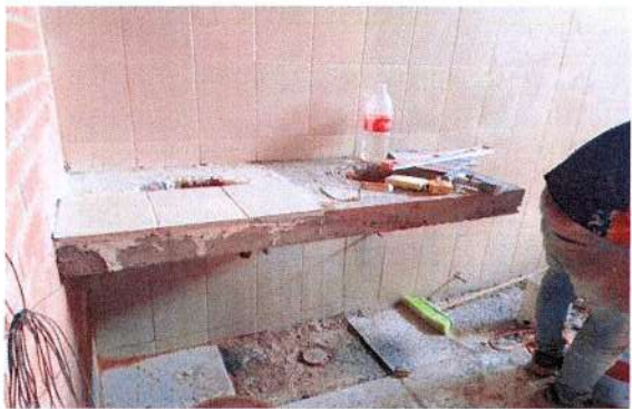
F67: Colocación de azulejo en barra de concreto en área de sanitarios
