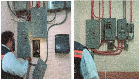
F3: Mantenimiento a red eléctrica considerando tableros principales y secundarios.
