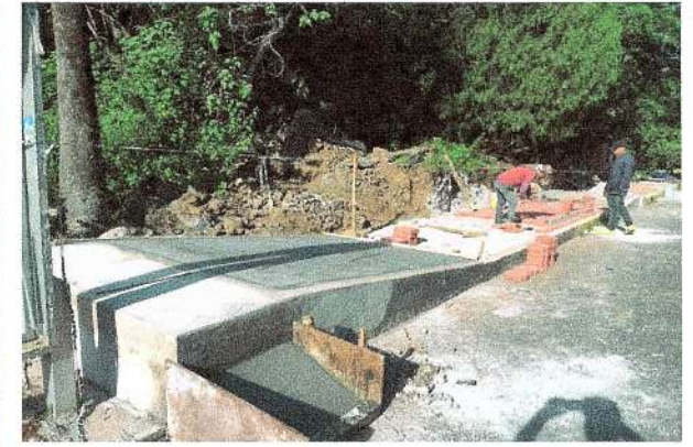
F43: Colado de rampa con concreto hecho en obra.
