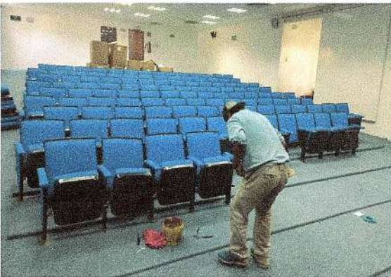
F75: Colocación de butacas retapizadas existentes
