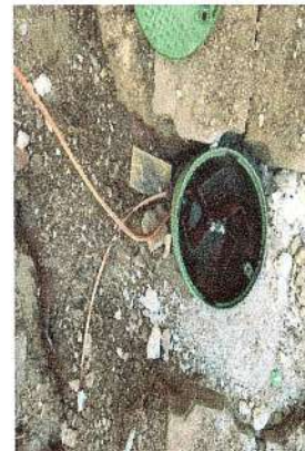
F49: Suministro y colocación de rehiletos para sistema de puesta a tierras
