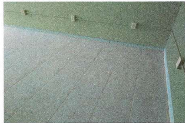
F10: Colocación de piso en sala de maestros.
