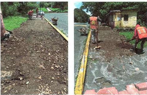
F29: Limpieza de terreno para habilitado de andador.
