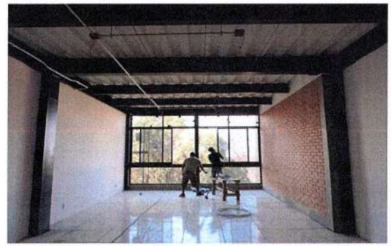
F127: Instalación de luminarias, colocación de cancelería y piso de loseta.
