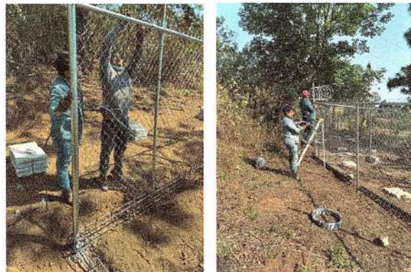
F21: Colocación de acero de cadena, suministro y colocación de malla tipo ciclónica y cerca de navajas (concertina)
