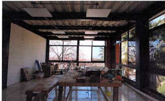
F124: Colocación de piso de loseta, muros divisorios de tablaroca y cancelería en color negro.
