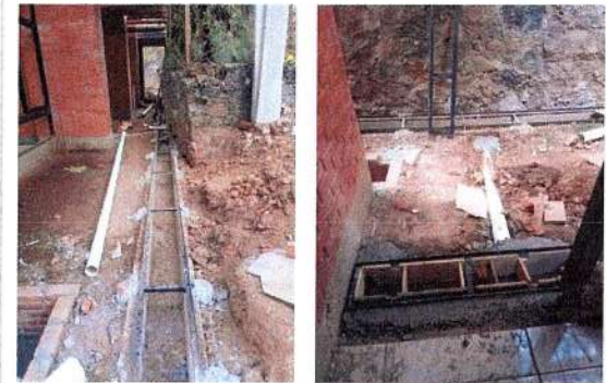
F71: Colocación de marco de herrería y conexión con tubo de pvc a canal pluvial
