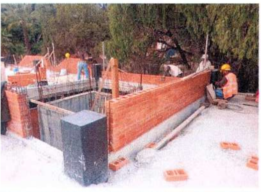
F84: Elaboración de pretil con ladrillo vintex en cubo de escalera
