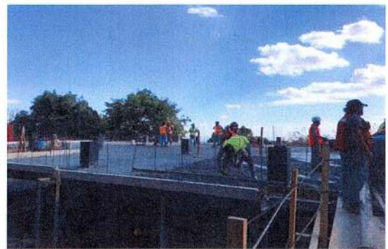
F23: Colado de entortado con concreto premezclado para dar pendientes
