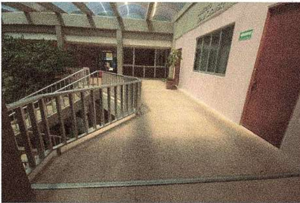
F48: Suministro y colocación de piso de loseta en pasillo de acceso.
