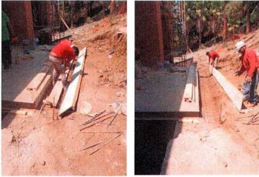
F111: Forjado de canal pluvial en acceso principal
