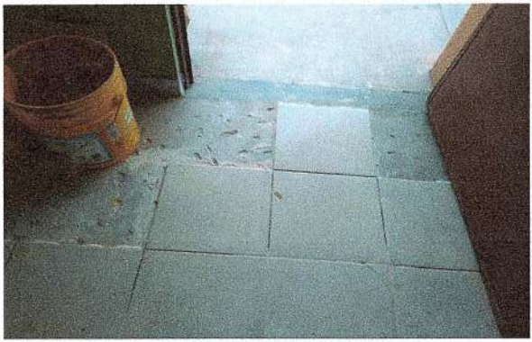
F9: Colocación de piso en sala de maestros.
