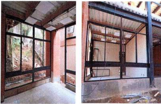
F63: Habilitado y colocación de cancelería de aluminio color negro
