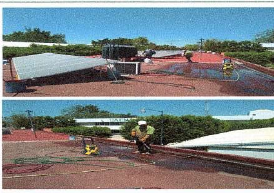
F13: Limpieza de superficie de impermeabilizante existente en losa de azotea de edificio B
