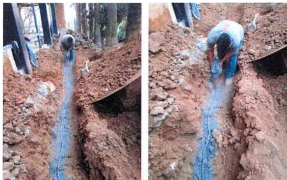
F31: Colocación de bentonita en cable de sistema de tierras
