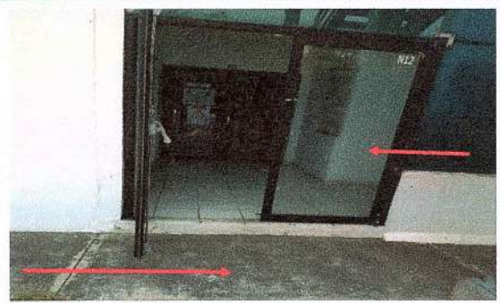
F3: Suministro y colocación de puerta de aluminio, barra antipánico y rampa de concreto
