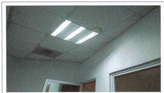
F12: Prueba de instalaciones eléctricas en cuarto de audio (lámpara)
