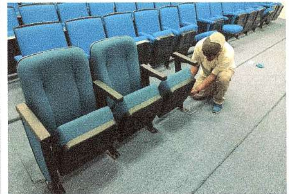
F77: Suministro y colocación de butacas
