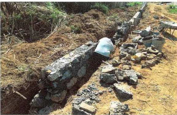
F12: Construcción de rodapie de mampostería
