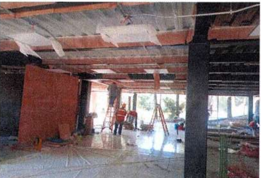
F48: Suministro y colocación de luminarias de 0.61 x 0.61 m
