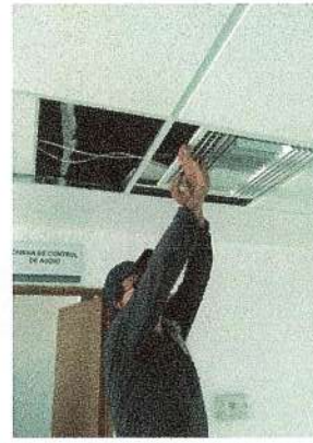
F64: Mantenimiento a equipo de aire acondicionado
