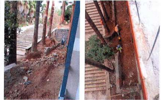
F74: Construcción de muro de contención en fachada poniente
