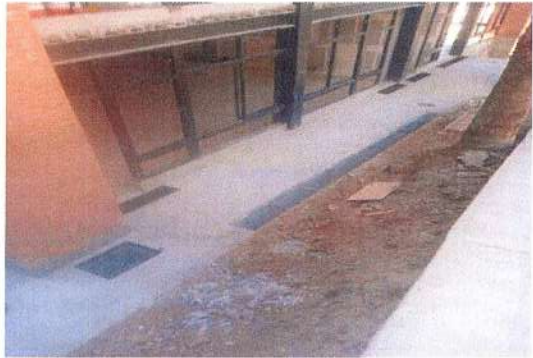
F96: Suministro y colocación de rejillas pluviales en pasillos exteriores
