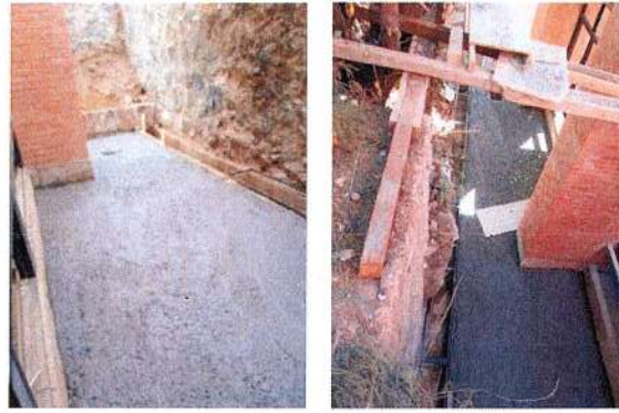
F94: Colado con concreto premezclado en pasillos exteriores
