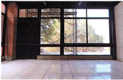
F138: Colocación de piso de loseta y cancelería en color negro.
