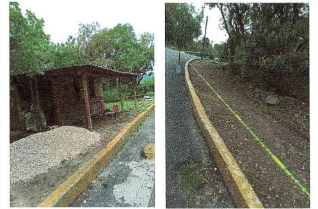
F8: Limpieza de terreno para habilitado de andador existente.
