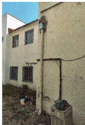
F57: Suministro y colocación de tubo de pvc de 4" para bajadas pluviales
