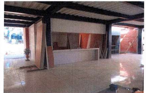
F92: Suministro y colocación de muro de tablaroca a dos caras
