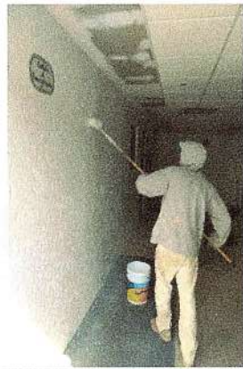
F45: Suministro y aplicación de pintura en muros (segunda mano)
