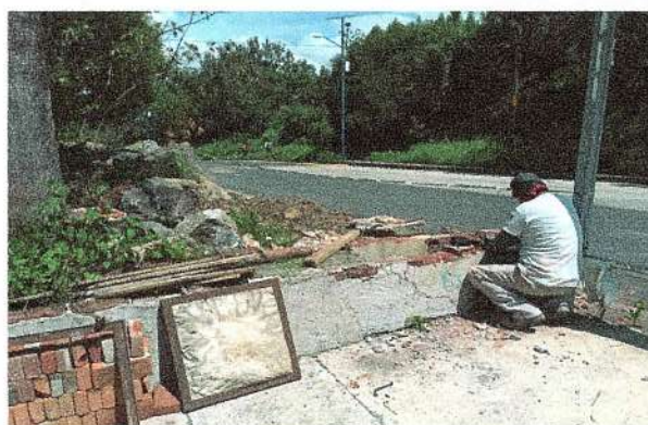
F36: Ajuste de altura de registros existentes.
