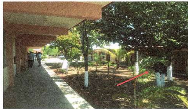
F2: Fachada Edificios Interiores de aulas donde se realizaron los trabajos.
