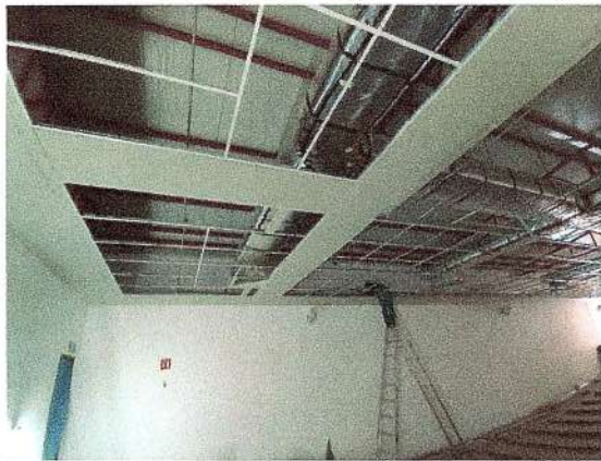
F36: Suministro y colocación de platabanda de tablaroca
