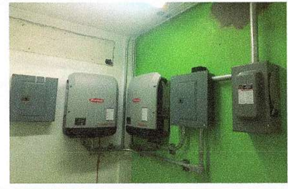
F17: Puesta en marcha de sistema fotovoltaico para pruebas de funcionamiento
