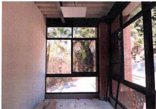
F141: Colocación de piso de loseta y cancelería en color negro.
