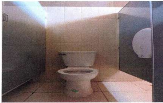
F151: Suministro y colocación de mamparas divisorias de sanitarios
