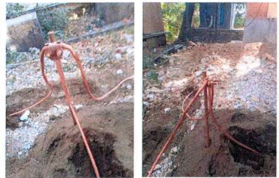
F32: Conexión mecánica de electrodos de sistema de puesta a tierra
