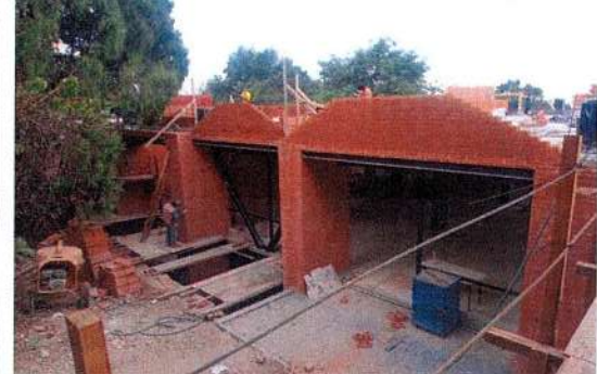
F83: Elaboración de pretil con ladrillo vintex
