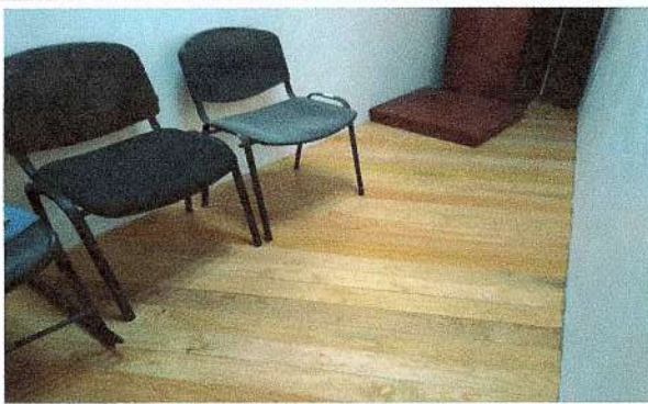
F18: Piso de duela en vestidores
