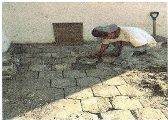
F51: Colocación de registros de sistema de puesta a tierras
