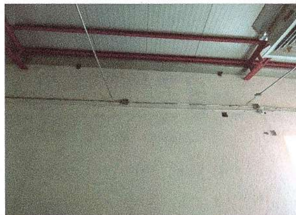
F31: Adecuación de instalación eléctrica
