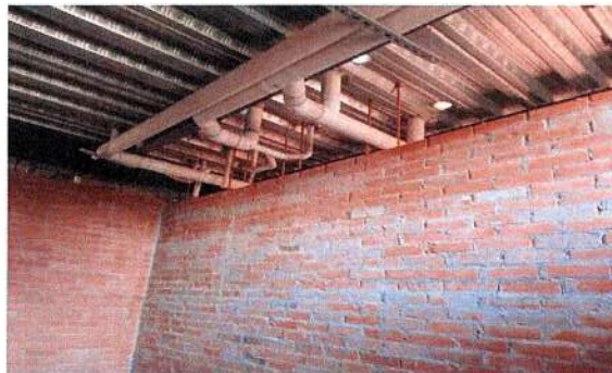
F28: Salidas de instalaciones hidráulicas y sanitarias
