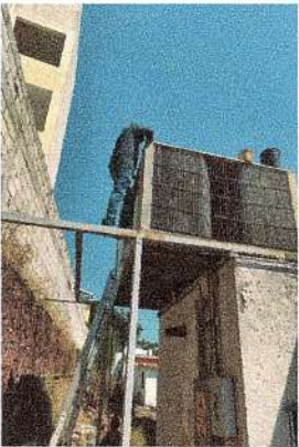
F63: Mantenimiento a equipo de aire acondicionado
