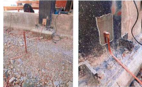
F34: Soldadura exotérmica a columna metálica
