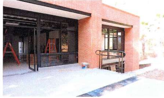
F130: Vestíbulo acceso principal (instalación de barandal).
