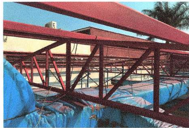
F9: Aplicación de pintura de esmalte en estructura existente.
