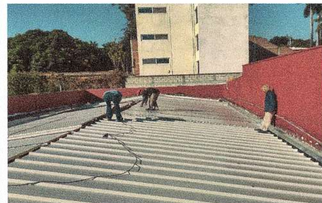
F22: Colocación de láminas multypanel
