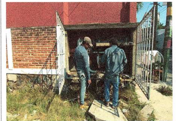
F59: Rehabilitación de instalación eléctrica para equipo de aire acondicionado
