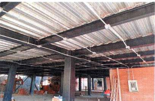
F39: Tendido de cable de cobre y colocación tablero para instalación eléctrica
