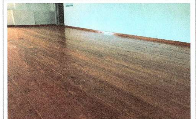
F14: Mantenimiento a duela (estrado de auditorio).
