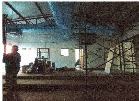
F28: Suministro y aplicación de pintura vinílica en muros interiores (primer mano)
