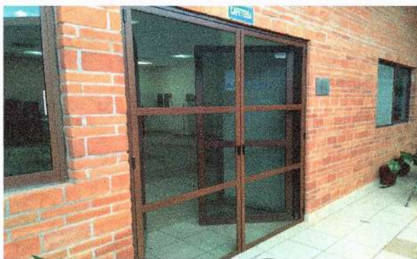
F30: Colocación de mosquitero en comedor.
