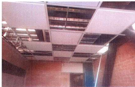
F109: Suministro y colocación de plafón modular de 0.61 x 0.61 m
