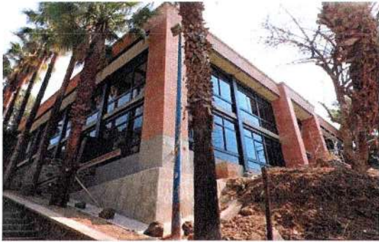
F156: Fachada lateral Edificio del Centro de Investigaciones Biológicas (CIB).
