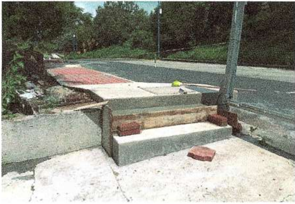
F44: Colado de escalones con concreto hecho en obra.
