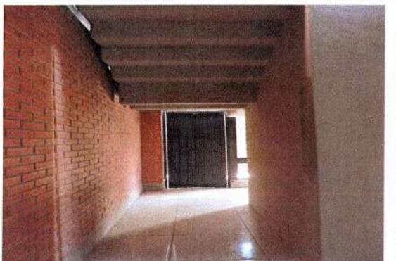
F143: Colocación de piso de loseta y puerta en color negro.
