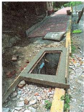
F35: Ajuste de altura de registros existentes.
