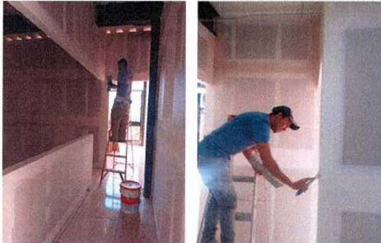
F91: Aplicación de pasta redmix en muro de tablaroca a dos caras
