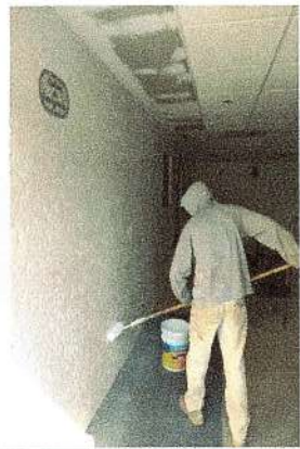
F45: Suministro y aplicación de pintura en muros (segunda mano)
