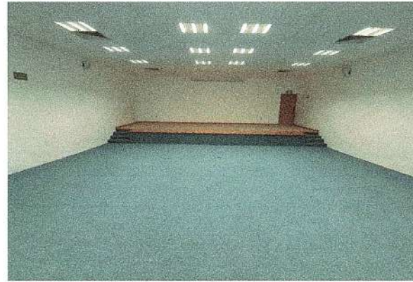
F70: Suministro y colocación de alfombra
