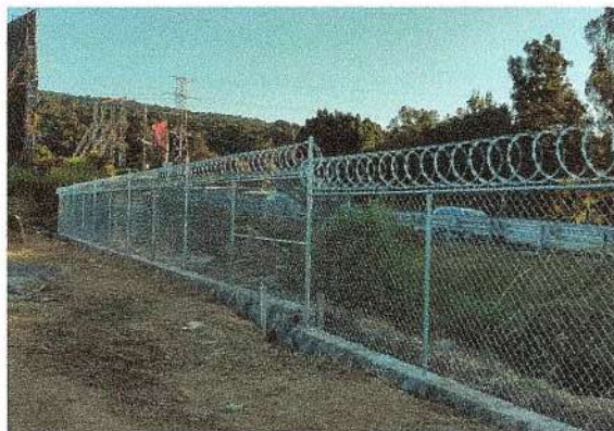
F26: Suministro y colocación de malla tipo ciclónica y cerca de navajas
