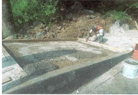
F42: Habilitado de cimbra para colado de rampa.
