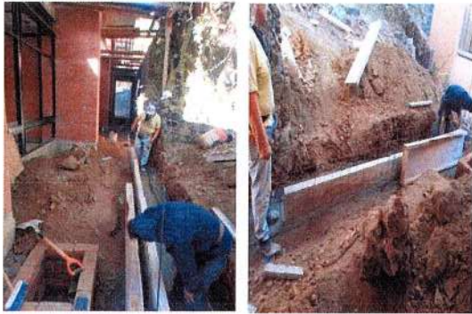
F69: Forjado de canal pluvial
