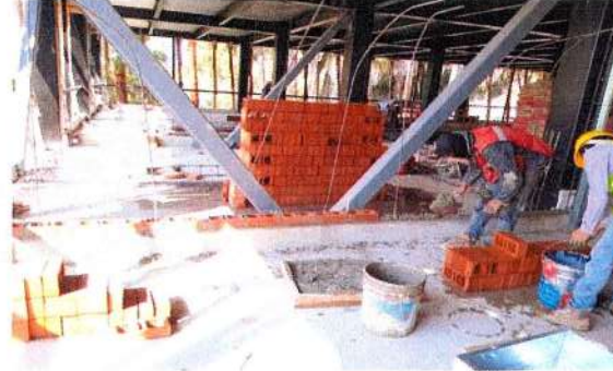
F10: Elaboración de muros vintex
