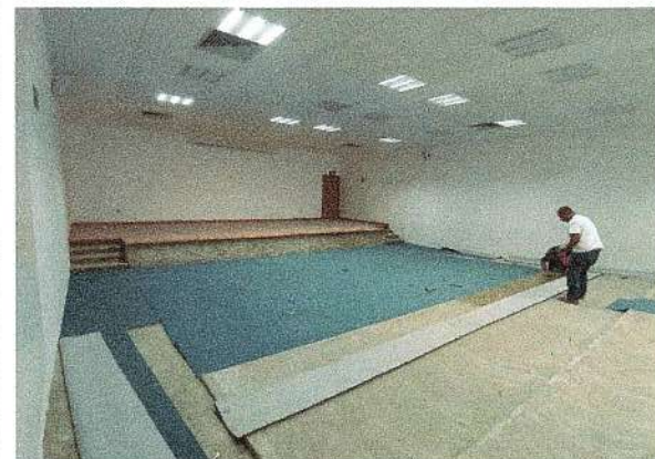
F67: Suministro y colocación de alfombra
