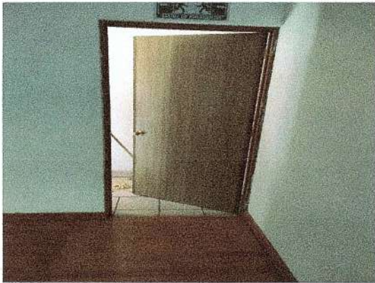
F81: Suministro y colocación de puertas de cabinas de audio
