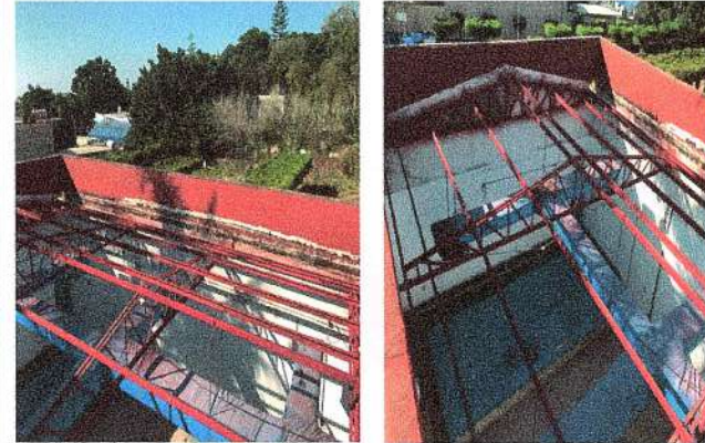
F19: Suministro y aplicación de impermeabilizante acrílico en pretil
