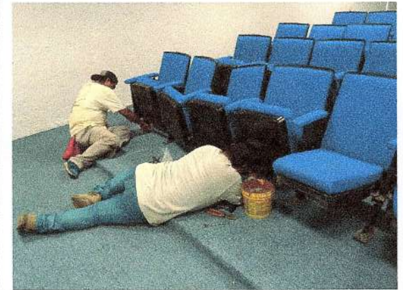
F74: Colocación de butacas retapizadas existentes
