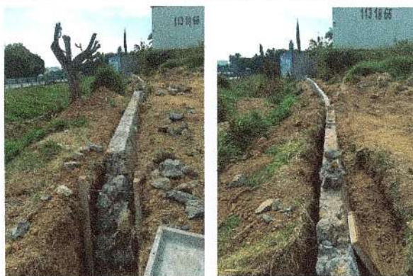
F8: Construcción de rodapie de mampostería
