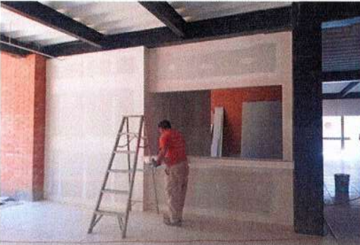
F90: Aplicación de pasta redmix en muro de tablaroca a dos caras
