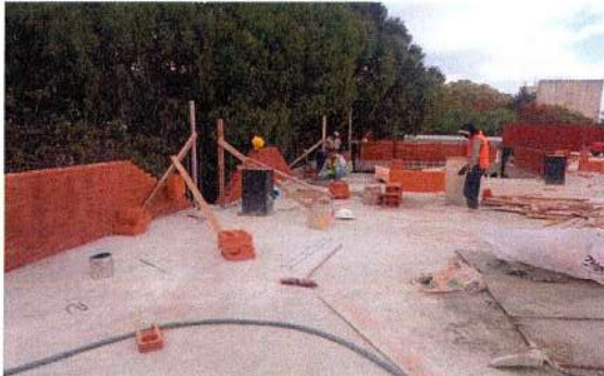
F82: Elaboración de pretil con ladrillo vintex
