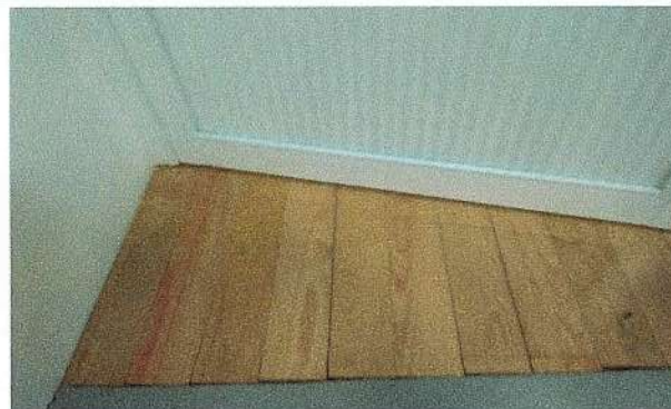
F19: Piso de duela en vestidores
