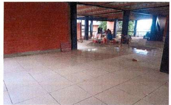
F47: Suministro y colocación de piso de loseta cerámica
