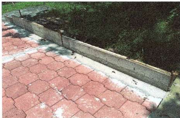
F32: Colado de cadena perimetral con concreto hecho en obra.
