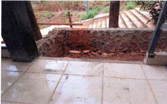
F73: Construcción de muro de contención en fachada poniente
