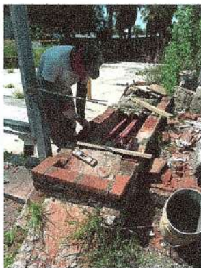
F35: Ajuste de altura de registros existentes.
