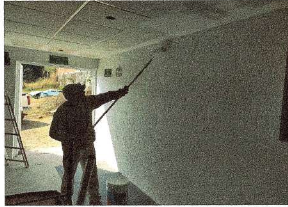
F43: Suministro y aplicación de pintura en muros (segunda mano)
