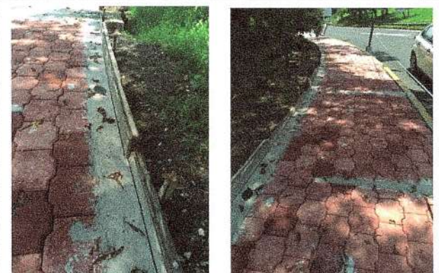
F31: Colado de cadena perimetral con concreto hecho en obra.
