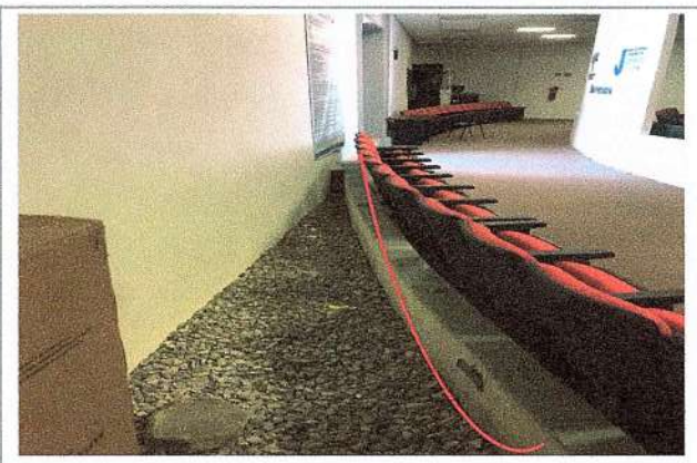
F7: Muro a base de placa de cemento durock.
