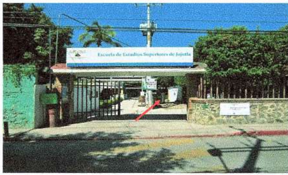
F1: Fachada principal de la EES de Jojutla.
