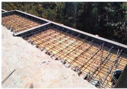
F12: Habilitado de acero en volados
