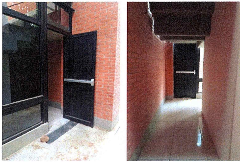
F45.- Puerta de emergencia 11, del Centro de Investigaciones Biológicas
