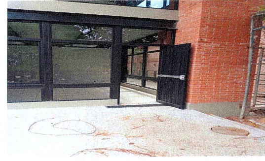
F37.- Puerta de emergencia 3, del Centro de Investigaciones Biológicas
