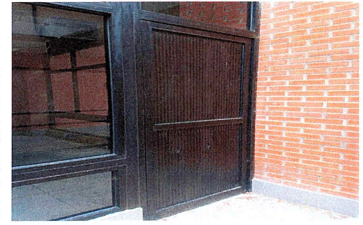
F35.- Puerta de emergencia 1, del Centro de Investigaciones Biológicas
