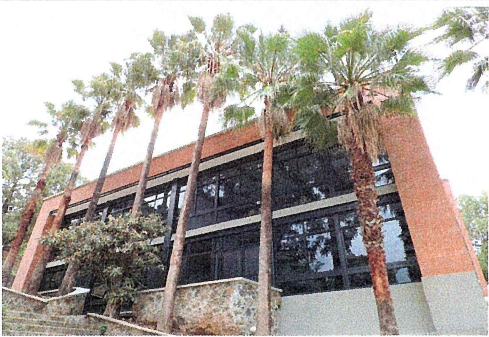
F48: Fachada lateral del Centro de Investigaciones Biológicas
