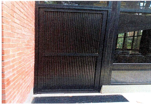
F42.- Puerta de emergencia 8, del Centro de Investigaciones Biológicas
