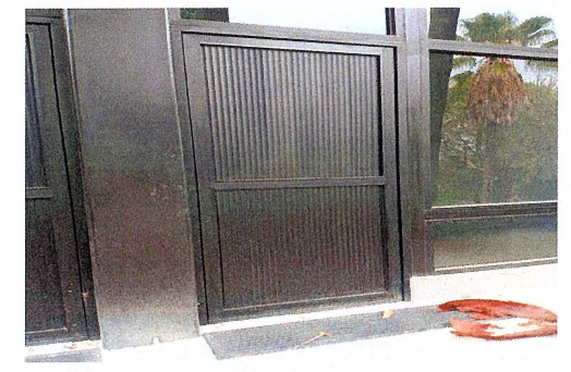
F41.- Puerta de emergencia 7, del Centro de Investigaciones Biológicas
