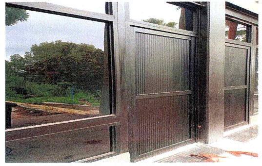
F40.- Puerta de emergencia 6, del Centro de Investigaciones Biológicas
