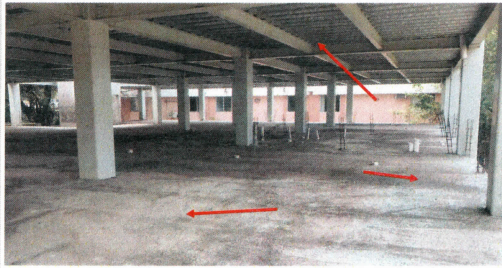
3.- Planta Baja - Se desarrollaran trabajos de construcción de cadena perimetral y firme de concreto, colocación de loseta de cerámica, muros divisorios de tablaroca, colocación de plafón, instalaciones, cancelería.
