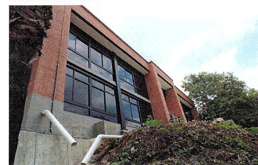
F49: Fachada lateral 2 del Centro de Investigaciones Biológicas
