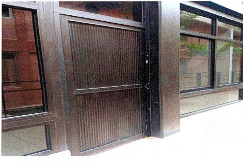
F36.- Puerta de emergencia 2, del Centro de Investigaciones Biológicas
