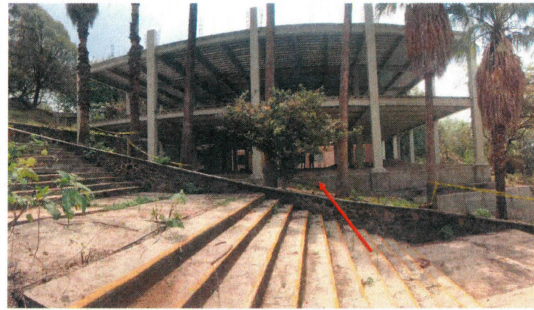
2.- Fachada Oeste -Construcción de la segunda etapa para la ampliación de laboratorios, cubículos de investigación, y oficinas académicas para el Centro de Investigaciones Biológicas antes CEIB (etapa final).
