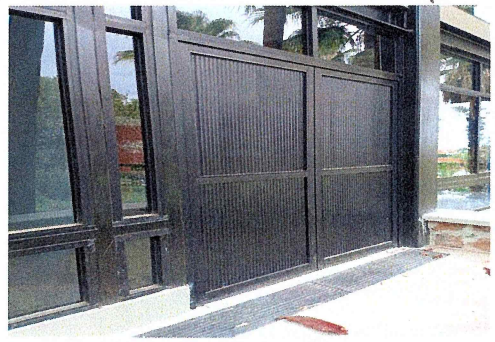
F39.- Puerta de emergencia 5, del Centro de Investigaciones Biológicas
