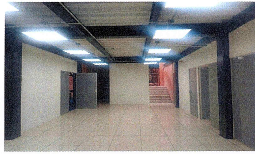
F19.- Pasillos interiores, Planta baja del Centro de Investigaciones Biológicas
