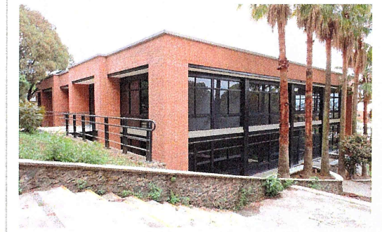
F47: Fachada principal del Centro de Investigaciones Biológicas
