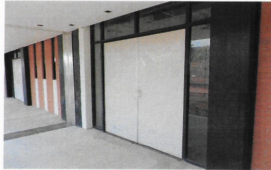
F33: Instalación de cancelería y puertas a accesos.
