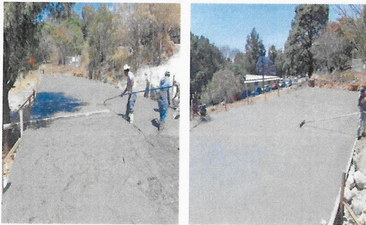
F21: Colado con concreto premezclado de plataforma.
