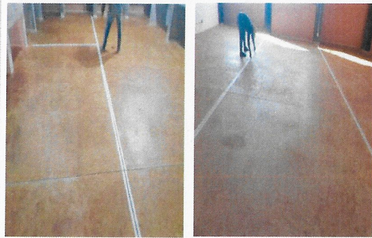
F9: Suministro y colocación de sellador en juntas de piso.
