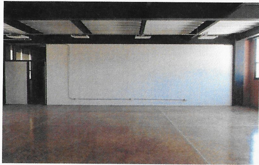
F53: Suministro y colocación de acabado con barniz sobre oxicroto
