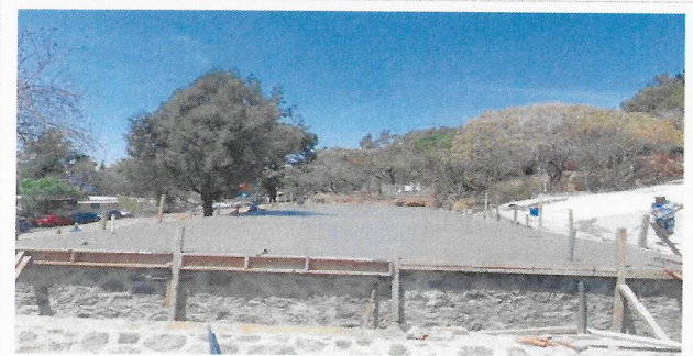
F23: Acabado de firme de concreto premezclado en plataforma.
