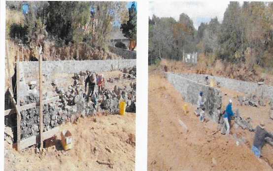
F16: Construcción de muro de mampostería para plataforma.
