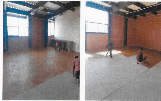
F7: Aplicación de oxicroto en pisos de aulas.
