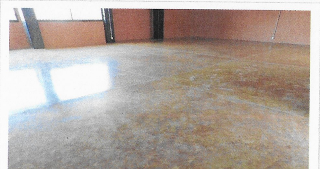
F46: Suministro y colocación de acabado con barniz sobre oxireto
