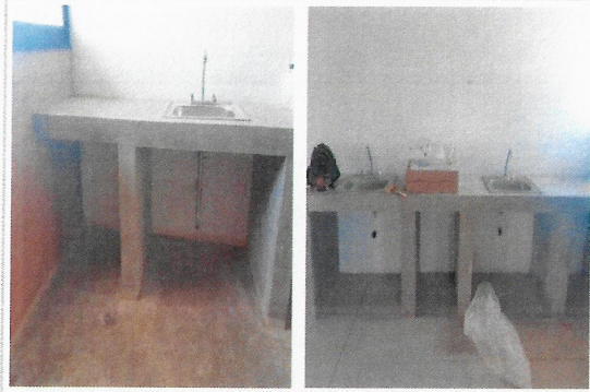
F6: Suministro y colocación de tarjas en barras de concreto
