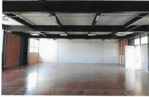
F50: Suministro y colocación de acabado con barniz sobre oxicroto, aplicación de pintura vinilica color blanco, instalación de canceleria.
