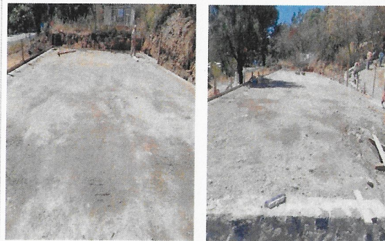
F19: Compactación de material de banco y nivelado para plataforma.
