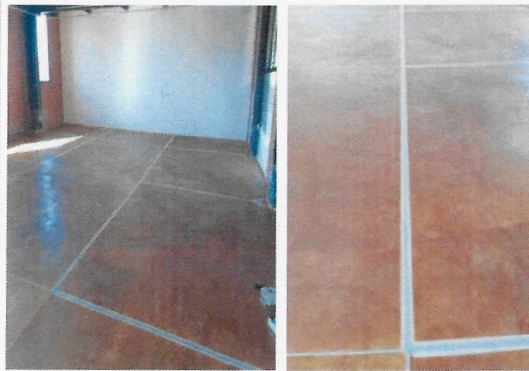
F26: Suministro y colocación de sellador en juntas de piso
