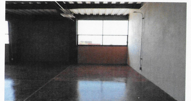
F46: Suministro y colocación de acabado con barniz sobre oxireto
