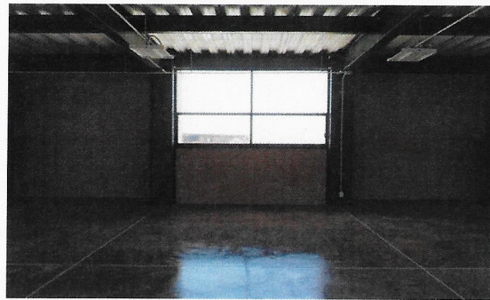
F51: Suministro y colocación de acabado con barniz sobre oxicroto, e instalación de canceleria.
