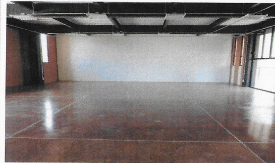
F45: Suministro y colocación de acabado con barniz sobre oxireto
