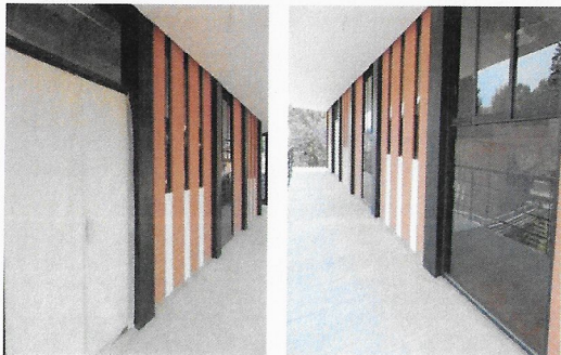
F56: Instalación de canceleria y puertas a accesos.
