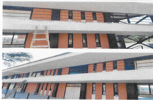
F3: Aplicación de pintura vinílica color blanco en plafón de pasillos
