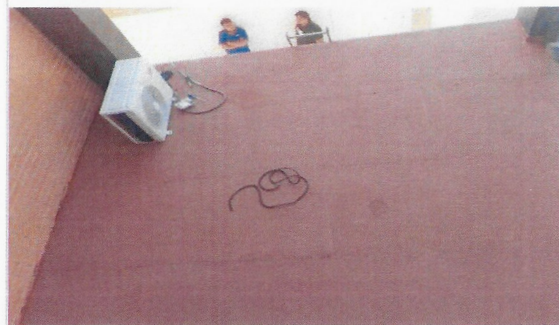
F25: Suministro y colocación de condensadora en losa de site
