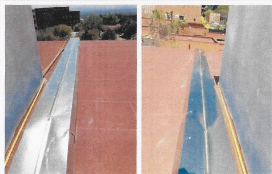
F30: Suministro y colocación de flashing en junta constructiva de azotea
