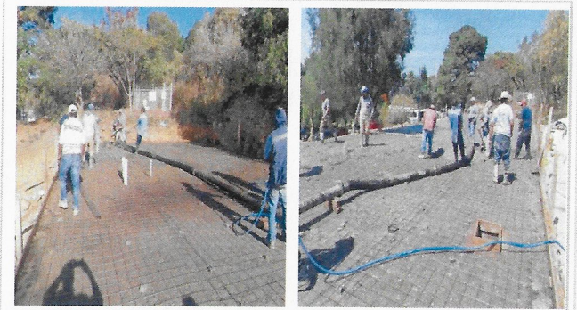
F20: Colado con concreto premezclado de plataforma.
