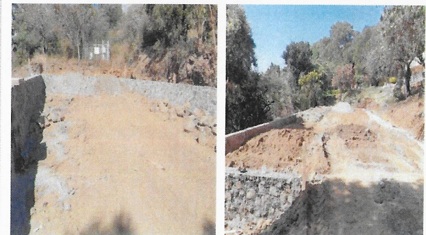
F14: Suministro y fendido de material de banco para plataforma
