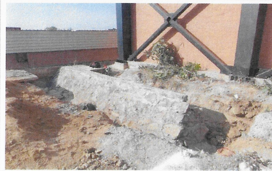
F13: Construcción de muro de contención para refuerzo de edificio
