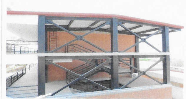
F40: Fachada lateral de la Facultad de artes (Escaleras, pasillo planta alta y pasillo planta baja).
