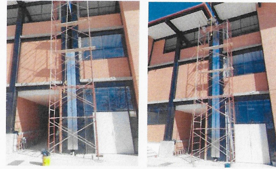
F10: Suministro y colocación de junta constructiva vertical en fachada posterior
