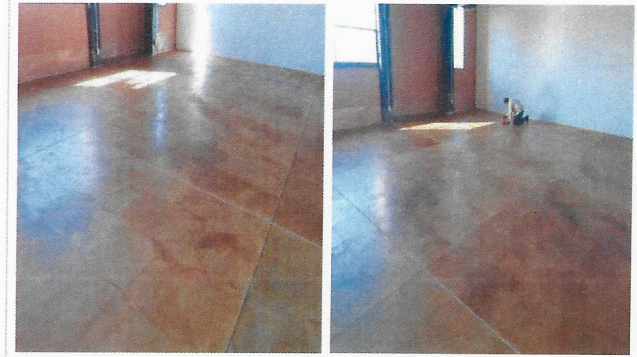
F8: Aplicación de oxicroto en pisos de aulas.
