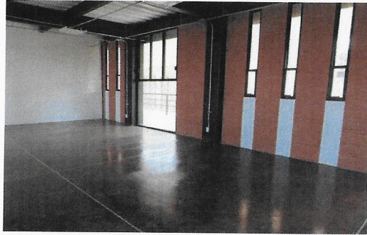
F44: Suministro y colocación de acabado con barniz sobre oxireto
