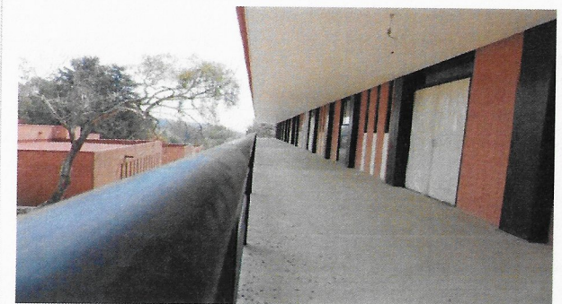
F43: Pasillo planta alta (aplicación de pintura a barandar, piso de concreto)
