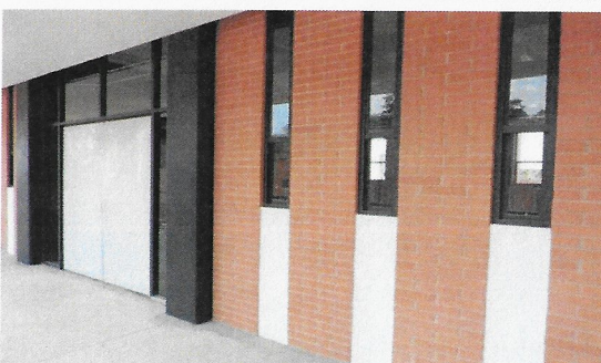
F57: Instalación de canceleria y puertas a accesos.
