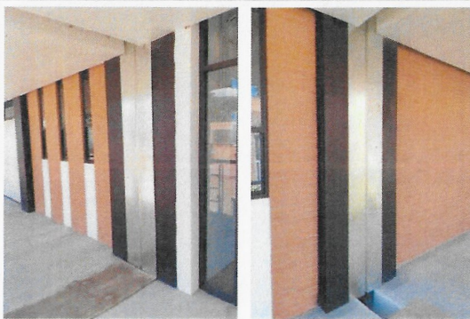
F29: Suministro y colocación de junta constructiva vertical en pasillos
