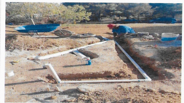
F17: Suministro y tendido de tubo de pvc para salidas sanitarias en plataforma.
