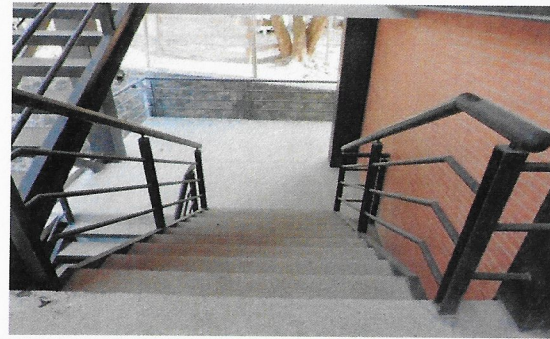
F42: Escaleras de concreto en la Facultad de Artes.
