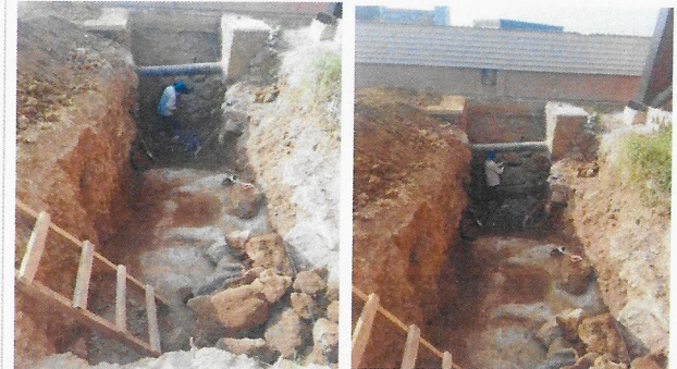
F11: : Construcción de muro de contención para refuerzo de edificio
