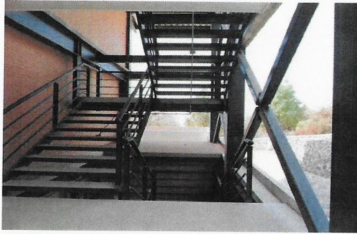
F41: Escaleras de la Facultad de Artes (aplicación de pintura vinílica color negro).
