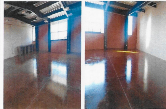
F27: Suministro y colocación de acabado con barniz sobre oxireto
