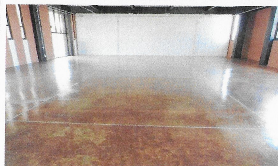
F48: Suministro y colocación de acabado con barniz sobre oxireto, aplicación de pintura vinílica color blanco, instalación de cancelería.
