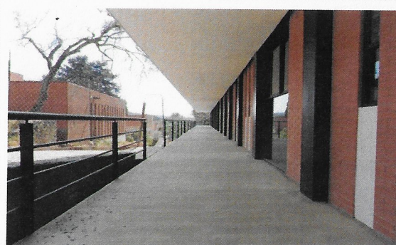
F60: Pasillo planta baja (aplicación de pintura a barandaz, piso de concreto)
