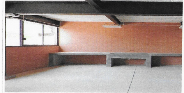
F37: Barra y tarja de concreto.
