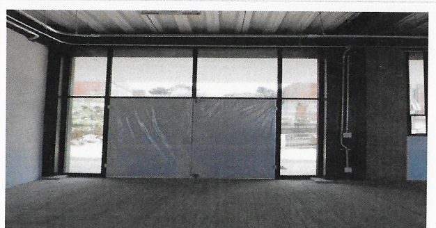
F58: Instalación de canceleria y puertas a accesos.
