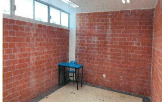
F31: Se equipará el Aula 13 Edificio A, con pizarrón blanco de 1.20*2.40.
