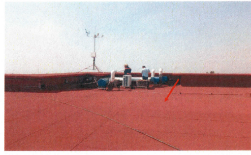
F7: Impermeabilización de cubierta, muros laterales, fachadas y base de caseta. Fachada sur del CIQ.
