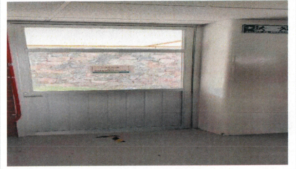
F20: Se equipará la puerta de salida de emergencia del Laboratorios LQ1, con colocación e instalación de cerradura, tipo barra antipánico, bancos de madera.
