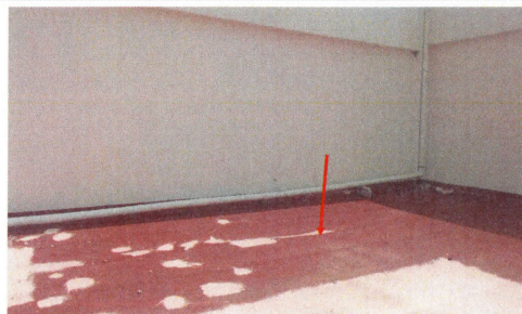
F4: Mantenimiento al sistema de impermeabilización de losa en el edificio 1 de Escuela de Estudios Superiores de Jonacatepec subsede Axochiapan. Cubierta de entrepiso, fachada suroeste.
