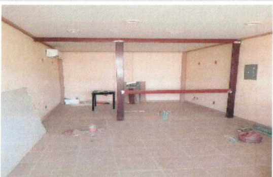
F13: Salón H: Se equipará la Cabina de Radio 1 extintor 1 silla binaria y extintor.
