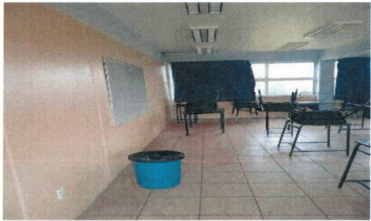
F12: Aula 11, 1er nivel edificio 72
