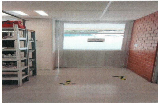
F25: Se equipará la puerta de salida de emergencia del Almacén de Laboratorios ED.B, con colocación e instalación de cerradura, tipo barra antipánico.
