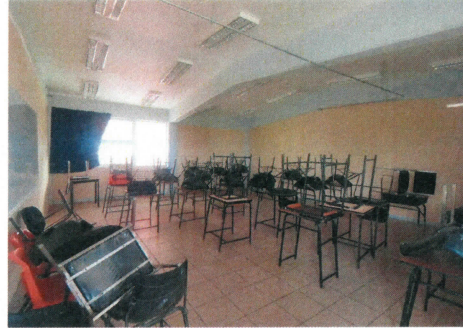
F7: Aula 6, 2do nivel, edificio 71
