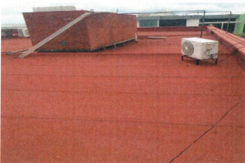
F3: Mantenimiento de impermeabilización en losa del edificio del Centro de Investigación en Ciencias
