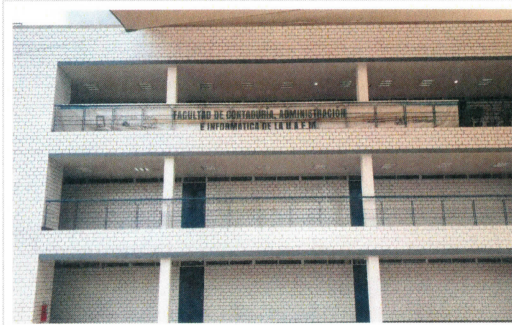
F1: Fachada Principal del Edificio 2B de la FCAeI
