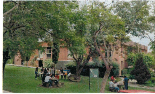
F2: Fachada Lateral del Centro de Investigación en Ciencias.
