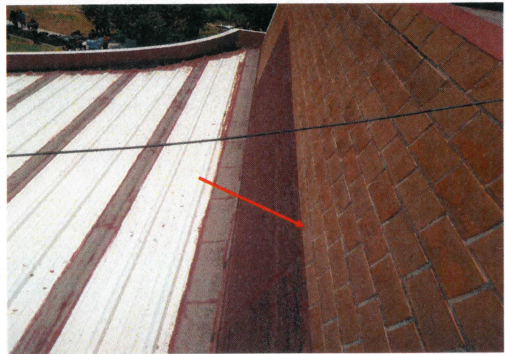
F9: Adecuación y Mejoras de la Cubierta y "Huerto Solar" en la Biblioteca Central. Sellado de muro de tabique de barro extruido
