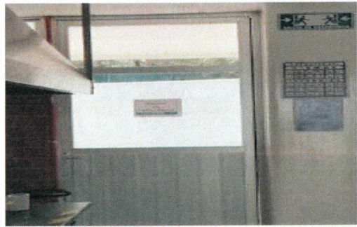
F21: Se equipará la puerta de salida de emergencia del Laboratorios LQ2, con colocación e instalación de cerradura, tipo barra antipánico.
