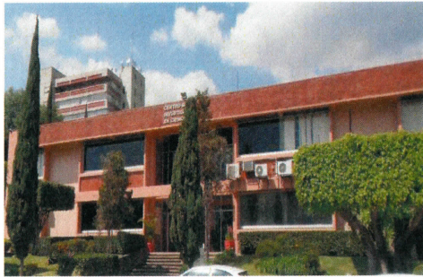
F1: Fachada Principal del Centro De Investigación En Ciencias
