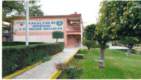
F1: Fachada Principal de la Facultad de Derecho y Ciencias Sociales.
