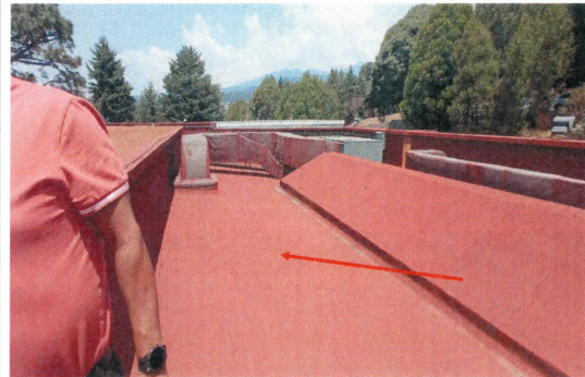
F4: Adecuación y Mejoras de la Cubierta y "Huerto Solar" en la Biblioteca Central. Trabajos de impermeabilización en losa de azotea y pretel, colocación de huerto solar, Nave principal
