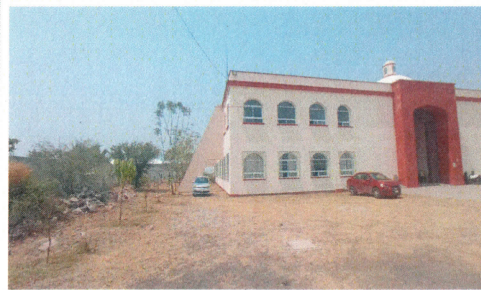
F2: Fachada Lateral de la Escuela de Estudios Superiores de Jonacatepec subsede Axochiapan.
