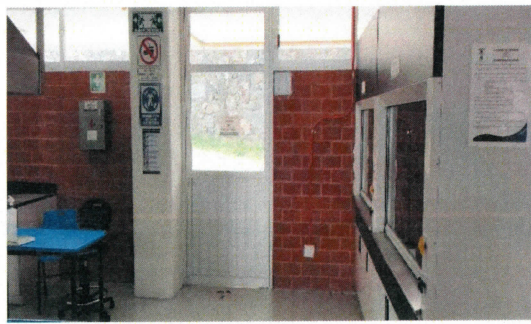
F22: Se equipará la puerta de salida de emergencia del Laboratorios LQ3, con colocación e instalación de cerradura, tipo barra antipánico.
