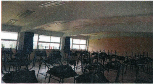
F15: Aula 14, 2do nivel, edificio 72
