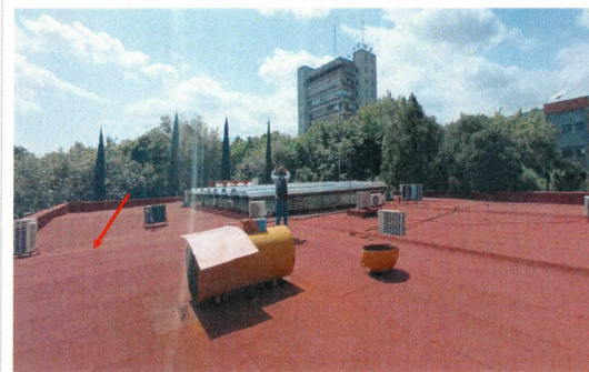
F4: Mantenimiento de Impermeabilizante en losa del edificio del Centro de Investigación en Ciencias (CInC). Lado Sur del edificio.
