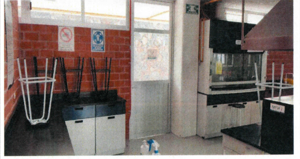
F23: Se equipará la puerta de salida de emergencia del Laboratorios LQ4, con colocación e instalación de cerradura, tipo barra antipánico.
