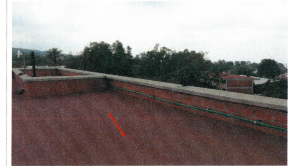
F5: Mantenimiento al sistema de Impermeabilización existente del edificio No. A 70. Cubierta de azotea, fachada sur, del edificio.
