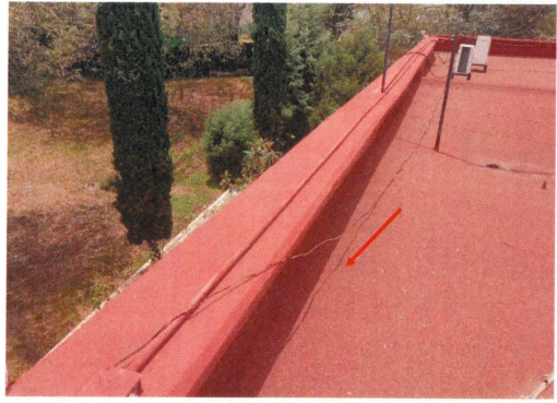
F6: Mantenimiento de impermeabilizante en losa del edificio del Centro de Investigación en Ciencias (CInC). Lado Oeste del edificio.
