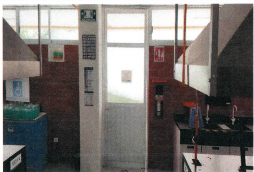
F24: Se equipará la puerta de salida de emergencia del Laboratorios LQ5, con colocación e instalación de cerradura, tipo barra antipánico.
