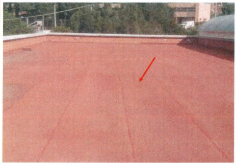
F3: Mantenimiento al sistema de Impermeabilización existente del edificio No. A 70. Cubierta de azotea, fachada sur.
