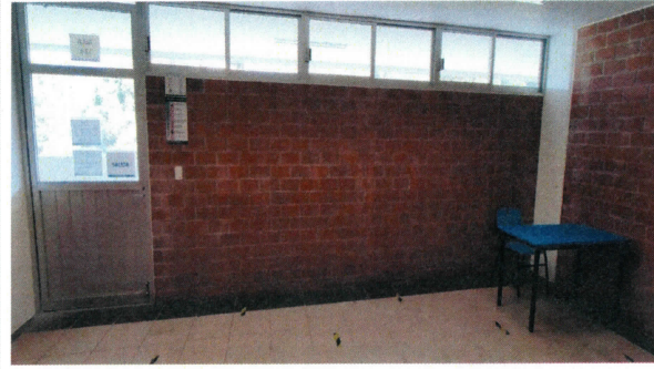
F29: Se equipará el Aula 11 Edificio A, con pizarrón blanco de 1.20*2.40.
