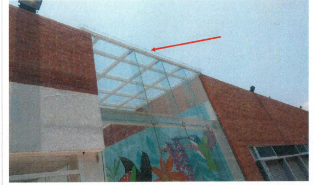
F8: Adecuación y Mejoras de la Cubierta y "Huerto Solar" en la Biblioteca Central. Trabajos de sellado en domos de azotea.
