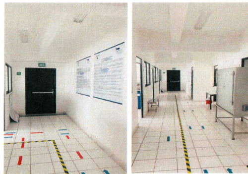
F7: Se equipará la Planta Piloto (Laboratorio), con 1 extractor atmosferico y 1 aire acondicionado y 1 anaquel metálico.
