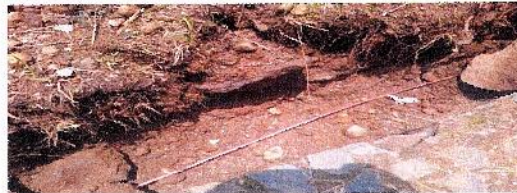
F36: Tendido de cable desnudo para delta de sistema de tierras para paneles solares.
