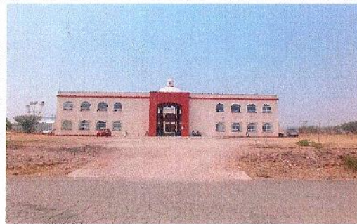
F1: Fachada Principal de la Escuela de Estudios Superiores de Jonacatepec subsede Axochiapan.
