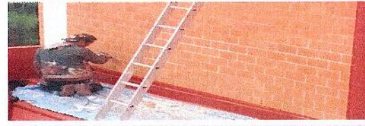
F21: Lijado y limpieza de muros aparentes
