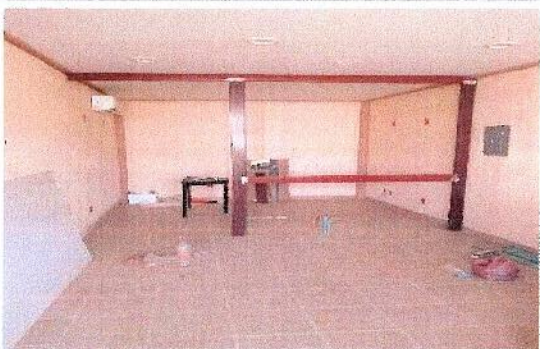
F13: Salón H: Se equipará la Cabina de Radio 1 extintor 1 silla binaria y extintor.
