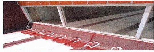
F17: Aplicación de impermeabilizante híbrido acrílico - poliuretano
