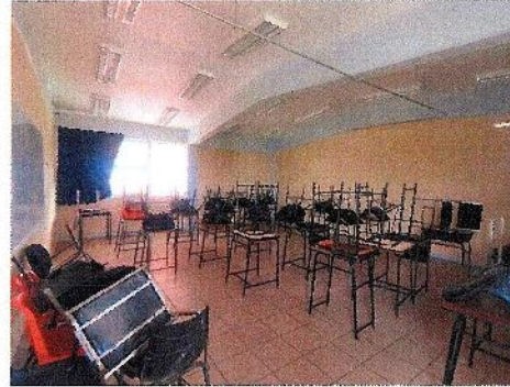
F7: Aula 6, 2do nivel, edificio 71 , con ventilador
