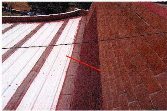
F9: Adecuación y Mejoras de la Cubierta y "Huerto Solar" en la Biblioteca Central. Sellado de muro de tabique de barro extruido
