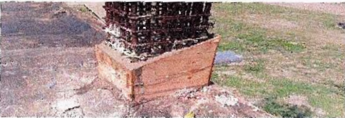
F9: Cimbrado y colado de columnas de entresiso
