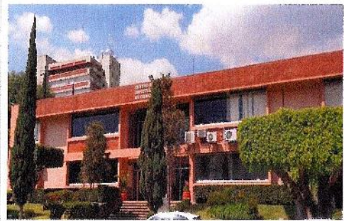
F1: Fachada Principal del Centro De Investigación En Ciencias
