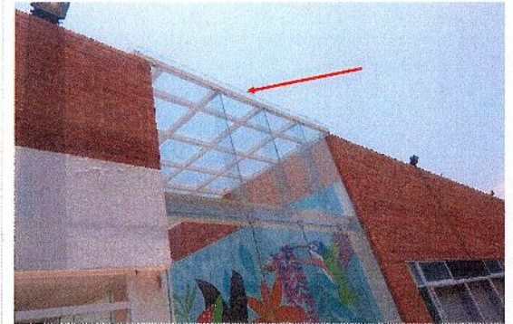
F8: Adecuación y Mejoras de la Cubierta y "Huerto Solar" en la Biblioteca Central. Trabajos de sellado en domos de azotea.
