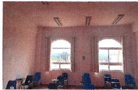
F3. Se equipará el Salón A con aire acondicionado.
