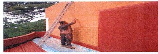
F18: Aplicación de impermeabilizante híbrido acrílico - poliuretano
