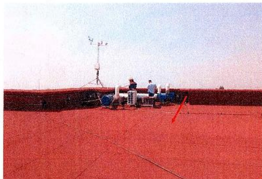
F7: Impermeabilización de cubierta, muros laterales, fachadas y base de caseta. Fachada sur del C.O.
