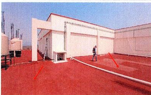
F3: Mantenimiento al sistema de impermeabilización de losa en el edificio 1 de Escuela de Estudios Superiores de Jonacatepec subsede Axochiapan. Cubierta de entrepiso, fachada sureste.
