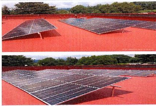
F26: Suministro y colocación de paneles solares en auditorio
