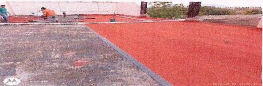
F10: Aplicación de primer en losa de entresiso
