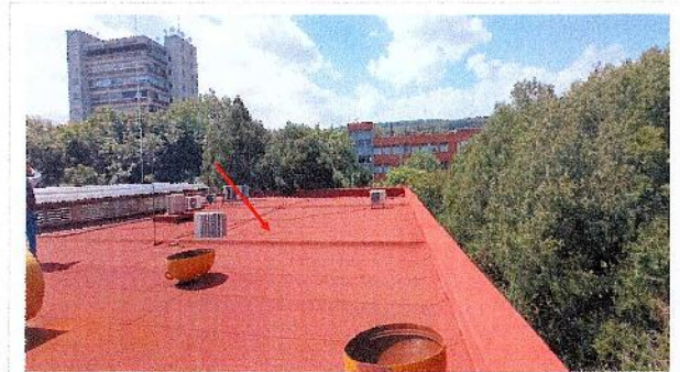
F5: Mantenimiento de impermeabilización en fosa del edificio del Centro de Investigación en Ciencias (CInC). Lado Este del edificio.
