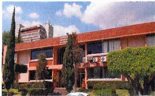
F1: Fachada Principal del Centro de Investigación en Ciencias.
