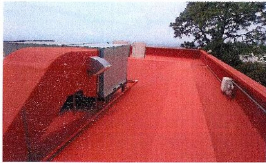
F42: Aplicación de impermeabilizante híbrido acrílico - poliuretano
