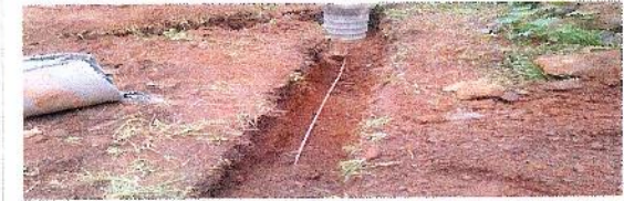
F34: Tendido de cable desnudo para delta de sistema de tierras para paneles solares.
