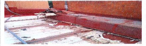
F19: Aplicación de sellador de poliuretano en juntas
