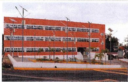
F1: Fachada Principal, del Edificio No. A70 Facultad de Psicología
