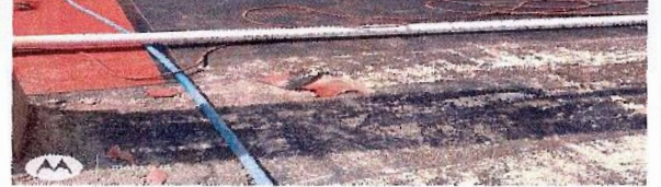
F11: Aplicación de primer en losa de entresiso
