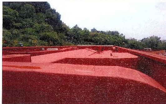
F43: Aplicación de impermeabilizante híbrido acrílico - poliuretano
