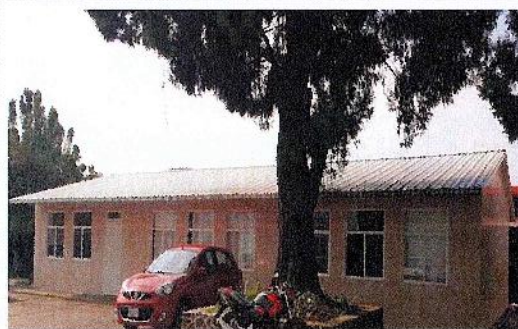
F4: Impermeabilización de cubierta, muros laterales, fachadas y base de caseta prefabricada a los salones y laboratorio de docencia del programa educativo de la Licenciatura en Diseño Molecular y Nanotecnología del Centro de Investigaciones Químicas (CIQ).
