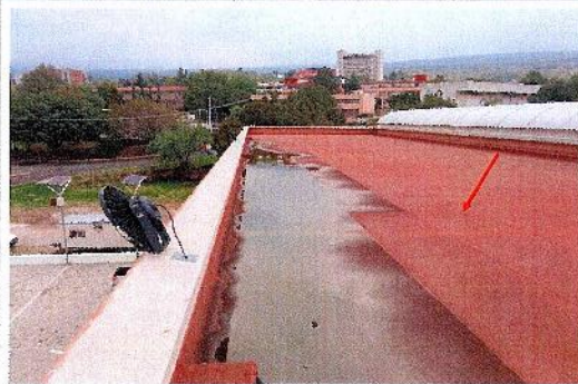
F4: Mantenimiento al sistema de impermeabilización existente del edificio No. A 70. Cubierta de azotea, fachada suroeste del edificio.
