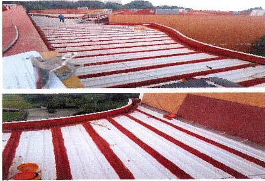
F23: Sellado de juntas con impermeabilizante acrílico - poliuretano reforzado con malla
