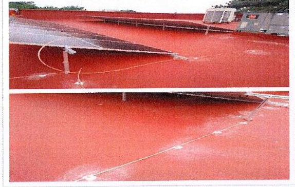
F28: Tendido de cable desnudo para conexión de paneles solares
