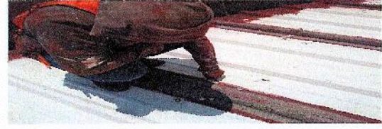
F20: Aplicación de sellador de poliuretano en juntas
