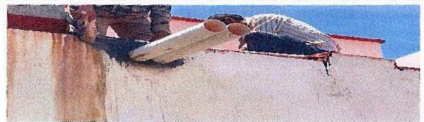
F11: Aplicación de primer en losa de entresiso
