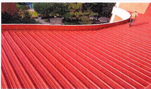
F46: Aplicación de impermeabilizante híbrido acrílico - poliuretano
