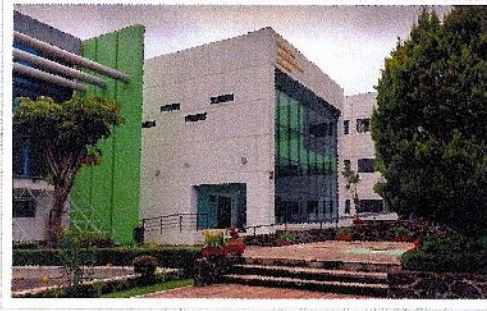
F1: Fachada Principal del Centro De Investigaciones Químicas
