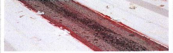
F19: Aplicación de sellador de poliuretano en juntas
