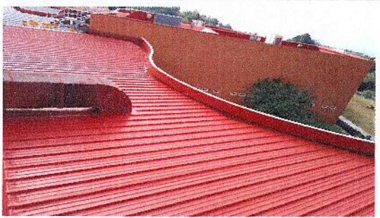
F45: Aplicación de impermeabilizante híbrido acrílico - poliuretano
