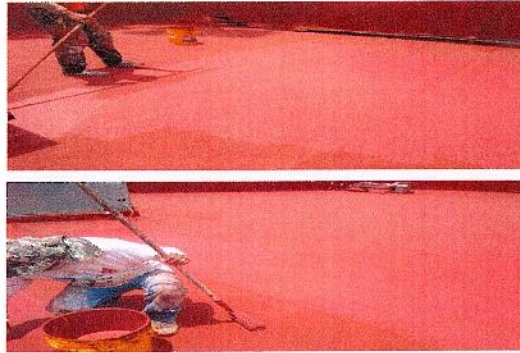
F15: Aplicación de impermeabilizante híbrido acrílico - poliuretano
