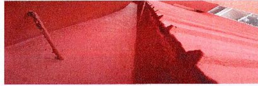
F18: Aplicación de impermeabilizante híbrido acrílico - poliuretano
