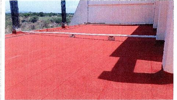
F17: Impermeabilizante de tapete color terracota en losa de entrepiso
