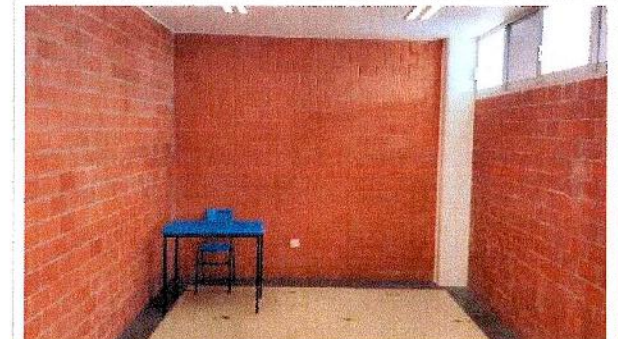
F5: Se equipará el Aula 10, edificio B, con piso blanco de 90*1.20.
