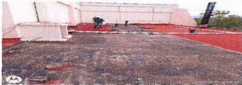
F6: Desprendimiento de carpeta asfáltica dañada existente
