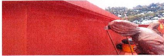
F14: Aplicación de impermeabilizante acrílico
