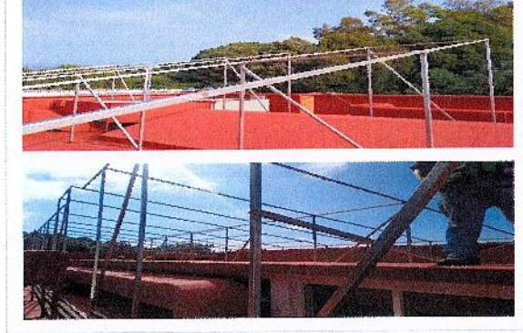
F31: Suministro y colocación de estructuras metálicas para paneles solares
