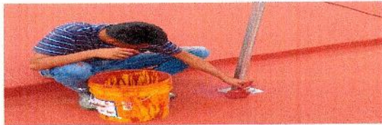
F32: Sellado de bases metálicas con impermeabilizante acrílico.
