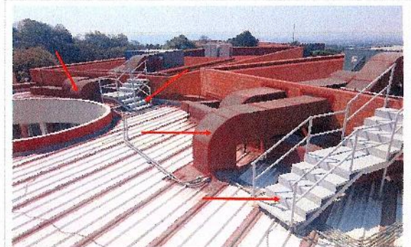
F5: Adecuación y Mejoras de la Cubierta y "Huerto Solar" en la Biblioteca Central. Retiro de ductos de aire acondicionado, escaleras metálicas y sustitución de cubierta.
