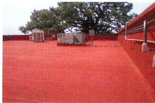
F40: Aplicación de impermeabilizante híbrido acrílico - poliuretano
