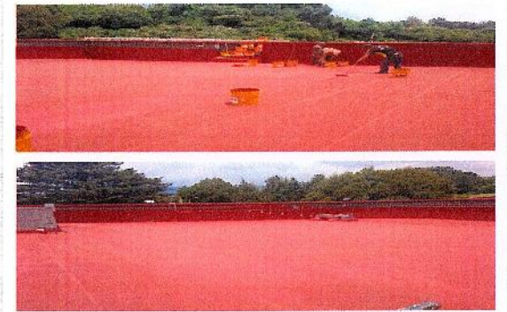
F16: Aplicación de impermeabilizante híbrido acrílico - poliuretano
