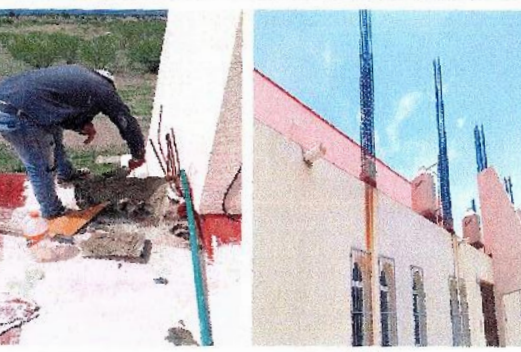
F13: Arreglo de bajadas pluviales con tubo de pvc de 4" en losa de entresiso
