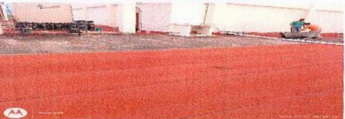
F12: Suministro y colocación de impermeabilizante de tapete
