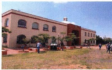
F1: Fachada Principal de la Escuela de Estudios Superiores de Atlatlahuacan
