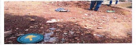
F34: Tendido de cable desnudo para delta de sistema de tierras para paneles solares.
