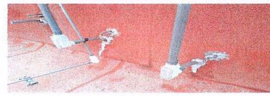
F12: Aplicación de sellador de poliuretano en juntas
