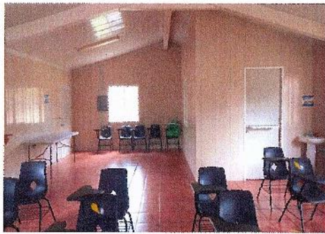
F9: Se equipará el Salón L2, con aire acondicionado.
