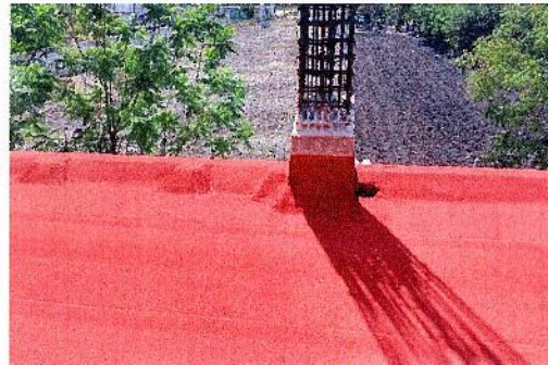
F18: Impermeabilizante de tapete color terracota en losa de entrepiso
