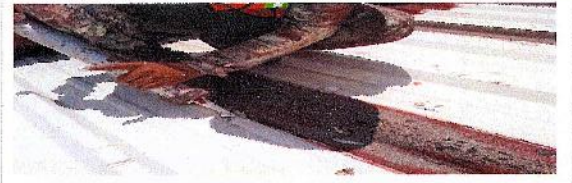
F16: Aplicación de impermeabilizante híbrido acrílico - poliuretano
