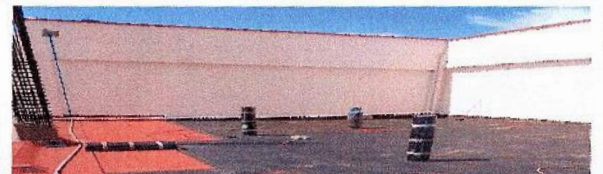
F8: Sellado de grietas con cemento plástico
