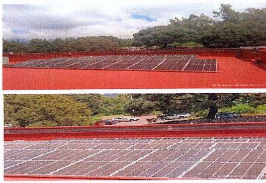
F27: Suministro y colocación de paneles solares en auditorio
