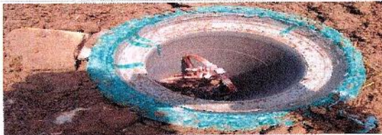
F32: Sellado de bases metálicas con impermeabilizante acrílico.
