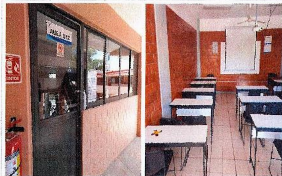
F11: Se equipará el Aula B12 Edificio B, con silla y pizarrón.
