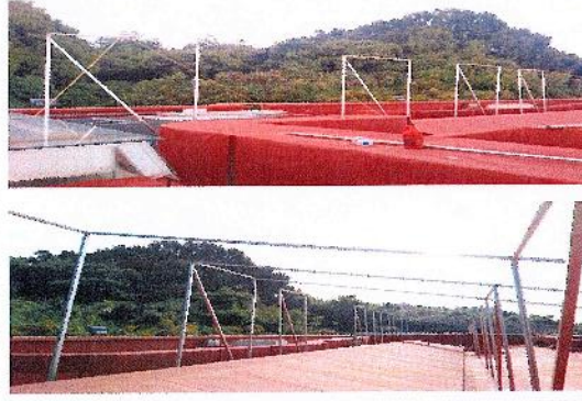
F30: Suministro y colocación de estructuras metálicas para paneles solares
