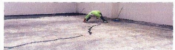
F8: Sellado de grietas con cemento plástico
