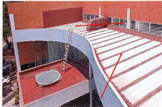
F7: Adecuación y Mejoras de la Cubierta y "Huerto Solar" en la Biblioteca Central. Trabajos de impermeabilización en cubierta de multitecho y sellado de ventanas de azotea, área central de biblioteca
