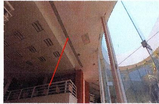
F10: Adecuación y Mejoras de la Cubierta y "Huerto Solar" en la Biblioteca Central. Trabajos de sustitución de plafón, área interior central.
