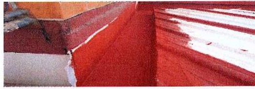
F15: Aplicación de impermeabilizante híbrido acrílico - poliuretano
