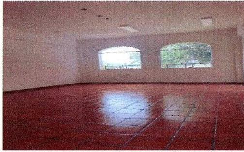
F7: Se equipará el Salón 6, con silla y mesa binaria.
