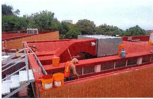
F14: Aplicación de impermeabilizante acrílico
