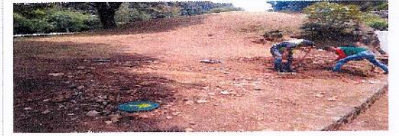
F37: Registro para delta de sistema de tierras para paneles solares.
