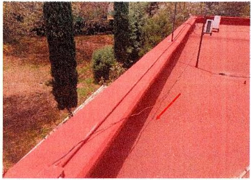
F6: Mantenimiento de impermeabilizante en losa del edificio del Centro de Investigación en Ciencias (CInC). Lado Oeste del edificio.
