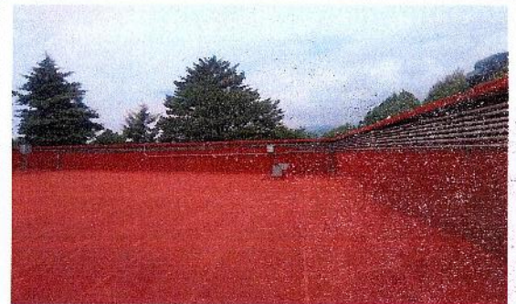
F44: Aplicación de impermeabilizante híbrido acrílico - poliuretano
