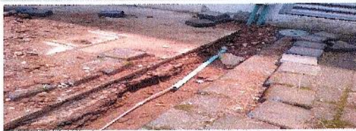
F33: Tendido de cable desnudo para delta de sistema de tierras para paneles solares.
