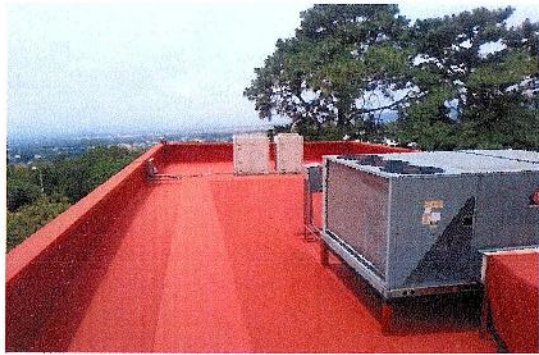
F39: Aplicación de impermeabilizante híbrido acrílico - poliuretano
