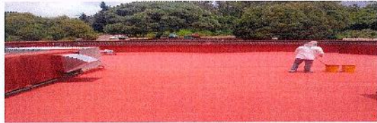
F17: Aplicación de impermeabilizante híbrido acrílico - poliuretano
