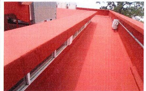
F41: Aplicación de impermeabilizante híbrido acrílico - poliuretano
