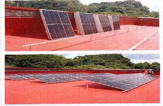
F25: Suministro y colocación de paneles solares en auditorio
