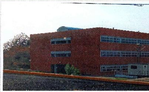
F2: Fachada lateral, del Edificio No. A70 Facultad de Psicología
