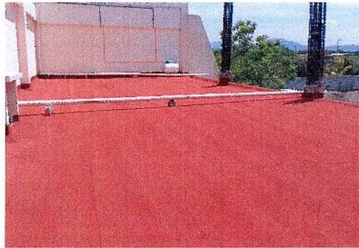
F15: Impermeabilizante de tapete color terracota en losa de entrepiso
