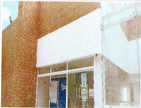
F40: Aplicación de pintura vinilica en fachada posterior
