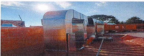
F13: Colocación de ductos de aire acondicionado por reubicación
