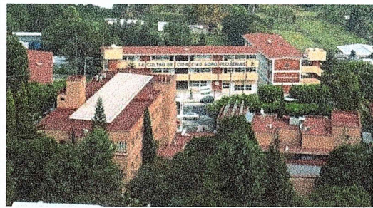
F1: Edificio principal de la Facultad de Ciencias Agropecuarias.
