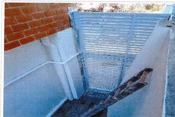
F45: Aplicación de pintura vinilica en fachada posterior
