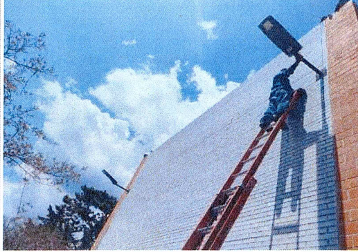
F53: Suministro y colocación de luminarias de empotrar.
