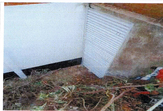
F48: Aplicación de pintura de esmalte en puerta de herrería
