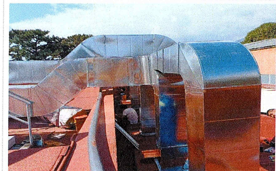
F27: Colocación de ductos de aire acondicionado por reubicación
