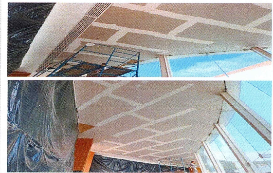
F24: Suministro y colocación de plafón liso de tablaroca
