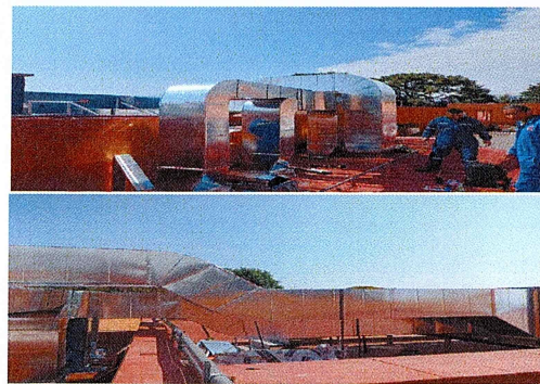
F26: Colocación de ductos de aire acondicionado por reubicación
