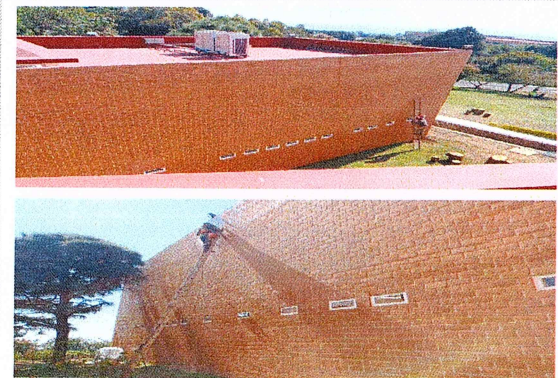
F12: Suministro y aplicación de sellador sobre muros vintex
