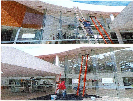
F22: Suministro y aplicación de pintura vinílica en fachada principal
