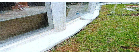
F20: Suministro y colocación de impermeabilizante acrílico con membrana
