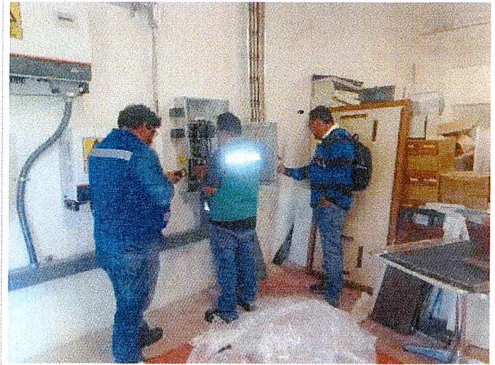
F52: Inspección de instalación eléctrica fotovoltaica con carga instalada.
