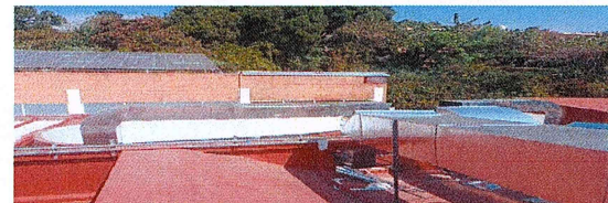
F18: Colocación de ductos de aire acondicionado por reubicación
