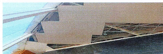
F21: Suministro y colocación de plafón liso de tablaroca
