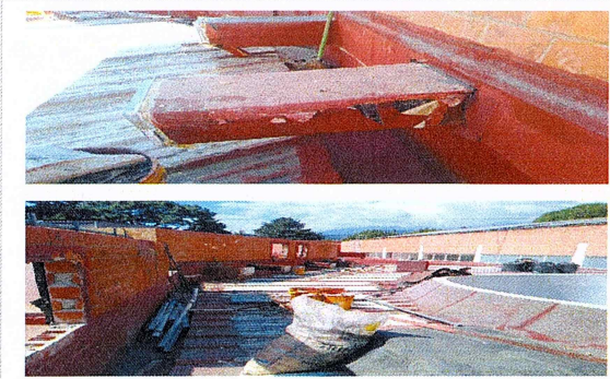
F3: Desmontaje de ductos de aire acondicionado
