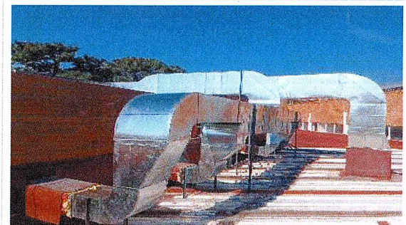
F30: Colocación de ductos de aire acondicionado
