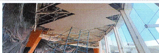
F18: Colocación de ductos de aire acondicionado por reubicación
