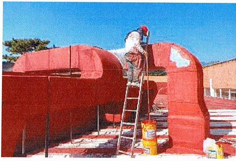
F31: Aplicación de impermeabilizante acrílico sobre ductos
