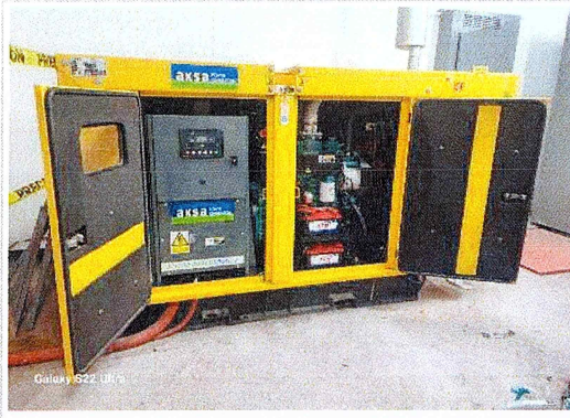
F50: Mantenimiento a planta de emergencia.
