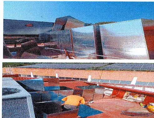
F11: Suministro de ductos para aire acondicionado
