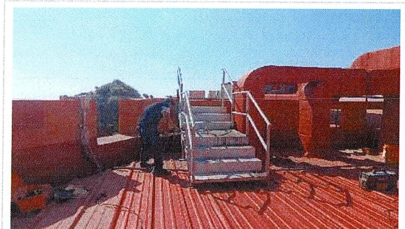
F33: Recolocación de escaleras metálicas
