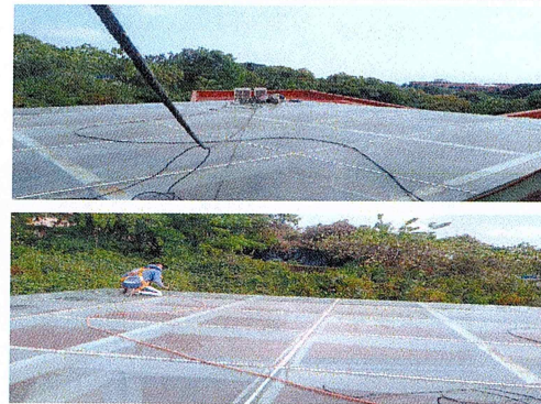
F8: Suministro y aplicación de sellador de poliuretano en uniones de cristal de domo
