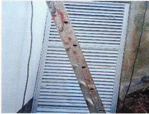
F49: Aplicación de pintura de esmalte en puerta de herrería
