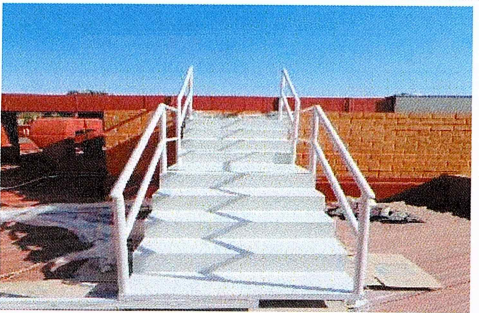
F34: Aplicación de pintura esmalte en escaleras metálicas
