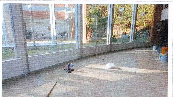
F39: Aplicación de pintura vinílica en áreas comunes
