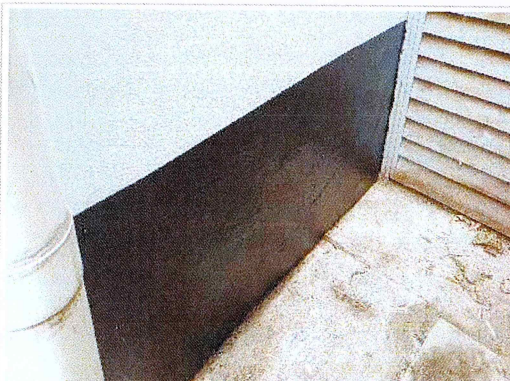
F47: Aplicación de barrera de vapor sobre muro
