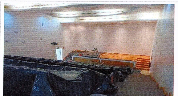
F36: Aplicación de pintura vinílica en auditorio
