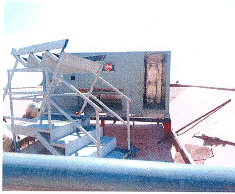
F4: Desmontaje de escalera de herrería
