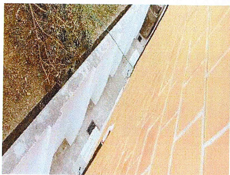
F43: Aplicación de pintura vinilica en fachada posterior
