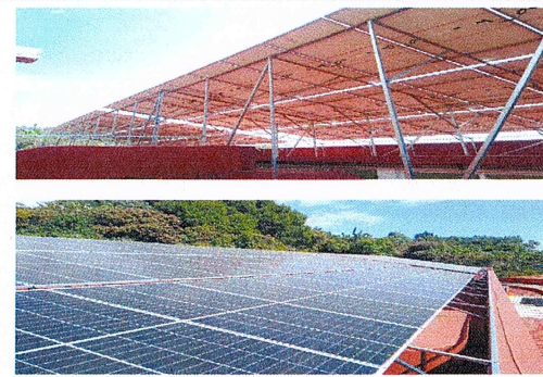
F2: Suministro y colocación de paneles solares
