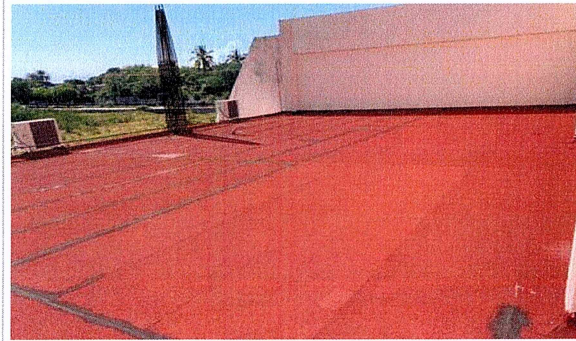
F1: Mantenimiento a impermeabilizante de azotea en Edificio Principal de la Escuela de Estudios Superiores de Mazatepec, Subside Tetecala.
