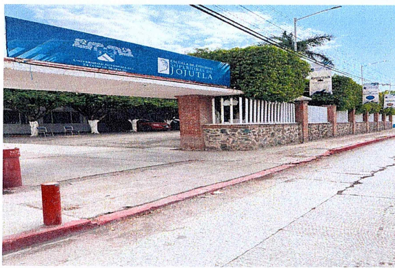
Fachada de la Escuela de Estudios Superiores de Jojutla
