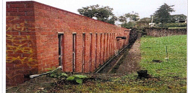
F3: Mantenimiento a sistema de impermeabilizante en losa de azotea y muros de los edificios A-59c de la Facultad de Artes.
