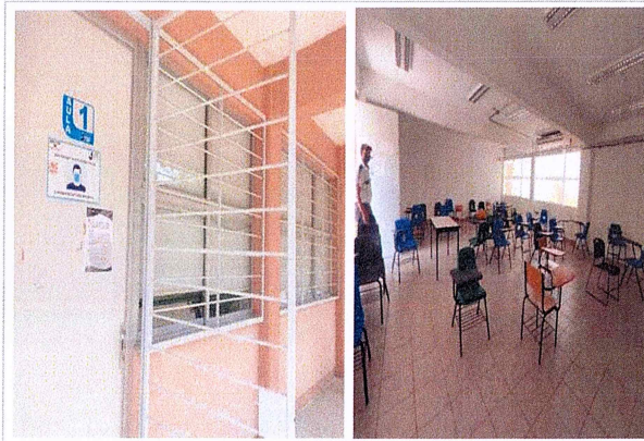
F1: Se equipará Salón /Aula 1 Edificio 18 (Planta Baja), con 1 proyector.
