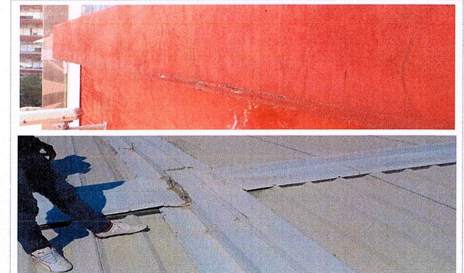
F2: Mantenimiento al sistema de impermeabilizante en muros perimetrales del edificio A-57 del Centro de Investigación en Biotecnología (CEIB).
