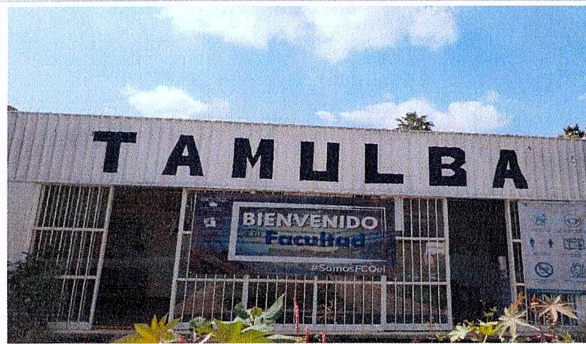
Fachada de la Facultad de la Facultad de Ciencias Químicas e Ingeniería FCQeI, Anexo TAMULBA.
