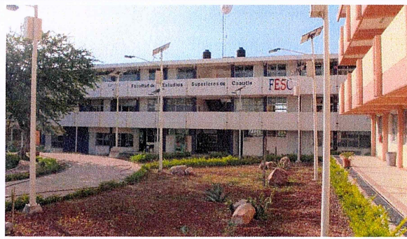
Fachada de la Facultad de Estudios Superiores Cuautla
