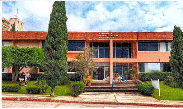
Fachada del CInC.
