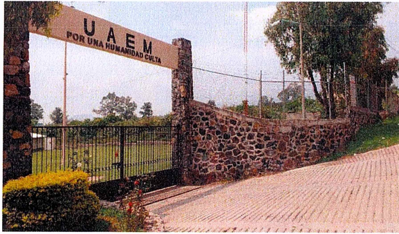
Fachada de la Escuela de Estudios Superiores de Atlatlahucan Subsede Totolapan
