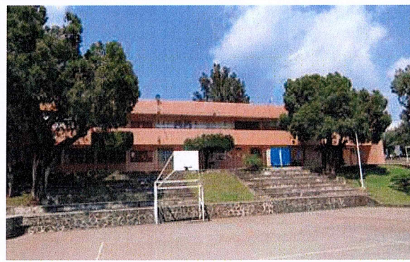
Fachada de la Facultad del Instituto de Ciencias de la Educación ICE, Edificio 29.
