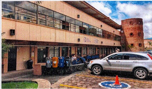
Fachada del CIDC.
