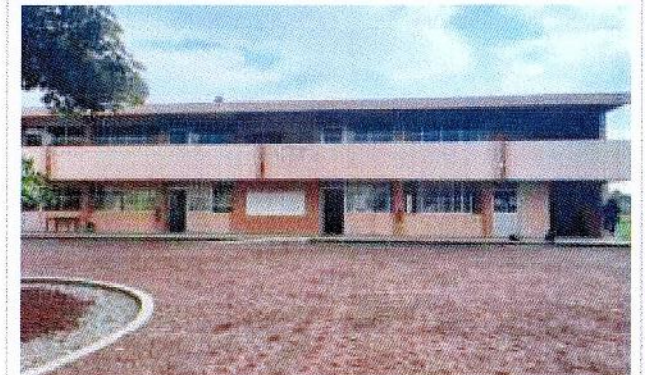
F4: Se equipará edificio de la Escuela de Estudios Superiores de Yecapixtla, con sistema de videovigilancia.
