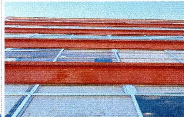
F2: Mantenimiento al sistema de impermeabilizante en muros perimetrales del edificio A-57 del Centro de Investigación en Biotecnología (CEIB).
