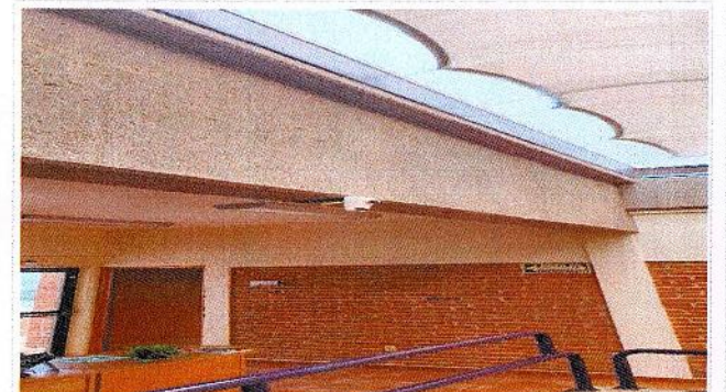
F6: Laboratorios exteriores del CIICAp equipados, con 1 sistema de seguridad.
