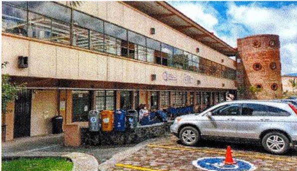
Fachada del CIDC.
