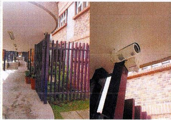
F6: Laboratorios exteriores del CIICAP equipados, con 1 sistema de seguridad.
