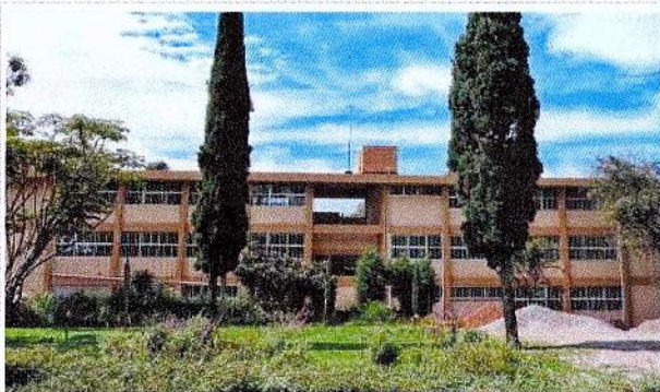
Fachada Edificio nuevo Facultad de Ciencias Biológicas.
