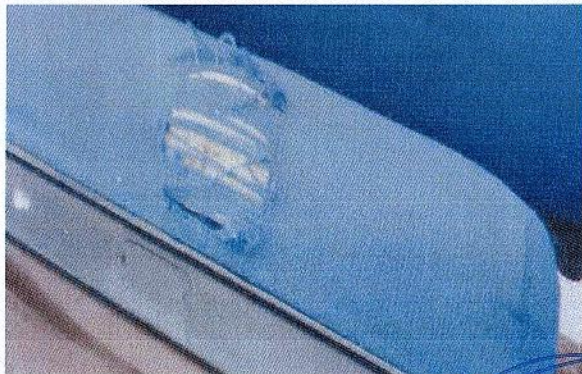
F1: Mantenimiento a la butaquera, alfombra y base metálica de escalinatas en Sala de Usos Múltiples de la Facultad de Arquitectura
