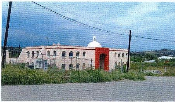
Fachada de la Escuela de Estudios Superiores de Mazatepec Subsede Tetecala
