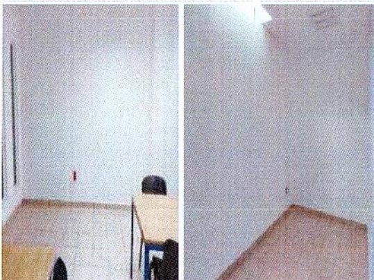
F2: Se equipará Biblioteca, con 2 estantes de acero y 1 de seis niveles.
