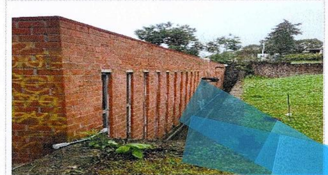
F3: Mantenimiento a sistema de impermeabilizante en losa de azotea y muros de los edificios A-59c de la Facultad de Artes.
