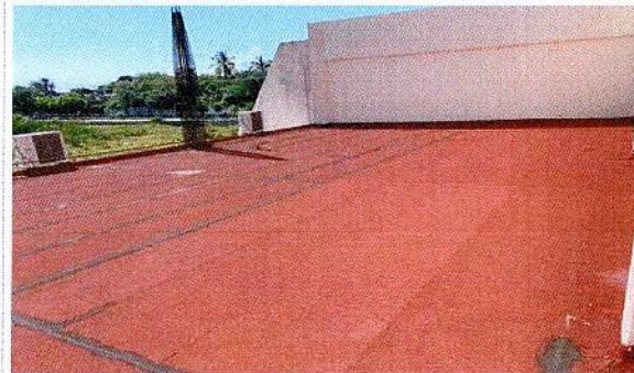
F1: Mantenimiento a impermeabilizante de azotea en Edificio Principal de la Escuela de Estudios Superiores de Mazatepec, Subsede Tetecala.
