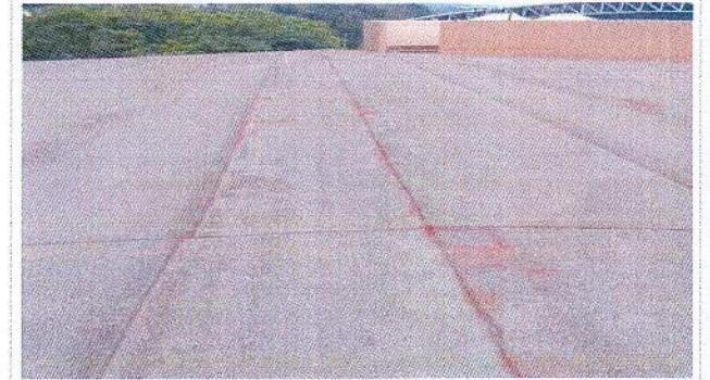
F1: Mantenimiento al sistema de Impermeabilización de azotea en el edificio Principal de la Estación Biológica el Limón, adscrita al CIByC.
