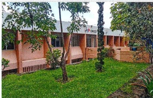
Fachada del CINCCO.
