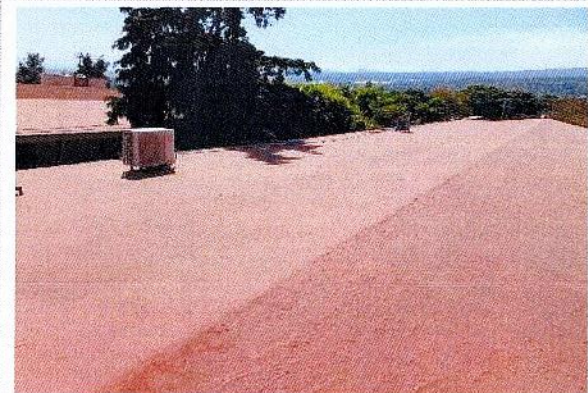
F1: Mantenimiento al sistema de impermeabilizante en azoteas de los edificios A-24 de la Facultad de Derecho y Ciencias Sociales.
