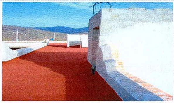
F1: Mantenimiento al sistema de Impermeabilización de azotea en el edificio Principal de la Estación Biológica el Limón, adscrita al CIByC.
