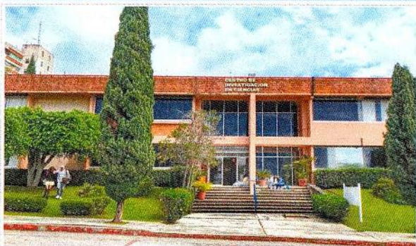
Fachada del CInC.
