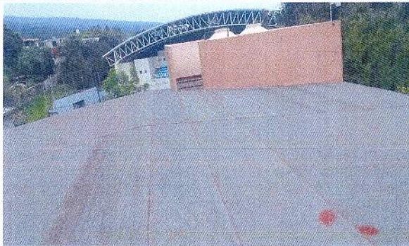
F2: Mantenimiento a Impermeabilizante de azoteas de los edificios A-66 y A-67 de la Facultad de Ciencias del Deporte.
