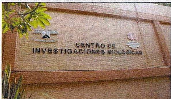
Fachada del CIB (Edificio nuevo)
