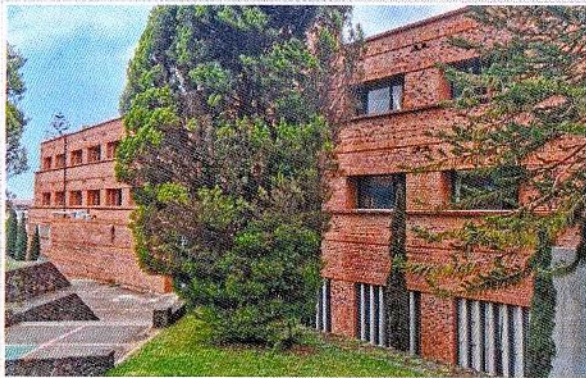
Fachada del CIICAp
