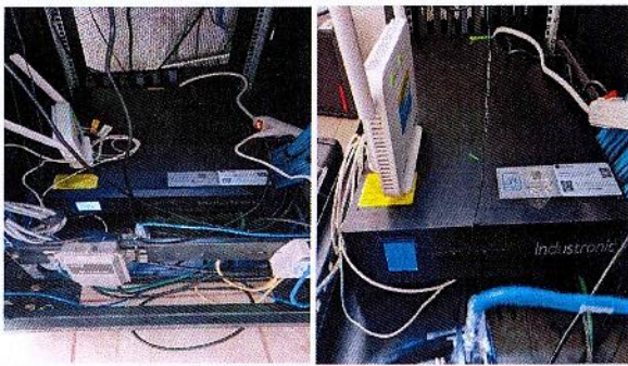
F1: Se instaló UPS en el Centro de Cómputo, 1 pieza.
