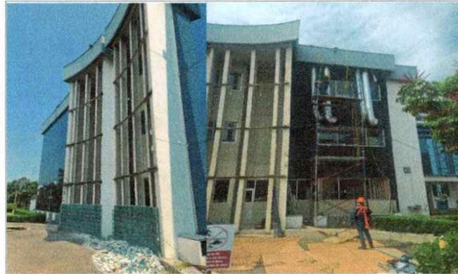
Trabajos de desmontajes y retiro de piezas de vidrio - vidrio vitrobloc y desmantelamiento de fachada Integral (cristal - vidrio templado) con recuperación, en el Centro de Investigaciones Químicas.
