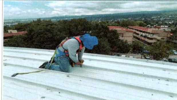
Trabajos de sustitucion de tornillos y pijas de cubierta, en el edificio A-38 Polideportivo 02
