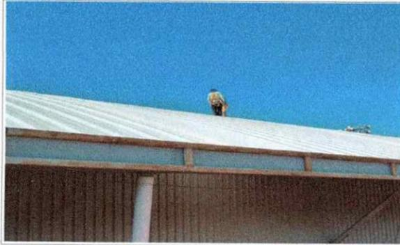
Trabajos de sustitución de tornillos y pijas de cubierta, en el edificio A-37 Polideportivo 01.
