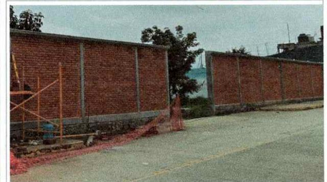
Vista en donde se realizaron trabajos de: Elaboración y colocación de reja de herrería con placas de acero y perfiles OC, OR con primer y pintura de esmalte, así como los trabajos de albañilería complementarios para la Escuela de Estudios Superiores de Atlatlahucan.
