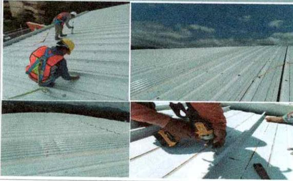
Trabajos de sustitucion de tornillos y pijas de cubierta, en el edificio A-38 Polideportivo 02
