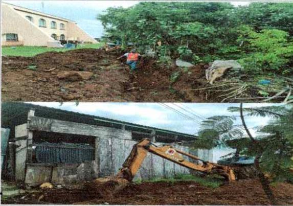
Trabajos de excavación por medios mecánicos de material tipo I-II y cepa en material tipo II en la, (Escuela de Estudios Superior de Atlatlahucan).
