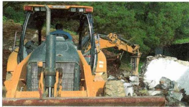
Trabajos de demolición por medios mecánicos de muro de mampostería, en la Facultad de Ciencias Químicas e Ingeniería.
