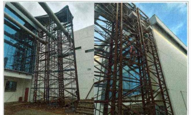
Trabajos de retiro de capas de corrosión sobre perfiles metálicos, en el Centro de Investigaciones Químicas (CIQ).
