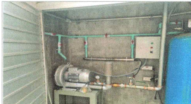
Trabajos de suministro, instalación y prueba en funcionamiento de sistema de clorado, para la Escuela de Turismo.
