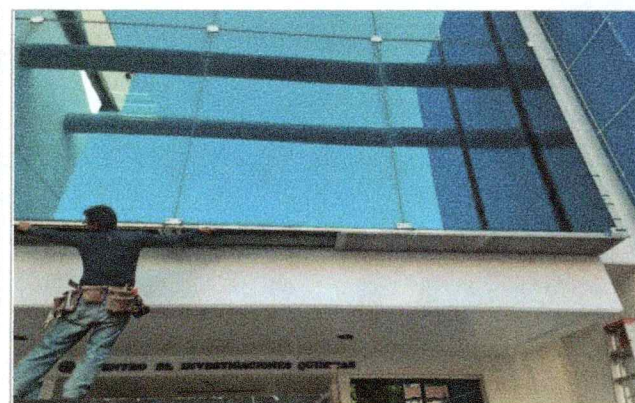
Trabajos de suministro e instalación de tapa junta, en el Centro de Investigaciones Químicas (CIQ).
