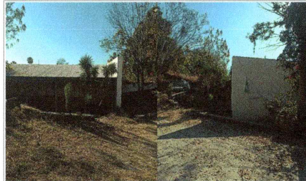
Vistas del sitio donde se realizarán trabajos: Preliminares que incluyen demolición, retiro de escombros, entre otros; para la Facultad de Ciencias Químicas e Ingeniería (TAMULBA).
