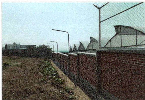
Imagen 1 del proyecto "Construcción de barda de colindancia de la Escuela de Estudios Superiores de Atlatláhuacan".
