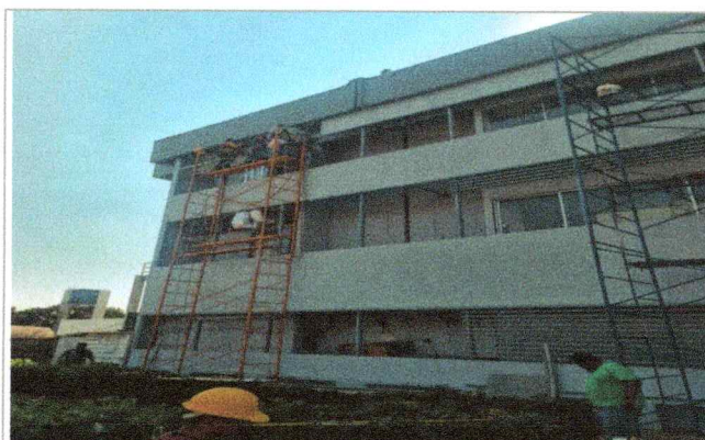
Trabajos de suministro y colocación de muro de placa cemento de Durock fijada en bastidores metálicos, en el Centro de Investigaciones Químicas (CIQ).
