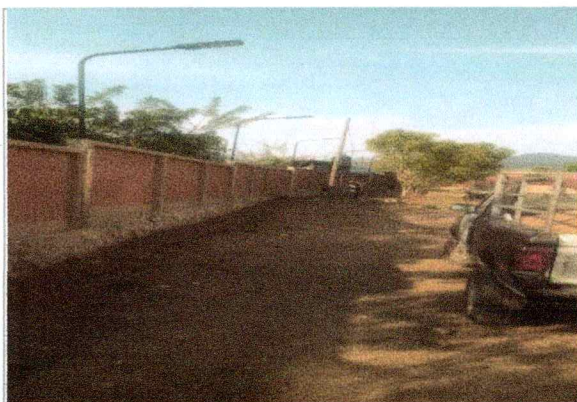
Trabajos de suministro e instalación de lámpara solar con sensor, para la Escuela de Estudios Superiores de Atlatláhuacan.
