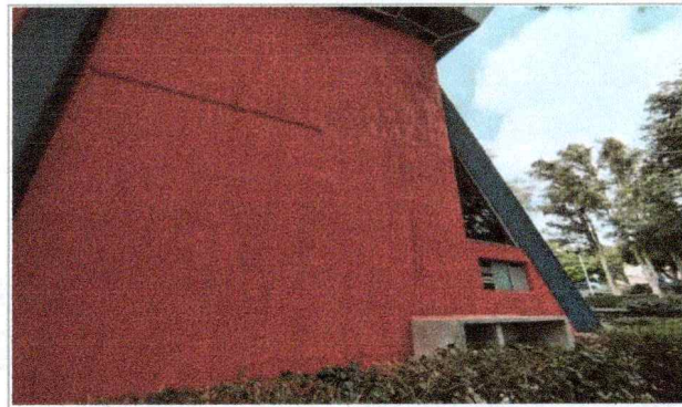
Imagen 3 del proyecto "Mantenimiento a espacios de actividad física y deportiva en el Campus Norte en el edificio A-20 Gimnasio Auditorio".
