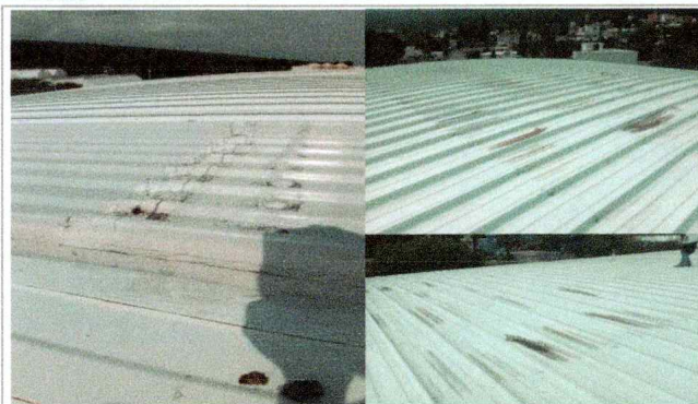
Vistas del sitio en donde se realizarán los trabajos de: Mantenimiento a la Cubierta existente, en el edificio A-38 Polideportivo 02.
