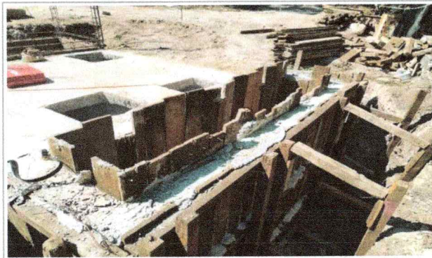
Trabajos de, suministro, instalación, prueba y puesta en funcionamiento de tablero de sistema de clorado, con un canal desnatador y clorador en la Escuela de Estudios Superiores del Jicarero.
