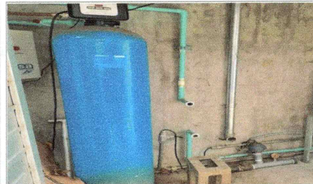
Trabajos de, suministro, instalación, pruebas y puesta en funcionamiento de Sistema de filtración de agua, en la Facultad de Contaduría, Administración e Informática.
