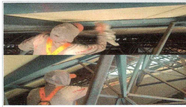
Trabajos de preparación de la superficie y aplicación de pintura en estructura, en el edificio A-20 Gimnasio Auditorio.
