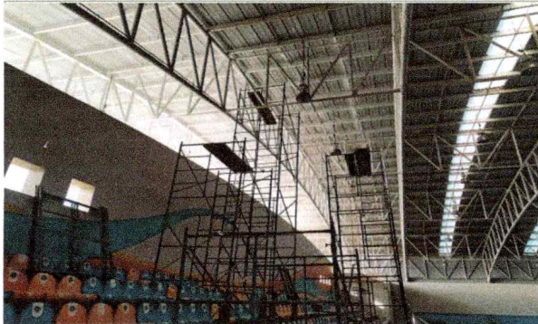
Trabajos de suministro y colocación de cinta autoadhesiva impermeable en cubierta así como sellado perimetral en lámina traslúcida en cubierta, del edificio A-38 Polideportivo 02.
