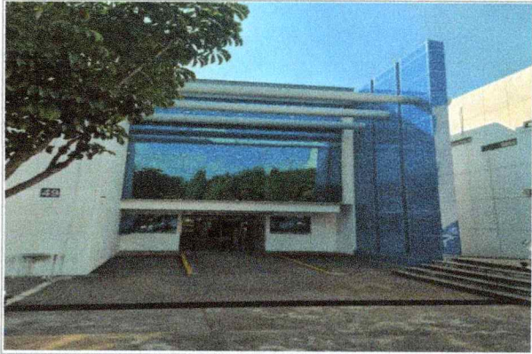
Imagen 4 del proyecto "Adecuaciones y mejoras en las fachadas y columnas del Centro de Investigaciones Químicas".
