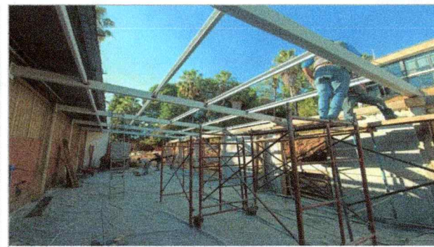
Trabajos de estructura metálica (acero misceláneo/ placas, cartabones, anclas, pernos), en la Facultad de Ciencias Químicas e Ingeniería (TAMULBA).
