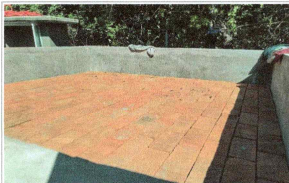
Instalación, conexión, y pruebas de tolva para secado de lodos Escuela de Estudios Superiores del Jicarero.
