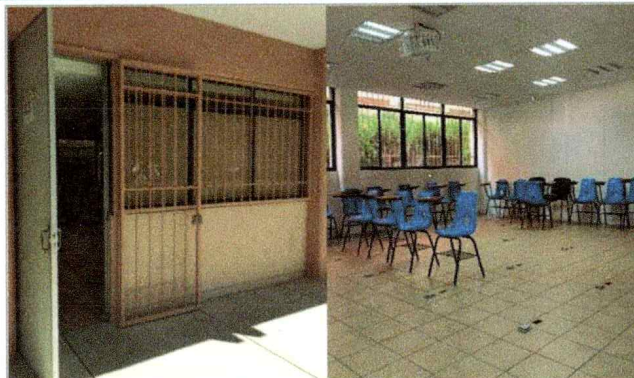
Se equipará Centro de cómputo con 1 aire acondicionado
