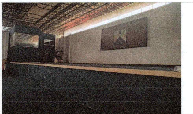
Imagen 5 del proyecto "Mantenimiento a espacios de actividad física y deportiva en el Campus Norte en el edificio A-20 Gimnasio Auditorio".
