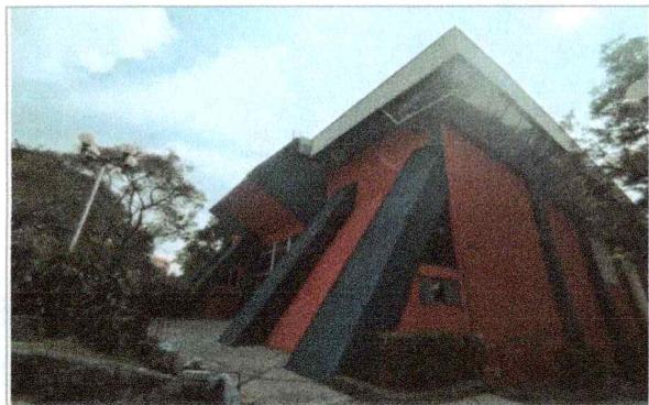
Imagen 1 del proyecto "Mantenimiento a espacios de actividad física y deportiva en el Campus Norte en el edificio A-20 Gimnasio Auditorio".
