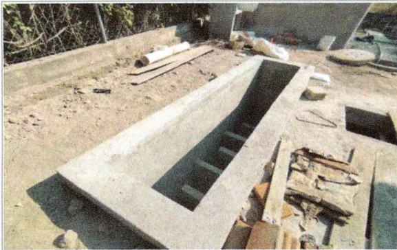
Instalación, prueba y puesta en funcionamiento de tablero del sistema de clorador, con canal desnatador y clorador, Escuela de Estudios Superiores del Jicarero.
