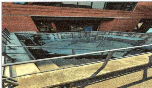
Imagen 2 del proyecto "Mantenimiento a planta de tratamiento, en la Facultad de Contaduría, Administración e Informática".
