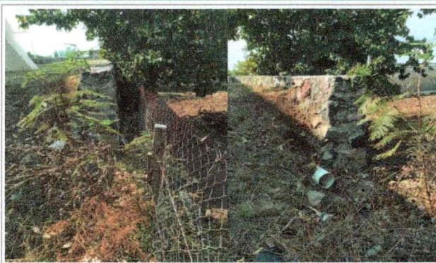
Vistas en donde se realizaran trabajos: Preliminares que incluyen limpieza, retiro de escombros, entre otros; para la Escuela de Estudios Superiores de Atlatlahucan.
