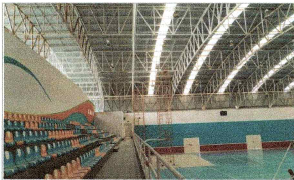
Trabajos de preparación de la superficie (estructura), así como la aplicación de pintura/esmalte, en el edificio A-37 Polideportivo 01.
