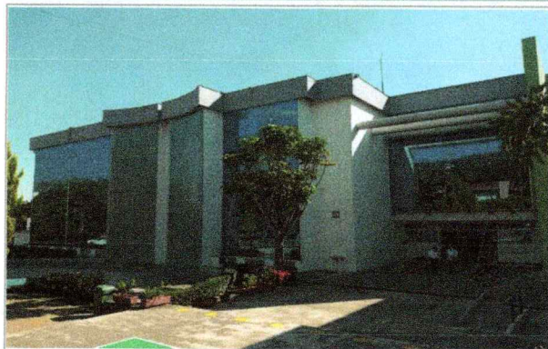
Adecuaciones y mejoras en las fachadas y columnas del Centro de Investigaciones Químicas
