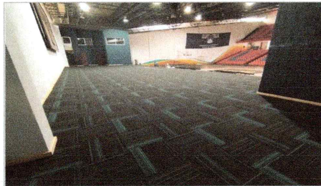
Trabajos de limpieza Fina de obra para entrega, para el edificio A-20 Gimnasio Auditorio.
