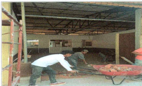
Trabajos de demolición de muro, en la Facultad de Ciencias Químicas e Ingeniería (TAMULBA).
