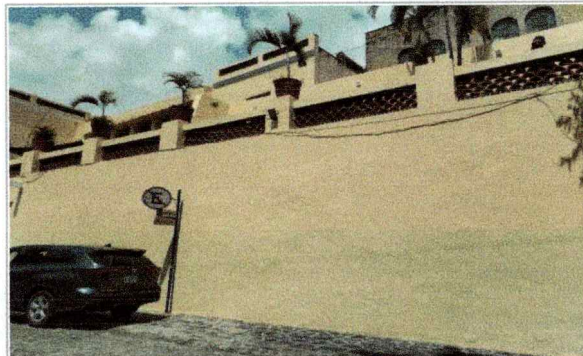
Trabajos de suministro y aplicación de pintura, para la Escuela de Teatro, Danza y Música.
