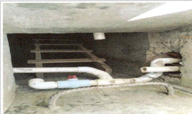
Trabajos de suministro, instalación, pruebas y puesta en funcionamiento de tuberías y accesorios, Escuela de Estudios Superiores del Jicarero.
