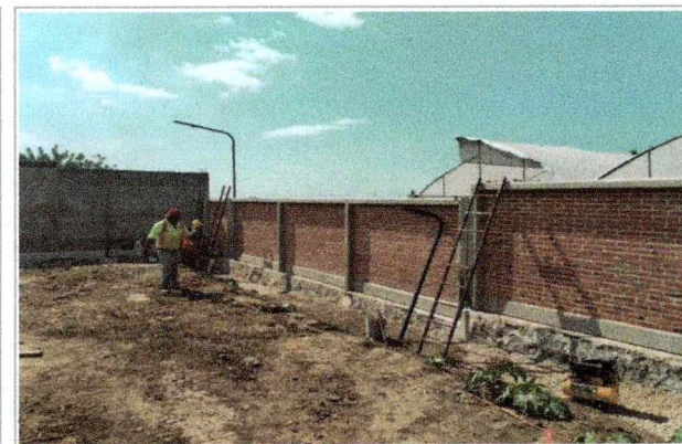
Trabajos de suministro e instalación de lámpara solar con sensor, para la Escuela de Estudios Superiores de Atlatláhuacan.
