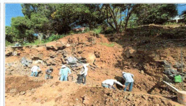
Trabajos de, excavación de cepa a mano, en la Facultad de Ciencias Químicas e Ingeniería (TAMULBA).
