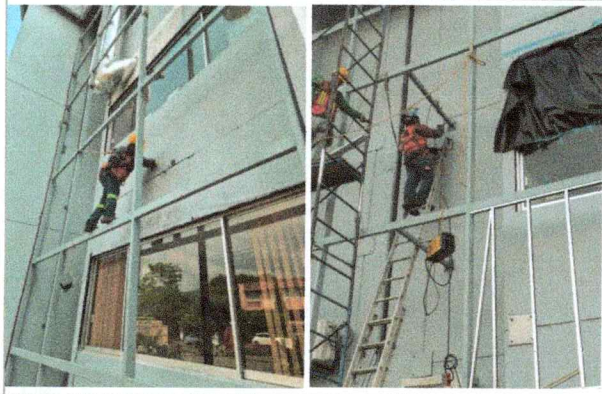
Trabajos de suministro, habilitado y montaje de acero misceláneo en el Centro de Investigaciones Químicas (CIQ).
