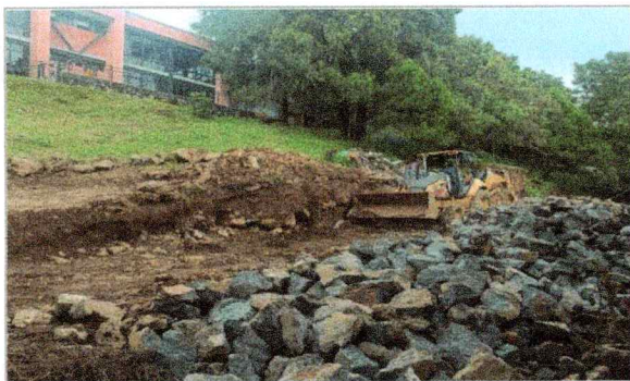
Trabajos de acarreo en camión de material escombros producto de los trabajos Facultad de Ciencias Químicas e Ingeniería (TAMULBA).
