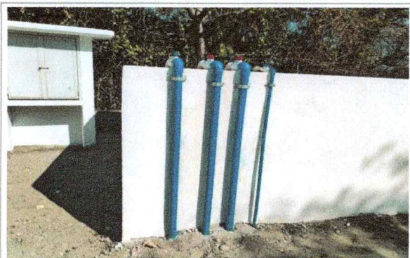
Imagen 4 del proyecto: "Construcción de la planta de Tratamiento de Aguas Residuales de la Escuela de Estudios Superiores del Jicarero".
