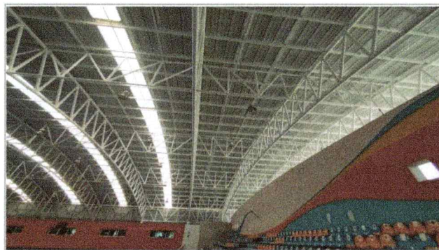
Trabajos de preparación de la superficie (estructura), así como la aplicación de pintura/esmalte, en el edificio A-37 Polideportivo 01.
