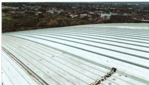
Imagen 8 del proyecto "Mantenimiento a espacios de actividad física y deportiva en el Campus Norte en el edificio A-37 Polideportivo 01. ".
