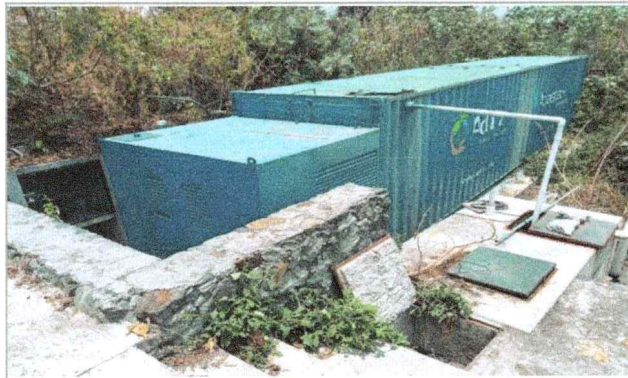
Vista del sitio en donde se realizaran los trabajos de: Limpieza de elementos, Así como Albañilerías para optimización de sistemas, para la Facultad de Ciencias Biológicas.
