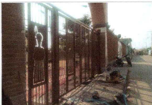
Trabajos de elaboración e instalación de portón de herrería, para la Escuela de Estudios Superiores de Atlatláhuacan.
