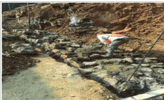
Trabajos de muro de mampostería con piedra de la región, en la Facultad de Ciencias Químicas e Ingeniería (TAMULBA).
