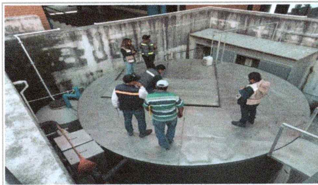
Trabajos de puesta en funcionamiento de planta de tratamiento, en la Facultad de Contaduría, Administración e Informática.
