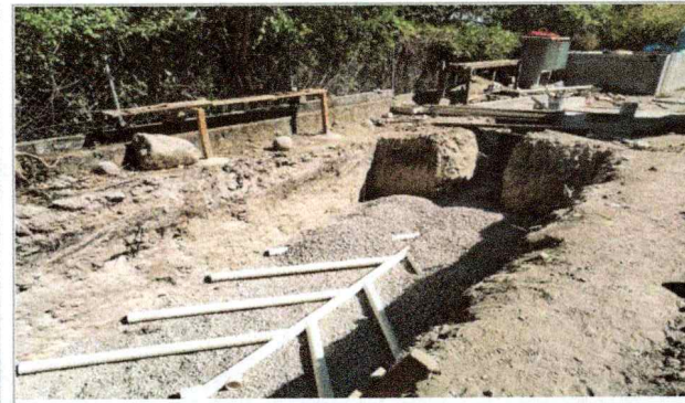
Trabajos de construcción de campo de oxidación (Excavación y compactación, tubería, accesorios, relleno), Escuela de Estudios Superiores del Jicarero.
