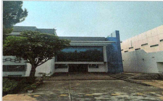
Imagen 5 del proyecto "Adecuaciones y mejoras en las fachadas y columnas del Centro de Investigaciones Químicas".
