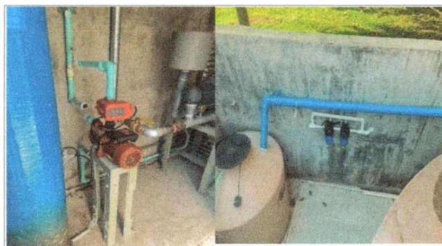
Trabajos de suministro e instalación de filtro y bomba para riego (sistema de filtración de agua), La Escuela de Turismo.
