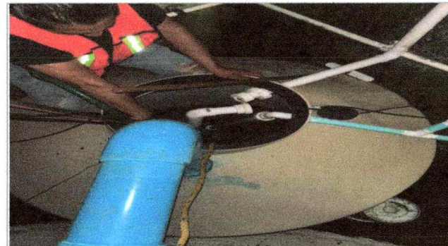
Trabajos de suministro, instalación, pruebas y puesta en funcionamiento de tuberías y accesorios para la Escuela de Turismo.
