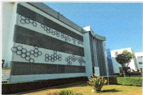
Imagen 1 del proyecto "Adecuaciones y mejoras en las fachadas y columnas del Centro de Investigaciones Químicas".
