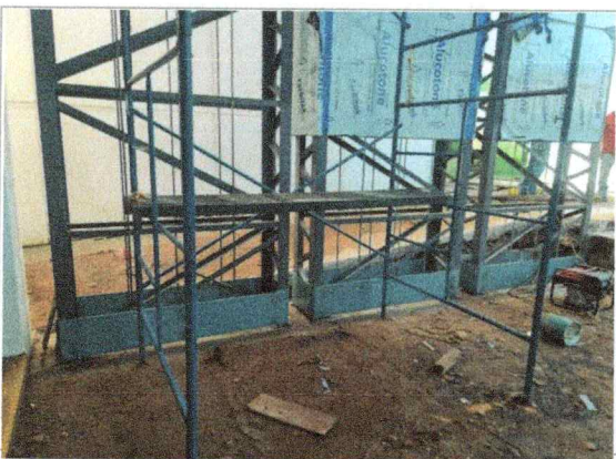
Trabajos de habilitado de acero misceláneo, en el Centro de Investigaciones Químicas (CIQ).
