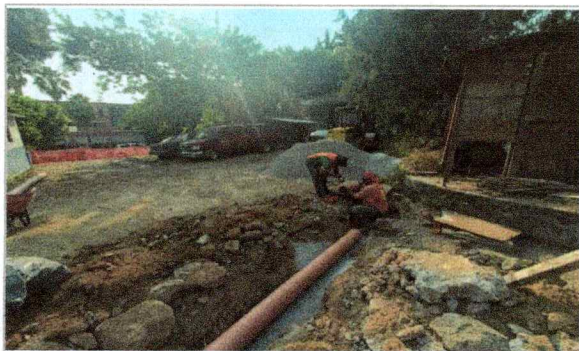
Trabajos de tubo sanitario, en la Facultad de Ciencias Químicas e Ingeniería (TAMULBA).
