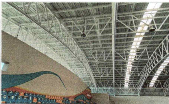
Imagen 1 del proyecto "Mantenimiento a espacios de actividad física y deportiva en el Campus Norte en el edificio A-37 Polideportivo 01. ".
