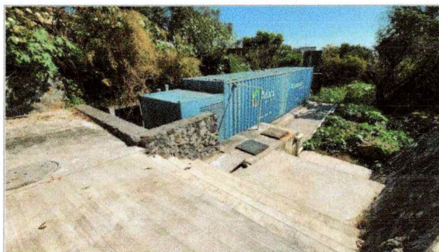
Imagen 2 del proyecto "Mantenimiento a planta de tratamiento, para la Facultad de Ciencias Biológicas".
