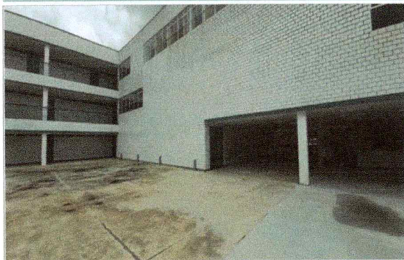
Fachada de la Facultad de Contaduría, Administración e Informática.
