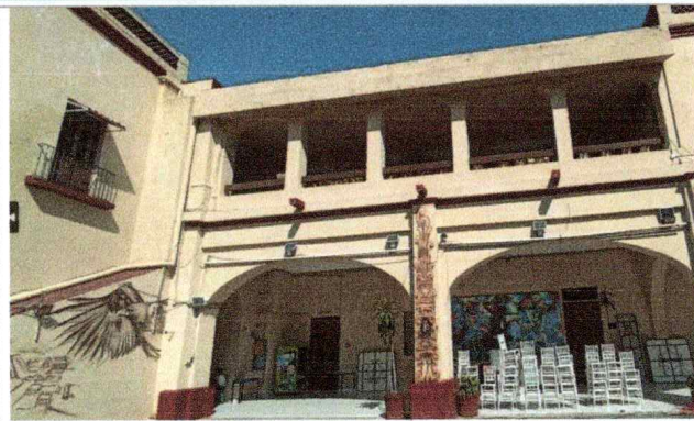
Vista del sitio en donde se relizaran los trabajos de Mantenimiento como : Preliminares y Albañilerías (Retiros, Colocacion de Protecciones, Resanes entre otros), para la Escuela de Teatro, Danza y Música.
