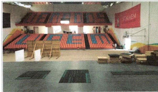
Trabajos de suministro e instalación de alfombra modular en escenario, para el edificio A-20 Gimnasio Auditorio.
