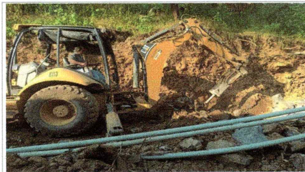
Trabajos de picado de piedra por medios mecánicos para su reutilización, en la Facultad de Ciencias Químicas e Ingeniería (TAMULBA).
