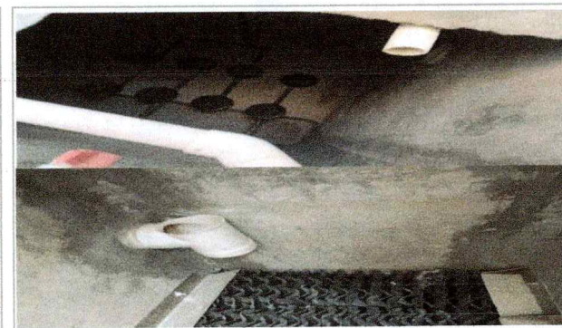
Trabajos de suministro de sistema de clorado y sistema de filtración de agua, Escuela de Estudios Superiores del Jicarero.
