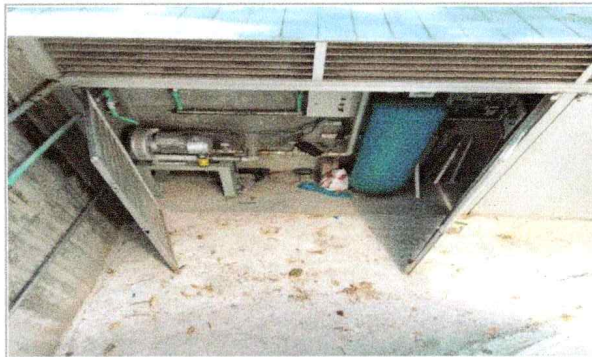
Trabajos de pruebas y puesta en funcionamiento de la planta de tratamiento para la Escuela de Turismo.
