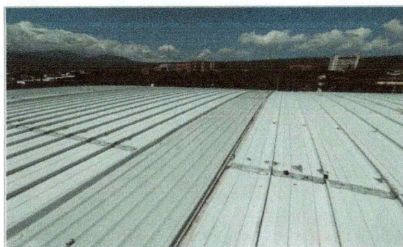
Imagen 7 del proyecto "Mantenimiento a espacios de actividad física y deportiva en el Campus Norte en el edificio A-37 Polideportivo 01. ".
