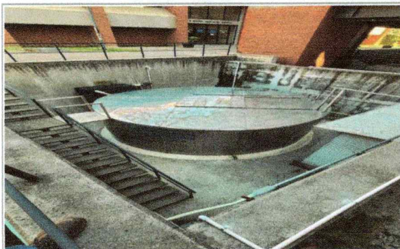
Imagen 1 del proyecto "Mantenimiento a planta de tratamiento, en la Facultad de Contaduría, Administración e Informática".
