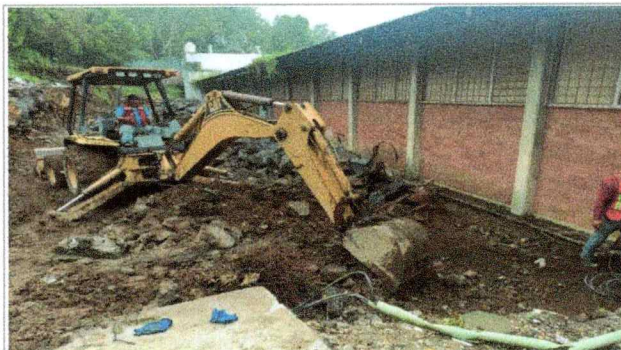
Trabajos de Acarreo en camión de material escombros producto de los trabajos Facultad de Ciencias Químicas e Ingeniería (TAMULBA).
