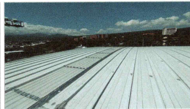
Imagen 6 del proyecto "Mantenimiento a espacios de actividad física y deportiva en el Campus Norte en el edificio A-37 Polideportivo 01. ".
