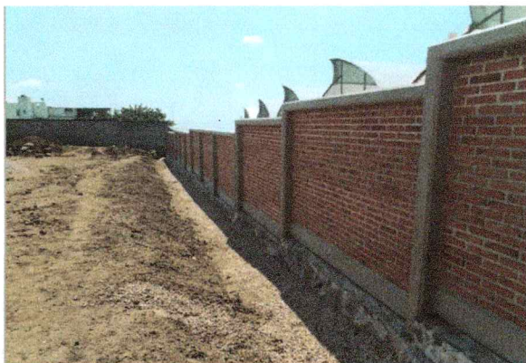
Trabajos de, filtro de grava triturada, así como la colocación de dren de PVC 4", en la Escuela de Estudios Superiores de Atlaltlahucan.
