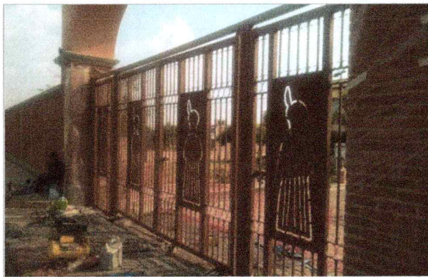
Trabajos de elaboración e instalación de portón de herrería, para la Escuela de Estudios Superiores de Atlatláhuacan.
