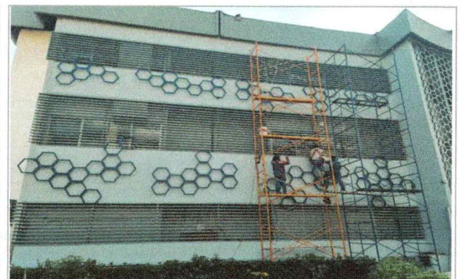
Trabajos de suministro e instalación de acero misceláneo, y aplicación de pintura esmalte Centro de Investigaciones Químicas (CIQ).
