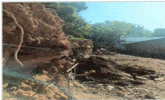
Trabajos de excavación en roca por medios mecánicos en la Facultad de Ciencias Químicas e Ingeniería (TAMULBA).
