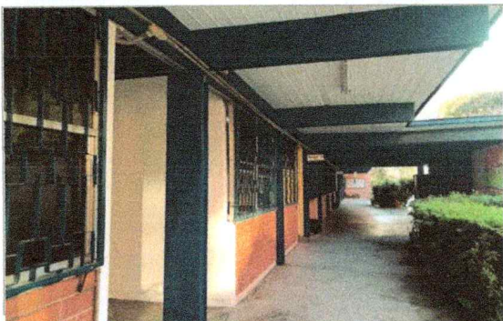
Imagen 1 del proyecto "Mantenimiento a espacios académicos en el edificio A-5 Centro de Lenguas (CELE).
