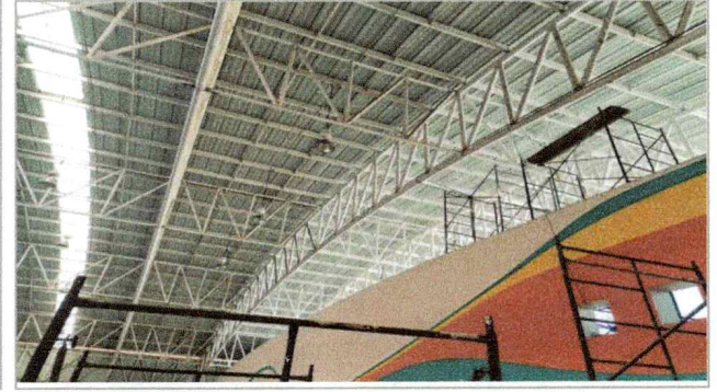
Trabajos de preparación de la superficie, así como aplicación de pintura en estructura de cubierta en el edificio A-38 Polideportivo 02.
