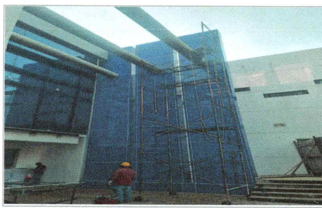
Trabajos de suministro y colocación de panel compuesto de aluminio (ALUCUBOND) en el Centro de Investigaciones Químicas (CIQ).
