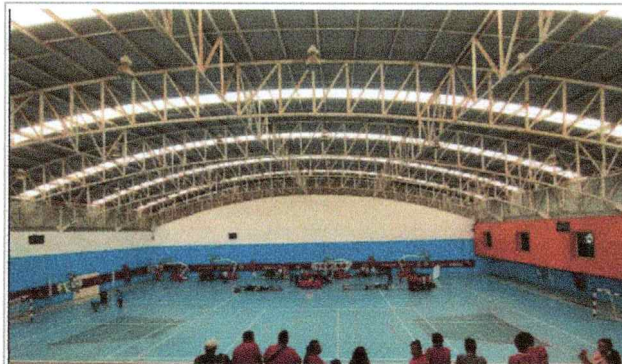
Vista del sitio en donde se realizarán los trabajos de: Mantenimiento a la estructura metálica existente con pintura de esmalte, para el edificio A-37 Polideportivo 01.
