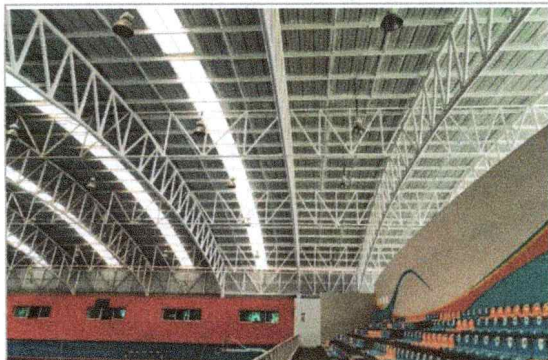
Imagen 4 del proyecto "Mantenimiento a espacios de actividad física y deportiva en el Campus Norte en el edificio A-37 Polideportivo 01. ".
