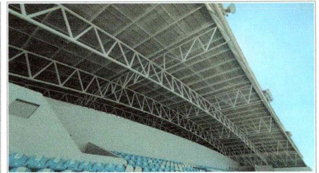
Imagen 3 del proyecto "Mantenimiento a espacios de actividad física y deportiva en el Campus Norte en el edificio A-38 Polideportivo 02".
