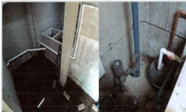
Vistas del sitio en donde se realizarán los trabajos de: Limpieza de elementos, para la Facultad de Psicología.
