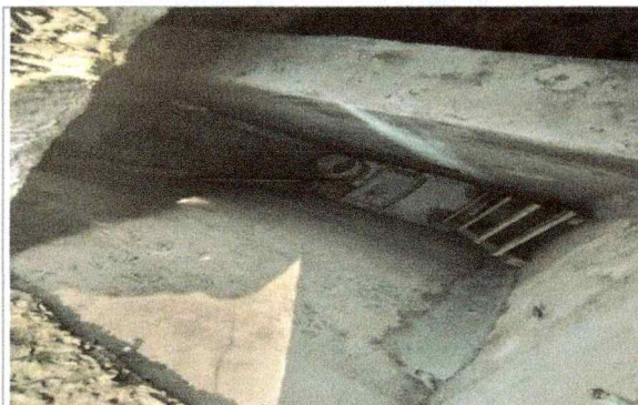
Se continúan los trabajos de construcción de tanques de aireación, sedimentación, cárcamo de bombeo y tanque de cloración, Escuela de Estudios Superiores de Jicarero.
