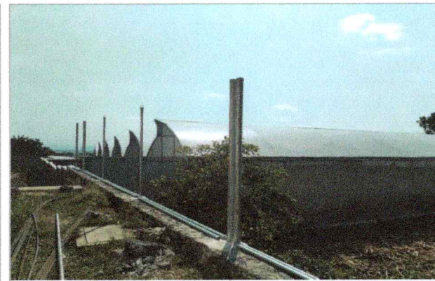
Trabajos de demoliciones en muro de piedra existente así como elaboración de anclajes con concreto de soportes para malla ciclónica, en la Escuela de Estudios Superiores de Atlaltlahucan.
