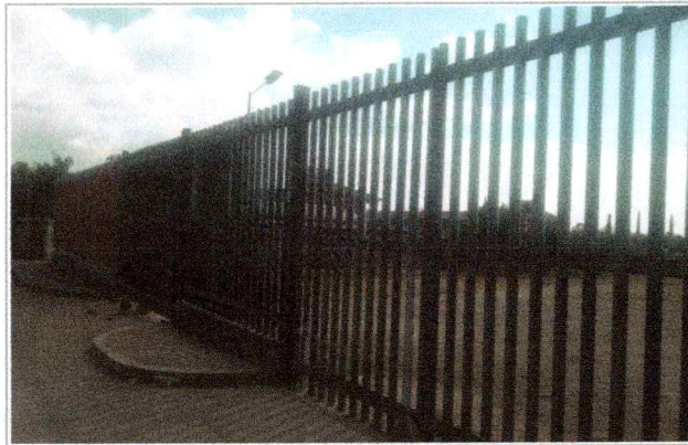
Imagen 5 del proyecto "Construcción de barda de colindancia de la Escuela de Estudios Superiores de Atlatláhuacan".
