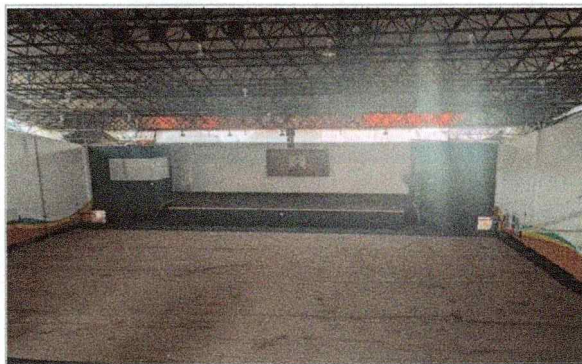
Trabajos de pintura en muros interiores, para el edificio A-20 Gimnasio Auditorio.
