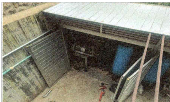
Trabajos de rehabilitación, pruebas y puesta en funcionamiento del sistema de filtración de agua, para la Escuela de Turismo.
