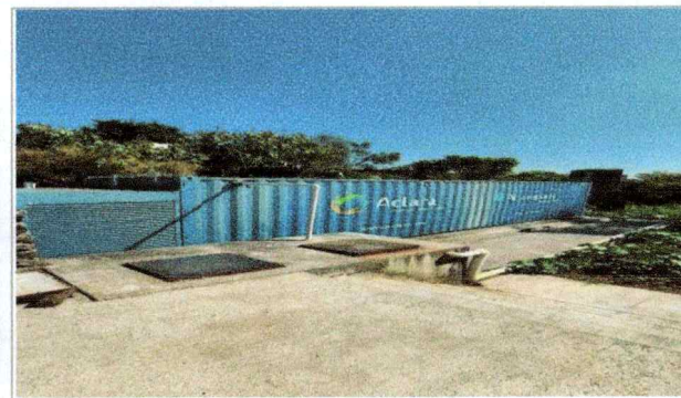
Imagen 3 del proyecto "Mantenimiento a planta de tratamiento, para la Facultad de Ciencias Biológicas".
