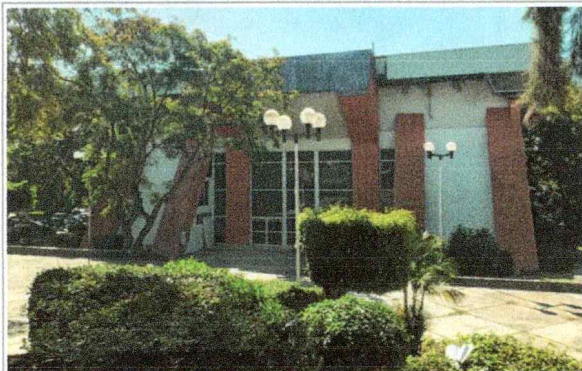
Fachada del Gimnasio Auditorio (Edif. A-20)
