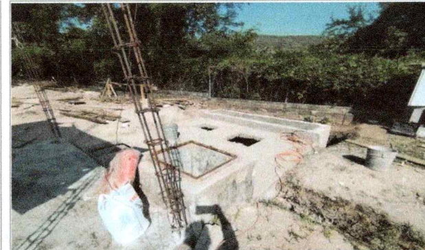
Se continúan los trabajos de construcción de tanques de aireación, sedimentación, cárcamo de bombeo y tanque de cloración, Escuela de Estudios Superiores de Jicarero.
