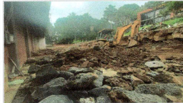
Trabajos de desprendimientos de piedra suelta Facultad de Ciencias Químicas e Ingeniería (TAMULBA).
