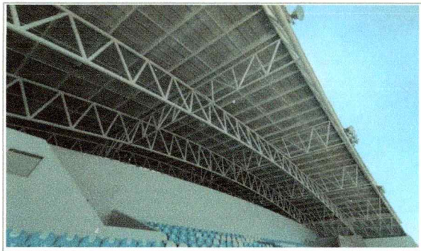
Imagen 1 del proyecto "Mantenimiento a espacios de actividad física y deportiva en el Campus Norte en el edificio A-38 Polideportivo 02".
