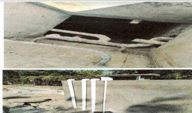
Trabajos de suministro, instalación, de paquete de tuberías y accesorios, en la Escuela de Estudios Superiores del Jicarero.
