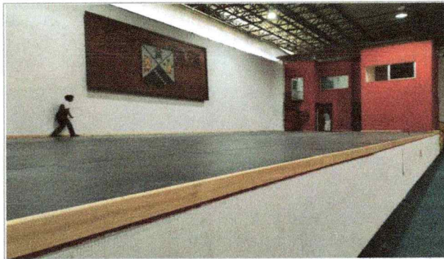
Trabajos de suministro e instalación de moldura de madera en escenario, para el edificio A-20 Gimnasio Auditorio.
