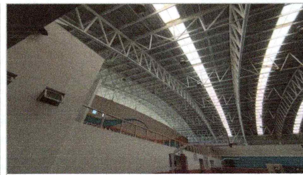
Imagen 3 del proyecto "Mantenimiento a espacios de actividad física y deportiva en el Campus Norte en el edificio A-37 Polideportivo 01. ".
