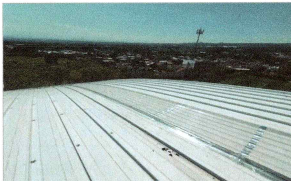
Imagen 5 del proyecto "Mantenimiento a espacios de actividad física y deportiva en el Campus Norte en el edificio A-37 Polideportivo 01. ".
