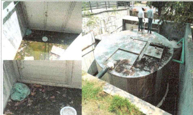
Vistas del sitio en donde se realizaron los trabajos de: Limpieza de elementos, Así como Albañilerías para optimización de sistemas, para la Escuela de Turismo.
