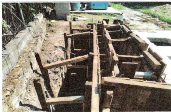
Trabajos de, suministro, instalación, prueba y puesta en funcionamiento de tablero de sistema de clorado, con un canal desnatador y clorador, en la Escuela de Estudios Superiores del Jicarero.
