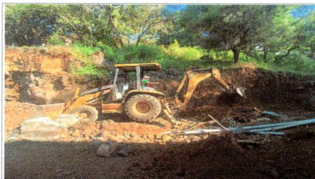
Trabajos de, desprendimientos de piedra suelta por medio mecánicos, en la Facultad de Ciencias Químicas e Ingeniería (TAMULBA).
