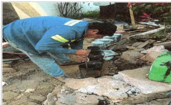
Trabajos de pruebas de Laboratorio de toma de muestra de concreto, en la Facultad de Ciencias Químicas e Ingeniería (TAMULBA).
