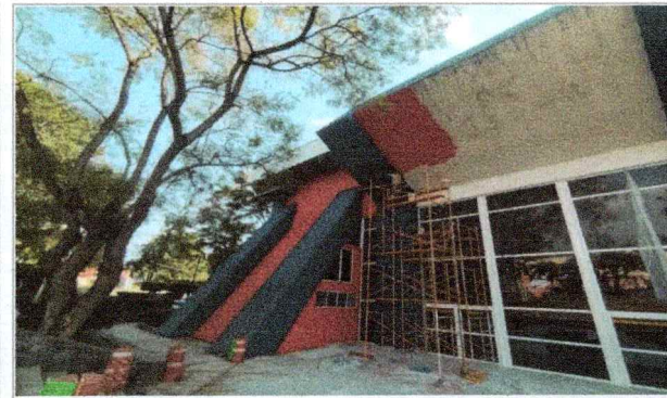
Trabajos de pintura en muros de fachadas, para el edificio A-20 Gimnasio Auditorio.
