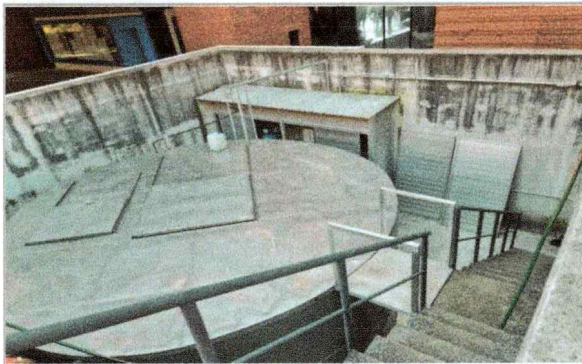
Trabajos de suministro e instalación de filtro y bomba para riego (sistema de filtración de agua), en la Facultad de Contaduría, Administración e Informática.
