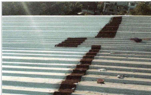
Trabajos de suministro y aplicación de Impermeabilizante híbrido en cubierta, para el edificio A-20 Gimnasio Auditorio.
