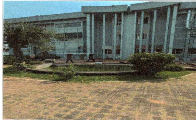
Trabajos de suministro, habilitado y montaje de acero misceláneo en el Centro de Investigaciones Químicas (CIQ).
