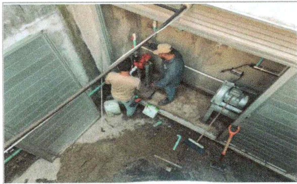
Trabajos de puesta en funcionamiento de planta de tratamiento, en la Facultad de Contaduría, Administración e Informática.
