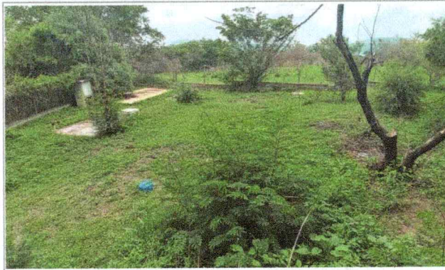
Vista del sitio en donde se realizarán los trabajos de: Preliminares (Delimitar, Nivelación, despalme de terreno, excavaciones, compactaciones entre otras), en la Escuela de Estudios Superiores del Jicarero.
