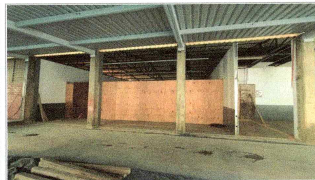
Trabajos de suministro e instalación de cubierta de lamina, en la Facultad de Ciencias Químicas e Ingeniería (TAMULBA).
