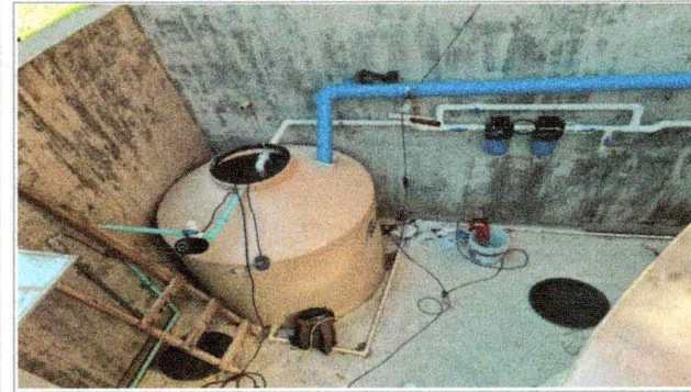
Trabajos de pruebas y puesta en funcionamiento de la planta de tratamiento para la Escuela de Turismo.
