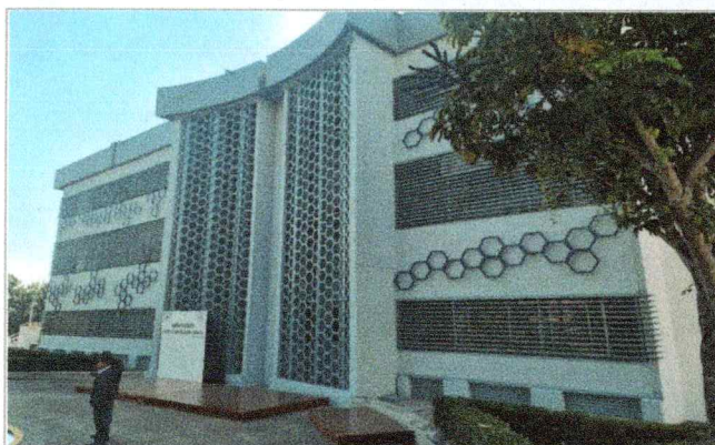
Imagen 2 del proyecto "Adecuaciones y mejoras en las fachadas y columnas del Centro de Investigaciones Químicas".
