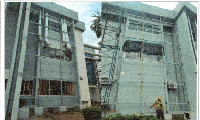
Trabajos de suministro e instalación de refuerzo vertical, para soporte en el Centro de Investigaciones Químicas (CIQ).
