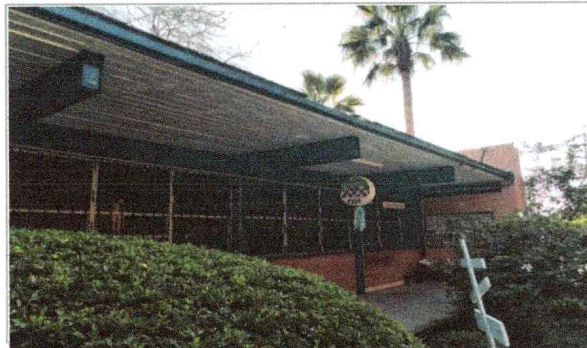
Imagen 2 del proyecto "Mantenimiento a espacios académicos en el edificio A-5 Centro de Lenguas (CELE).
