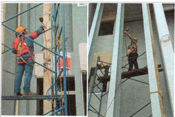
Trabajos de aplicación de pintura esmalte en estructura metálica, en el Centro de Investigaciones Químicas (CIQ).
