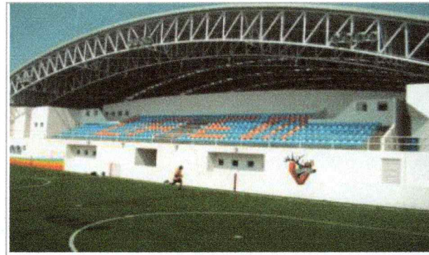
Vista del sitio en donde se realizarán los trabajos de: Mantenimiento a la estructura metálica existente con pintura de esmalte, para el edificio A-37 Polideportivo 01.
