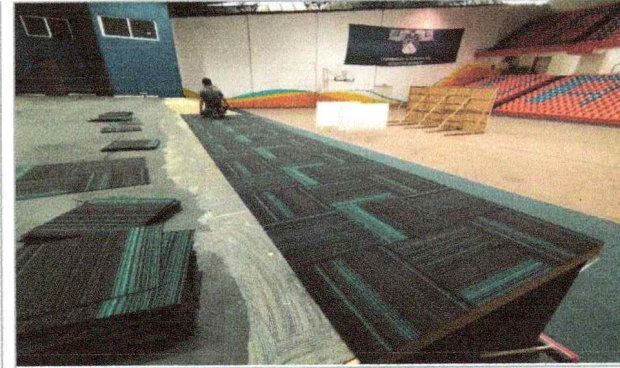
Trabajos de suministro e instalación de alfombra modular en escenario, para el edificio A-20 Gimnasio Auditorio.
