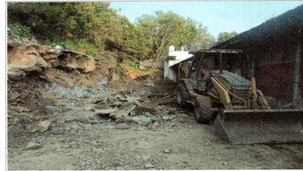
Trabajos de acarreo en camión de material escombros producto de los trabajos, en la Facultad de Ciencias Químicas e Ingeniería (TAMULBA).
