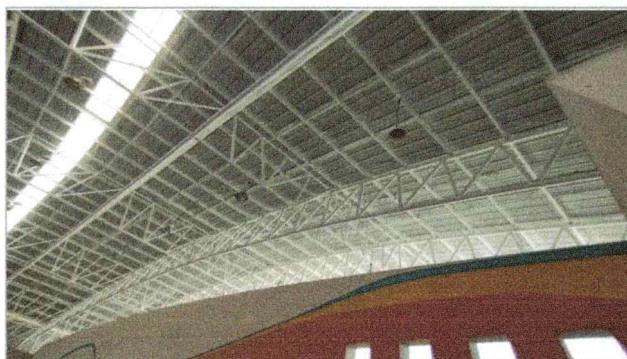
Imagen 2 del proyecto "Mantenimiento a espacios de actividad física y deportiva en el Campus Norte en el edificio A-37 Polideportivo 01. ".
