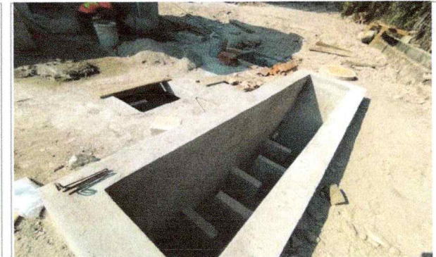
Instalación, prueba y puesta en funcionamiento de tablero del sistema de clorador, con canal desnatador y clorador, Escuela de Estudios Superiores del Jicarero.
