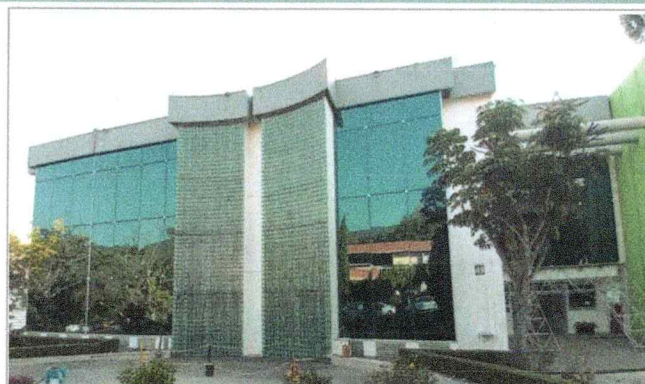
Vista del sitio donde se realizaron los trabajos de : Preliminares (delimitación del área, trazo, nivelación de la superficie, Así como el desmantelamiento de estructura metálica, demoliciones, retiros) , para el Centro de Investigaciones Químicas (CIQ).
