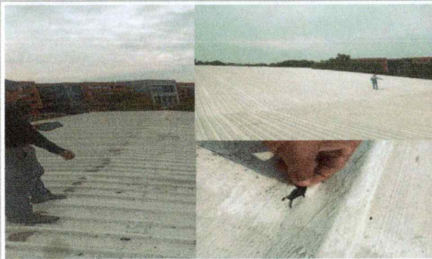
Vista del sitio en donde se realizarán los trabajos de: Mantenimiento al sistema de impermeabilizante en cubierta existente, para el edificio A-20 Gimnasio Auditorio.
