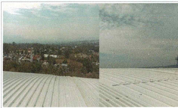
Vistas del sitio en donde se realizarán los trabajos de: Mantenimiento a la Cubierta existente, para el edificio A-37 Polideportivo 01.
