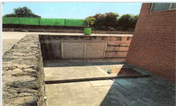
Imagen 1 del proyecto "Mantenimiento a planta de tratamiento, en la Facultad de Psicología".
