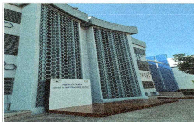
Imagen 3 del proyecto "Adecuaciones y mejoras en las fachadas y columnas del Centro de Investigaciones Químicas".
