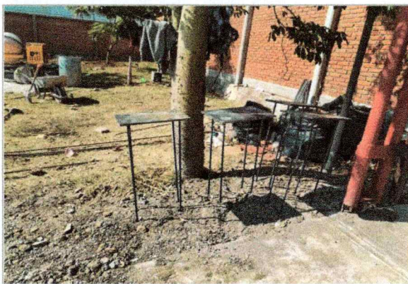
Trabajos de suministro y colocación de acero misceláneo (placas, perfiles, cartabones, anclas, pernos), para la Escuela de Estudios Superiores de Atlatláhuacan.
