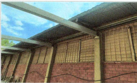
Trabajos de estructura metálica (acero misceláneo/ placas, cartabones, anclas, pernos), en la Facultad de Ciencias Químicas e Ingeniería (TAMULBA).
