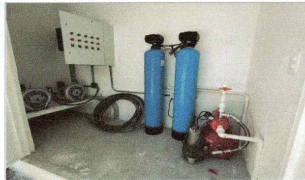
Imagen 6 del proyecto: "Construcción de la planta de Tratamiento de Aguas Residuales de la Escuela de Estudios Superiores del Jicarero".
