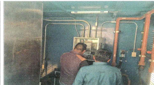
Trabajos de pruebas y puesta en funcionamiento de planta de tratamiento, para la Facultad de Ciencias Biológicas
