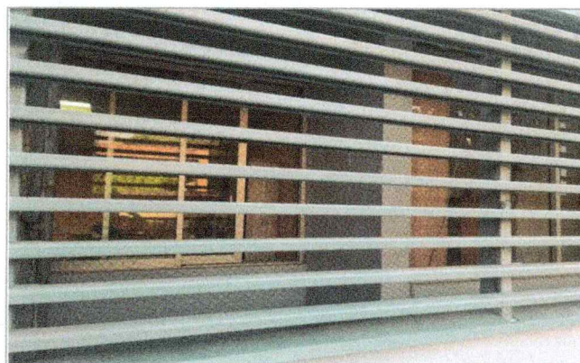
Trabajos de suministro e instalación de mallas anti pájaros, en el Centro de Investigaciones Químicas (CIQ).
