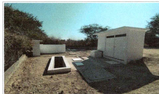
Imagen 3 del proyecto: "Construcción de la planta de Tratamiento de Aguas Residuales de la Escuela de Estudios Superiores del Jicarero".
