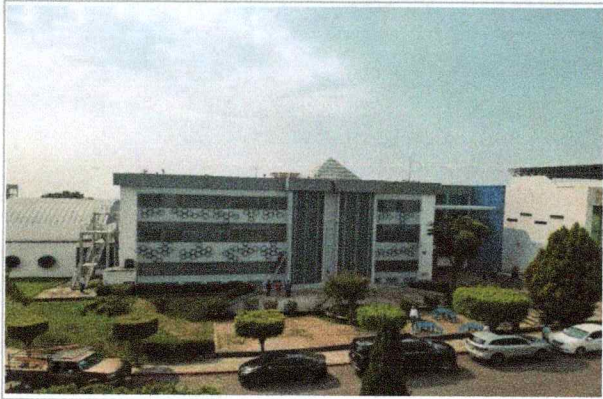
Imagen 7 del proyecto "Adecuaciones y mejoras en las fachadas y columnas del Centro de Investigaciones Químicas".
