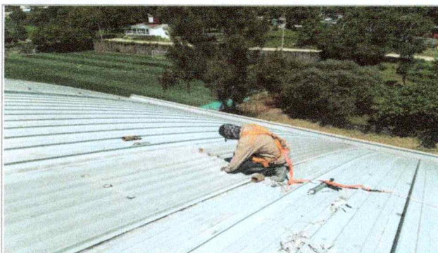
Trabajos de suministro y colocación de cinta autoadhesiva impermeable en cubierta existente, en el edificio A-37 Polideportivo 01.
