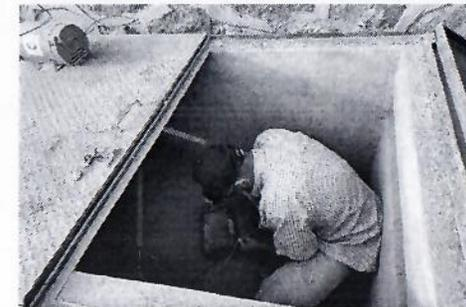
F48: Conexión de bombas existentes a cárcamo seco de cisterna
