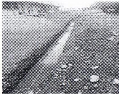
F10. Excavación por medias manuales para colado de guarnición
