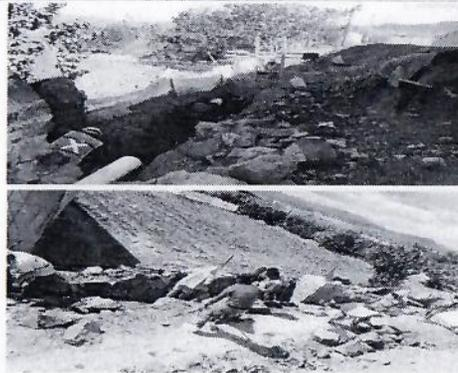
F28: Excavación de terreno por medios manuales para muro de contención de colindancia
