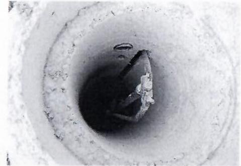
F11: Conexión de cable desnudo a varilla de cobre para sistema de tierras
