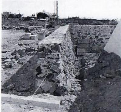
F18: Construcción de muro de contención para soporte de contrafuertes fachada sur
