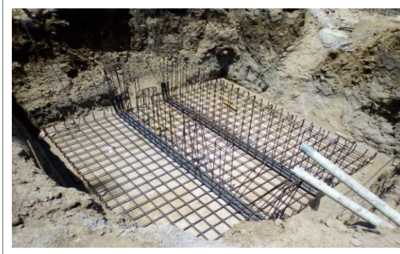
F11: Habilitado de acero de zapata aislada y contratraves
