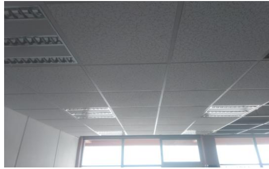
F7: Colocación de falso plafón modular y luminarias
