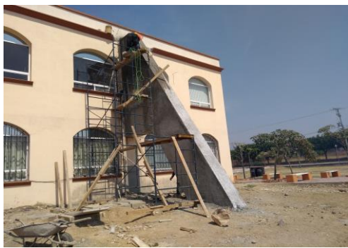
F16: Aplanado fino en contrafuertes
