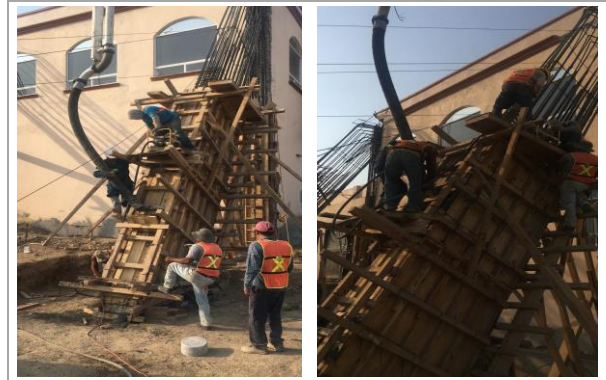
F6: Colado con concreto f'c=250 kg/cm 2 de contrafuertes
