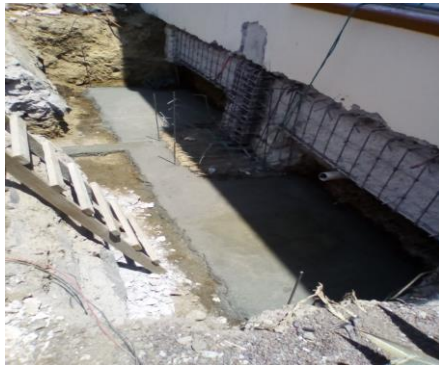
F10: Colado de plantilla de concreto
