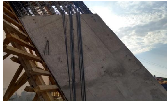
F8: Descimbrado de contrafuerte
