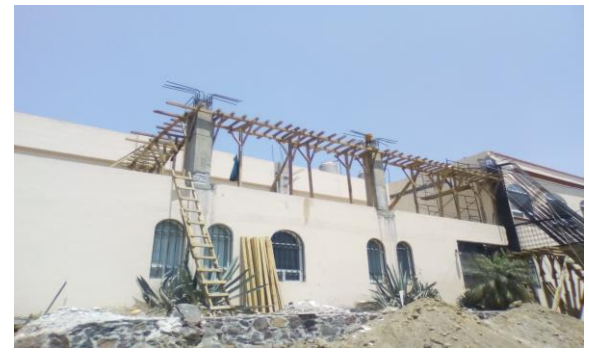
F18: Habilitado de cimbra puente para traves en ampliación del segundo nivel
