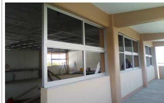
F11: Colocación de cancelería de aluminio
