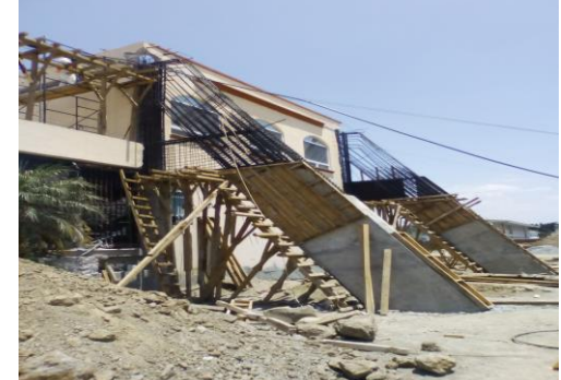
F9: Habilitado de cimbra para contrafuerte
