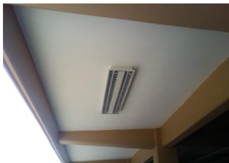
F9: Colocación de luminarias de 0.30 x 1.22 m en pasillos
