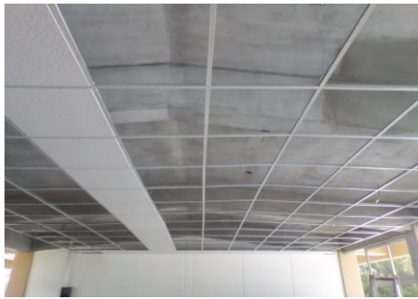
F6: Colocación de suspensión de falso plafón modular
