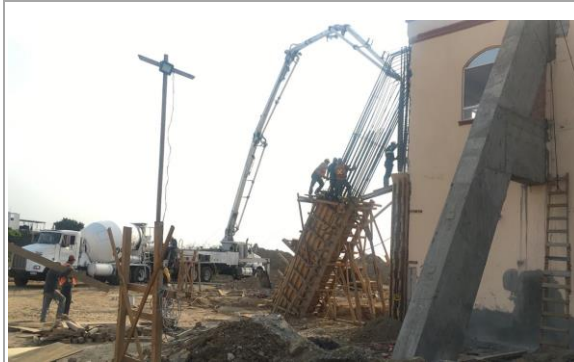
F5: Colado con concreto f'c=250 kg/cm 2 de contrafuertes
