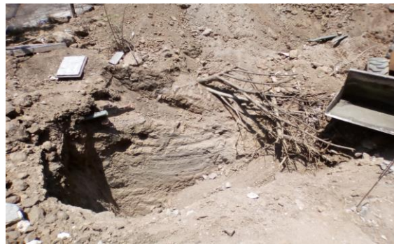
F14: Excavación de terreno para zapatas por medios mecánicos
