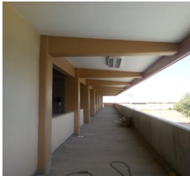
F3: Aplicación de pintura vinílica
