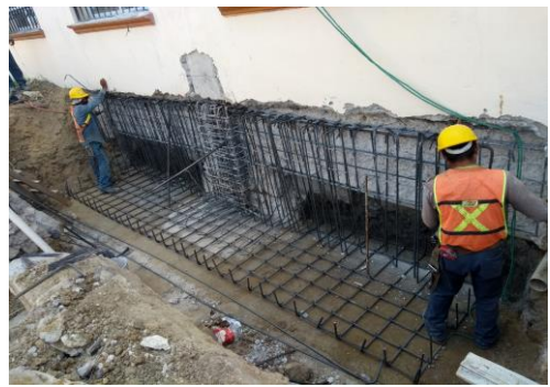
F13: Habilitado de acero de zapata corrida
