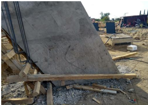
F7: Descimbrado de contrafuerte
