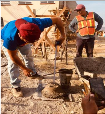
F4: Pruebas de revenimiento al concreto
