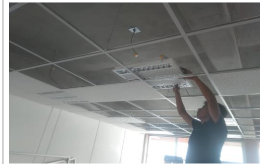
F8: Colocación de luminarias de 61 x 61 cm en interior de laboratorios
