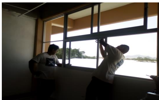
F10: Colocación de cancelería de aluminio
