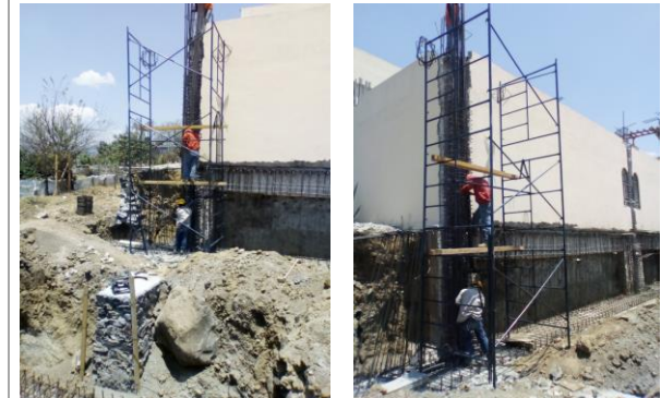
F12: Habilitado de acero de zapata corrida
