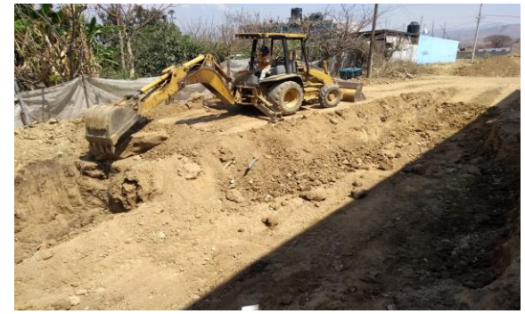
F15: Excavación de terreno para zapatas por medios mecánicos
