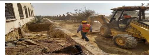
F5: Excavación de terreno para zapatas por medios mecánicos
