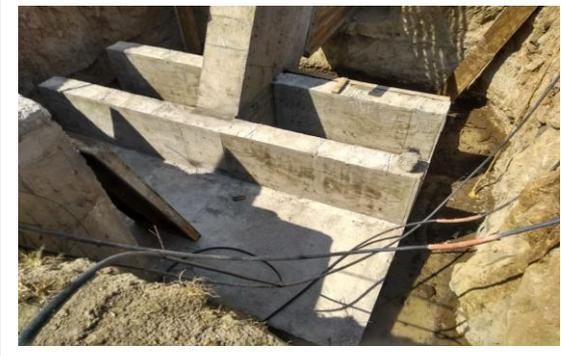
F20: Descimbrado de zapatas, contratraves y contrafuerte
