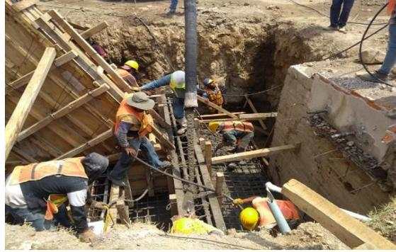
F16: Colado con concreto  $f'c=250$  kg/cm<sup>2</sup> de zapatas, contratraves y contrafuertes
