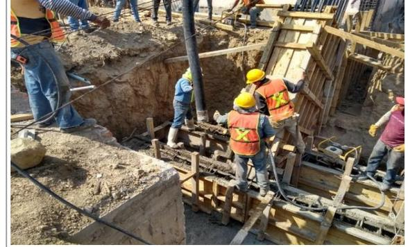
F17: Colado con concreto  $f'c=250$  kg/cm<sup>2</sup> de zapatas, contratraves y contrafuertes
