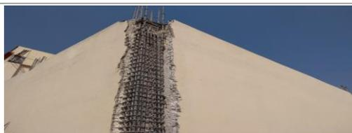
F7: Demolición de elementos estructurales para empotramiento de contrafuerte
