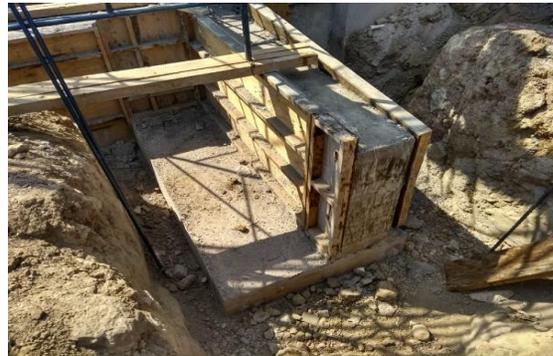
F19: Descimbrado de zapatas, contratraves y contrafuerte
