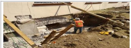
F6: Demolición de elementos estructurales para empotramiento de contrafuerte
