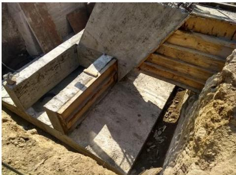
F18: Descimbrado de zapatas, contratraves y contrafuerte
