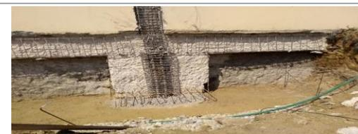
F8: Demolición de elementos estructurales para empotramiento de contrafuerte
