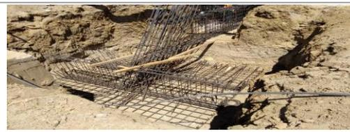
F10: Habilitado de acero de zapata aislada, contratraveses y contrafuertes
