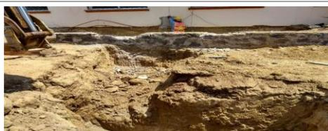
F4: Excavación de terreno para zapatas por medios mecánicos
