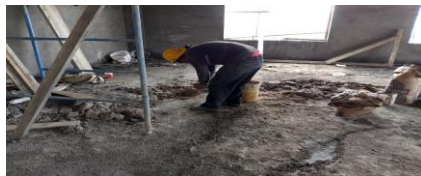
F3: Demolición de entortado existente
