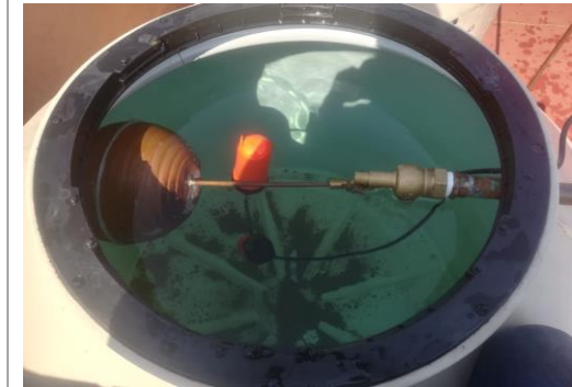
F25: Colocación de electroneveles para llenado de tinacos
