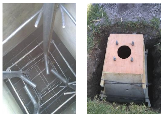
F7: Colocación de anclas para dados de concreto para colocación de postes de luminarias en estacionamiento
