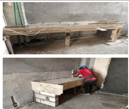
F12: Cimbrado de mesetas para lavabos en sanitarios
