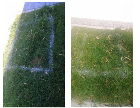
Trazo de excavación para colocación de postes de luminarias en F3:estacionamiento
