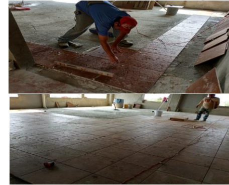
F17: Colocación de piso de loseta cerámica en aulas y sanitarios
