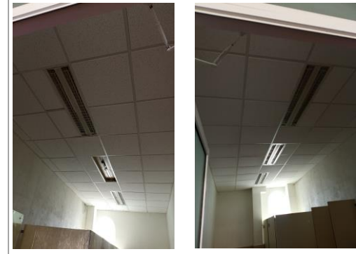
F46: Colocación de plafón modular de 0.61 x 0.61 m en sanitarios planta baja para cubrir tuberías de instalaciones hidrosanitarias de planta alta
