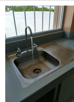
F13: Pruebas hidráulicas en mesas de lavado
