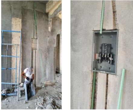
F15: Colocación de tablero eléctrico para alumbrado y contactos de ampliación
