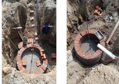
F23: Elaboración de pozos de visita para instalación sanitaria
