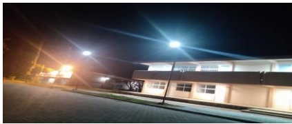
F35: Colocación de poste de luminarias en estacionamiento
