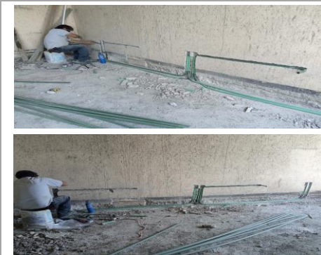
F14: Renurado de muros para colocación de tubería de instalaciones eléctricas y voz y datos
