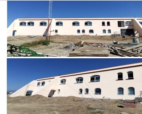
F48: Aplicación de pintura vinilica color venado como terminado en muros exteriores de ampliación
