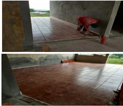
F18: Colocación de zoclo de loseta cerámica en muros
