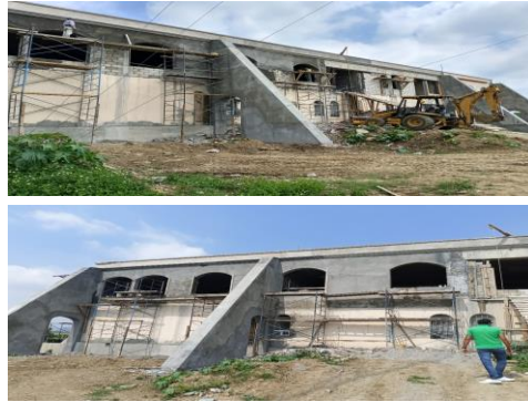
F16: Aplanado de muros exteriores con mortero cemento-arena
