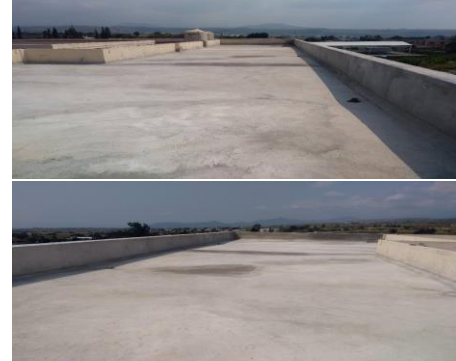
F20: Colado de entortado en losa de azotea para dar pendientes
