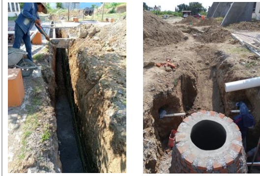
F25: Relleno de cepa con material producto de la excavación
