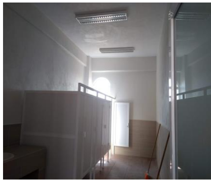
F38: Colocación de mamaparas de aluminio blanco en divisiones de módulos sanitarios
