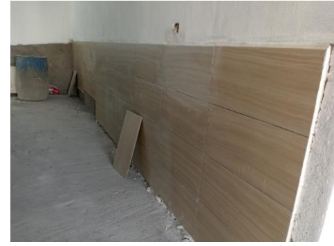
F37: Colocación de lábrin de azulejo en muros de sanitarios
