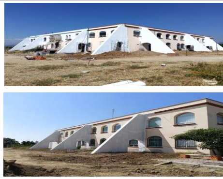
F47: Aplicación de pintura vinilica color blanco como fondo de contrafuertes
