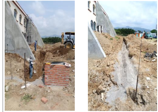
F26: Relleno de cepa con material producto de la excavación
