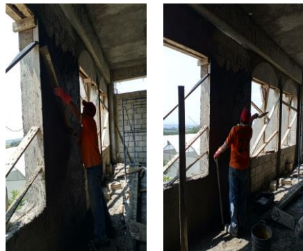
F6: Aplanado de muros de block con mortero cemento-arena
