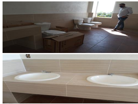
F42: Colocación de muebles sanitarios (wc y lavabos) en módulos de mujeres
