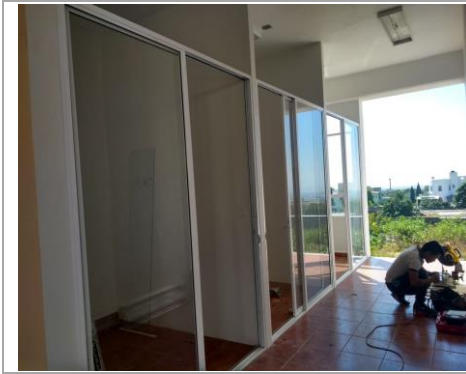
F35: Colocación de cancelería de aluminio blanco y cristal claro (corredizos) en cubículos
