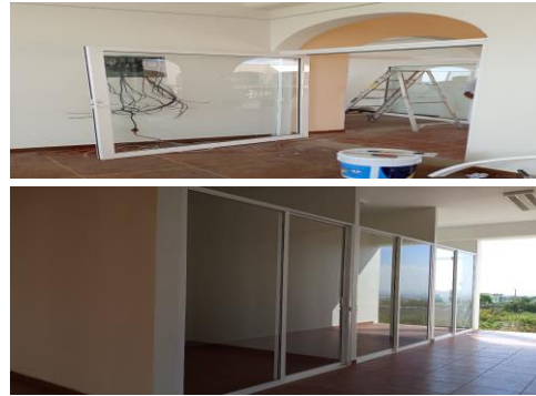
F39: Colocación de cancelería de aluminio blanco y cristal claro (puertas y corredizos) en cubículos
