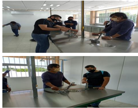
F15: Pruebas de instalación de gas
