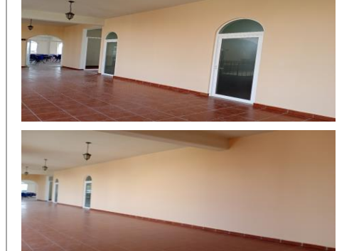
F29: Aplicación de pintura vinilica color venado en pasillo de ampliación de claustro
