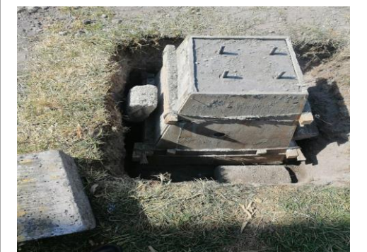
F30: Colado de dados con concreto hecho en obra para colocación de postes de luminarias en estacionamiento
