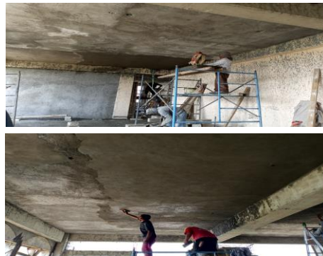
F7: Aplanado fino en losa con mortero cemento-arena
