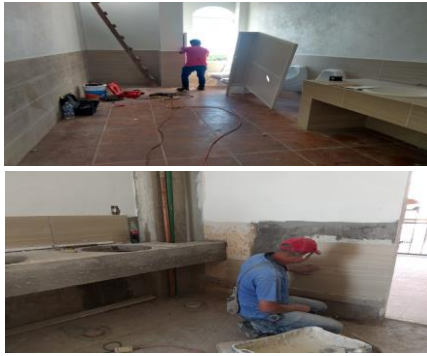
F36: Colocación de lábrin de azulejo en muros y mesetas de lavabos de sanitarios
