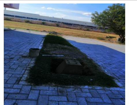
F9: Descimbrado de dados de concreto para colocación de postes de luminarias en estacionamiento
