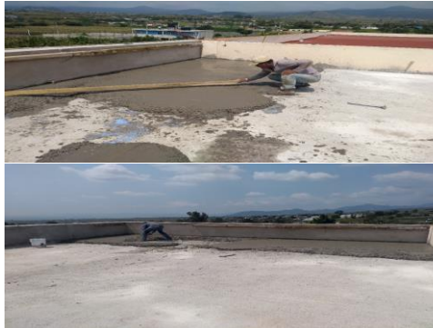
F19: Colado de entortado en losa de azotea para dar pendientes
