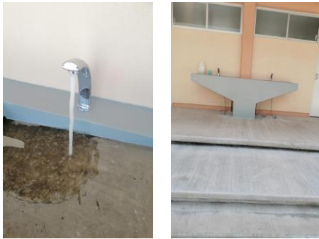
F14: Pruebas hidráulicas en módulo sanitizante
