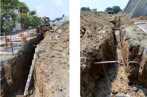
F22: Excavación de terreno por medios mecánicos para instalación sanitaria
