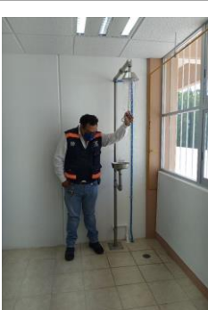
F12: Pruebas hidráulicas de regadera de emergencia
