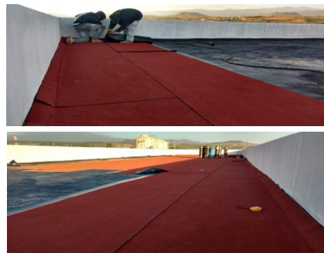
F50: Colocación de impermeabilizante de tapete color terracota en losa de azotea de ampliación
