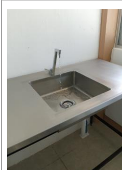
F13: Pruebas hidráulicas en mesas de lavado
