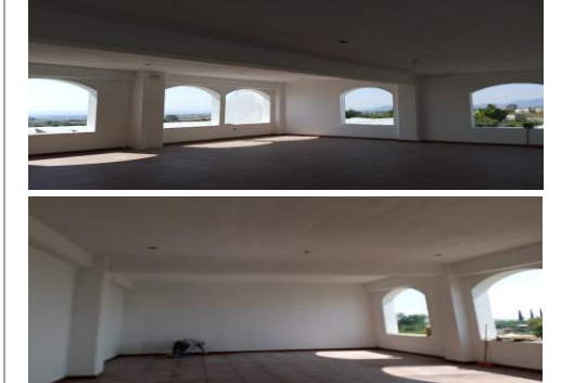
F28: Aplicación de pintura vinilica color blanco en interior de aulas, oficinas y sanitarios
