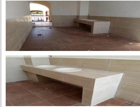
F40: Colocación de lábrin de azulejo en muros y mesetas de lavabos de sanitarios
