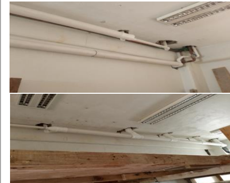
F11: Colocación de tubería de pvc sanitario para instalaciones de sanitarios
