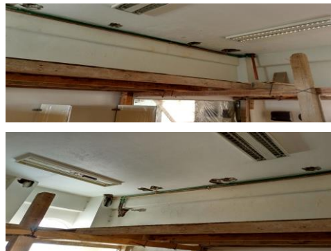
F10: Perforación de losa de entepiso para paso de instalaciones hidrosanitarias
