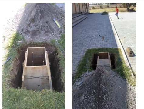
F6: Habilitado de cimbra para dados de concreto para colocación de postes de luminarias en estacionamiento
