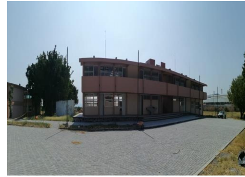
F34: Colocación de poste de luminarias en estacionamiento
