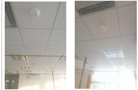
F28: Colocación de detectores de humo en plafón de laboratorios
