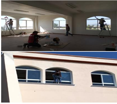
F33: Colocación de cancelería de aluminio blanco y cristal claro (ventanas)
