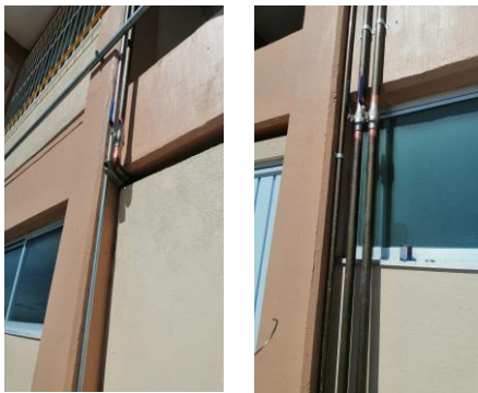
F26: Colocación de válvulas de paso en tubería hidráulica
