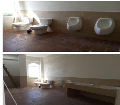
F41: Colocación de muebles sanitarios (wc, lavabos y mingitorios) en módulo de hombres
