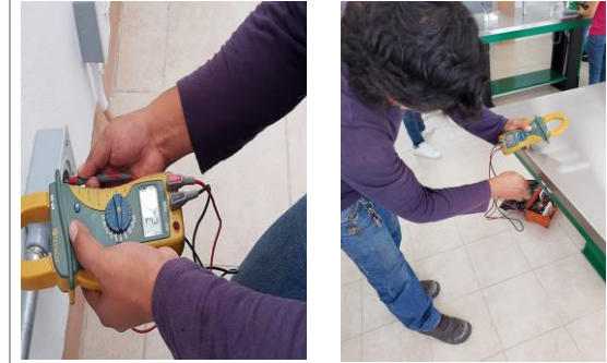
F16: Pruebas eléctricas en contactos (medición de voltaje)
