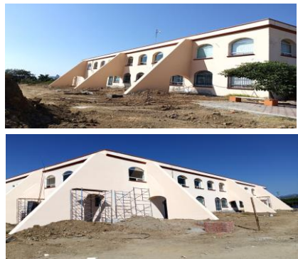
F49: Aplicación de pintura vinilica color venado como terminado de contrafuertes
