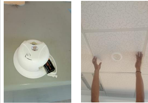
F27: Colocación de detectores de humo en plafón de laboratorios
