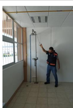
F12: Pruebas hidráulicas de regadera de emergencia
