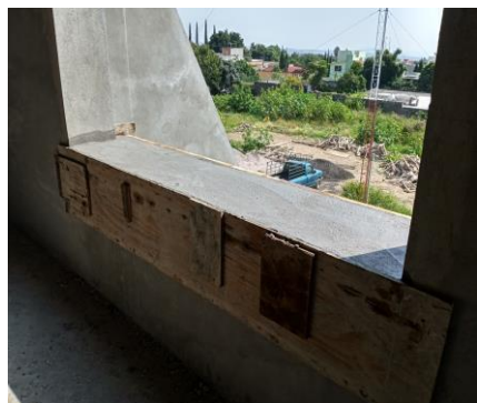
F9: Colado de repisón de ventana con concreto hecho en obra
