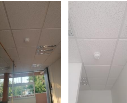
F29: Colocación de detectores de humo en plafón de laboratorios
