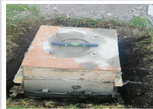
F8: Colado de dados con concreto hecho en obra para colocación de postes de luminarias en estacionamiento
