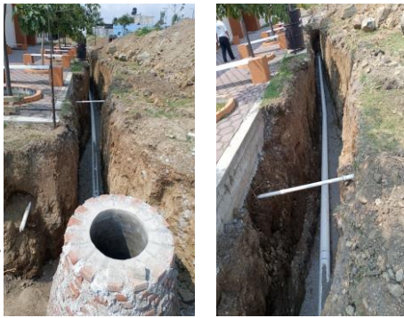
F24: Tendido de tubería de pvc para instalaciones sanitarias
