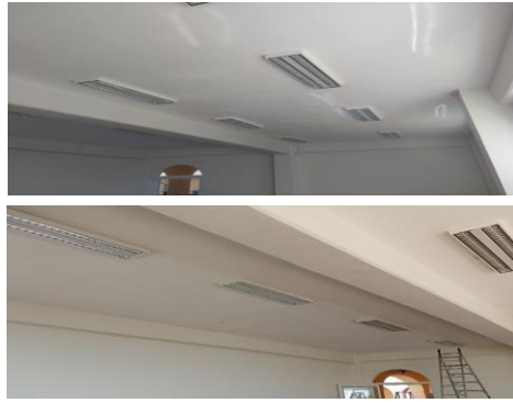
F45: Colocación de luminarias de 0.30 x 1.20 m sobre losa de viga y bovedilla
