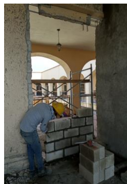
F4: Muro interior de block de concreto 12x20x40 cm
