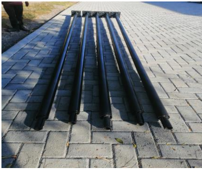
F32: Aplicación de pintura esmalte sobre postes de luminarias
