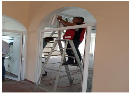
F34: Colocación de cancelería de aluminio blanco y cristal claro (puertas)
