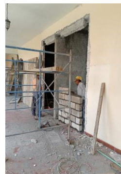
F4: Muro interior de block de concreto 12x20x40 cm
