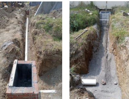
F21: Colocación de tubería de pvc para salida de instalaciones pluviales
