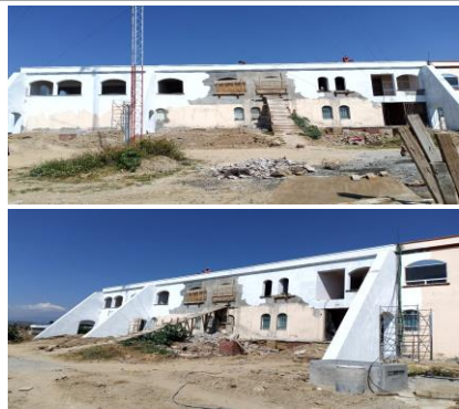
F47: Aplicación de pintura vinilica color blanco como fondo de muros exteriores de ampliación
