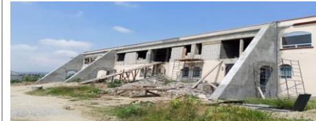
F5: Muros exteriores de block de concreto 12x20x40 cm
