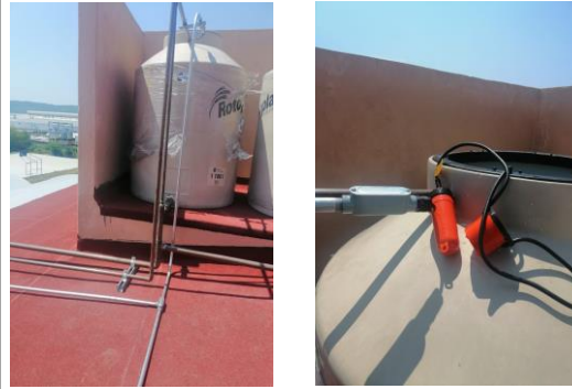
F24: Colocación de electroneveles para llenado de tinacos
