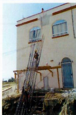
F22: Habilitado de acero para contrafuerte.
