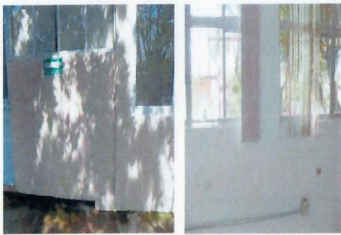
F12: Colocación de extintores afuera de Módulo de servicios escolares y Centro de Computo.
