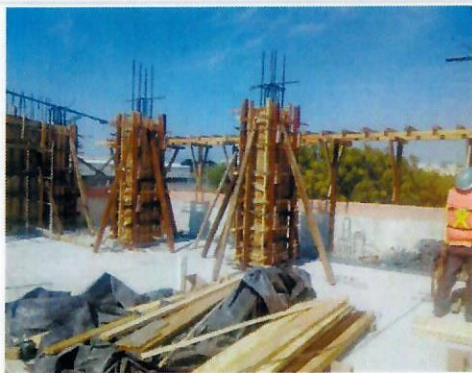
F22: Habilitado de cimbra para muros y columnas.
