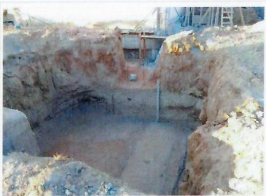
F36: Colado de plantilla para zapata y trabe de liga de siguiente contrafuerte.
