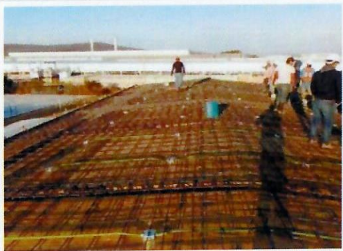
F28: Habilitado de acero para losa de azotea.
