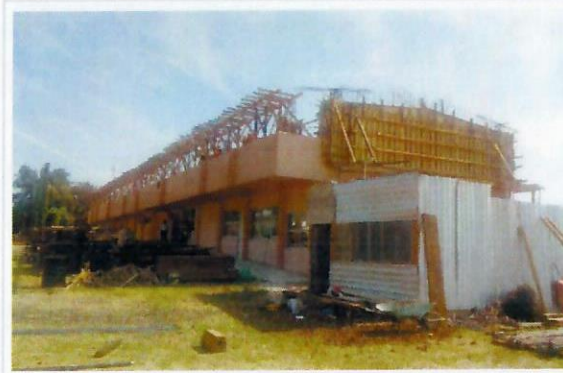
F23: Habilitado de cimbra para muros y columnas.
