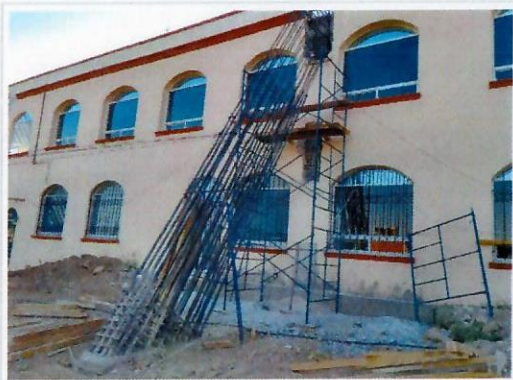
F30: Habilitado de acero de zapata aislada, contrarabes y contrafuerte.
