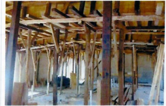
F27: Habilitado de cimbra para losa de azotea.
