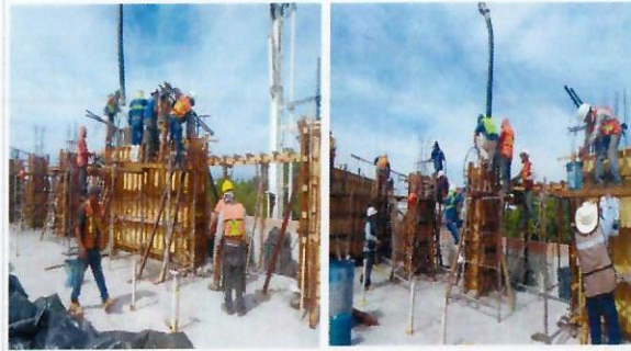
F26: Colado con concreto f'c=250 kg/cm 2 en muros y columnas.
