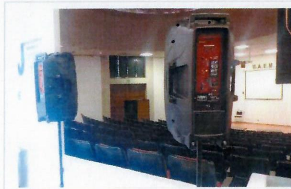
F30: Baffles instalados
