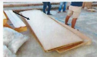
F29: Instalación de Pizarrones
