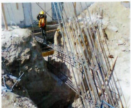
F21: Habilitado de acero para trabe de liga y contrafuerte.
