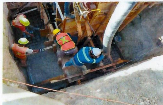
F34: Colado con concreto f'c=250 kg/cm 2 de zapata, contrarabe y trabe de liga.
