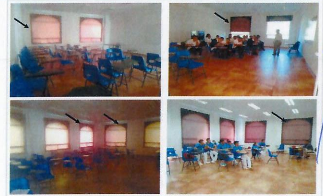
F27: Persianas enrollables Instaladas en Salones
