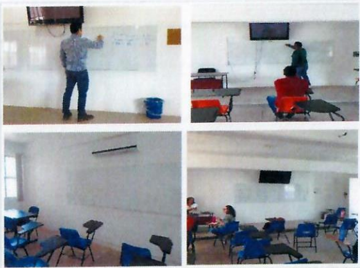
F40: Pizarrones instalados en Aulas 1, 2, 3, 4, 5, 6, 7, 8, y 9.
