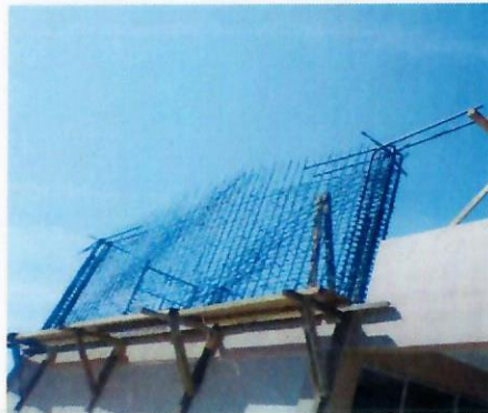
F19: Habilitado de acero para muros y columnas.
