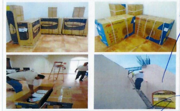
F21: Llegada e instalación de Aires acondicionado.
