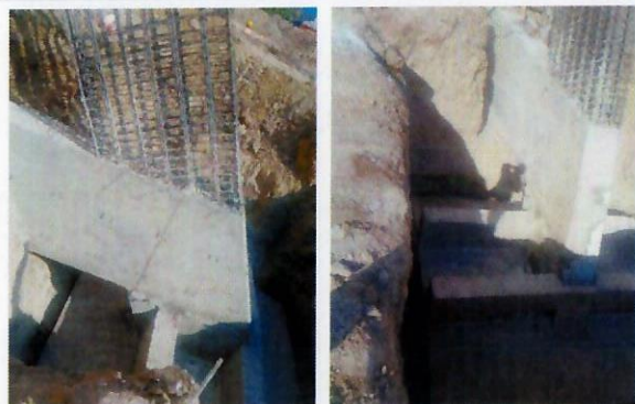
F25: Descimbrado de zapata, contrarabe y trabe de liga.
