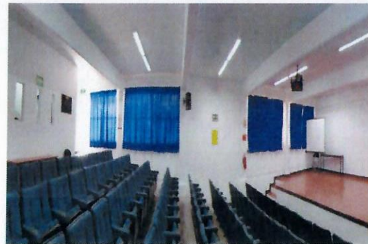
F16: Se colocaran 3 aires acondicionados en el Auditorio.
