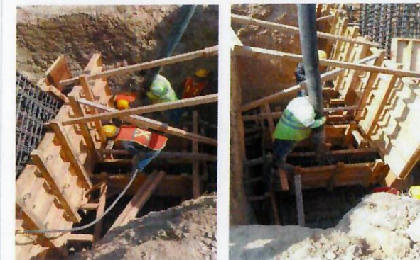
F26: Colado con concreto f'c=250 kg/cm2 de zapata, contrarabe y trabe de liga.
