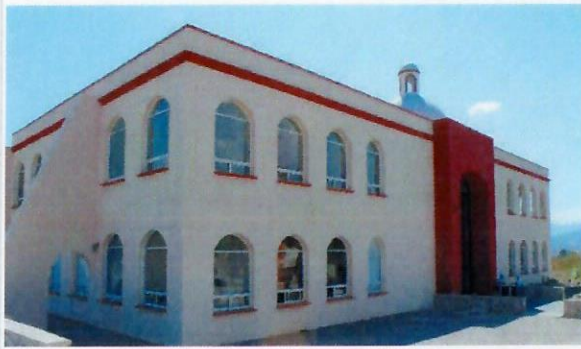
F1: Fachada principal
