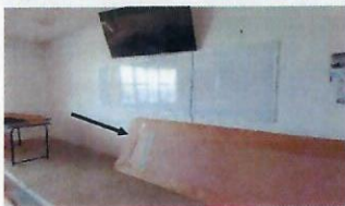
F28: Instalación de Pizarrones
