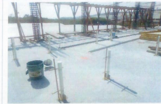
F17: Pasos en losa y colocación de tubería de pvc y cobre
