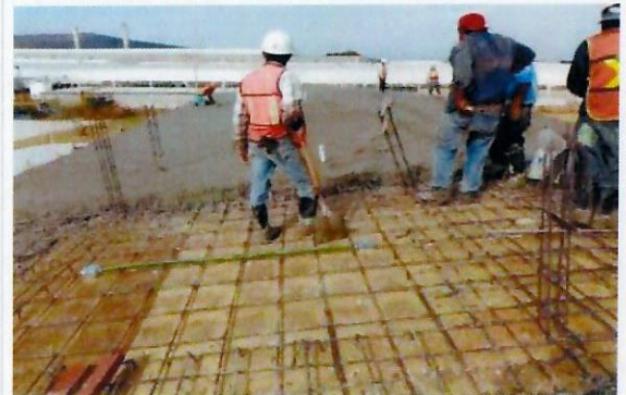
F29: Colado con concreto f'c=250 kg/cm 2 en losa de azotea.
