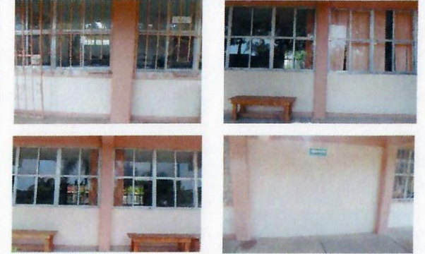
F11: Colocación de extintores afuera de pasillo edificio 1, pasillo de edificio 3 y pasillo de edificio 2
