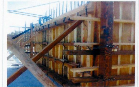
F21: Habilitado de cimbra para muros y columnas.
