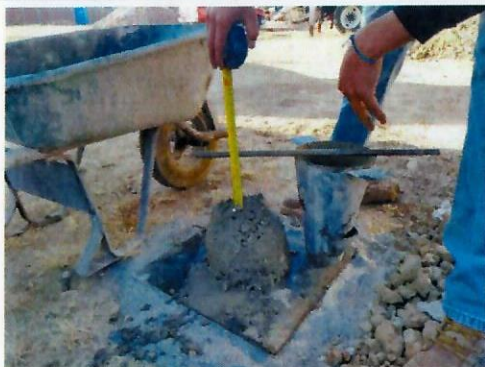
F33: Pruebas de revenimiento al concreto.
