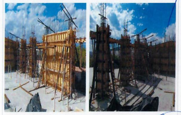
F24: Habilitado de cimbra para muros y columnas.
