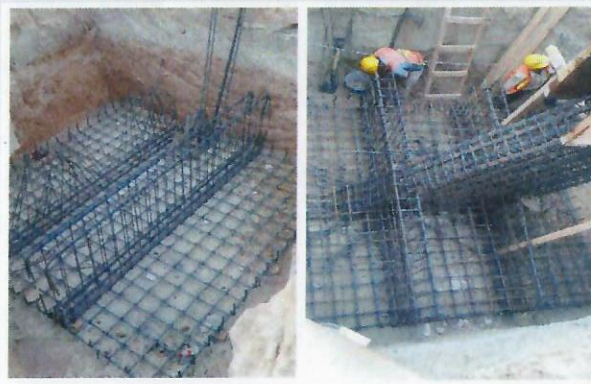
F29: Habilitado de acero de zapata y contrarabes.
