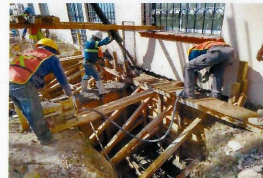
F35: Colado con concreto f'c=250 kg/cm 2 de zapata, contrarabe y trabe de liga.
