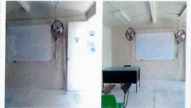
F14: Se colocará 1 extintor en el salón 12 y en el salón 13
