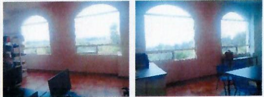
F9: Colocación de Persianas en Auditorio, laboratorio y Biblioteca.
