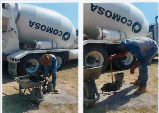
F24: Pruebas de revenimiento al concreto.
