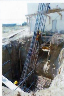
F22: Habilitado de acero para contrafuerte.
