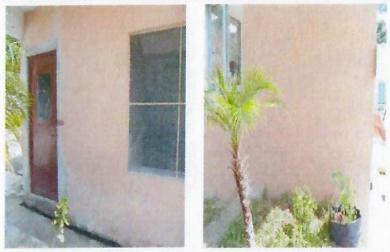
F10: Colocación de extintores afuera de Bodega 1 y en caseta de vigilancia
