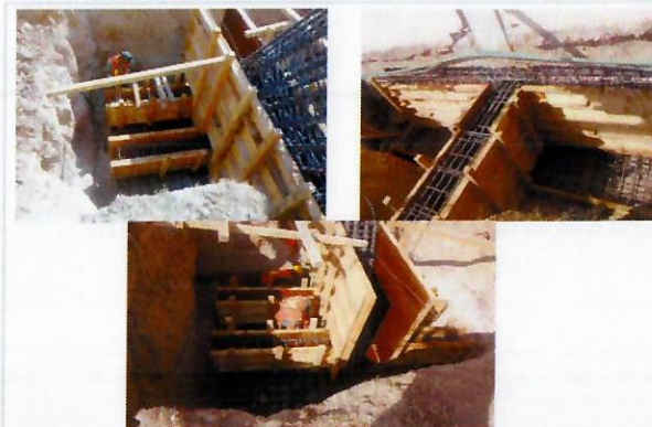
F23: Habilitado de cimbra de zapata aislada y contrarabes.
