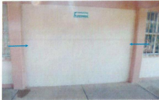
F7: Se colocaran Lockers en Pasillo edificio 3
