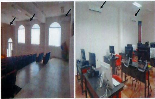
F28: Se instalaron Aire acondicionado en Auditorio y Centro de Cómputo.
