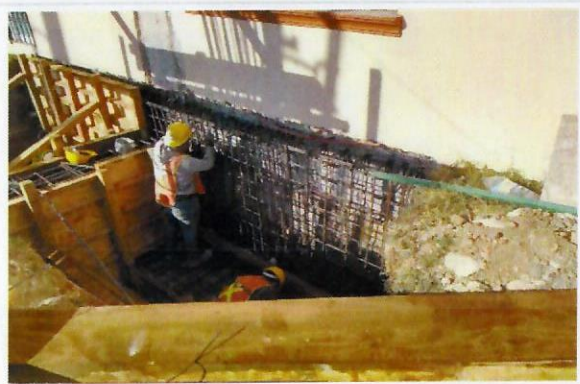
F28: Habilitado de acero de contrarabe nueva con contrarabe existente.
