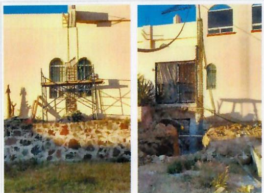
F27: Demolición de elementos estructurales para empotramiento de contrafuerte.
