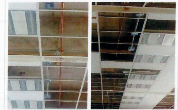
F18: Colocación de tubería de cobre
