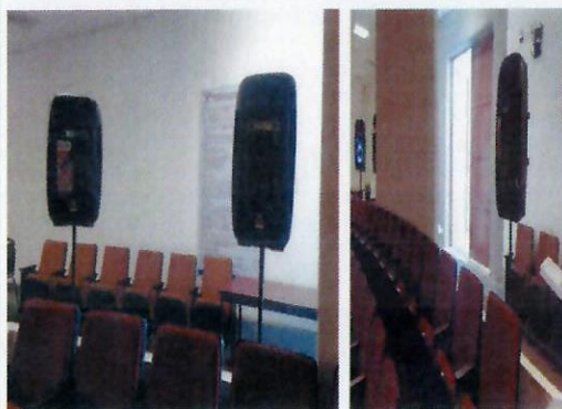
F29: Baffles instalados
