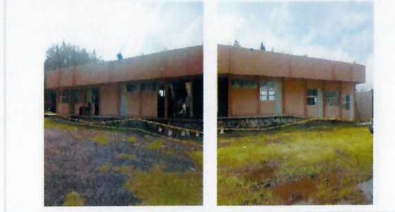
F6: Estado actual del inmueble.
