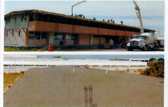
F30: Colado con concreto f'c=250 kg/cm 2 en losa de azotea
