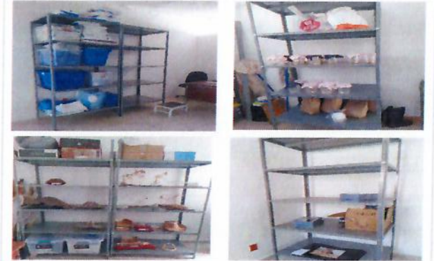
F6: Instalación de estantes y anaqueles en Laboratorios.
