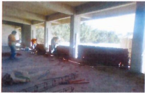
F10: Elaboración de muros de tabique rojo
