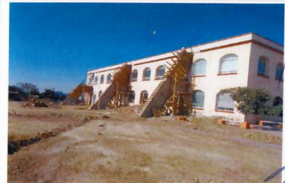
F12: Habilitado de cimbra para contrafuertes.
