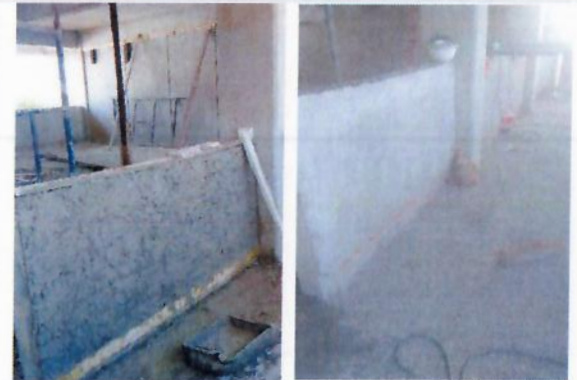
F17: Aplanado de muros con mortero primera mano
