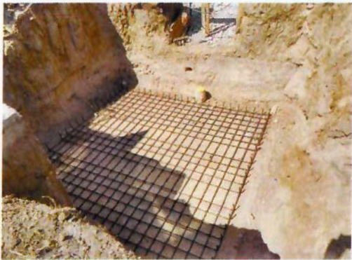
F7: Habilitado de acero de zapata aislada.
