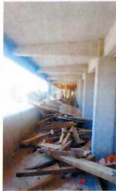
F7: Descimbrado de traves y losa de azotea
