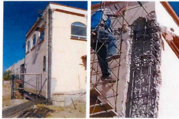
F5: Demolición de elementos estructurales para empotramiento de contrafuerte.
