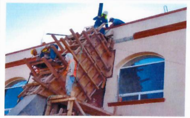
F15: Colado con concreto f'c=250 kg/cm 2 de contrafuertes.
