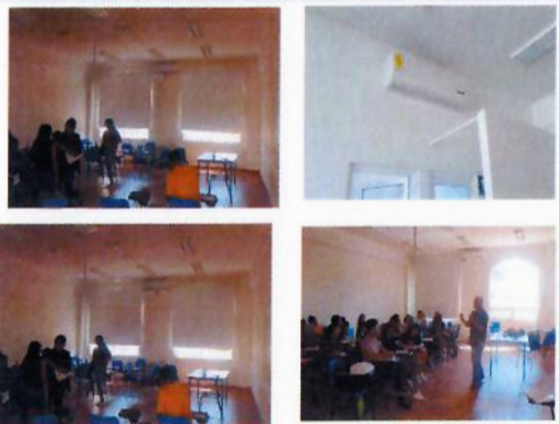
F3: Instalacion de Aires acondicionados.
