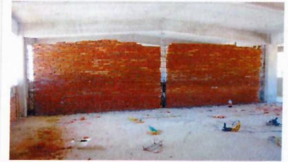
F12: Elaboración de muros de tabique rojo
