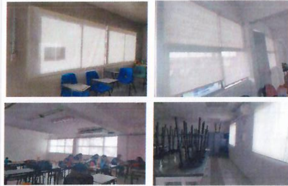
F5: Se instalaron persianas en los edificios 6, 12 y 13.
