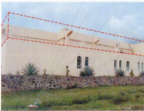
F3: Fachada posterior
