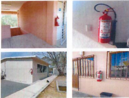
F7: Instalación de extintores, en edificios 13, 6 y 12, centro de computo, lab de biología.
