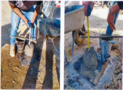
F13: Pruebas de revanamiento al concreto.
