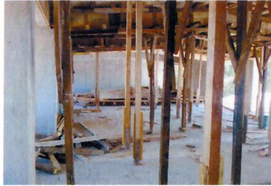
F8: Descimbrado de traves y losa de azotea
