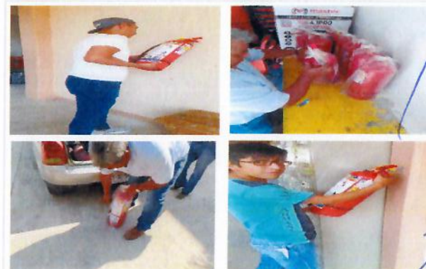
F5: Instalación de Extintores en pasillos de edificio 1, 2, 3, bodega.
