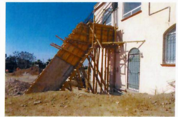
F11: Habilitado de cimbra para contrafuertes.
