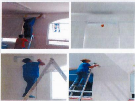
F2: Instalacion de Aires acondicionados.
