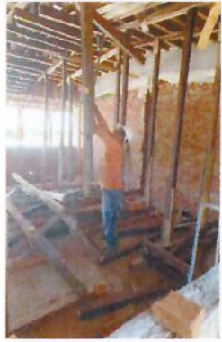
F7: Descimbrado de traves y losa de azotea
