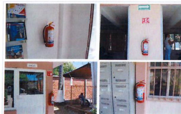
F8: Instalación de Extintores en pasillos de edificio 1, 2, 3, bodega.
