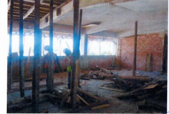
F9: Descimbrado de traves y losa de azotea
