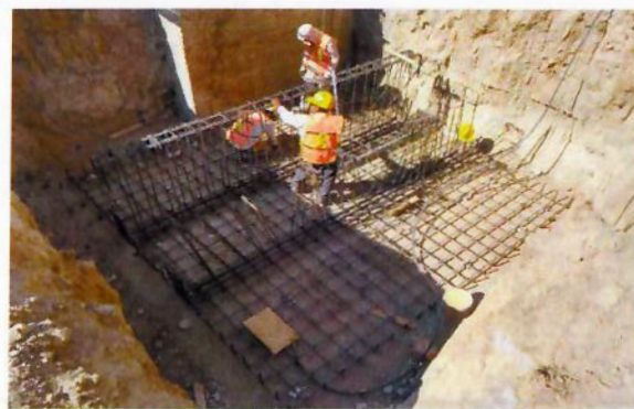
F8: Habilitado de acero de zapata aislada y contrarabes.
