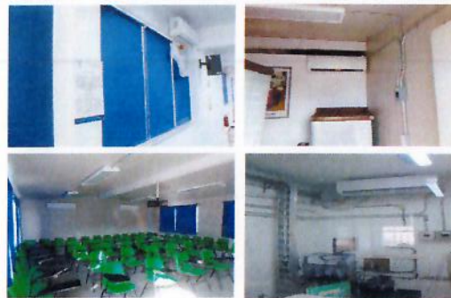
F11: Se colocaron aires acondicionados Auditorio, Salones 12, 13, 14 y 15 y Centro de Cómputo.
