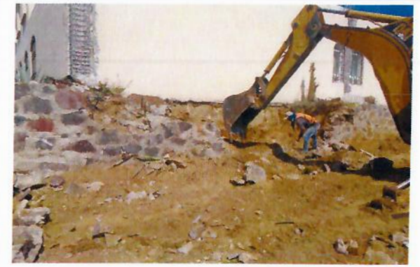
F6: Excavación de terreno para zapatas por medios mecánicos.
