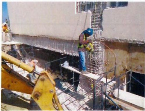
F4: Demolición de elementos estructurales para empotramiento de contrafuerte.
