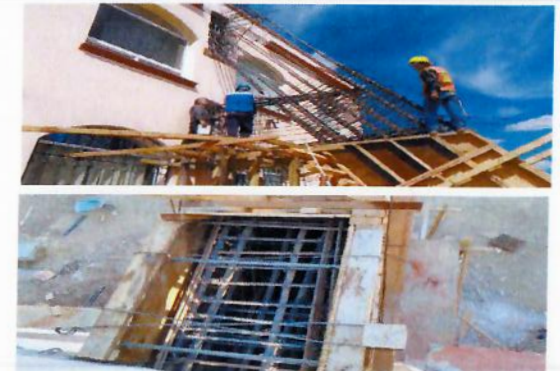
F9: Habilitado de acero para contrafuerte.
