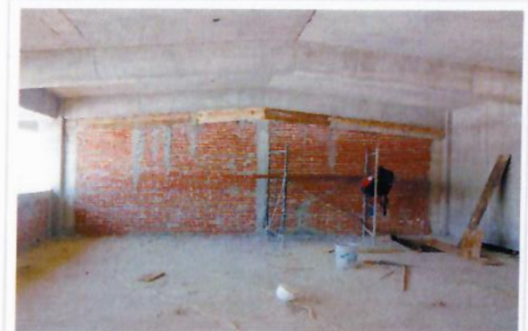
F15: Castillos y cadenas de concreto de 14 x 20 cm
