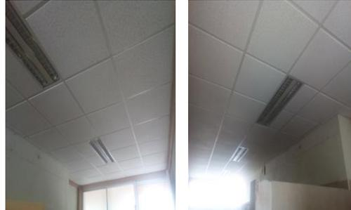
F4: Colocación de plafón modular en sanitarios planta baja
