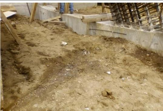
F11: Relleno y compactación de material producto de la excavación
