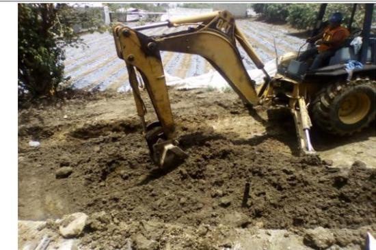
F12: Excavación de terreno para zapatas por medios mecánicos
