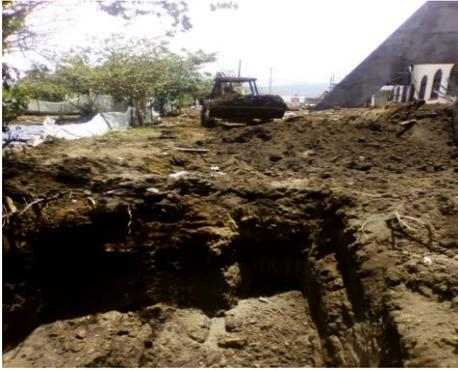
F13: Excavación de terreno para zapatas por medios mecánicos
