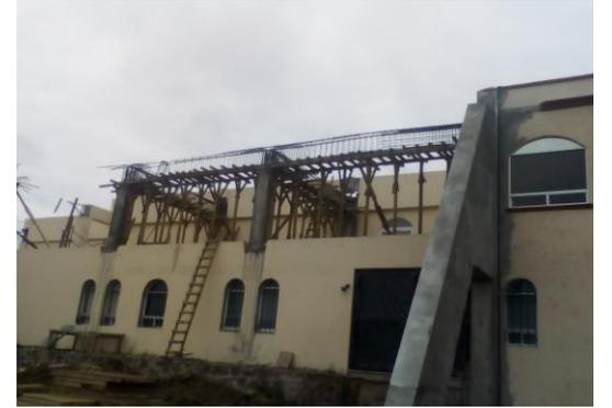
F18: Habilitado de cimbra puente y acero para traves en ampliación del segundo nivel2
