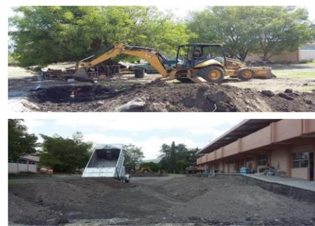
F22: Excavación de terreno y suministro de material mejorado en área de estacionamiento
