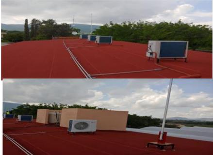
F10: Instalación de condensadoras de equipos de aire acondicionado
