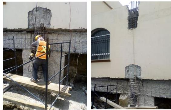
F14: Demolición de estructura de concreto existente para anclaje de contrafuertes
