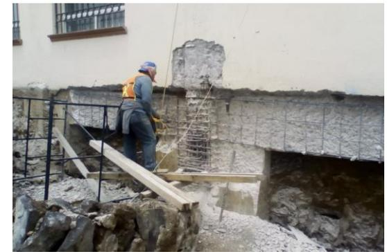
F15: Demolición de estructura de concreto existente para anclaje de contrafuertes
