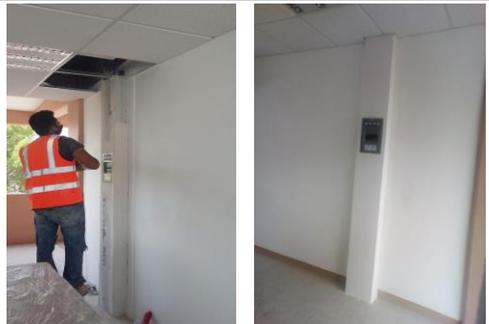
F13: Colocación de cajillos de durock para cubrir tableros eléctricos
