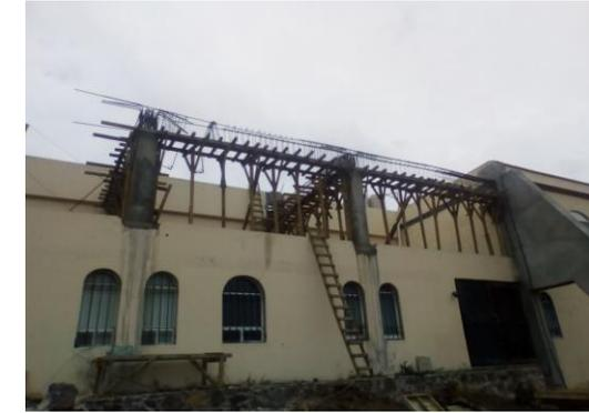
F17: Habilitado de cimbra puente y acero para traves en ampliación del segundo nivel
