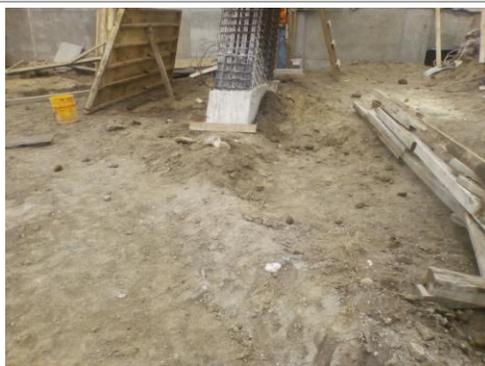
F10: Relleno y compactación de material producto de la excavación
