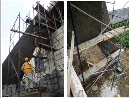
F15: Aplanado fino en contrafuertes
