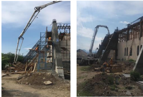
F10: Colado de cimentación con concreto prefabricado de f'c = 250 \text{ kg/cm}^2 de último contrafuerte
