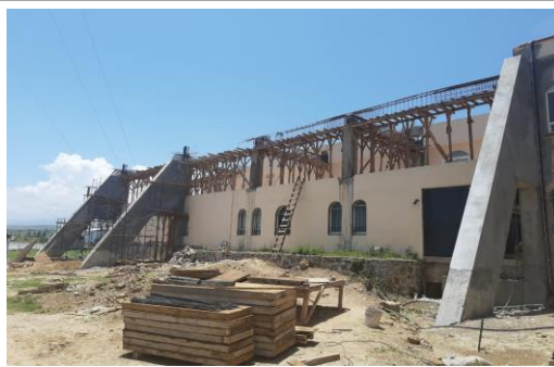
F14: Habilitado de cimbra para traves en ampliación de planta alta
