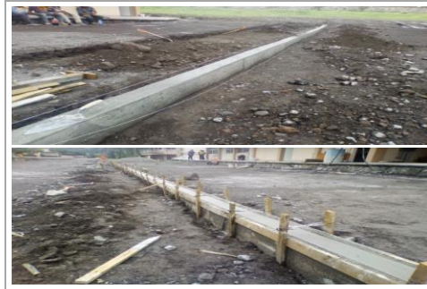
F7: Colado de guarnición de concreto en área de estacionamiento
