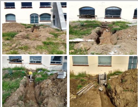
F30: Excavación de terreno por medios manuales y elaboración de salidas pluviales
