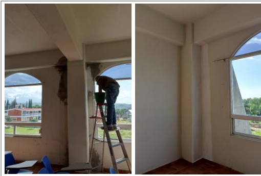
F28: Aplicación de pintura vinilica en muros interiores
