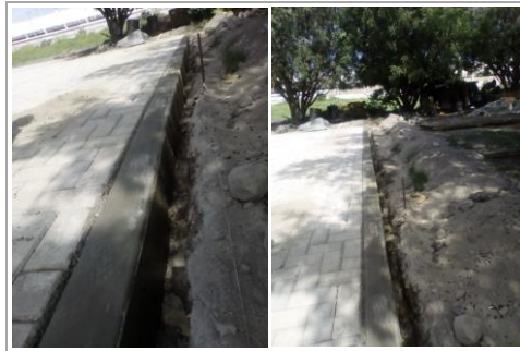
F13: Colado de guarnición de concreto en área de estacionamiento
