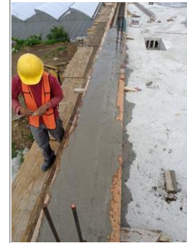
F41: Colado de cadena y pecho paloma con concreto hecho en obra de pretil de azotea
