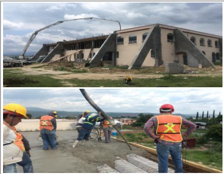
F27: Colado de capa de compresión con concreto f'c=250 kg/cm 2 en losa de azotea
