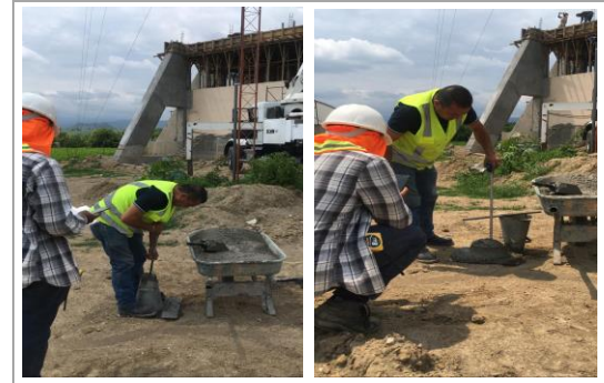
F26: Prueba de revenimiento al concreto
