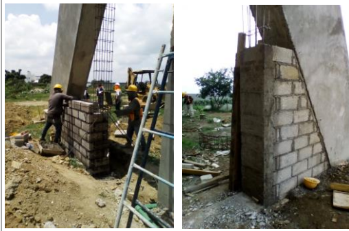
F16: Elaboración de muro de block para base de arco en contrafuerte
