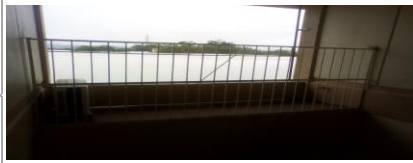
F3: Colocación de protecciones de herrería en escaleras
