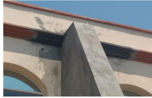
F8: Elaboración de pecho paloma en remate de contrafuerte
