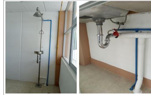
F23: Aplicación de pintura esmalte en tubería de cobre de salidas hidráulicas
