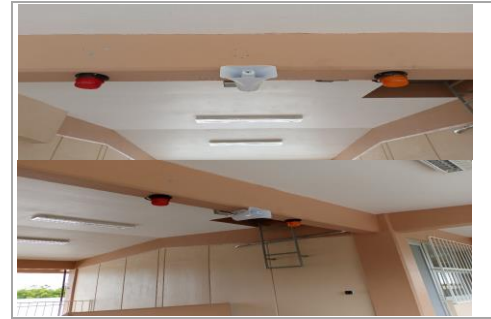
F41: Colocación de sirena y luz estroboscópica en pasillo de planta alta
