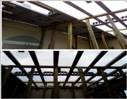
F24: Habilitado de cimbra para soporte de viguetas y bovedillas
