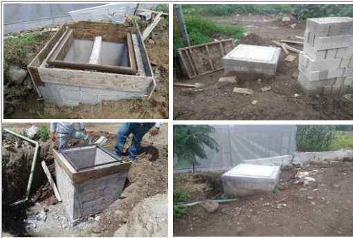
F31: Elaboración de registros para instalación de voz y datos
