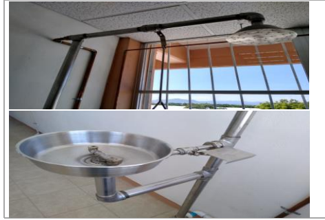
F37: Colocación de regadera de emergencia con lavaojos
