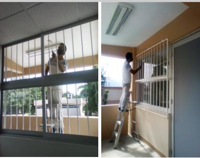
F12: Aplicación de pintura esmalte en protecciones de herrería
