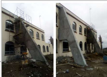
F3: Aplanado fino en contrafuertes
