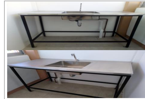
F26: Colocación de mesas de lavado
