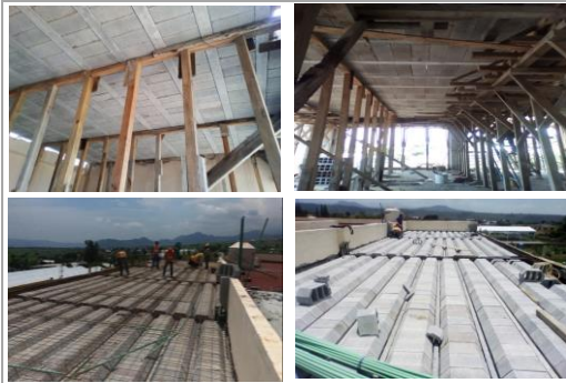
F25: Colocación de viguetas y bovedillas para losa de azotea
