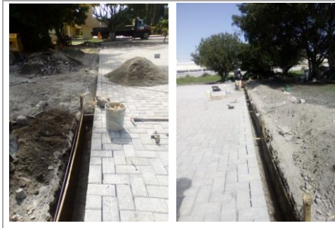
F16: Habilitado de cimbra para guarnición en área de estacionamiento
