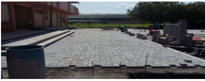
F9: Colocación de adoquero en área de estacionamiento
