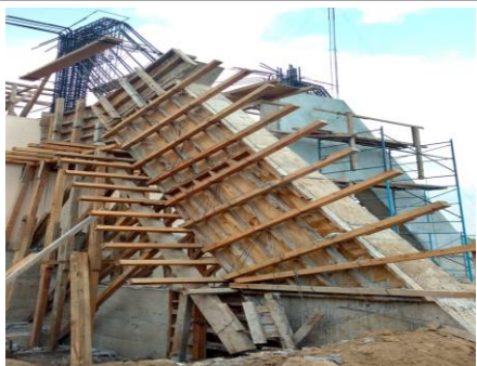
F12: Habilitado de cimbra en segunda parte de último contrafuerte
