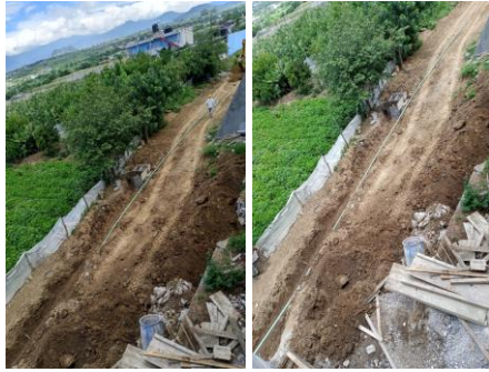
F33: Tendido de tubería de pvc pesado para cableado de voz y datos
