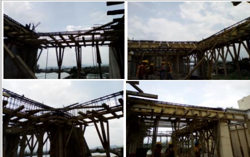
F22: Habilitado de acero para traves de azotea
