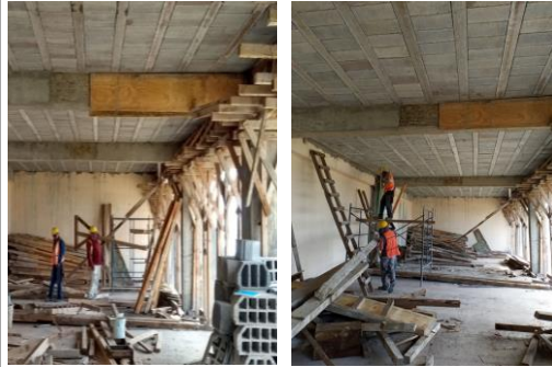
F34: Descimbrado de losa y traves de planta alta
