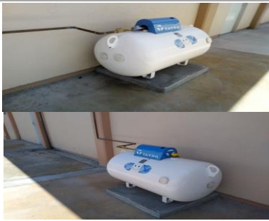
F33: Colocación de tanque estacionario de 300 litros
