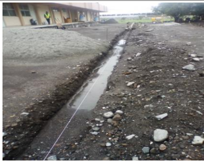
F6: Excavación por medios manuales para colado de guarnición
