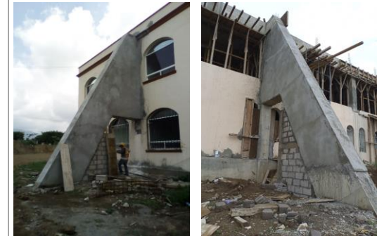
F17: Elaboración de muro de block para base de arco en contrafuerte
