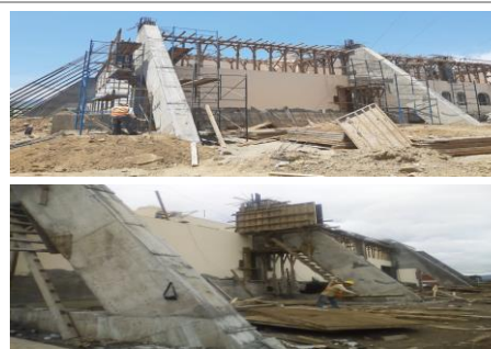
F4: Descimbrado de elementos estructurales de concreto
