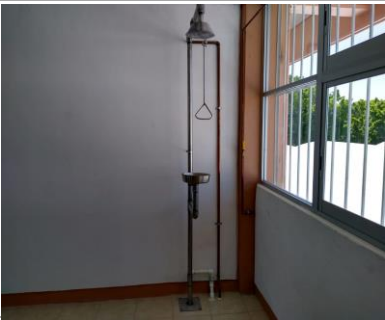
F36: Colocación de regadera de emergencia con lavaojos
