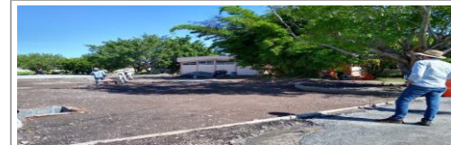
F8: Colocación de adoquero en área de estacionamiento
