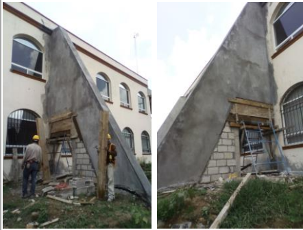
F18: Forjado de arco de concreto en contrafuerte
