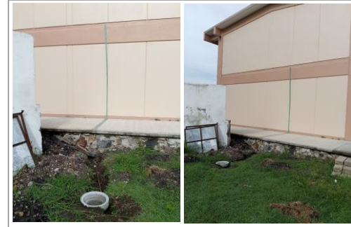
F20: Colocación de tubería de pvc pesado para bajada de pararrayos
