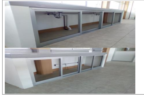
F31: Colocación de marcos de aluminio para puertas en barras de concreto
