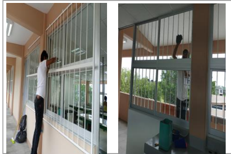
F43: Limpieza fina, en ventanas y herrería.
