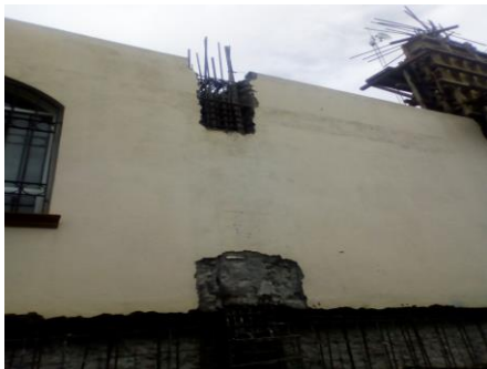
F9: Demolición de estructura de concreto para anclaje de contrafuerte
