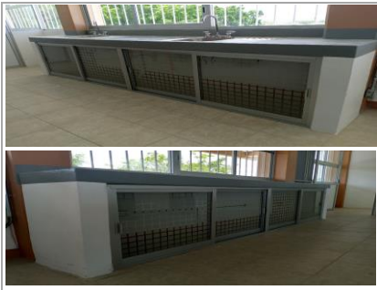
F24: Colocación de cristal templado en puertas de barras de concreto
