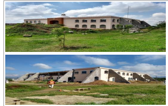
F29: Aplanado fino terminado en todos los contrafuertes
