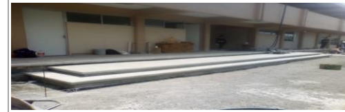
F5: Forjado de escalones de concreto para acceso a edificio
