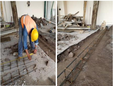
F36: Habilitado de acero para cadenas y castillos de los muros divisorios
