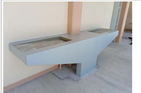
F22: Aplicación de pintura epóxica en módulo sanitizante
