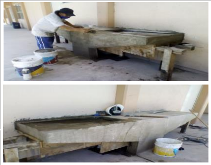
F18: Elaboración de meseta de concreto para módulo sanitizante
