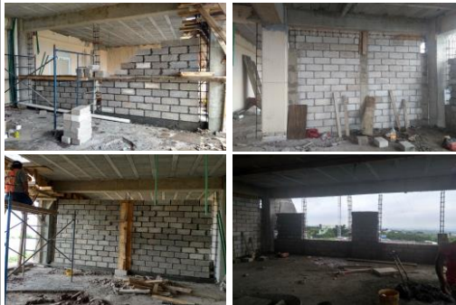
F37: Elaboración de muros divisorios de block en la planta alta
