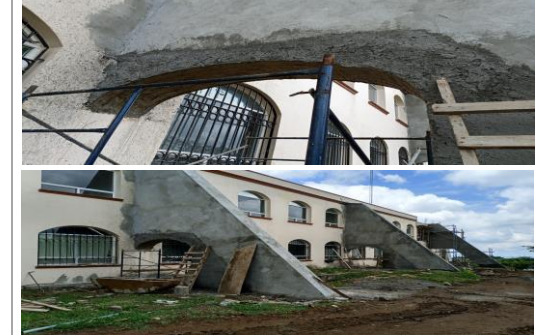
F20: Aplanado fino en muro de block y arco de concreto en contrafuerte
