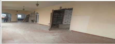
F39: Demolición de muro existente para abertura de puertas
