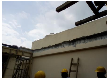
F21: Demolió de estructura de concreto existente para anclaje de losa de vigueta y bovedilla
