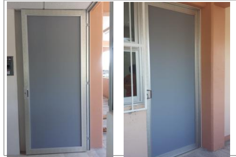
F28: Colocación de puertas de acceso a laboratorios
