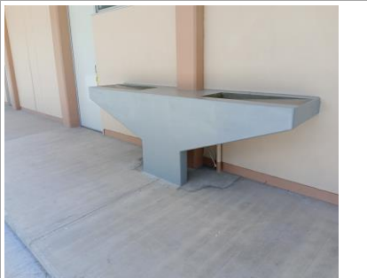
F21: Aplicación de pintura epóxica en módulo sanitizante
