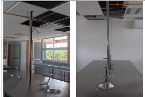
F34: Colocación de unicanal para soporte de tubería de gas
