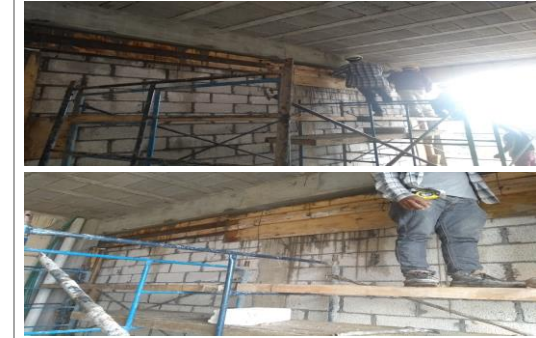
F38: Colado de cadenas de cerramiento con concreto hecho en obra
