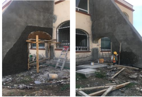
F7: Aplanado fino en muro de block y arco de concreto en contrafuerte.
