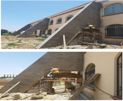
F6: Forjado de arco de concreto en contrafuerte
