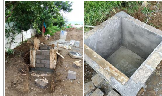
F23: Elaboración de registros para conexión de voz y datos+AA226
