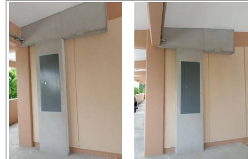
F35: Colocación de cajillo de durock en tablero principal de planta alta
