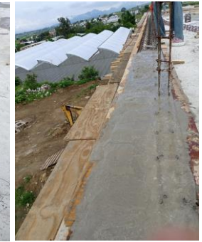
F41: Colado de cadena y pecho paloma con concreto hecho en obra de pretil de azotea
