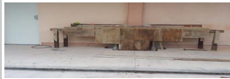
F4: Elaboración de meseta de concreto para módulo sanitizante
