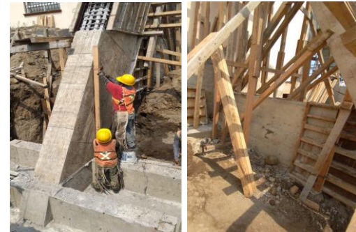
F11: Descimbrado de cimentación de último contrafuerte
