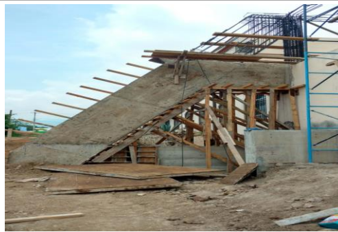
F13: Descimbrado en segunda parte de último contrafuerte
