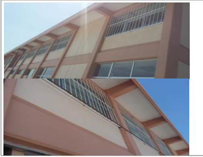
F27: Colocación de protecciones de herrería
