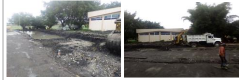
F10: Excavación y acarreo por medios mecánicos de material inerte
