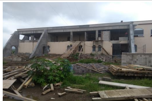
F43: Pretil perimetral en losa de azotea
