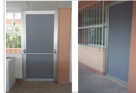
F29: Colocación de puertas de emergencia en laboratorios
