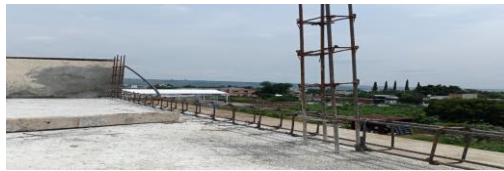
F40: Habilitado de acero para cadenas y castillos de pretil de azotea
