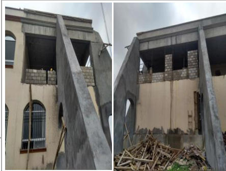
F42: Colado de cadena y pecho paloma con concreto hecho en obra de pretil de azotea
