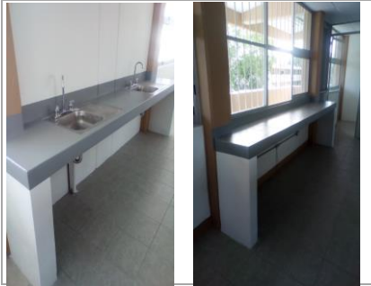
F30: Aplicación de pintura epóxica sobre barras de concreto
