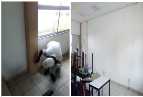
F19: Aplicación de pintura vinílica en interior de planta baja
