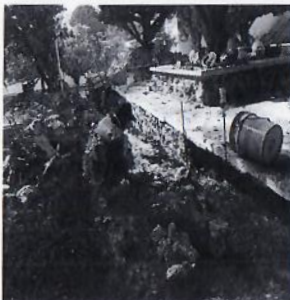
F13: Construcción de muros de mampostería.
