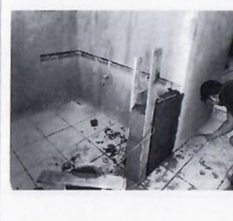
F9: Ranurado de muro de tabique y colado de barra de concreto para lavabos para sanitario de hombres
