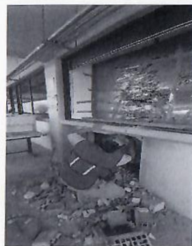
F6: Demolición de muro de tabique y repisón.
