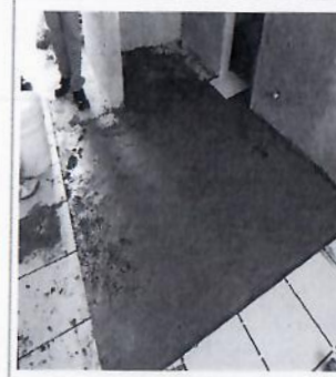
F7: Colado de entortado con concreto hecho en obra para nivelación de superficie en sanitario de hombres
