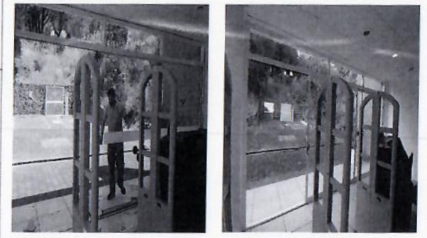
F8: Sustitución de cancel en acceso norte.
