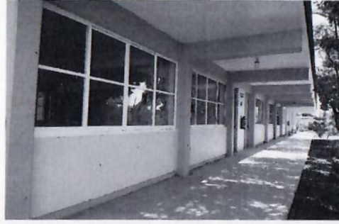
F15: Suministro y colocación de cancelería de aluminio de 2" en edificio 2
