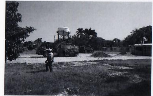
F37: Retiro de material producto de la demolición o excavación fuera de la obra.
