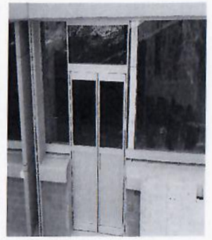
16.- Adecuación de cancelería y colocación de puerta de emergencia.
