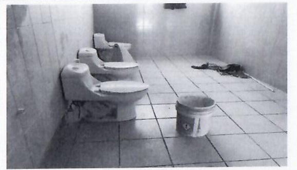
F17: Colocación de muebles sanitarios (w.c.) existentes .
