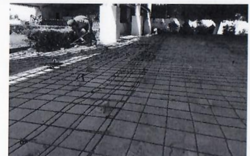
F13: Tendido de malla electrosoldada 6-6/4-4 en explanada.
