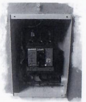
F11: Instalación de interruptor termomagnético en caja moldeada.
