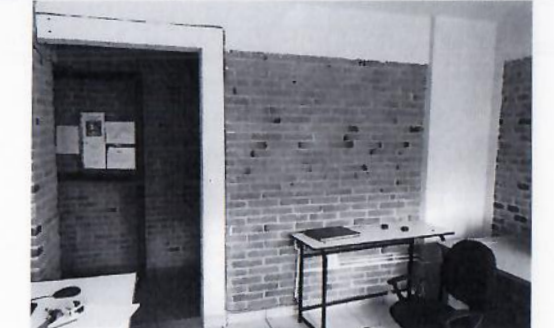
F4: Muro que se demolerá para ampliar biblioteca.
