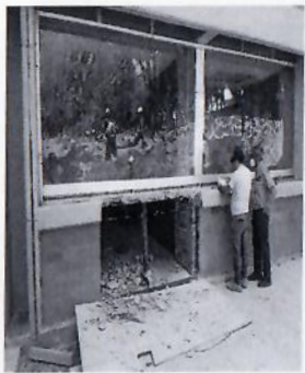
14.- Demolición de repisón y muro de tabique.
