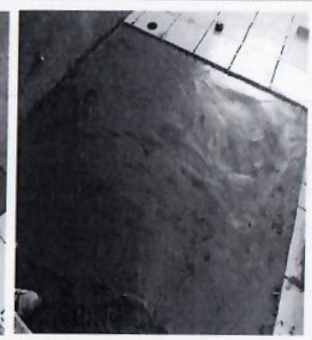
F7: Colado de entortado con concreto hecho en obra para nivelación de superficie en sanitario de hombres
