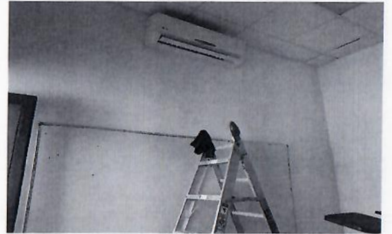
F35: Servicio de mantenimiento mayor a unidades de aire acondicionado
