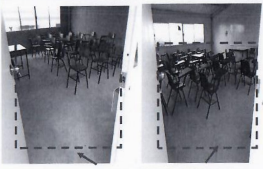
F3: Nivelación y colocación de piso de loseta cerámica esmaltado.
