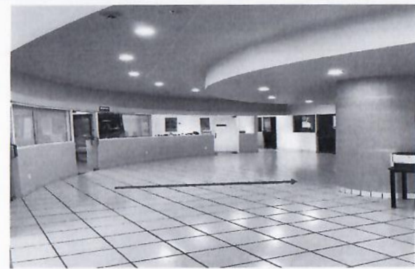
F4: Área donde se desarrollaran muros de tablaroca, con suministro y colocación de cancelería de aluminio.
