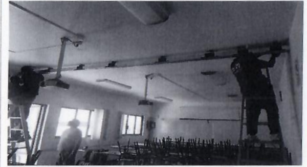
F18: Colocación de riel para muro móvil.
