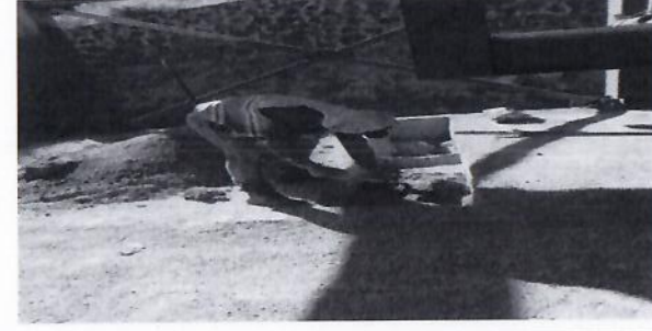
F28: Excavación por medios manuales para construcción de cimentación para muros de site.
