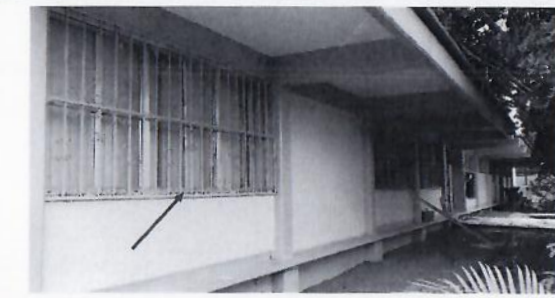
F4: Desmontaje de ventanas, suministro y colocación de cancelería de aluminio.Edificio 3
