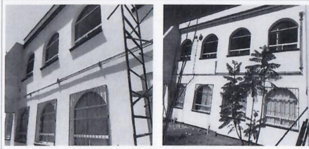
F21: Tendido de tubería conduit para instalaciones eléctrica en muros exteriores
