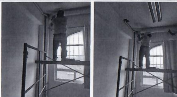
F12: Suministro y colocación de tubería de pvc para instalaciones sanitarias.
