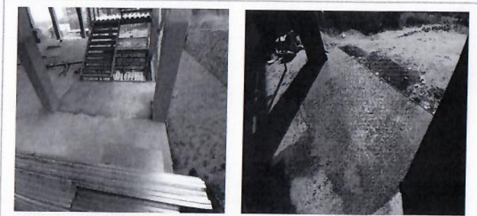
F41: Colado de volados y pasillo faltante hacia escaleras de primer nivel.
