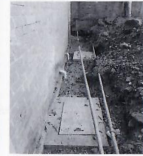
F14: Conexión de registros sanitarios y relleno.
