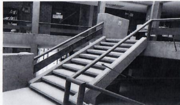
2.- Módulo de escaleras - Sustitución de barandales existentes.
