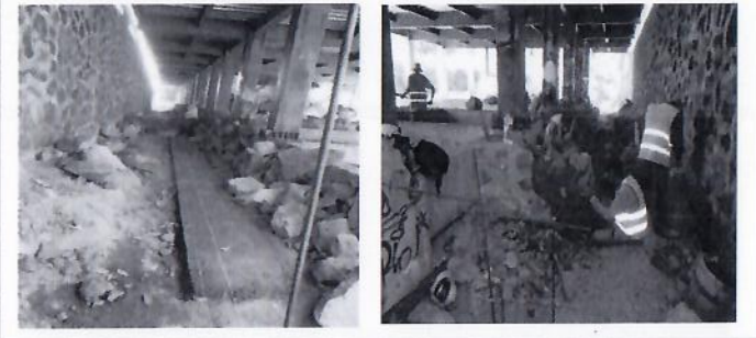
F11: Colocación de plantilla y construcción de muro de mampostería para escaleras y rampa en planta baja.
