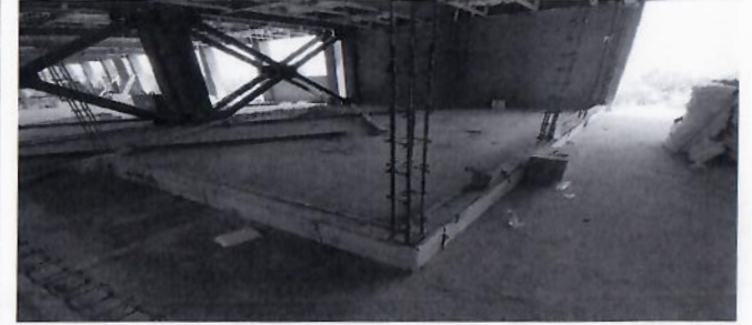
F62: Habilitado de cimbra y colado con concreto hecho en obra de cadenas en primer nivel.
