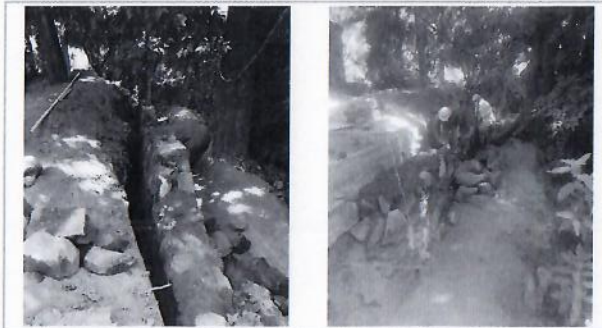
F13: Elaboración de muro de contención en límites de barranquilla
