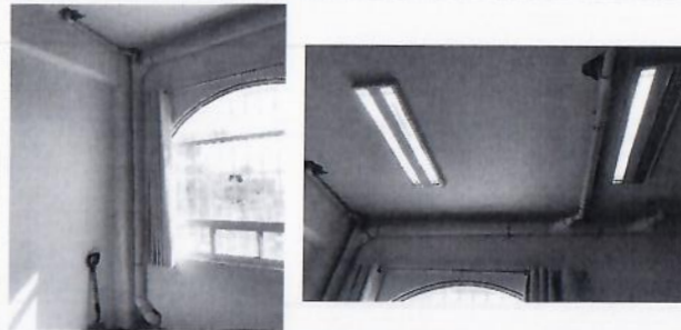
F15: Suministro y colocación de tubería de pvc para instalaciones sanitarias.
