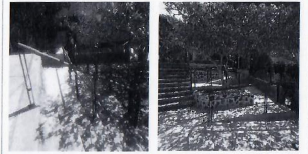
F17: Colocación de barandal.
