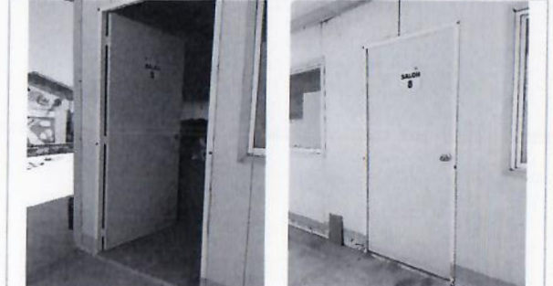
F13: Recolocación de puertas recortadas de acceso a aulas
