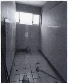
F11: Suministro y colocación de lambrín de azulejo en sanitario de hombres.
