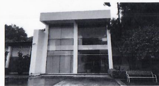
F5: Fachada Edificio Anexo Tamulba, E-4A.
