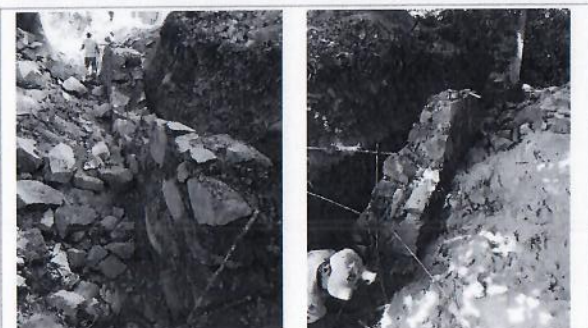
F11: Elaboración de muro de contención en límites de barranquilla
