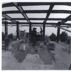
F74: Construcción de muros vintex en segundo nivel.
