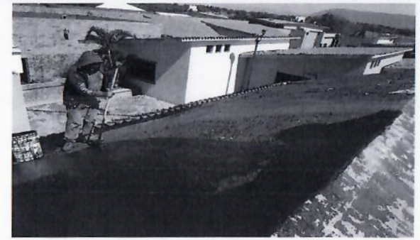
F20: Aplicación de compuesto asfáltico de baja viscosidad
