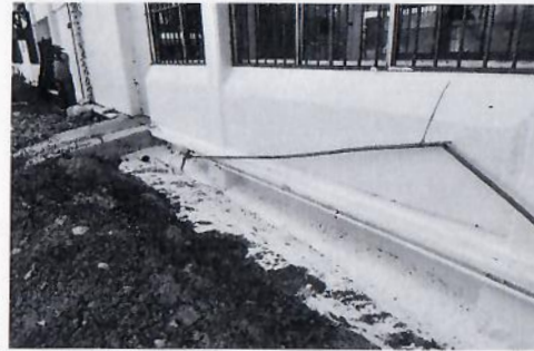
F36: Impermeabilización de cimentación en exterior de auditorio.
