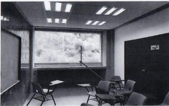
3.- Planta baja barandales por cambiar.
