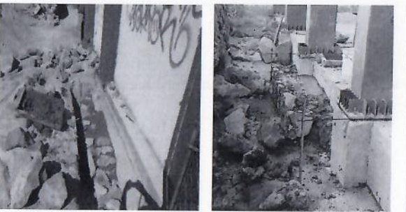
F36: Construcción de mampostería para saliente de muro en planta baja.
