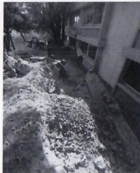
11.- Excavación de terreno por medios manuales.
