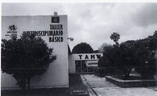
F1: Fachada Edificio Anexo Tamulba, E-4A.
