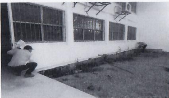
F3: Excavación, impermeabilización de cimentación, relleno de material inerte Auditorio.
