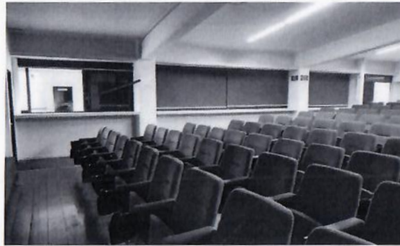
F2: Interior de auditorio donde se colocara puerta de emergencia.
