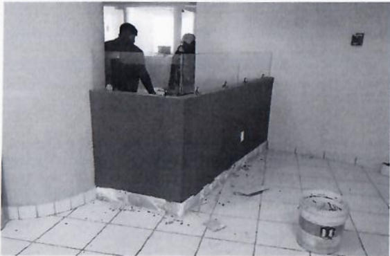
F6: Demolición de zocio.
