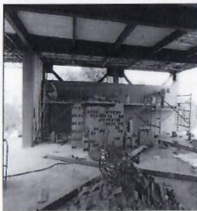
F72: Construcción de muros vintex en fachada oriente.
