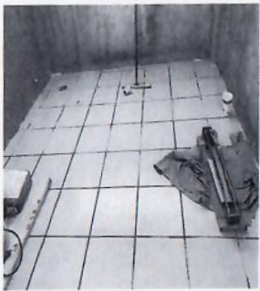
F8: Suministro y colocación de piso de loseta cerámica en sanitario de hombres
