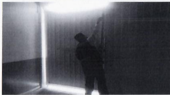
F3: Adecuación a la salida de emergencia suministrando barra antipánico que funcionen y rehabilitando las puertas.
