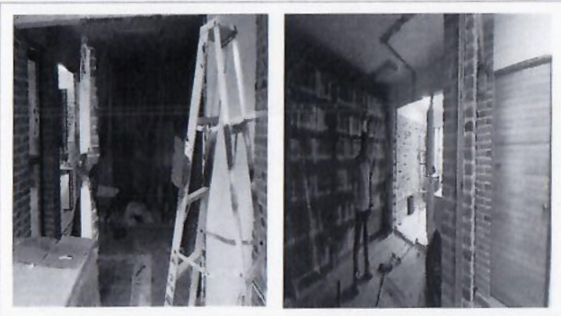
F11: Demolición de muros de tabique.
