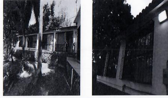
F9: Colocación de reflectores en área exterior.
