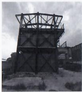
F72: Construcción de muros vintex en fachada oriente.
