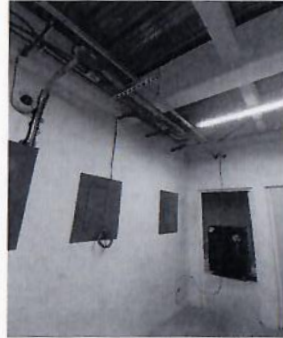
F10: Tendido de tubería eléctrica para conexión de UPS.
