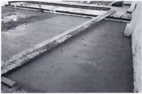
F32: Acabado en piso de concreto de auditorio.
