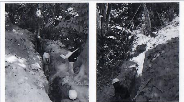
F8: Excavación de terreno por medios manuales para zanja de muro de contención
