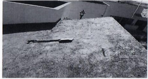
F17: Desprendimiento y retiro de impermeabilizante prefabricado
