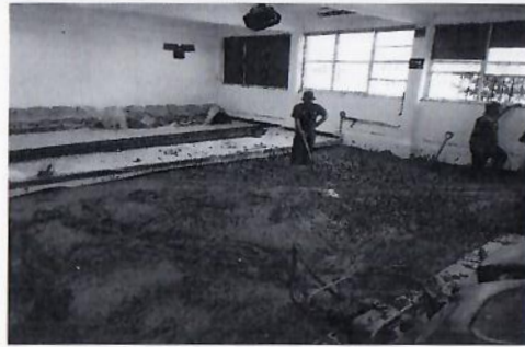
F30: Colado de concreto F'c= 200 kg/cm2 con impermeabilizante Integral en auditorio.
