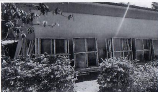
F8: Desmontaje por medios manuales de ventanas de aluminio en edificio 2
