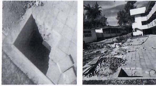
F6: Retiro de adoquín y excavación.
