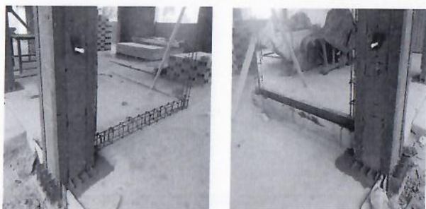
F52: Habilitado de acero y cimbra para cadenas y castillos en planta baja.
