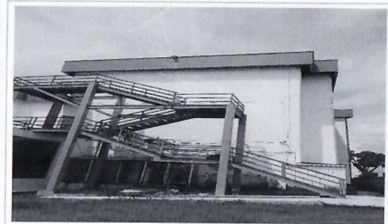
F5: Fachada Lateral
