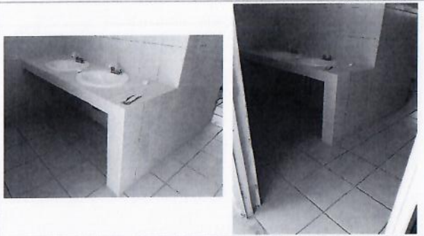
F18: Colocación de muebles sanitarios (lavabos) existentes .
