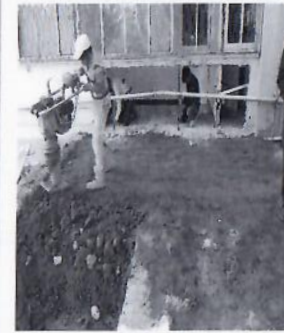
F11: Relleno y compactación de material mejorado.
