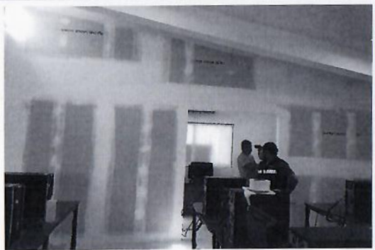
F36: Suministro y fabricación de muro de tablroca en centro de computo
