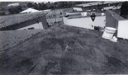
F16: Desprendimiento y retiro de impermeabilizante prefabricado
