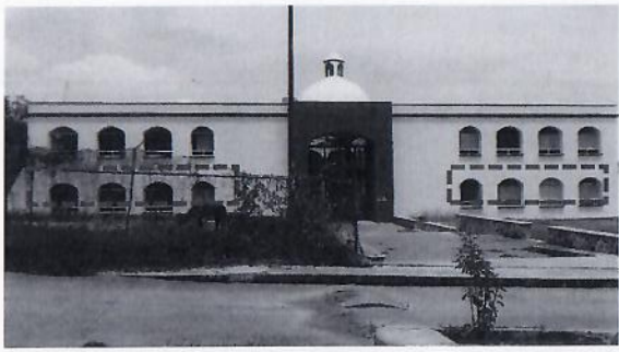
F1: Colocación de Protecciones de herrería en ventanas. Fachada Principal.
