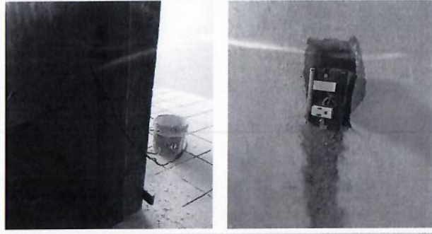
F15: Reubicación de apagador existente en área de cuarto de servicio.
