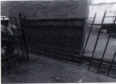
F6: Fabricación en taller de protecciones de herrería
