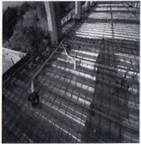
F66: Colocación de tuberías de pvc y cobre para instalación hidrosanitaria en segundo nivel.
