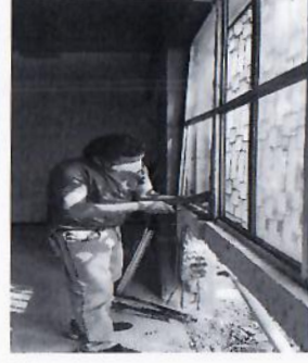
F14: Desmontaje de cancelería de aluminio.
