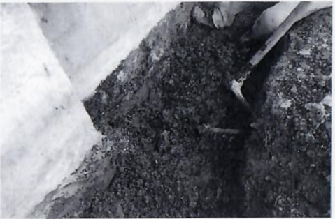
F8: Excavación en exterior de auditorio para determinar profundidad de manto freático.
