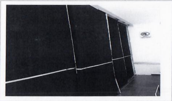
F9: Interior de Salones, donde se encuentra muro móvil a cambiar.
