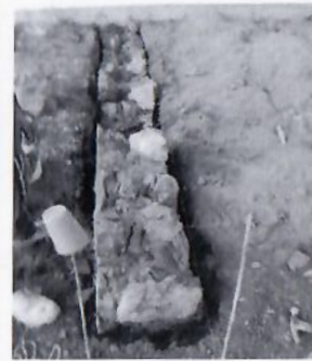
F10: Construcción de muro de mampostería.
