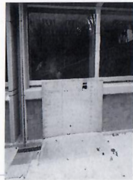
15.- Colado de rampa y firme, colocación de rejilla pluvial.
