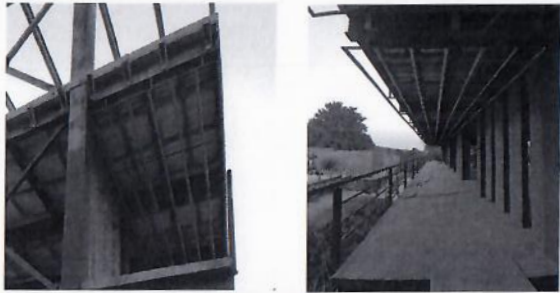
F57: Colocación de bastidor y canal listón para soporte de plafón de durock en pasillo de primer nivel.
