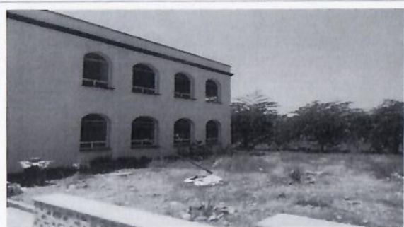
F3: Suministro y colocación de protecciones de herrera en vanos de fachadas P.B.
