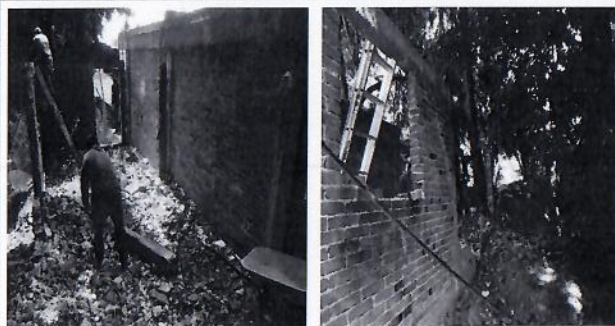
F6: Demolición de muros de tabique rojo, castillos y cadenas de concreto
