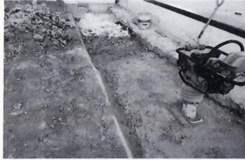
F15: Suministro y relleno con material inerte en auditorio.
