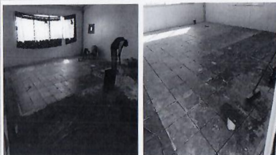
F11: Colocación de piso de loseta cerámica en cinco aulas
