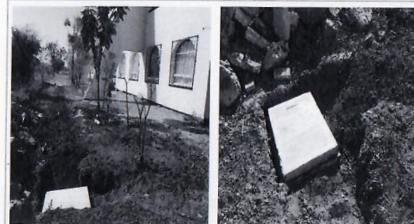
F10: Conexión de tubería de pvc sanitaria a registro exterior existente
