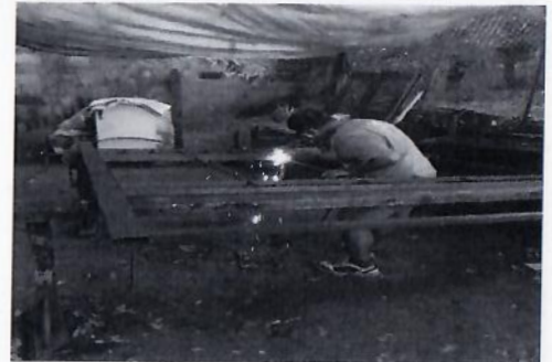
F8: Fabricación en taller de protecciones de herrería
