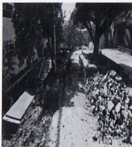
F9: Demolición de firme.
