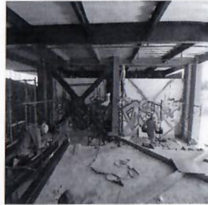
F67: Cambio de contraventeos de planta baja y primer nivel de acuerdo al dictamen estructural presentado por el D.R.O.
