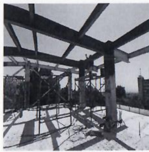
F73: Limpieza y aplicación de primer en estructura de segundo nivel.
