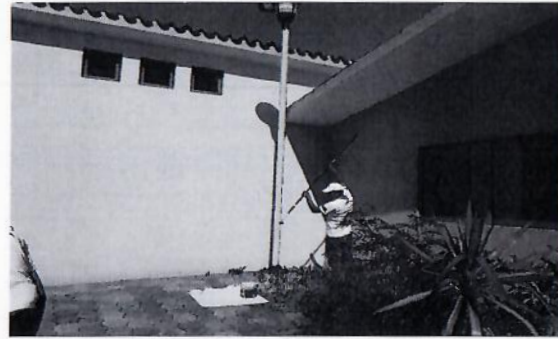
F31: Aplicación de primer anticorrosivo en postes de luminarias
