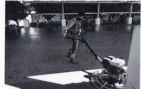
F22: Acabado pulido con allanadora en piso de concreto de explanada.
