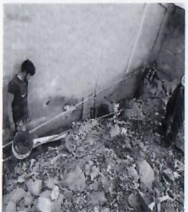
F12: Excavación de zanja para colocación de tubería
