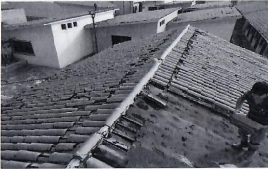
F13: Retiro de teja con recuperación en cubierta de aula 11.
