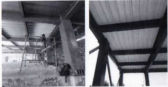
F24: Aplicación de pintura en lámina y estructura en planta baja.
