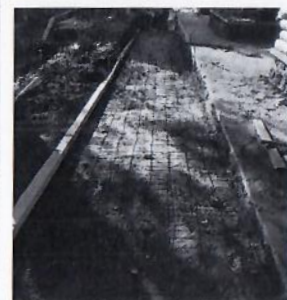
F14: Tendido de malla electrosoldada.
