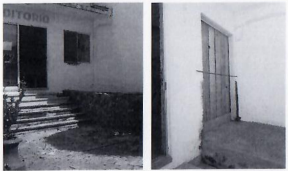
F7: Demolición de muro.
