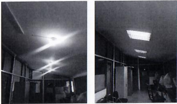
F5: Sustitución de lámparas interiores.
