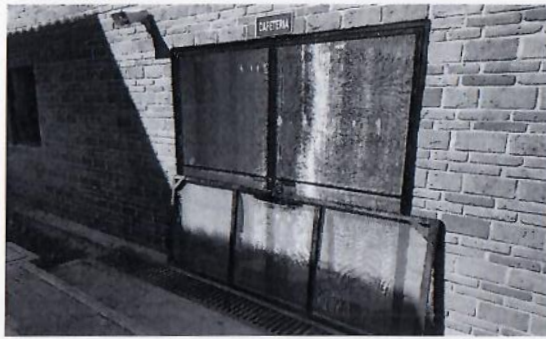
F43: Suministro, Fabricación y colocación de puerta de Herrería con mosquitero en cafetería
