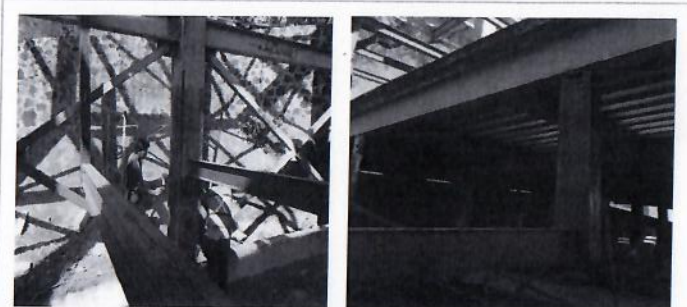
F14: Suministro y colocación de estructura para fabricación de escalera
