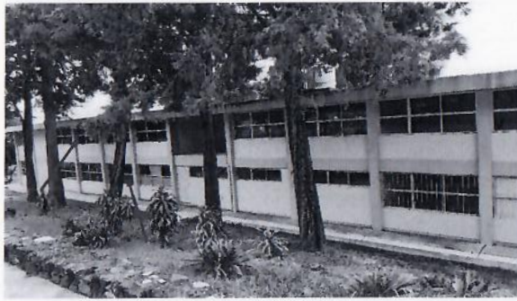
2.- Fachada Posterior, Suministro y colocación de protecciones de herrería.
