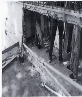
F13: Demolición de muro de tabique.
