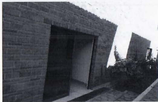
F45: Mantenimiento de puerta de aluminio posterior izquierda.
