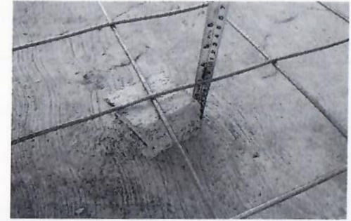
F16: Colocación de catzas para mallá electrosoldada de firme en explanada.
