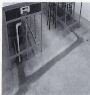
F10: Conexión de desagüe de mesas y colado de firme.
