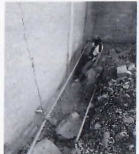
F12: Excavación de zanja para colocación de tubería
