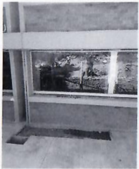
14.- Demolición de repisón y muro de tabique.
