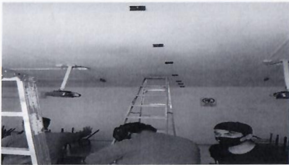
F16: Colocación de riel para muro móvil.
