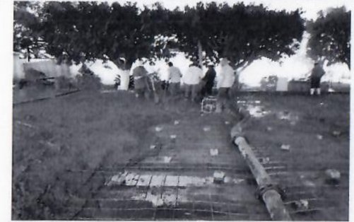
F19: Vaciado de concreto F'c= 250 kg/cm2, premezclado de 15 cm de espesor en explanada.
