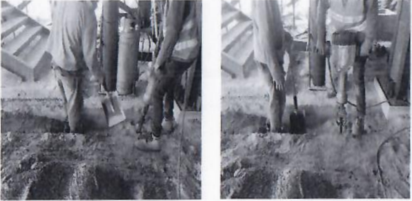
F64: Excavación de terreno para colocación de cimentación para muro en planta baja.
