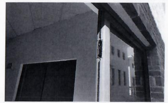
F44: Mantenimiento de puerta de aluminio posterior izquierda.
