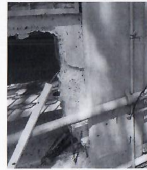
F13: Demolición de muro de tabique.
