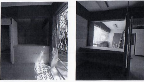
F18: Elaboración de barra de atención de tablaroca.
