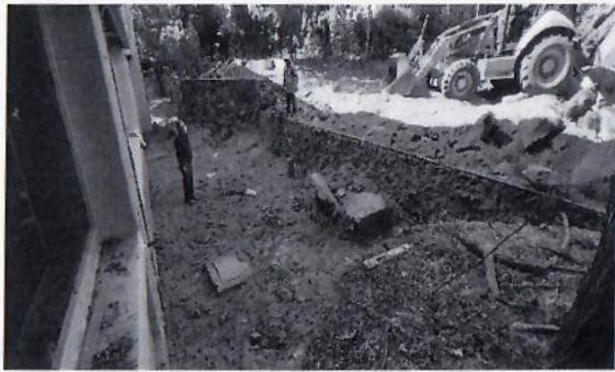
5.- Retiro de material.
