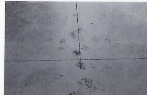
F28: Corte con disco en piso de concreto de explanada.
