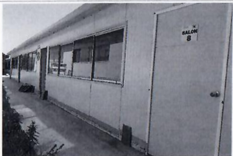
F14: Recolocación de puertas recortadas de acceso a aulas
