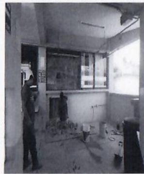
F6: Demolición de muro de tabique y repisón.
