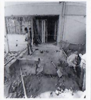
F11: Relleno y compactación de material mejorado.
