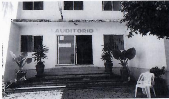
F1: Fachada Principal de acceso Auditorio - Área de fabricación de primer rampa de concreto
