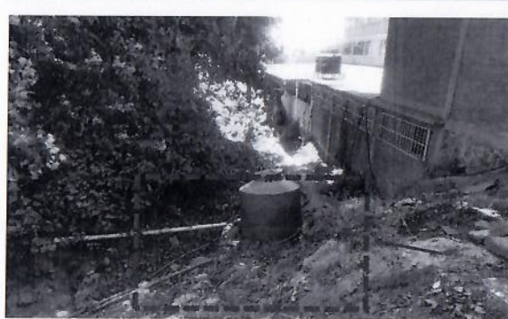
F2: Elaboración de muro de contención y suministro.
