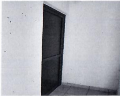
F48: Suministro, Fabricación y colocación de puerta de aluminio en modulo de baño
