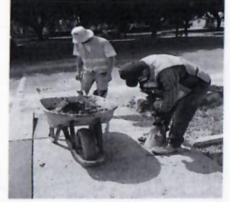
F68: Pruebas de revenimiento durante colado de losa de segundo nivel.
