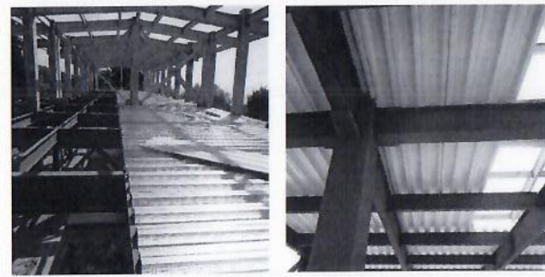
F10: Montaje de láminas de losacero en segundo nivel.
