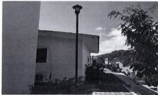
F49: Suministro, colocación y conexión de foco, incluye mantenimiento a poste y remplazo de pantallas
