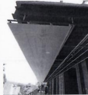
F76: Colocación de hojas de durock para plafon en pasillo de primer nivel.
