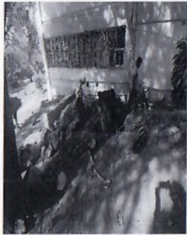
F9: Excavación de terreno para muros de mampostería.
