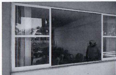
F11: Suministro y colocación de cancelería de aluminio de 2" en edificio 2
