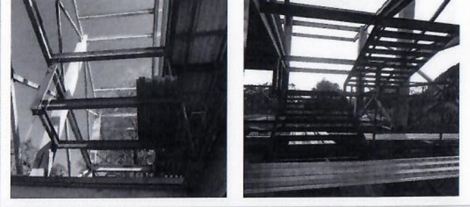
F26: Fabricación de escalera principal de edificio en primer nivel
