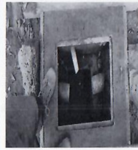
F14: Conexión de registros sanitarios y relleno.
