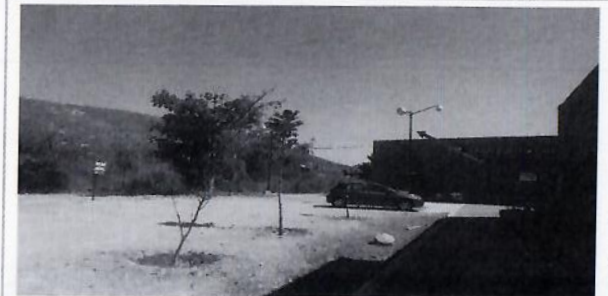
F8: Suministro, colocación y conexión de luminarias exteriores.
