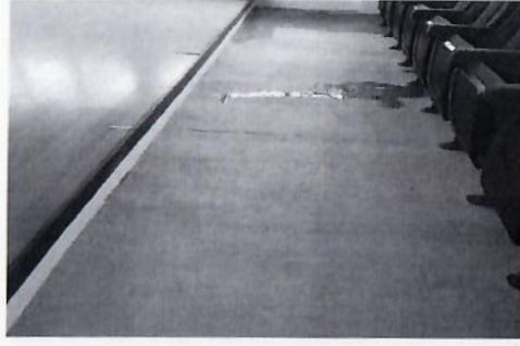
F33: Acabado en piso de concreto de auditorio.
