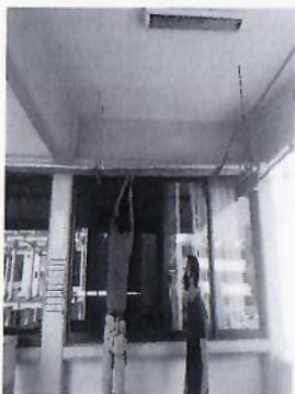
F5: Desmontaje de cancelería de aluminio.
