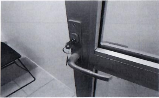
F39: Suministro y fabricación de puerta de aluminio anodizado natural
