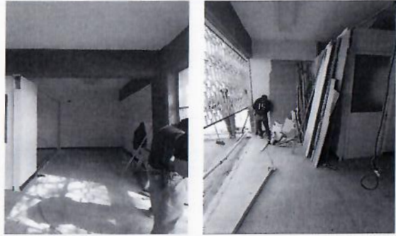
F15: Demolición de muros de tablaroca.
