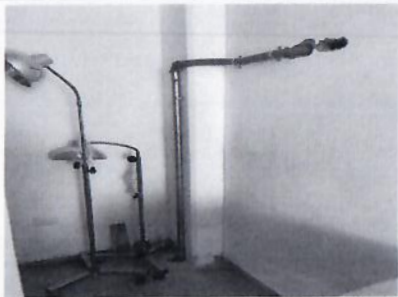
F14: Colocación de tubería conduit y liquatite para instalaciones eléctricas
