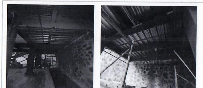
F47: Colocación de bastidor para soporte de plafón de durock en pasillo de planta baja.
