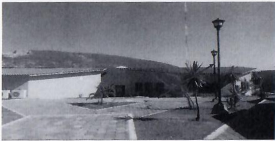
F9: Suministro, colocación y conexión de luminarias exteriores.
