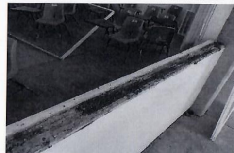
F7: Desmontaje por medios manuales de ventanas de aluminio en edificio 2
