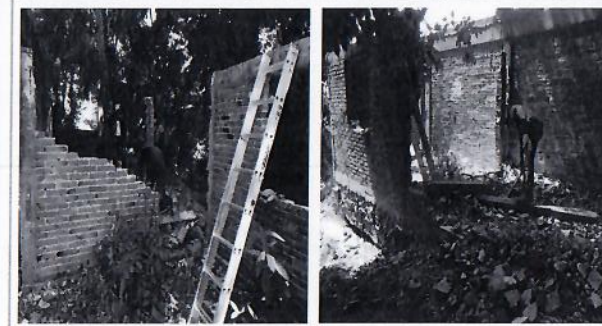
F7: Demolición de muros de tabique rojo, castillos y cadenas de concreto
