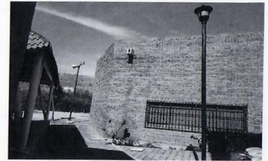
F50 Suministro, colocación y conexión de foco, incluye mantenimiento a poste y remplazo de pantallas
