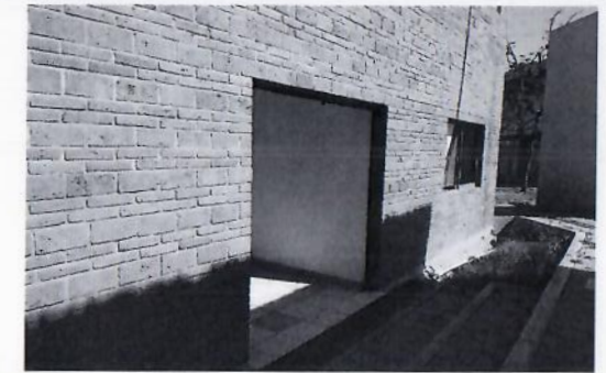
F47: Mantenimiento de puerta de aluminio posterior izquierda.
