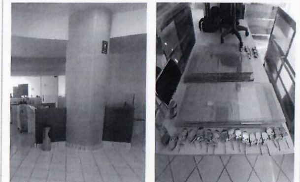
F7: Desmontaje de tabletas de cristal templado con sus herrajes.
