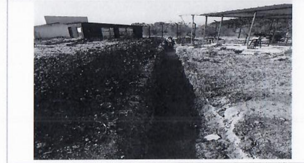
F22: Excavación de terreno por medios manuales para zanja de instalación sanitaria.
