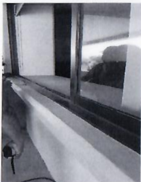
F5: Desmontaje de cancelería de aluminio.
