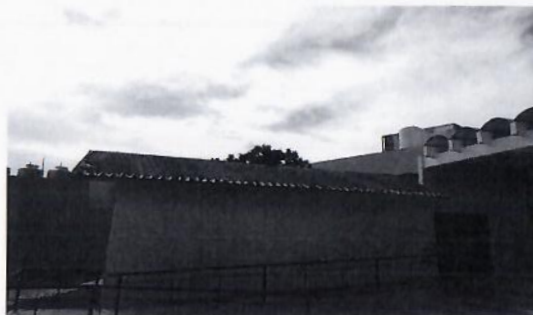
F11: Retiro de teja con recuperación en cubierta de aula 11.
