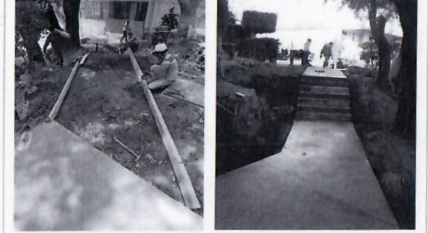
F19: Corte, afine de terreno y colado de andador.
