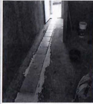
F6: Suministro y colocación de piso de loseta cerámica en sanitario de hombres
