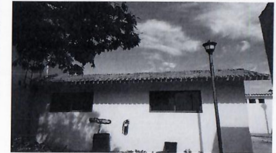
F12: Retiro de teja con recuperación en cubierta de aula 11.
