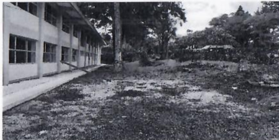
F3: Planta baja se suministrara y colocara en vanos de ventanas protecciones de herrería.
