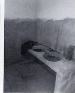
F9: Ranurado de muro de tabique y colado de barra de concreto para lavabos para sanitario de hombres
