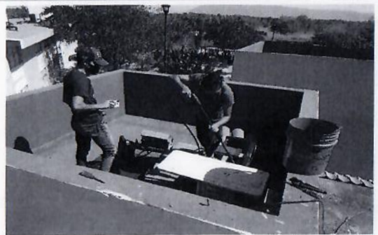
F25: Servicio de mantenimiento mayor a unidades de aire acondicionado
