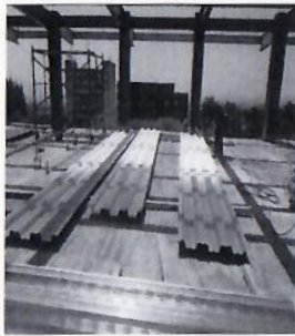
F75: Aplicación de pintura en láminas de losacero para losa de azotea.
