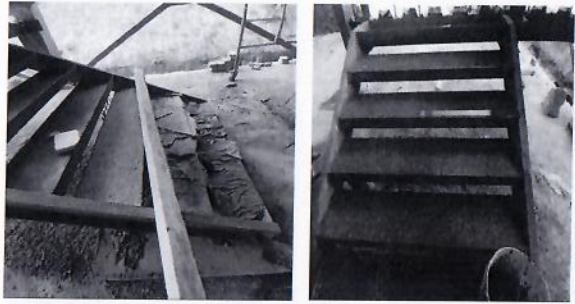
F30: Colado de huellas de escalera con concreto hecho en obra, acabado deslavado planta baja.
