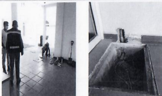
F8: Verificación en registro eléctrico para conexión de tablero
