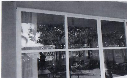
F12: Suministro y colocación de cancelería de aluminio de 2" en edificio 2
