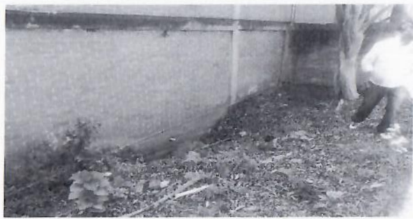
F8: Parte posterior de LOU, Adecuación sanitaria para mesa de laboratorio.
