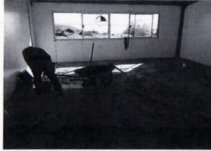
F6: Colado de entortado con concreto hecho en obra para nivelación de superficie
