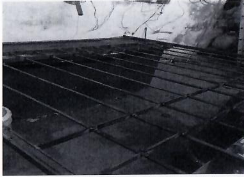
F7: Fabricación en taller de protecciones de herrería
