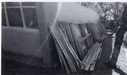
F9: Desmontaje por medios manuales de ventanas de aluminio en edificio 2
