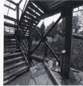
F67: Cambio de contraventeos de planta baja y primer nivel de acuerdo al dictamen estructural presentado por el D.R.O.
