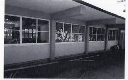
F16: Suministro y colocación de cancelería de aluminio de 2" en edificio 2
