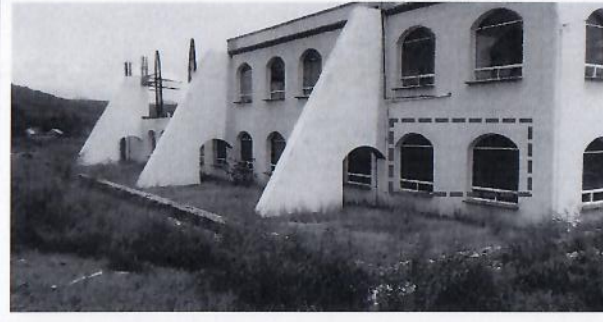
F2: Colocación de Protecciones de herrería en ventanas. Fachada Lateral.
