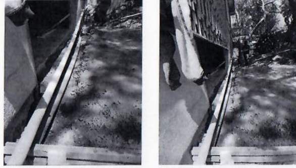
F15: Colocación de tubería para paso de instalación de voz y datos.
