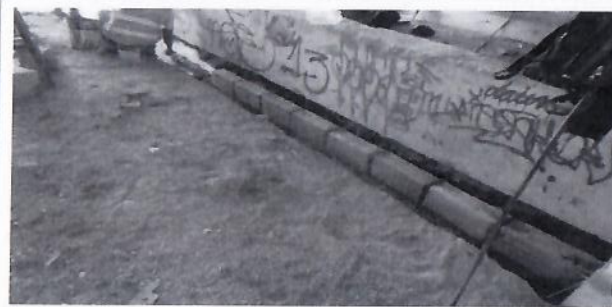
F13: Construcción de murete de block para contención de relleno en planta baja.
