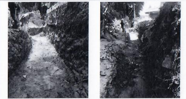
F9: Excavación de terreno por medios manuales para zanja de muro de contención
