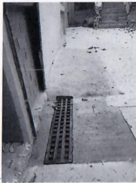
15.- Colado de rampa y firme, colocación de rejilla pluvial.
