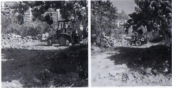
F3: Limpieza de terreno para acceso de material.
