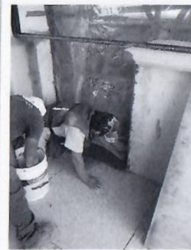
F7: Emboquillado de vanos.
