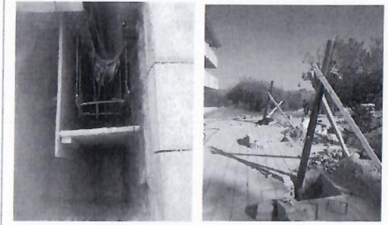
F7: Armado de zapatas aisladas y colocación de postes para velaría.
