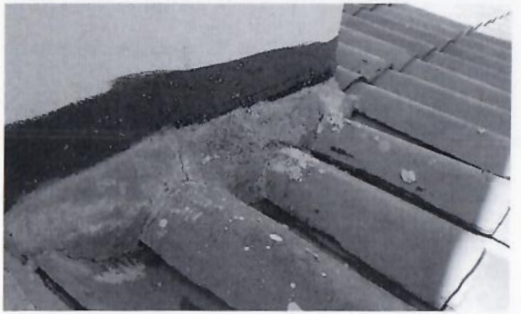
F28: Chafan de concreto F'c= 100 kg/m 2
