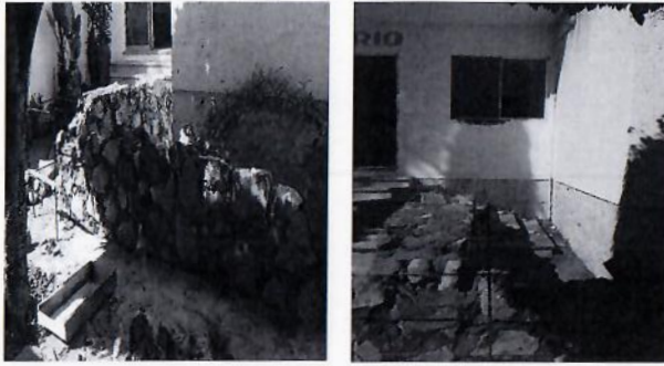
F5: Construcción de muro de mampostería.
