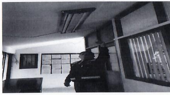
F4: Sustitución de lámparas existentes por luminarias ahorradoras de energía
