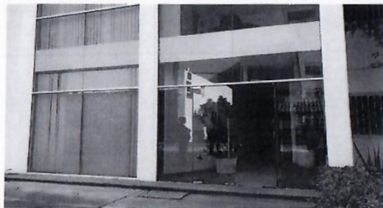
F6: Fachada donde se construirá la salida de emergencia.
