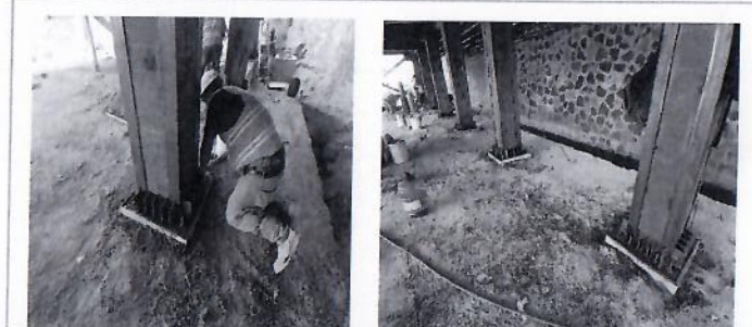
F50: Colado de grout en base de columnas planta baja.
