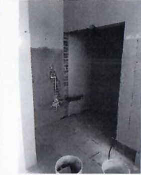
F12: Demolición de muro de tabique para ampliación en área de mingitorios de sanitario de hombres.
