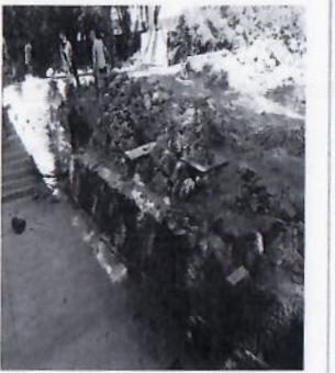
13.- Construcción de muro de mampostería.
