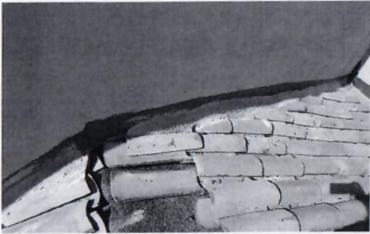
F30: Chaflán de concreto F'c= 100 kg/m 2
