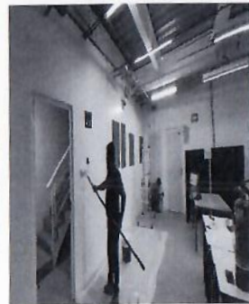
F12: Aplicación de pintura vinílica en interior.
