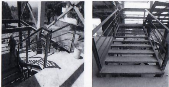
F60: Colocación de barandal en escalera principal de edificio.
