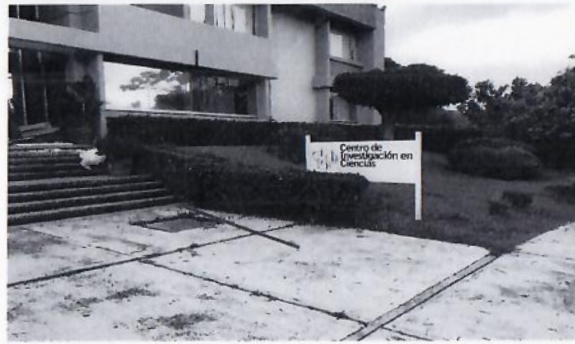
4.- Barandales por cambiar en modulo de escaleras.
