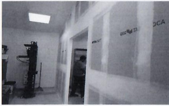
F37: Suministro y fabricación de muro de tablroca en centro de computo
