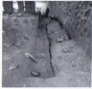
F80: Excavación de zanja por medios manuales para tuberías de instalaciones eléctrica, pluvial y voz y datos.
