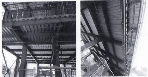
F27: Colocación de bastidor metálico para soporte de plafón de durock en pasillo de planta baja.
