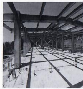
F73: Limpieza y aplicación de primer en estructura de segundo nivel.
