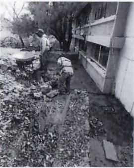
8.- Demolición de muro de mampostería.
