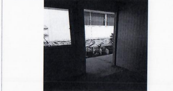
F9: Desmontaje de puertas de acceso a aulas para recorte por colocación de piso de loseta
