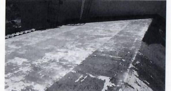
F18: Desprendimiento y retiro de impermeabilizante prefabricado
