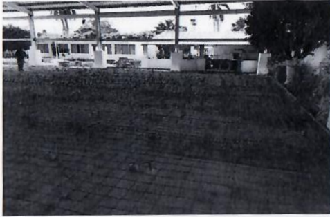
F17: Colocación de fronteras para firme en explanada.
