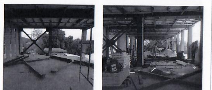
F56: Cambio de contraventeos en primer nivel de acuerdo al dictamen estructural presentado por el D.R.O.
