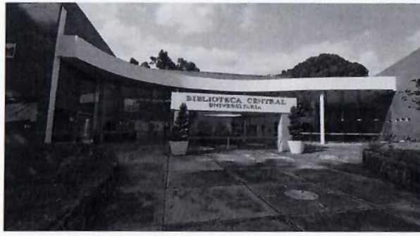
F7: Aplicación de pintura vinílica en fachada principal.
