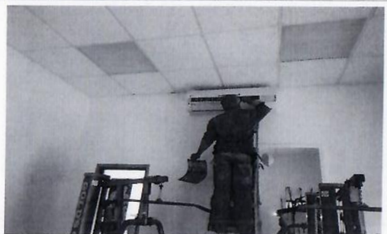
F26: Servicio de mantenimiento mayor a unidades de aire acondicionado
