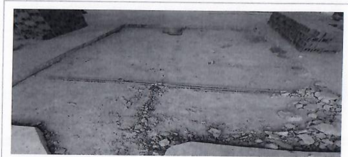
F44: Demolición de firme para colocación de tubería sanitaria en planta baja.
