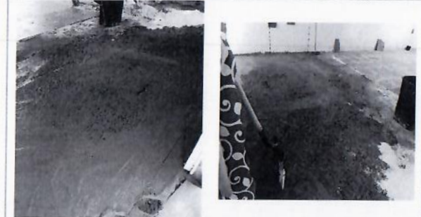
F7: Colado de entortado con concreto hecho en obra para nivelación de superficie
