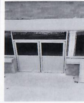
16.- Adecuación de cancelería y colocación de puerta de emergencia.
