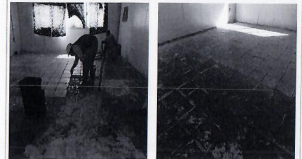
F10: Colocación de piso de loseta cerámica en cinco aulas
