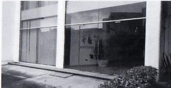
F7: Fachada Edificio Anexo Tamulba, E-4A.
