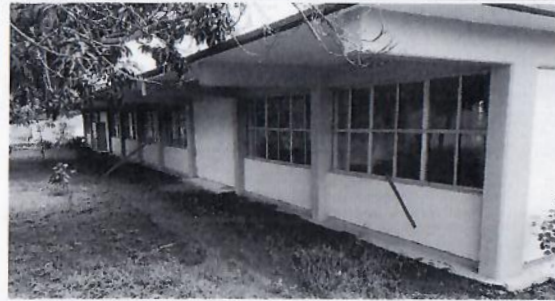
F2: Desmontaje de ventanas, suministro y colocación de cancelería de aluminio.Edificio 2
