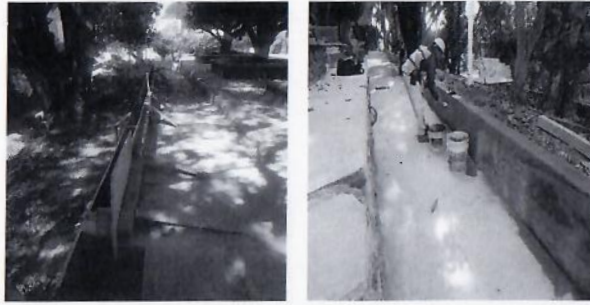
F16: Construcción de mureta de concreto.
