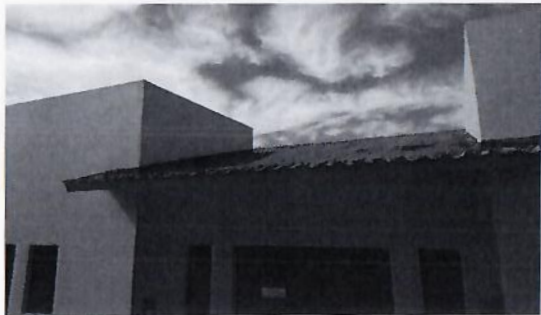
F10: Retiro de teja con recuperación en cubierta de gimnasio.
