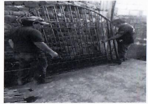
F8: Fabricación en taller de protecciones de herrería
