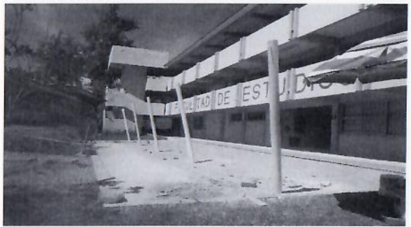
F9: Aplicación de pintura en postes.
