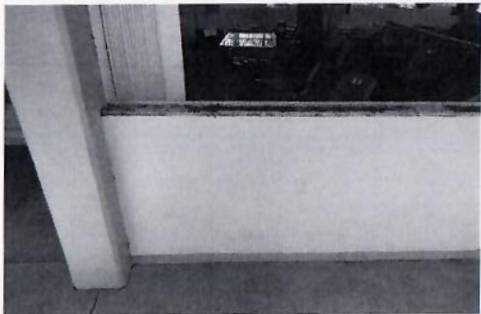
F5: Desmontaje por medios manuales de ventanas de aluminio en edificio 2
