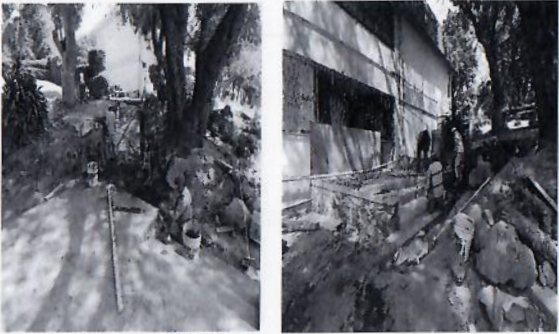
F17: Elaboración de escalones, acabado lavado.
