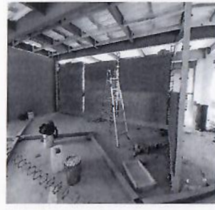
F71: Construcción de muros interiores de tabique rojo recocido en primer nivel.
