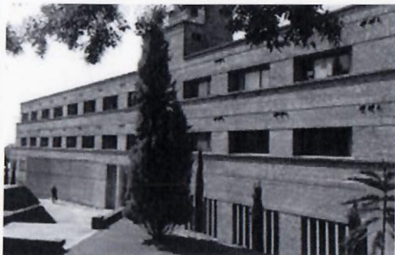
F1: Fachada Principal
