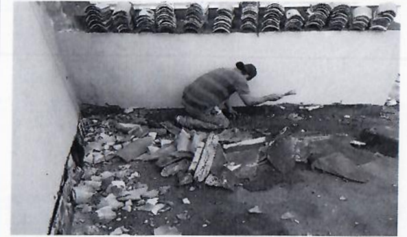
F15: Demolición de chaflanes de concreto
