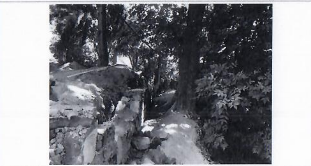
F12: Elaboración de muro de contención en límites de barranquilla
