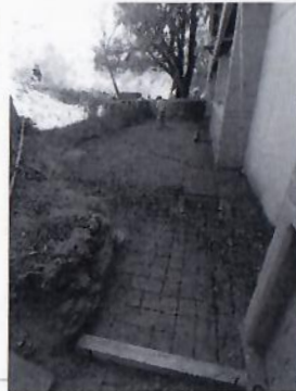
9.- Tendido de malla electro-soldada.
