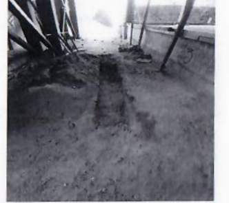
F80: Excavación de zanja por medios manuales para tuberías de instalaciones eléctrica, pluvial y voz y datos.
