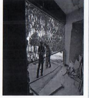
F14: Desmontaje de cancelería de aluminio.
