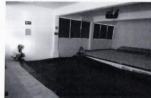
F25: Colocación de membrana plástica en auditorio.
