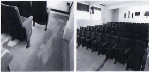
F35: Rehabilitación y montaje de butacas recuperadas en auditorio.
