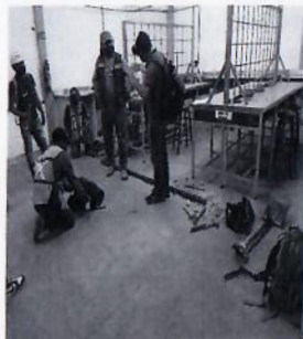
F9: Corte y demolición de firme de concreto
