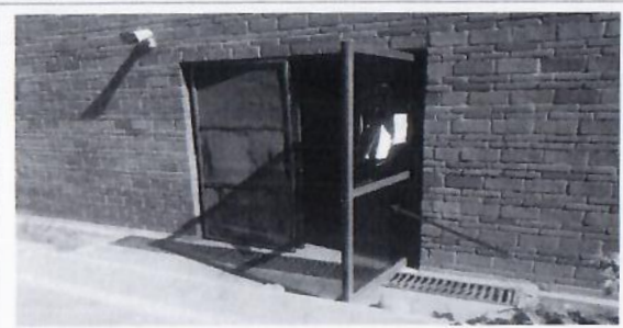
F3: Mantenimiento de puertas de aluminio Edificio 01.
