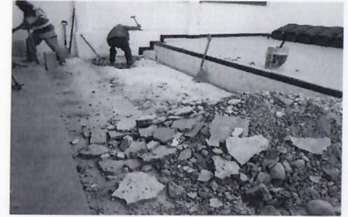
F10: Demolición de piso de concreto armado en auditorio.
