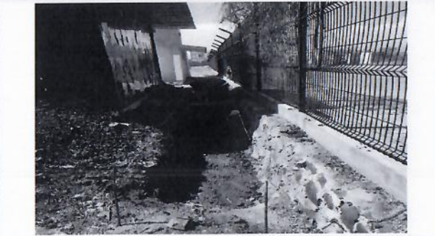
F21: Excavación de terreno por medios manuales para zanja de instalación sanitaria.
