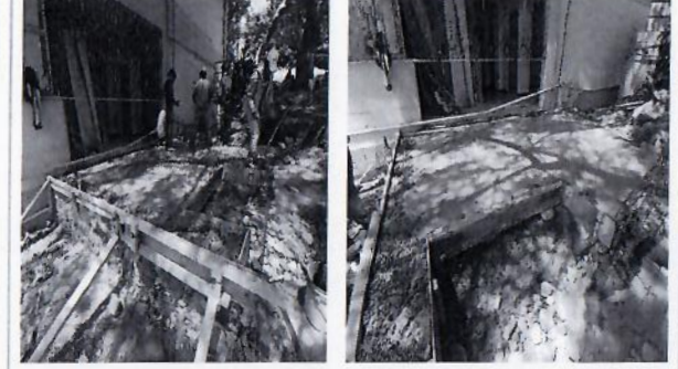
F16: Colado de firme acabado lavado.
