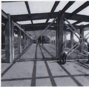
F69: Colado con concreto premezclado de losa de entresuelo de segundo nivel.
