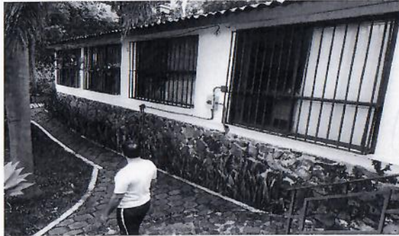
F2: Fachada Lateral
