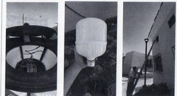
F53: Suministro, colocación y conexión de foco, incluye mantenimiento a poste y remplazo de pantallas
