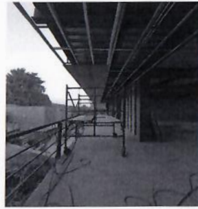
F76: Colocación de hojas de durock para plafon en pasillo de primer nivel.
