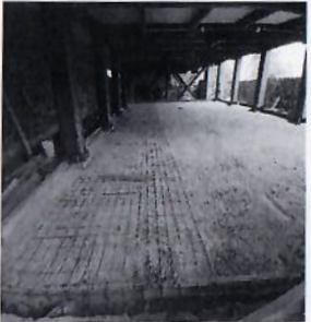
F78: Colocación de malla electrosoldada y habilitado de cimbra para colado de firme en planta baja.
