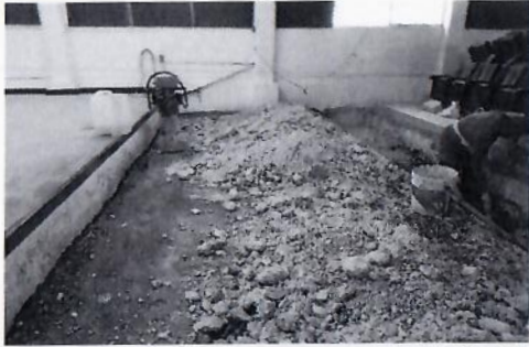
F14: Excavación y corte de terreno en auditorio.
