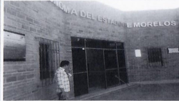
F2: Mantenimiento de puertas Edificio 01 con aluminio.
