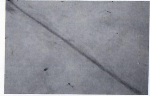
F34: Calafateo de junta de dilatación en piso de explanada.
