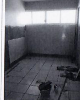
F10: Suministro y colocación de lambrín de azulejo en sanitario de hombres
