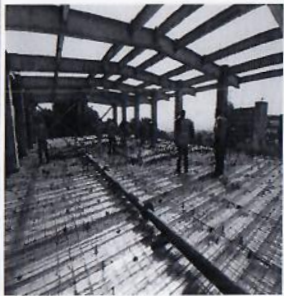
F69: Colado con concreto premezclado de losa de entresuelo de segundo nivel.
