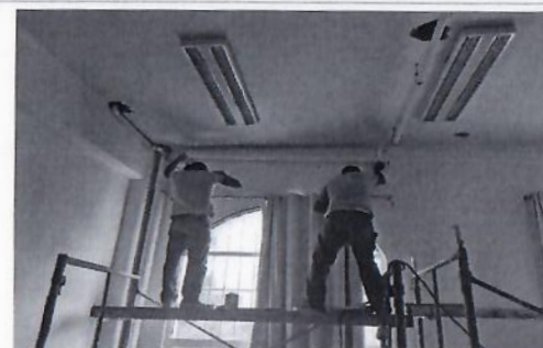
F13: Suministro y colocación de tubería de pvc para instalaciones sanitarias.
