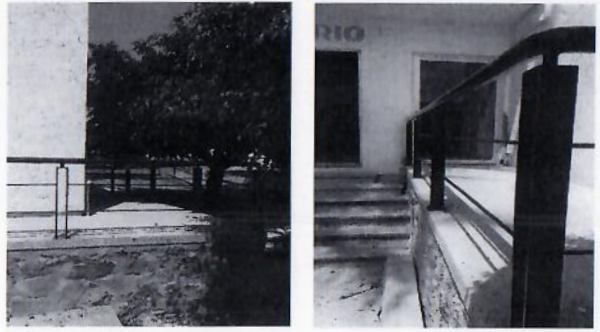
F11: Aplicación de pintura en barandal.
