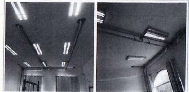
F16: Suministro y colocación de tubería de pvc para instalaciones sanitarias y tubería conduit para instalaciones eléctricas
