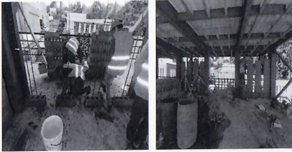
F21: Construcción de muros vintex en primer nivel.
