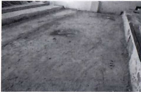
F24: Suministro, relleno y compactación de material inerte en auditorio.
