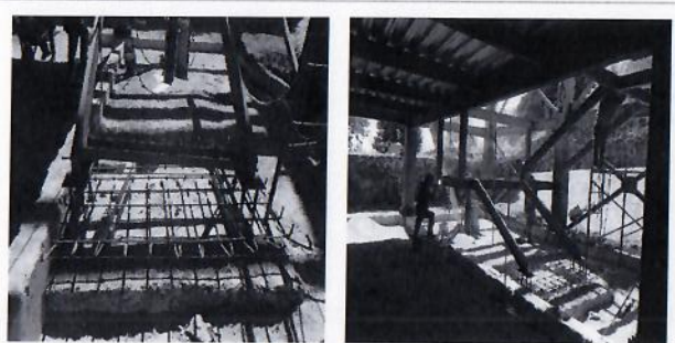
F16: Habilitado de acero para zapata de escalera.
