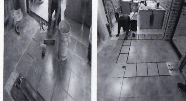
F14: Colocación de loseta cerámica.
