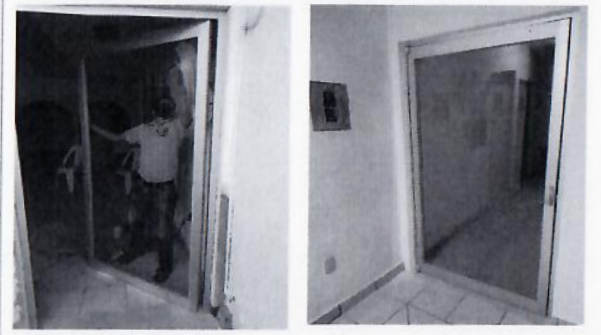
F9: Colocación de puerta.
