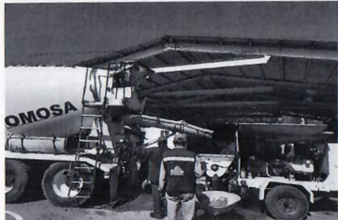
F20: Toma de muestras para pruebas de resistencia de concreto de explanada.
