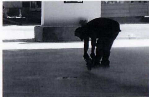
F26: Corte con disco en piso de concreto de explanada.
