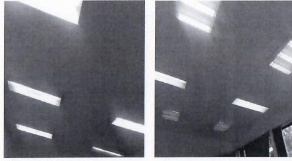
F6: Sustitución de lámparas interiores.
