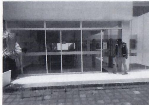
F4: En el acceso norte (acceso a segunda planta por estacionamiento) se sustituirá cancel existente
