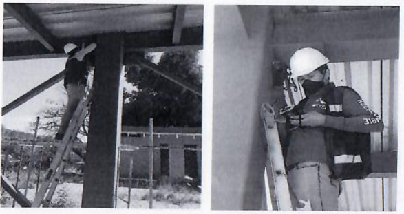
F15: Pruebas de líquidos penetrantes y ultrasonido a estructura existente.
