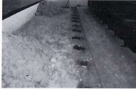
F6: Desmontaje de butacas.
