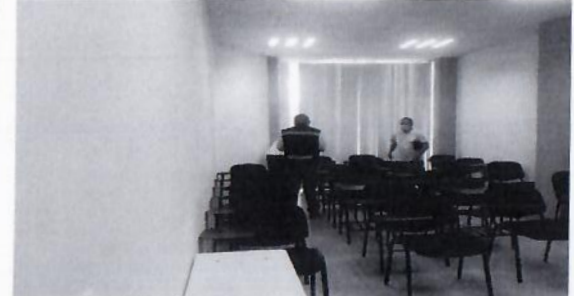
F8: Aula interior donde abrirá puerta de emergencia E-4A.
