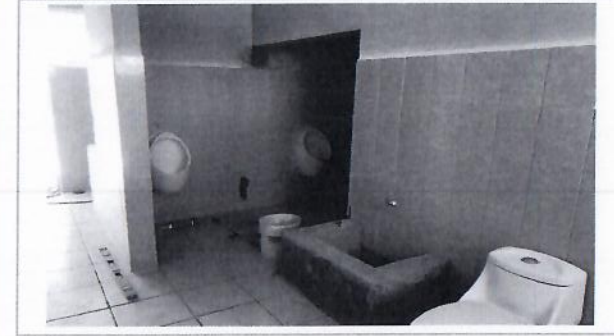
F16: Colocación de muebles sanitarios (mingitorios) existentes .
