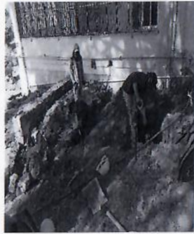
F9: Excavación de terreno para muros de mampostería.
