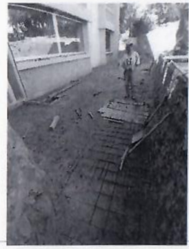
9.- Tendido de malla electro-soldada.
