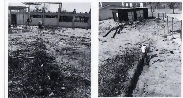
F19: Excavación de terreno por medios manuales para zanja de instalación sanitaria.
