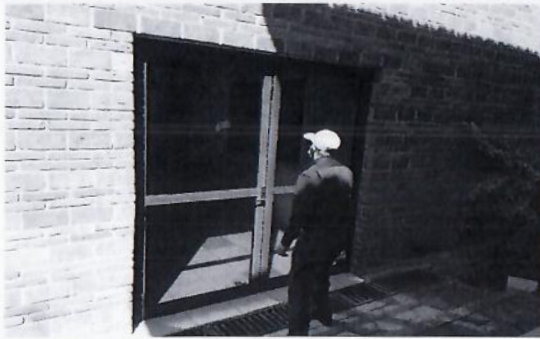
F46: Mantenimiento de puerta de aluminio posterior izquierda.
