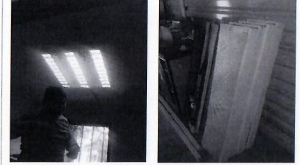
F7: Sustitución de lámparas interiores.
