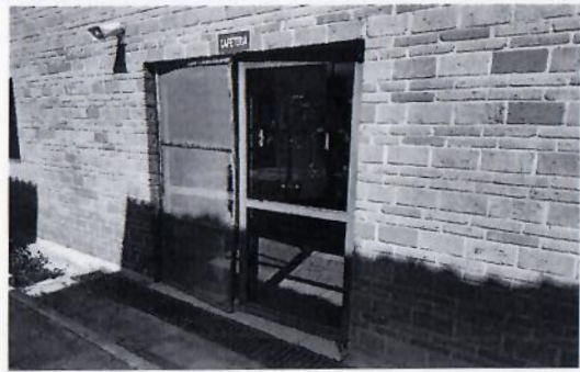
F42: Suministro, Fabricación y colocación de puerta de Herrería con mosquitero en cafetería
