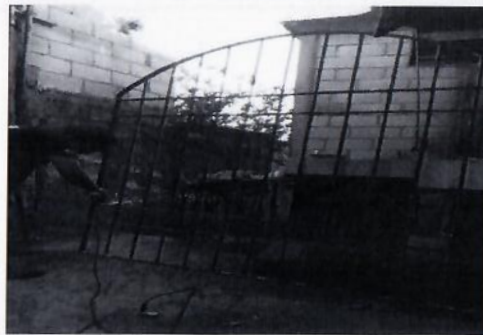
F7: Fabricación en taller de protecciones de herrería
