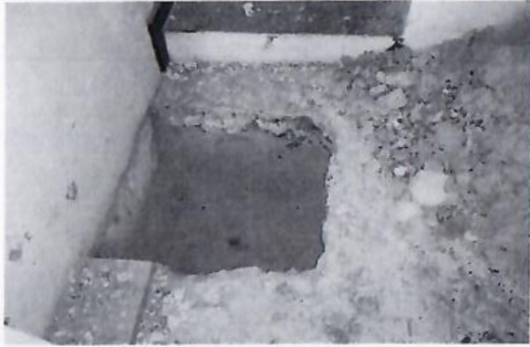
F5: Cala para determinar profundidad de manto freático.
