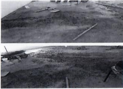
F5: Colado de entortado con concreto hecho en obra para nivelación de superficie
