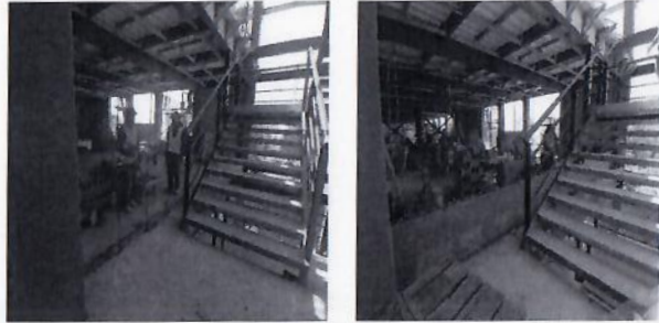
F61: Construcción de muros vitex en primer nivel.
