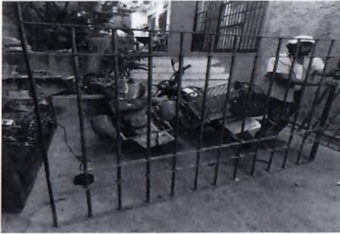
F6: Fabricación en taller de protecciones de herrería
