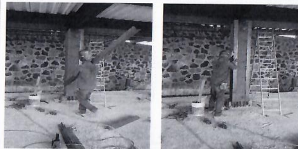
F40: Colocación de ángulos de refuerzo en columnas de planta baja, de acuerdo al dictamen estructural presentado por el D.R.O.
