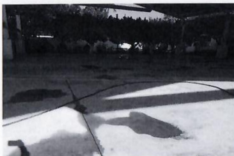
F29: Curado de piso de concreto de explanada.
