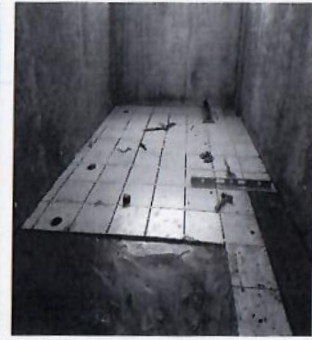
F6: Suministro y colocación de piso de loseta cerámica en sanitario de hombres
