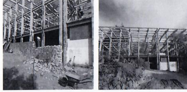
F4: Demolición de muro de mampostería existente
