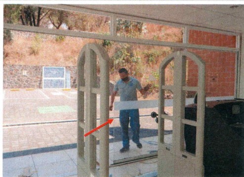
F14: Sustitución de cancel en acceso norte.
