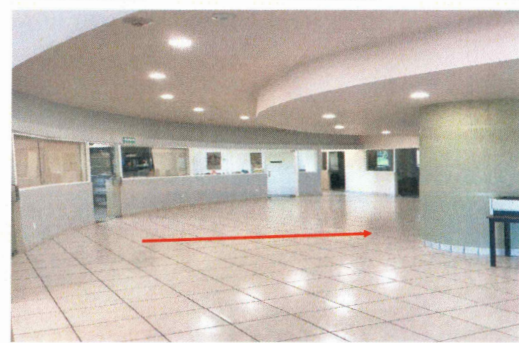
F4: Área donde se desarrollaran muros de tablaroca, con suministro y colocación de canceleria de aluminio.
