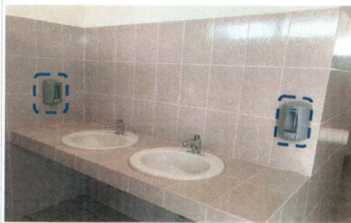
F5: Suministro y colocación de jaboneras en muros de barra da lavabos
