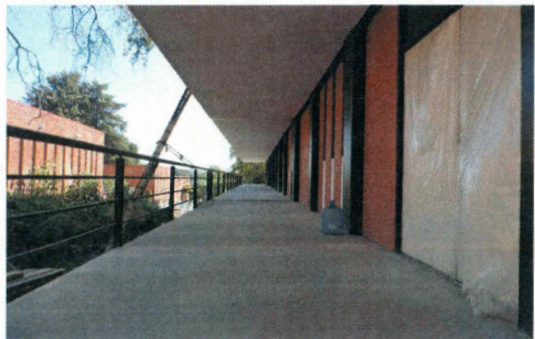
F30: Firme de concreto en pasillos.
