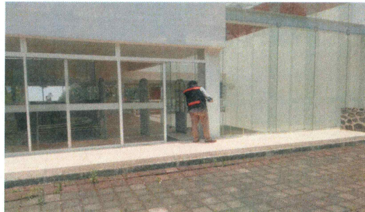
F4: En el acceso norte (acceso a segunda planta por estacionamiento).
