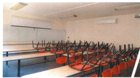
F9: Aplicación de pintura vinílica sobre muros y plafón.
