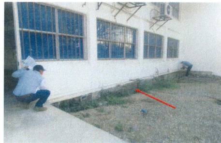
F3: Excavación, impermeabilización de cimentación, relleno de material inerte Auditorio.
