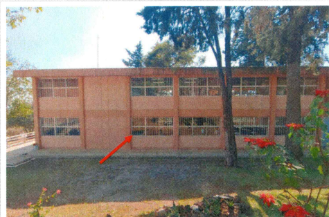
F15: Suministro y colocación de protecciones de herrería en aulas del edificio 10.
