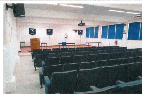
F12: Aplicación de pintura vinílica color blanco en muros de auditorio.
