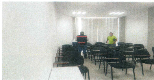
F4: Aula interior donde abrirá puerta de emergencia E-4A.
