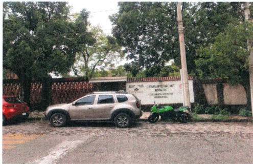
F1: Fachada Principal
