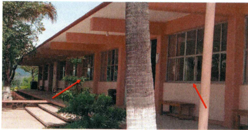
F1: Desmontaje de ventanas, suministro y colocación de cancelería de aluminio, desmontaje de puertas, suministro, armado y colocación de multy-puerta. Edificio 2.
