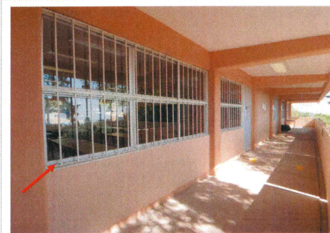
F20: Suministro y colocación de protecciones de herrería en aulas del edificio 10.
