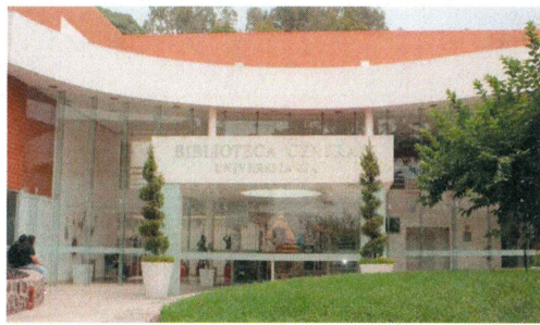
F1: Fachada Principal.
