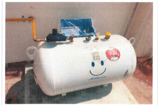
F22: Suministro y colocación de tanque de gas estacionario, con base de concreto.
