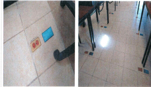
F31: Suministro y fabricación de tapa ciega de aluminio
