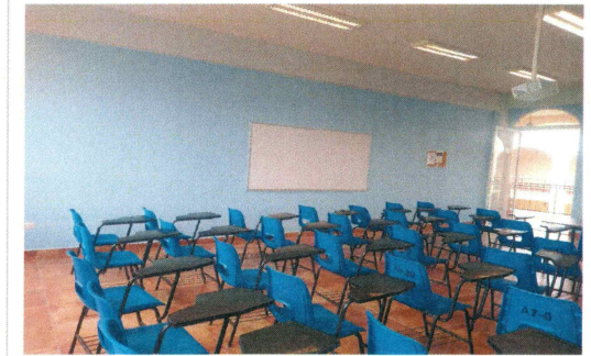
F20: Aplicación de pintura vinilica en aulas
