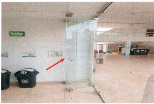
F17: Suministro y colocación de puerta plegable entrada principal de biblioteca.
