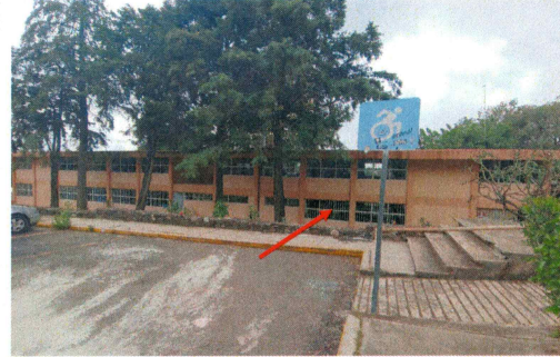
F10: Protecciones de herrería en aulas de Edificio 10.
