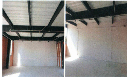
F37: Suministro y aplicación de pintura (segunda mano) en muros
