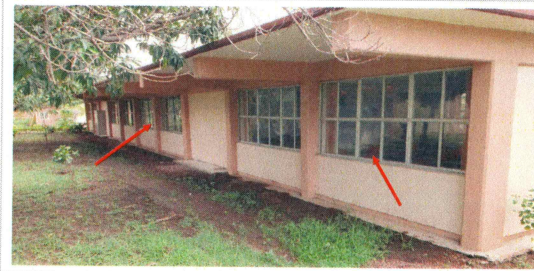
F2: Desmontaje de ventanas, suministro y colocación de cancelería de aluminio Edificio 2.
