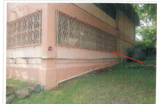
F8: Fachada Oeste Edificio A-13.
