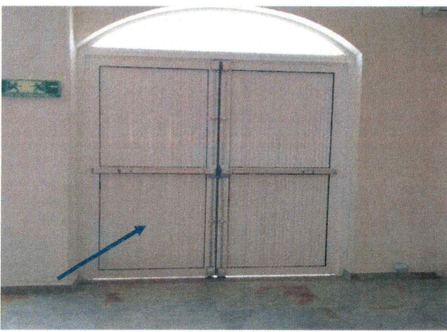
F24: Suministro y colocación de puerta de aluminio blanco en auditorio.
