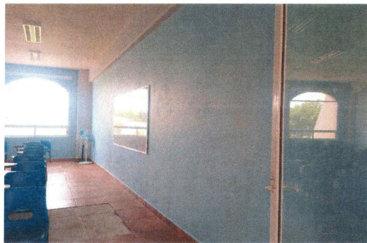
F22: Aplicación de pintura vinílica en aulas
