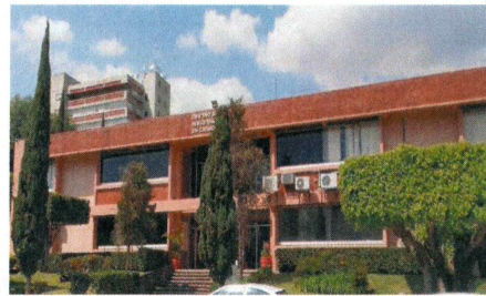
F1.- Fachada Principal.
