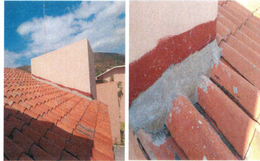
F28: Chaffan de concreto F c= 100 kg/m2 and colocación de teja de barro.
