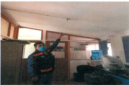
F3: Sustitución de lámparas existentes por luminarias ahorradoras de energía
