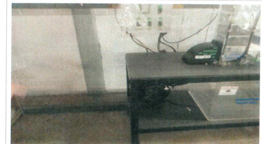
F5: Adecuación sanitaria para mesa de laboratorio.
