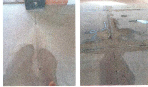
F19: Corte con cortadora sobre pisos pulidos de concreto
