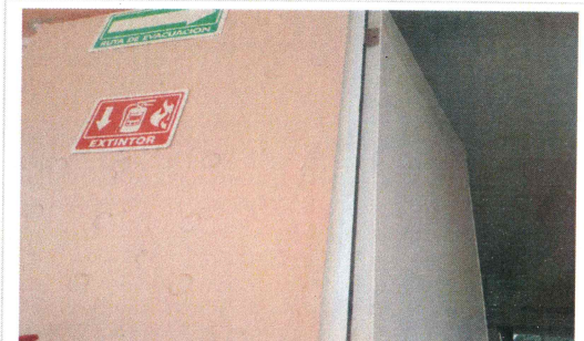
F8: Suministro y colocación de puertas tipo capfice en aulas.
