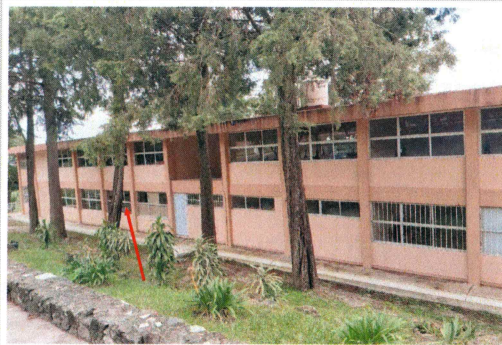
F2: Fachada Posterior. Suministro y colocación de protecciones de herrería.
