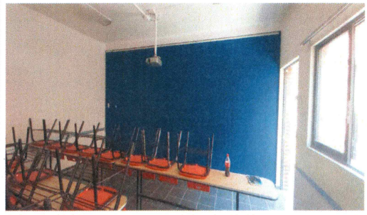
F8: Suministro y colocación de pintura vinílica sobre muros y plafón
