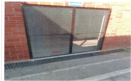
F35: Suministro, Fabricación y colocación de puerta de Herrería con moquitero en cafetería.
