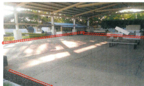
F2: Trazo, picoteo de concreto, Fabricación de firme de concreto, corte con disco y calafateo. Plaza Cívica.
