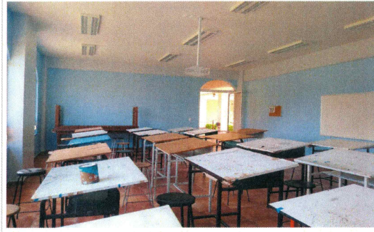
F13: Aplicación de pintura vinilica en aulas
