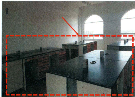
F3: Movimiento de Mesas de laboratorio para colocación de instalaciones hidrosanitarias y eléctricas.
