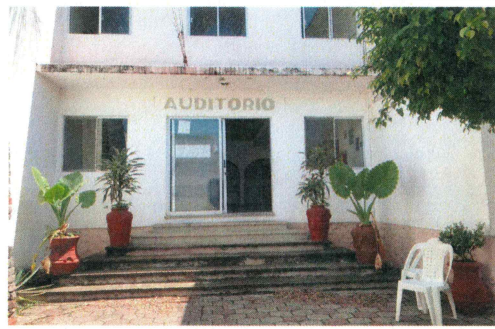
F1: Fachada Principal de acceso Auditorio - Área de fabricación de primer rampa de concreto
