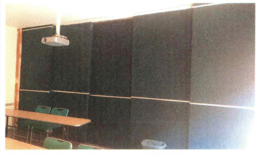
F6: Interior de Salones, donde se encuentra muro móvil a cambiar.
