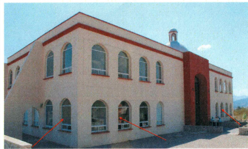
F1: Suministro y colocación de protecciones de herrería.
