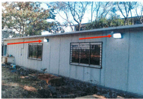
F8: Colocación de reflectores en área exterior.
