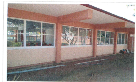
F5: Suministro y colocación de cancelería de aluminio de 2" en edificio 2.
