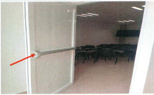
F8: Suministro y colocación de puerta de aluminio blanco con barra antipánico para salida de emergencia.
