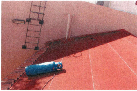
F27: Aplicación de sistema impermeable prefabricado
