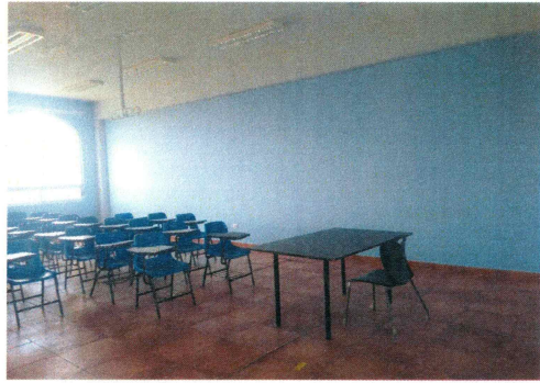
F21: Aplicación de pintura vinílica en aulas
