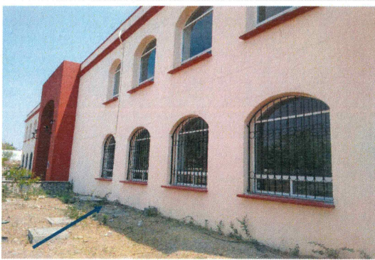
F25: Suministro y colocación de protecciones de herrería en P-1 y P-2.
