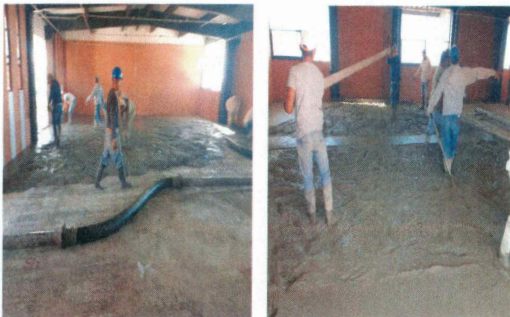
F13: Colado de firmes de concreto premezclado en interior de aulas
