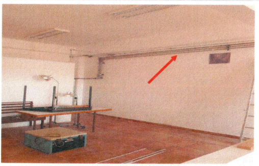
F11: Tendido de tuberías conduit para instalaciones eléctricas
