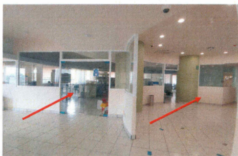
F12: Muros de tablaroca, con suministro y colocación de cancelería de aluminio, reubicación de contactos y colocación de puertas de cristal templado.
