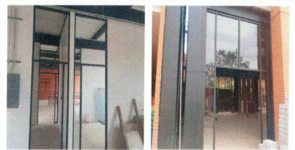
F11: Suministro y colocación de cancelería de aluminio duranodik
