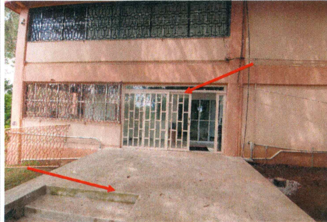
F9: Puerta protección de herrería y firme de concreto en acceso principal a Edificio 13.
