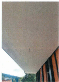
F3: Aplicación de pintura vinilica color blanco en plafón de pasillos
