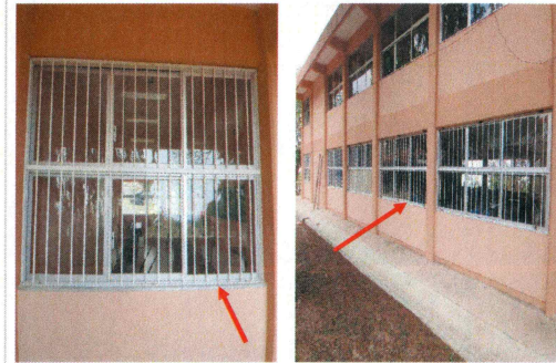
F14: Suministro y colocación de protecciones de herrería en aulas del edificio 10.
