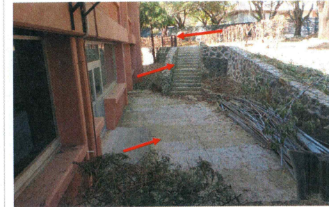
F11: Construcción de muro de mampostería, firme, escaleras y colocación de barandal de herrería en pasillo posterior de salida de emergencia.
