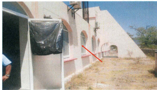
F2: Suministro y colocación de protecciones de herrería.
