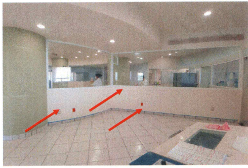
F16: Muros de tablaroca, con suministro y colocación de cancelería de aluminio, reubicación de contactos.
