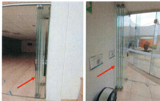
F18: Suministro y colocación de puerta plegable entrada principal de biblioteca.
