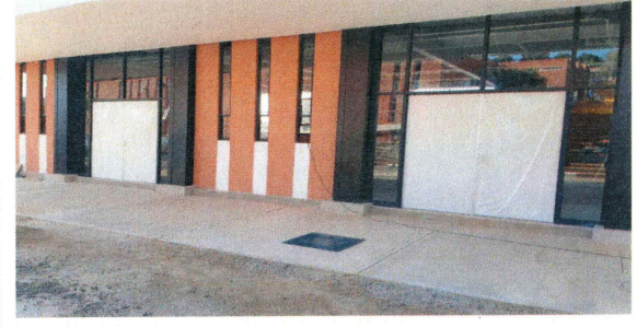
F17: Suministro y colocación de puertas tipo capfce
