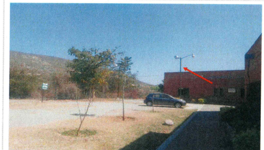
F8: Suministro, colocación y conexión de luminarias exteriores.
