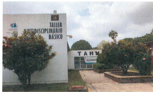
F1: Fachada Edificio Anexo Tamulba, E-4A.
