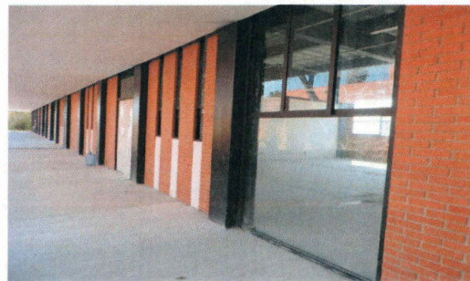
F31: Instalación de cancelería de aluminio.
