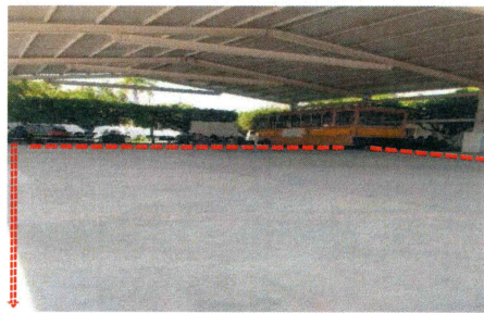
F1: Fabricación de firme de concreto. Plaza Cívica
