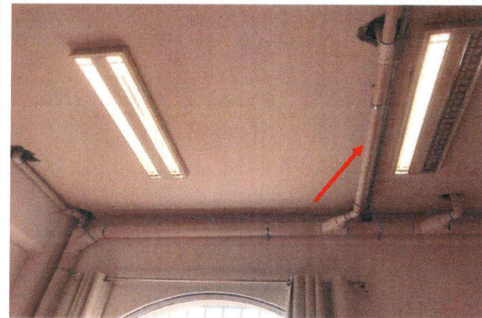
F6: Suministro y colocación de tubería de pvc para instalaciones sanitarias y tubería conduit para instalaciones eléctricas.
