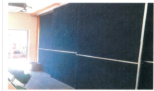
F5: Interior de Salones, donde se encuentra muro móvil a cambiar.
