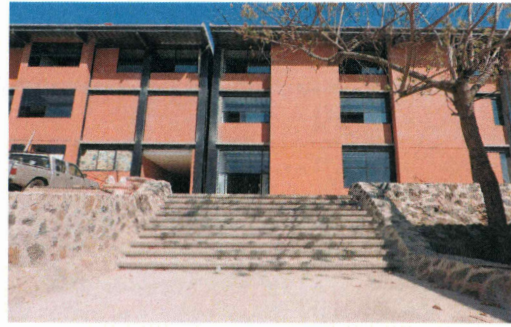
F43: Firme de concreto para la entrada principal (escaleras)
