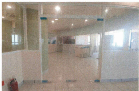
F8: Colocación de puertas de cristal templado
