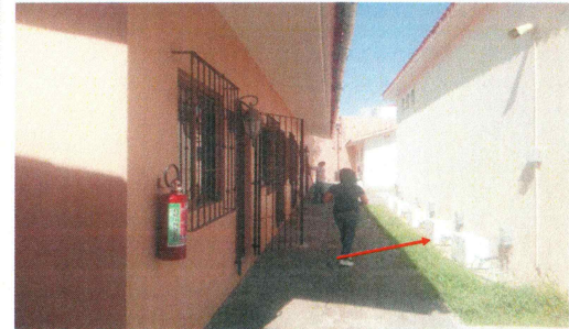
F4: Mantenimiento preventivo a unidades de refrigeración Edificio 06.
