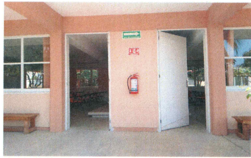
F6: Suministro y colocación de puertas tipo capfice en aulas.
