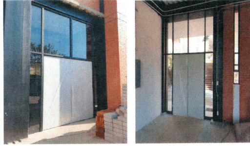
F16: Suministro y colocación de puertas tipo capfce
