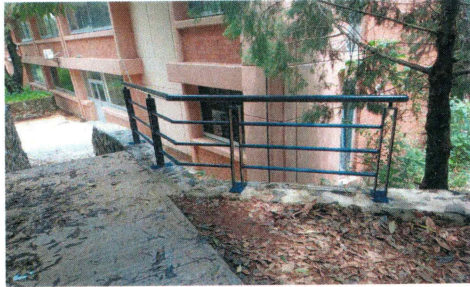
F7: Colocación de barandal de herrería en pasillo posterior de salida de emergencia.
