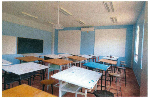
F12: Aplicación de pintura vinilica en aulas
