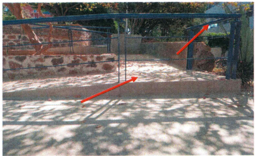
F11: Construcción de rampa, con Colocación de barandal de herrería.
