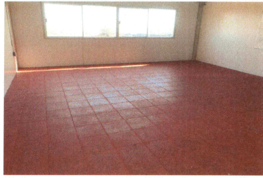
F6: Colocación de piso de loseta cerámica en cinco aulas.
