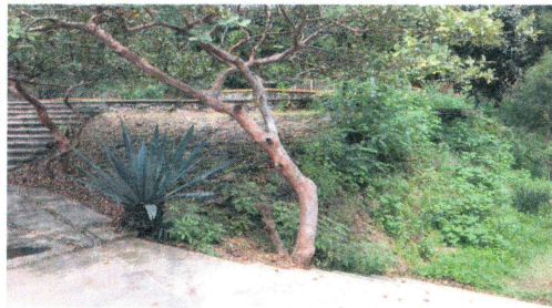
F3: Fachada Edificio Anexo Tamulba, E-4A. Rampa
