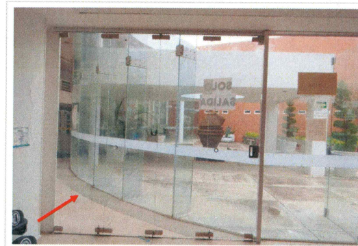
F16: Suministro y colocación de puerta plegable entrada principal de biblioteca.
