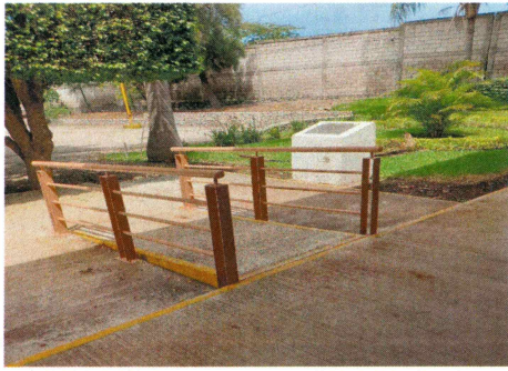
F8: Colocación de barandal de herrería en rampas
