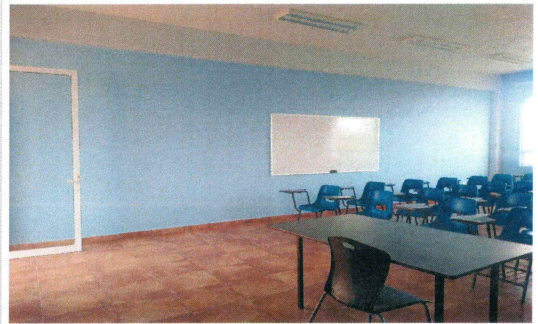
F19: Aplicación de pintura vinilica en aulas
