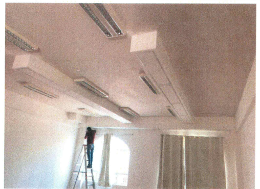
F8: Colocación de cajillo de tablaroca para cubrir tuberías sanitarias.
