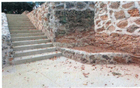
F10 : Construcción de muro de mampostería, firme y escaleras.
