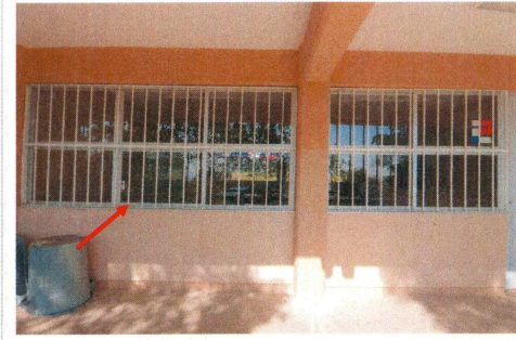
F17: Suministro y colocación de protecciones de herrería en aulas del edificio 10.
