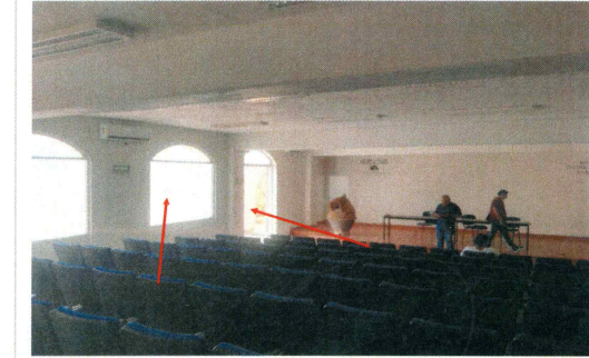
F5: Suministro y colocación de protecciones de herrería y puerta de emergencia.
