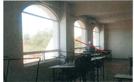
F4: Suministro y colocación de protecciones de herrería.
