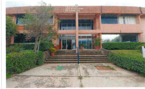
F9: Colocación de pasamanos y barandal de herrería en escaleras de acceso principal
