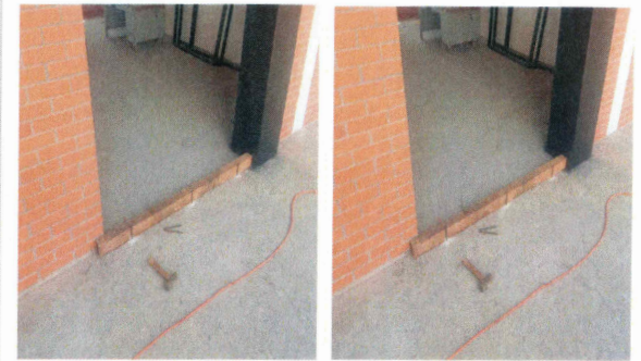
F8: Habilitado de cimbra en puerta de acceso a aulas para colado de firmes
