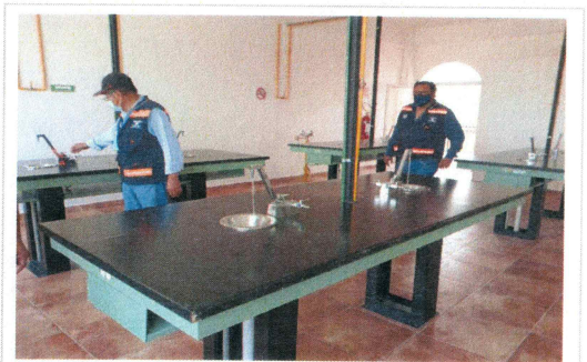
F13: Pruebas hidráulicas en mesas de laboratorio
