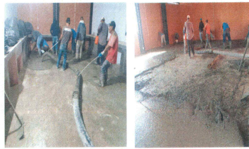
F22: Colado de firmes de concreto premezclado en interior de aulas
