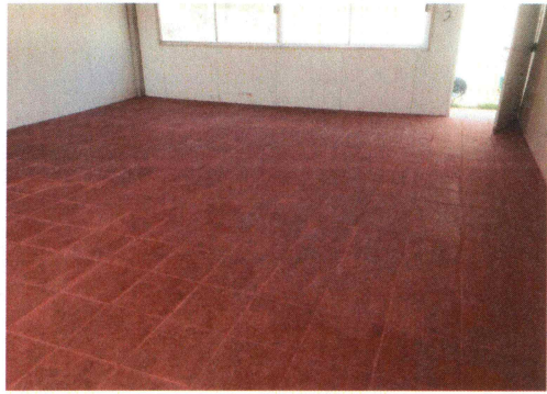
F5: Colocación de piso de loseta cerámica en cinco aulas.
