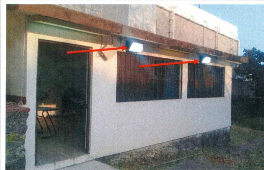
F9: Colocación de reflectores en área exterior.
