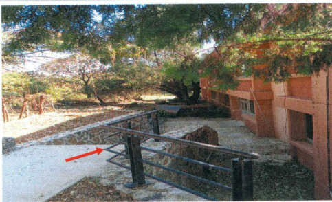
F12: Construcción de muro de mampostería, firme, escaleras y colocación de barandal de herrería en pasillo posterior de salida de emergencia.
