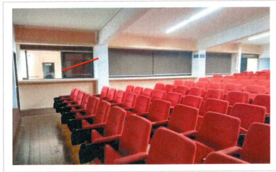
F2: Interior de auditorio donde se colocara puerta de emergencia.
