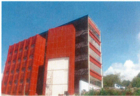
F1: Fachada Principal
