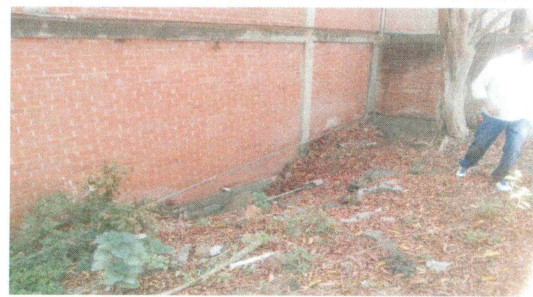
F4: Parte posterior de LOU. Adecuación sanitaria para mesa de laboratorio.
