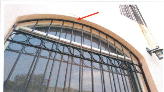
F7: Suministro y colocación de protecciones de herrería.
