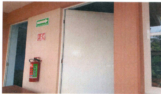
F7: Suministro y colocación de puertas tipo capfice en aulas.
