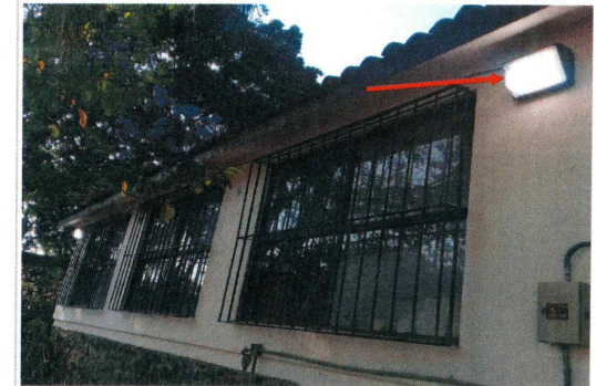
F7: Colocación de reflectores en área exterior.
