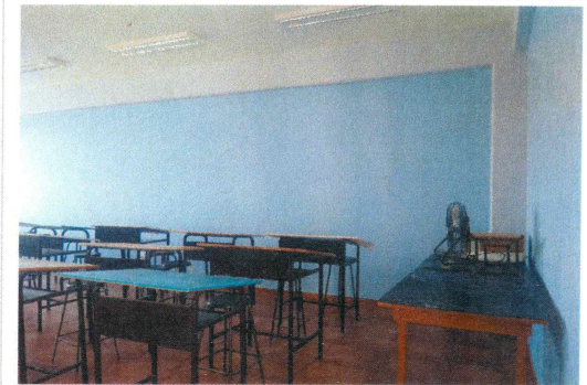
F23: Aplicación de pintura vinílica en aulas
