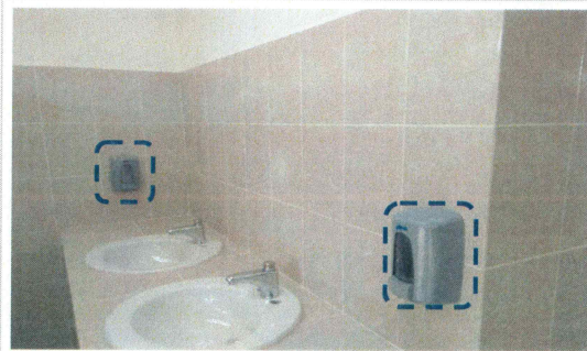
F6: Suministro y colocación de jaboneras en muros de barra da lavabos
