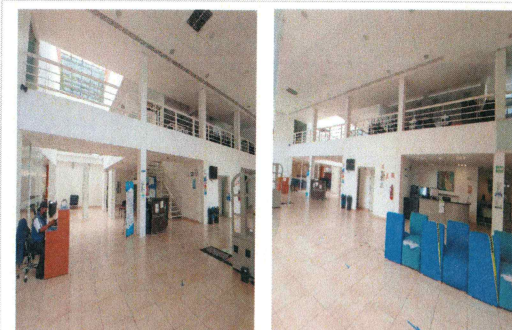
F13: Aplicación de pintura vinilica color blanco sobre muros
