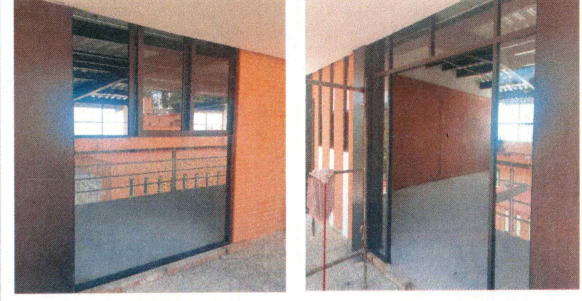
F20: Suministro y colocación de cancelería de aluminio duranodik
