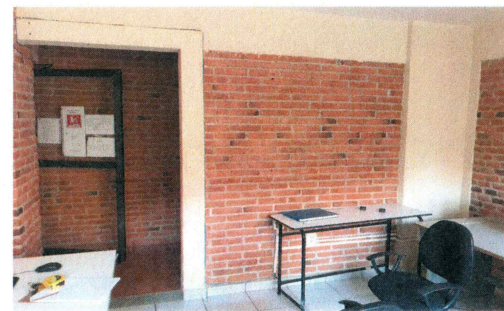
F3: Muro que se demolerá para ampliar biblioteca.
