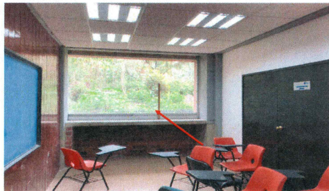
F3.- Colocación de salidad de emergencia
