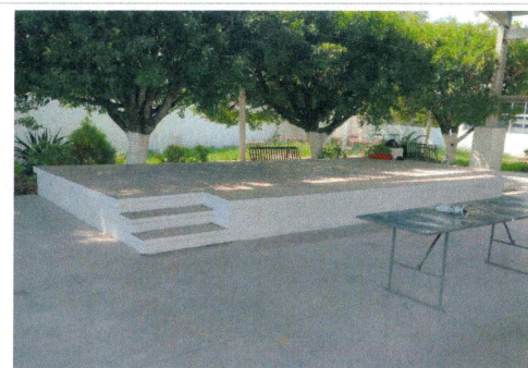
F9: Aplicación de pintura vinílica color blanco en muros de templete.
