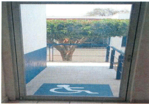
F4: Suministro y aplicación de pintura vinílica en señalética de discapacitados en rampa de auditorio.
