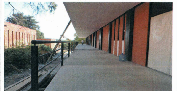
F32: Instalación de barandales de herrería
