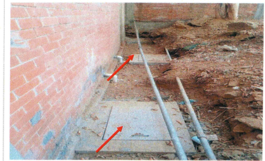
F8: Parte posterior de LOU, Adecuación sanitaria para mesa de laboratorio. Conexión de registros sanitarios y relleno.
