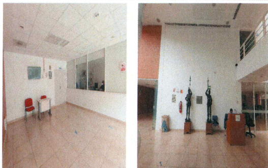
F12: Aplicación de pintura vinilica color blanco sobre muros
