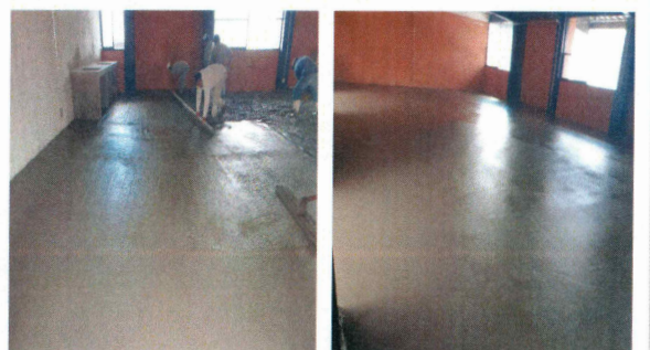
F14: Colado de firmes de concreto premezclado en interior de aulas
