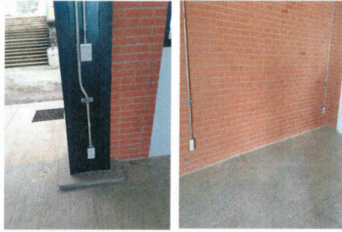
F6: Suministro y colocación de accesorios eléctricos (apagadores y contactos)
