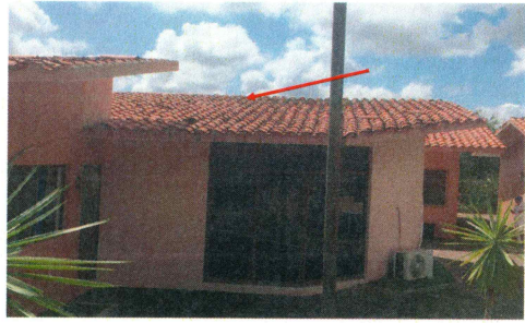
F6: Retiro de teja, chaflanes e impermeabilizante en losa, suministro y colocación de impermeabilizante, teja, fabricación de chaflán. Edificio 06.
