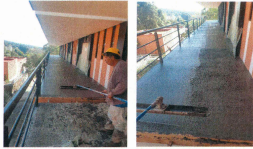
F25: Acabado rayado de firmes de concreto premezclado en pasillos
