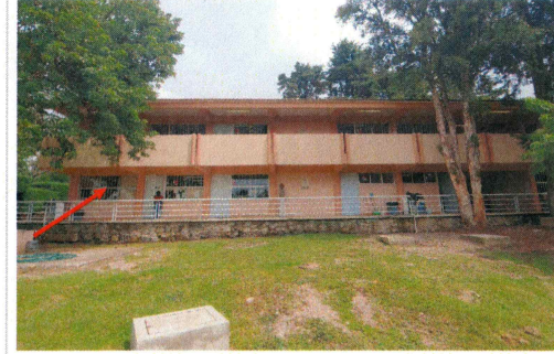
F11: Protecciones de herrería en aulas de Edificio 10.
