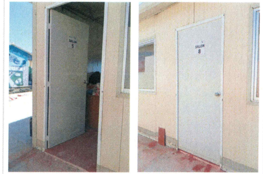
F7: Recolocación de puertas recortadas de acceso a aulas.
