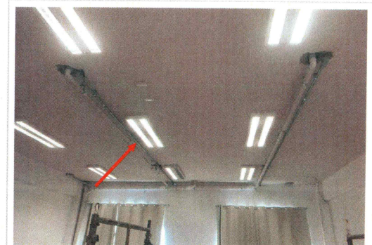
F7: Suministro y colocación de tubería de pvc para instalaciones sanitarias y tubería conduit para instalaciones eléctricas.
