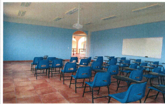
F16: Aplicación de pintura vinilica en aulas
