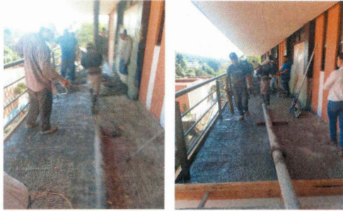
F24: Colado de firmes de concreto premezclado en pasillos
