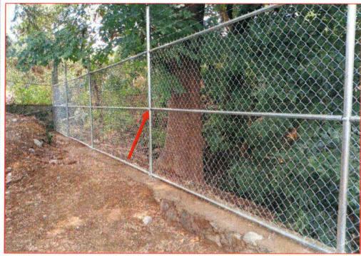
F4: Colocación de malla ciclónica perimetral sobre muro de contención
