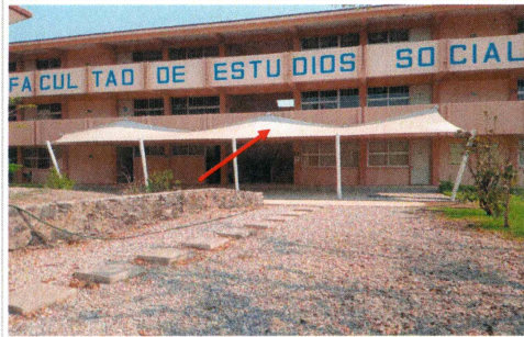
F11: Colocación de velaria.
