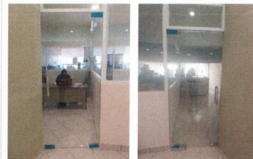
F11: Colocación de puertas de cristal templado
