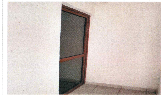
F32: Suministro, Fabricación y colocación de puerta de aluminio en modulo de baño
