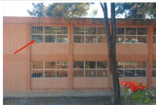
F19: Suministro y colocación de protecciones de herrería en aulas del edificio 10.
