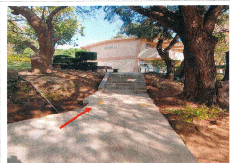
F18: Firme de concreto en acceso principal a Edificio 13.
