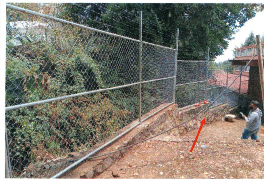
F5: Muro de contención con colocación de malla ciclónica.
