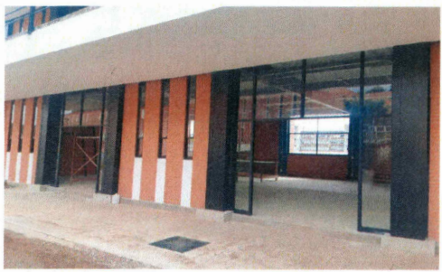
F9: Suministro y colocación de cancelería de aluminio duranodik
