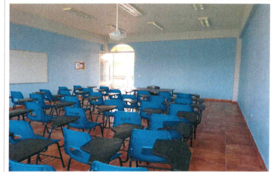
F17: Aplicación de pintura vinilica en aulas
