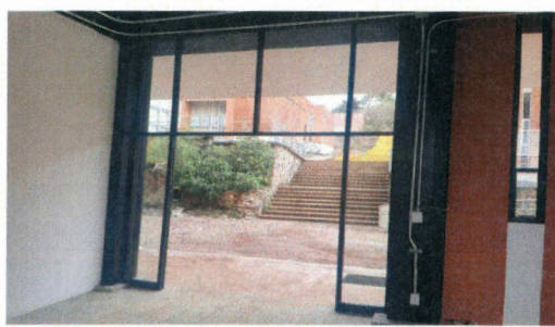
F10: Suministro y colocación de cancelería de aluminio duranodik
