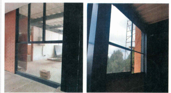
F6: Suministro y colocación de cancelería de aluminio duranodik
