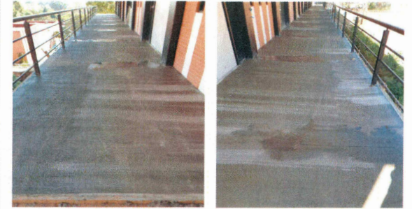
F26: Corte con cortadora sobre pisos rayados de concreto de pasillos
