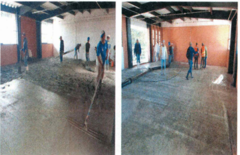
F12: Colado de firmes de concreto premezclado en interior de aulas
