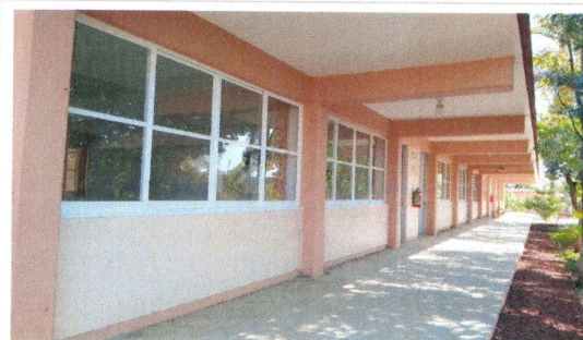
F4: Suministro y colocación de cancelería de aluminio de 2" en edificio 2.
