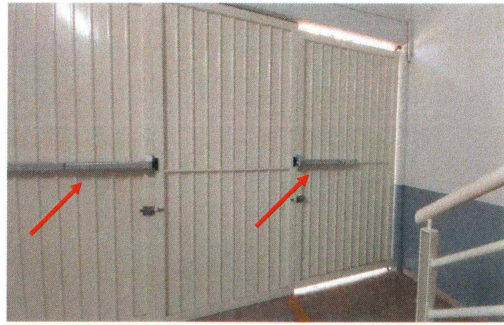
F6: Barras antipánico en puerta de herrería.
