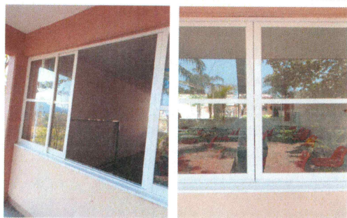
F3: Suministro y colocación de cancelería de aluminio de 2" en edificio 2.
