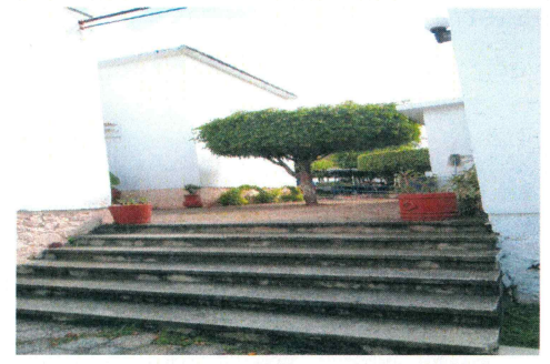
F3: Área de construcción de segunda rampa de acceso a vestibulo de auditorio.
