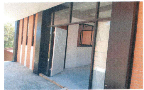
F21: Suministro y colocación de puertas tipo capfce
