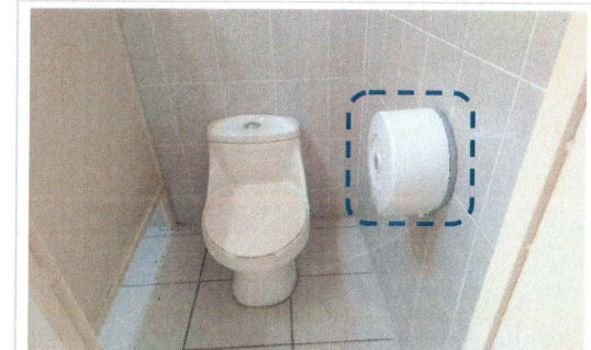
F7: Suministro y colocación de papeleras en sanitarios
