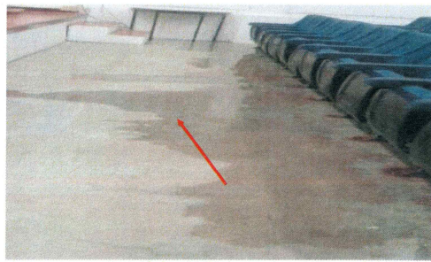
F4: Demolición de concreto, desmoldaje y montaje de butacas, excavación, suministro y colocación de material inerte, membrana plástica, firme, Auditorio.
