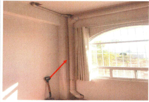
F5: Suministro y colocación de tubería de pvc para instalaciones sanitarias y tubería conduit para instalaciones eléctricas.
