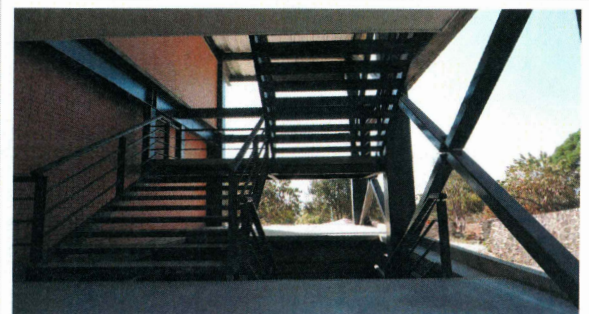
F35: Aplicación de pintura en barandales de escaleras.
