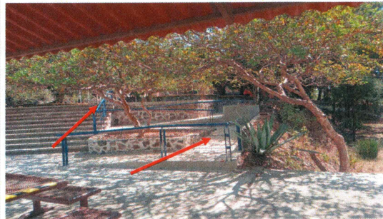
F12: Construcción de rampa, con Colocación de barandal de herrería.
