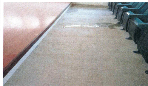
F6: Acabado en piso de concreto de auditorio.
