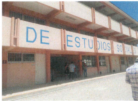
F1: Fachada Principal.
