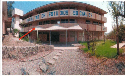
F12: Colocación de velaria.
