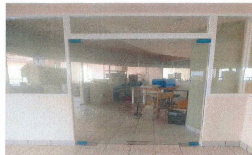
F10: Colocación de puertas de cristal templado
