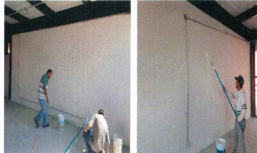
F28: Suministro y aplicación de pintura (segunda mano) en muros
