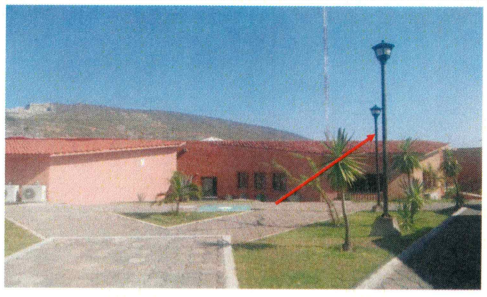
F9: Suministro, colocación y conexión de luminarias exteriores.
