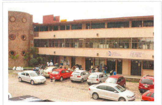
F1: Fachada Principal
