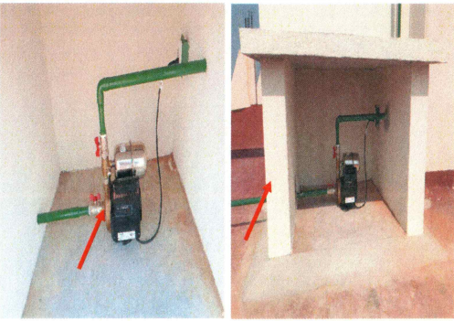
F20: Suministro, colocación y conexión de presurizador y Construcción de nicho.
