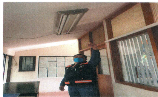
F4: Sustitución de lámparas existentes por luminarias ahorradoras de energía
