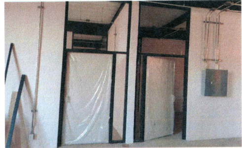
F18: Suministro y colocación de puertas tipo capfce
