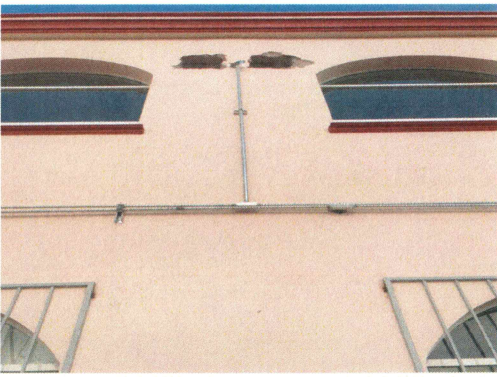
F17: Suministro y colocación de tuberías para instalaciones eléctricas
