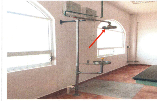
F15: Colocación de regadera mixta con lavajos.
