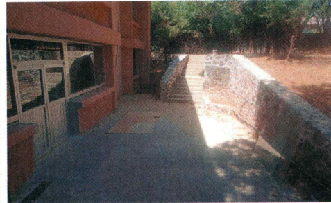
F10 : Construcción de muro de mampostería, firme y escaleras.
