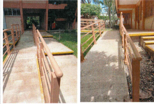
F9: Colocación de barandal de herrería en rampas
