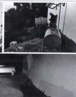
F4: Se retiró el tanque estacionario de diesel de 600 litros que alimenta la planta de emergencia y se instaló el nuevo tanque de la misma capacidad.
