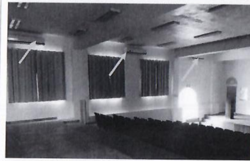
F4: Se equipó con Aire acondicionado el Auditorio planta baja.
