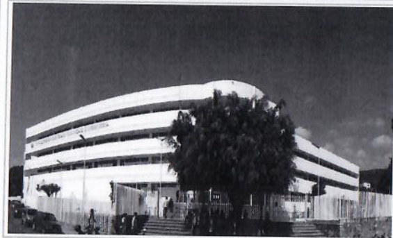
F1: Fachada Principal
