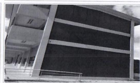
F5: Fachada Lateral (Edificio 72)
