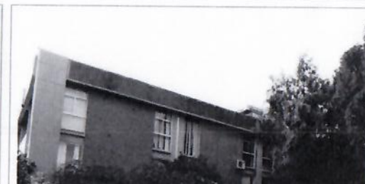
F5: Fachada Lateral
