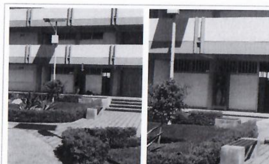
F8: 1 Gabinete industrial, planta baja afuera del baño de hombres edificio A
