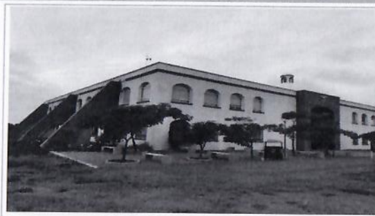
F2: Fachada lateral
