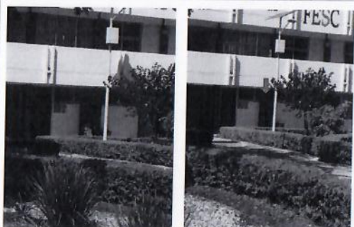
F9: 1 Gabinete industrial, planta baja afuera del baño de hombres edificio B
