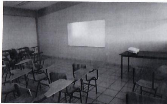
F7: PROYECTOR DE TIRO LARGO: Se colocó en el edificio de INGENIERO EN ROBOTICA Y SISTEMAS DE MANUFACTURA INDUSTRIAL EN EL AULA 3 PLANTA ALTA
