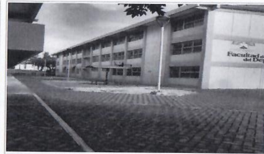
F5: Fachada lateral
