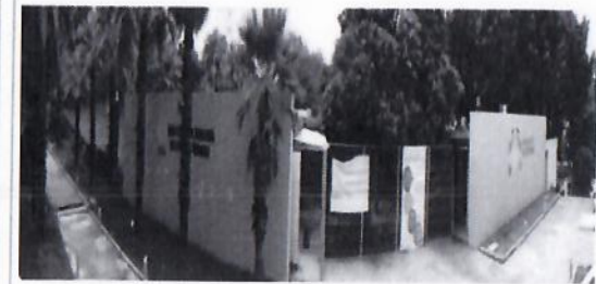
F5: Fachada Lateral
