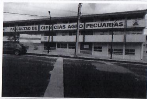
F1: Fachada Principal (Edificio 72)
