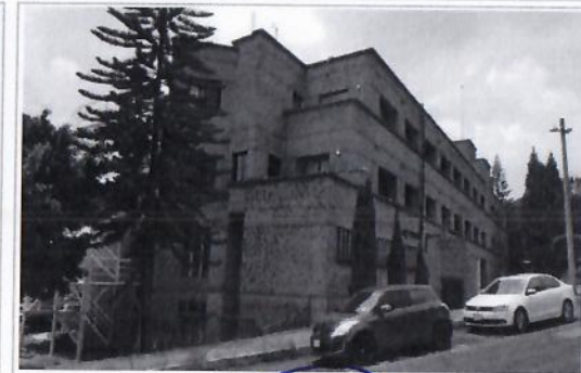
F5: Fachada lateral
