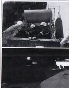
F4: Se retiró el tanque estacionario de diesel de 600 litros que alimenta la planta de emergencia y se instaló el nuevo tanque de la misma capacidad.
