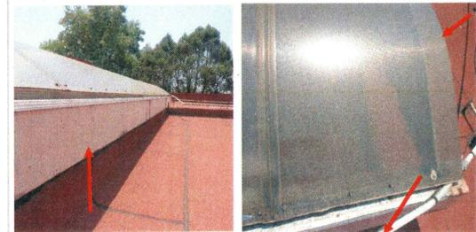
5.- Remates perimetrales de perfil de aluminio, sujeción del perfil de aluminio con monten base y placas de remate de policarbonato.
