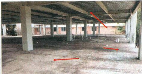
3.- Planta Baja - Se desarrollarán trabajos de construcción de codena perimetral y firme de concreto, colocación de loseta de cerámica, muros divisorios de labiároca, colocación de plafón, instalaciones, cancelería.
