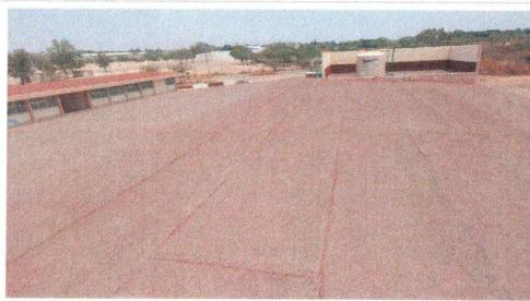
4.- Extremo Este de losa de azotea donde se realizarán los trabajos de mantenimiento al Impermeabilizante existente.
