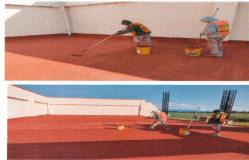
10.- Aplicación de impermeabilizante acrílico en losa de entrepiso
