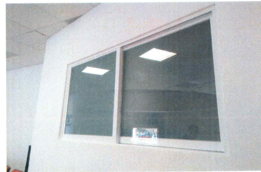
47.- Colocación de ventanas en cuarto de audio y vestidor
