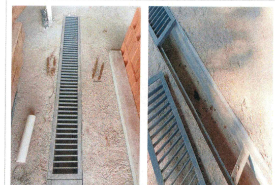
77.- Suministro y colocación de rejillas metálicas en planta baja (Edificio CIB).
