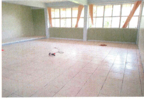
16.- Colocación de piso en aulas de edificio 4.
