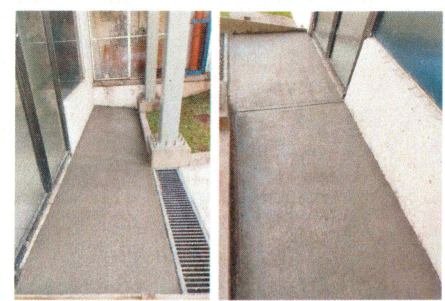
10.- Limpieza fina para entrega de obra.
