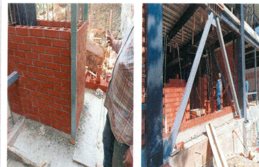
95.- Fabricación de muros divisorios aparentes de vintex (Edificio CIB).
