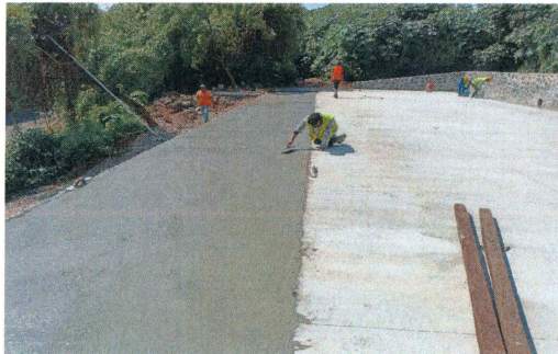
37.- Colado de plataforma con concreto premezclado acabado rayado
