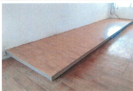
48.- Colocación de piso en sala de juicios orales y salón 9.
