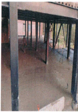
70.- Colado con concreto premezclado de firme de planta baja (Edificio CIB).
