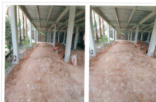
41.- Compactación de material de banco por medios mecánicos (Edificio CIB).
