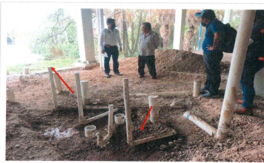
4. Colocación de instalación hidrosanitaria en modulo de baños y laboratorio, rellenos y compactación, firme de concreto, colocación de loseta, fabricación de muros de tabique y vintex, canceleria, colocación de plafón, muebles sanitarios.
