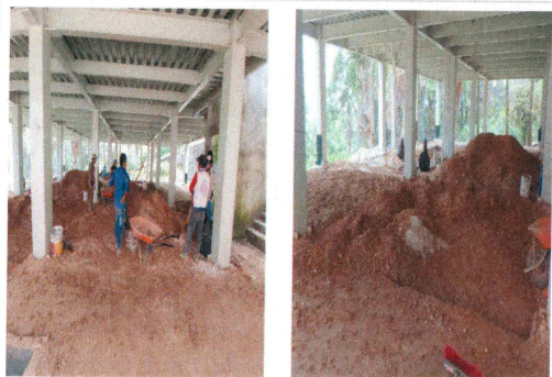
39.- Tendido de material de banco por medios manuales (Edificio CIB).
