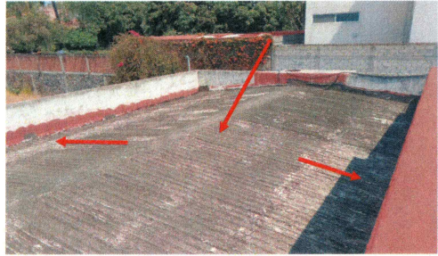
F6.-Vista superior de techumbre metálica y canalón perimetral que se sustituirán.
