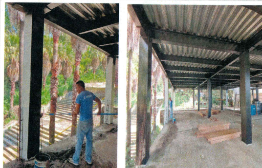
46.- Aplicación de pintura esmalte en estructura metálica (Edificio CIB).
