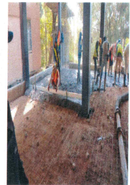
68.- Colado con concreto premezclado de firme de planta baja (Edificio CIB).
