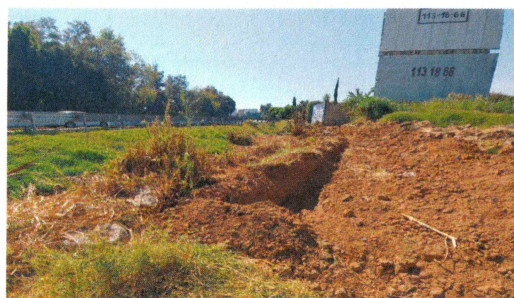
10.- Excavación de terreno para abertura de cepas
