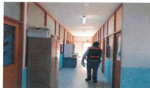
4.- Mantenimiento a red eléctrica: incluyendo colocación de luminarias y separación de circuitos
