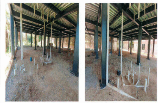
50.- Preparación de tubería de pvc para salidas sanitarias (Edificio CIB).
