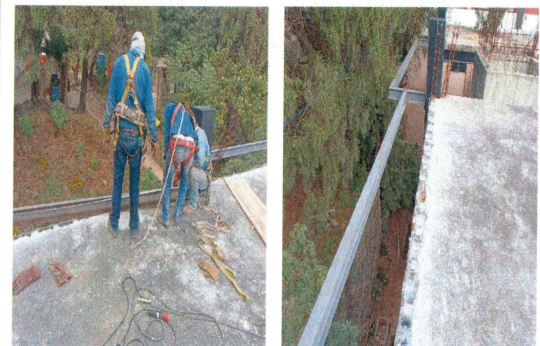
79.- Demolición de losa de concreto existente para anclaje de volados (Edificio CIB).
