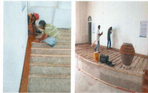
19.- Recolocación de piso de duela reparado en estrado de auditorio
