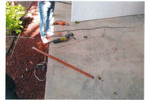
29.- Ajuste de puertas en edificio 2.
