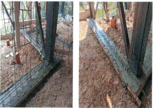
63.- Colado con concreto hecho en obra para cadenas interiores (Edificio CIB).
