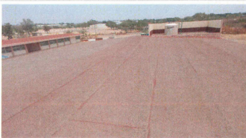
4.- Extremo Este de losa de azotea donde se realizarán los trabajos de mantenimiento al Impermeabilizante existente.
