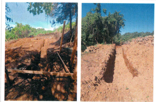
14.- Excavación de ceca por medios mecánicos (Almacén de residuos).
