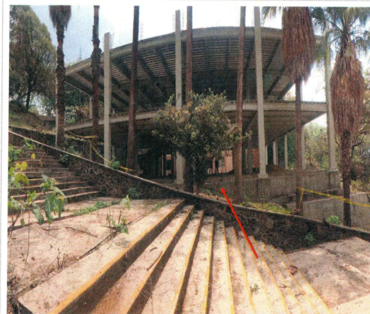
2.- Fachada Oeste - Construcción de la segunda etapa para la ampliación de laboratorios, cubículos de investigación, y oficinas académicas para el Centro de Investigaciones Biológicas antes CEIB [etapa final].
