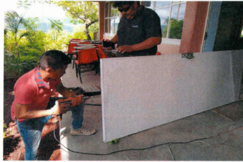
28.- Ajuste de puertas en edificio 2.
