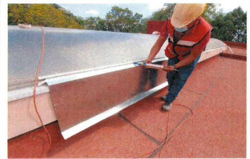
14.- Suministro y colocación de flashing en extremos este y oeste
