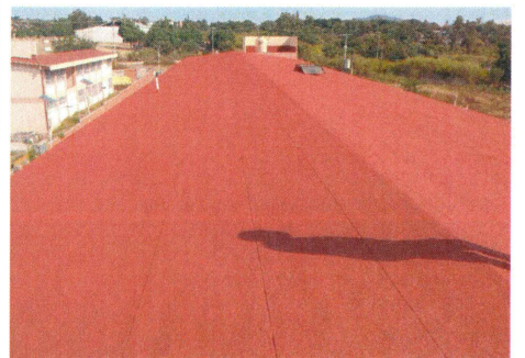
12.- Aplicación de impermeabilizante acrílico en losa de azotea
