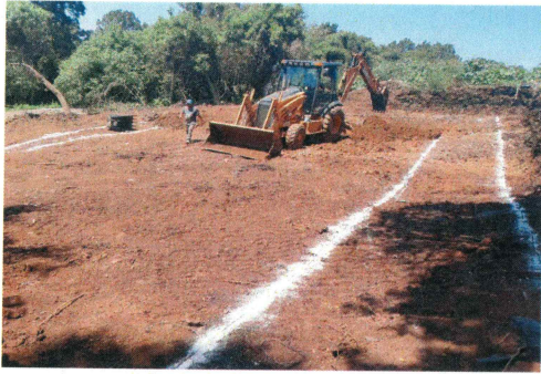
12.- Trazo con cal para delimitar área (Almacén de residuos).
