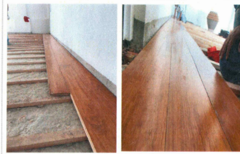
20.- Recolocación de piso de duela reparado en estrado de auditorio
