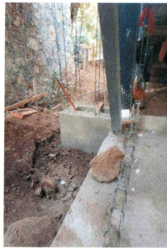
84.- Colado de concreto hecho en obra para ampliación de dados (Edificio CIB).
