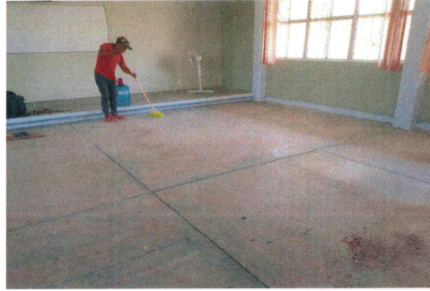
7.- Picoteo de piso en aulas de edificio 4.
