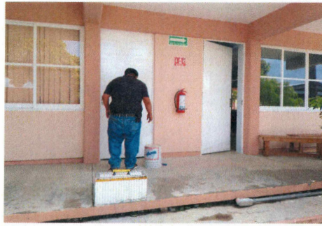
27.- Ajuste de puertas en edificio 2.
