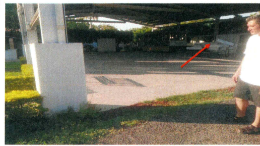
F2: Edificios interiores de la EES de Jojutla
