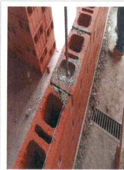
89.- Colado de alveolos con concreto hecho en obra (Edificio CIB).
