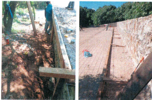
27.- Habilitado de cimbra perimetral (Almacén de residuos).
