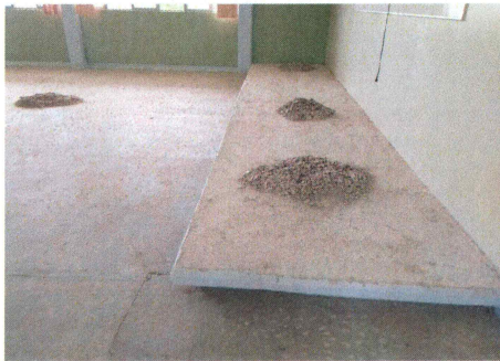
9.- Picoteo de piso en aulas de edificio 4.
