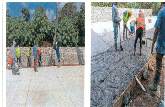
35.- Colado de pasillos de plataforma con concreto premezclado (Almacén de residuos).
