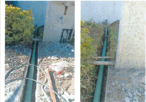
F23: Tendido de tubería de pvc pesado de 1 1/2"
