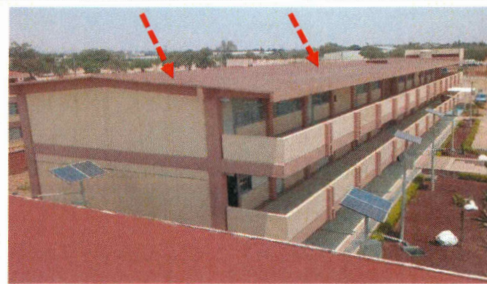
2.- Fachada lateral de edificio donde se realizarán los trabajos
