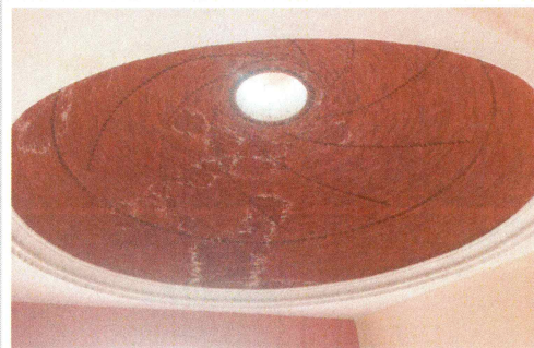
4- Impermeabilización de Azotea y cupula
