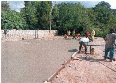
31.- Colado de plataforma con concreto premezclado (Almacén de residuos).
