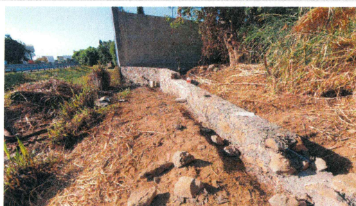
11.- Elaboración de rodapie de piedra de sitio (la piedra se le proporcionó al contratista)
