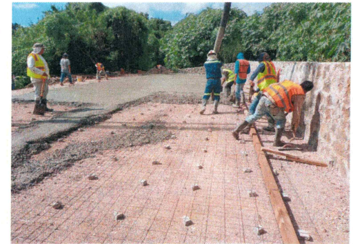
32.- Colado de plataforma con concreto premezclado (Almacén de residuos).
