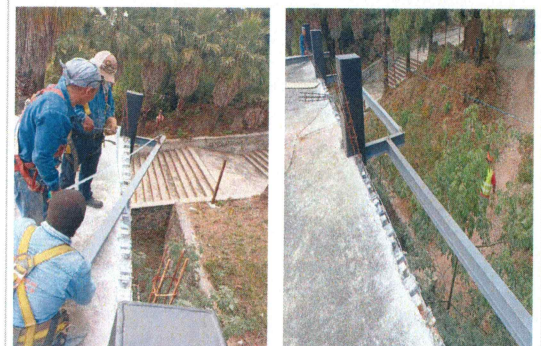
80.- Suministro y colocación de estructura metálica para volados de losa (Edificio CIB).
