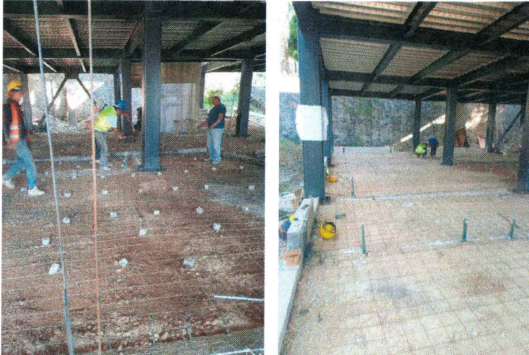
64.- Tendido de malla electrosoldada en planta baja (Edificio CIB).
