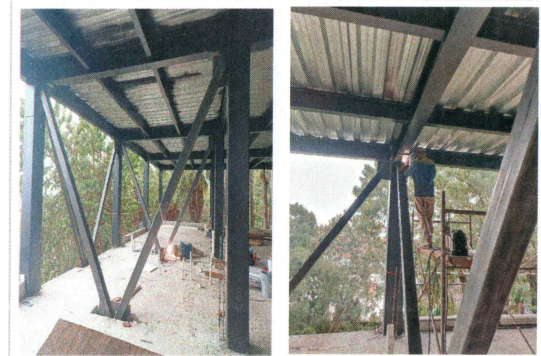
59.- Suministro, colocación y soldadura de contraventeos de acuerdo al dictamen estructural (Edificio CIB).
