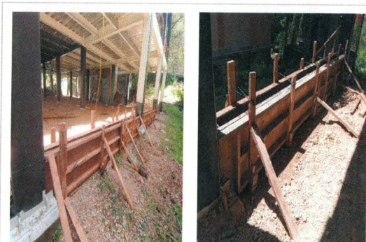
44.- Habilitado de cimbra para cadenas perimetrales en planta baja (Edificio CIB).
