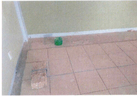
34.- Colocación de piso en aulas de edificio 2.
