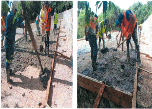
30.- Colado de plataforma con concreto premezclado (Almacén de residuos).
