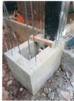
85.- Colado de concreto hecho en obra para ampliación de dados (Edificio CIB).
