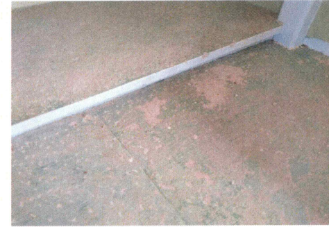
11.- Picoteo de piso en aulas de edificio 4.
