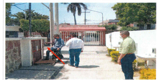
F5: Área de conexión general del sistema de paneles solares.
