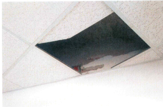
34.- Conexión de circuitos de fuerza y alumbrado de cuarto de audio y vestidor
