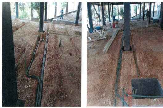
61.- Tendido de tubería de pvc pesado para alimentación eléctrica (Edificio CIB).
