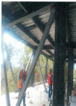
90.- Aplicación de primer en estructura metálica de contraventeos (Edificio CIB).
