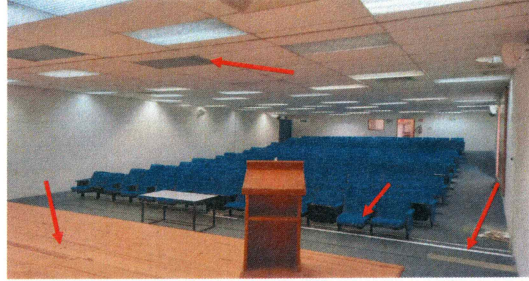
F7.- Interior de auditorio donde se realizaran trabajos de rehabilitación de plafón, cambio de butacas deterioradas, rehabilitación de duela y cambio en un área de alfombra..
