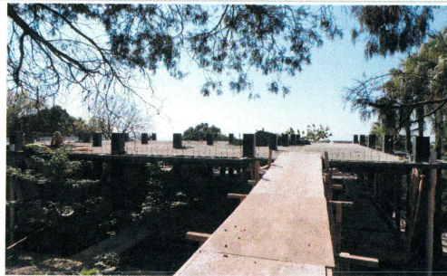
108.- Habilitado de acero, cimbra y colado para amплación de dados de concreto
