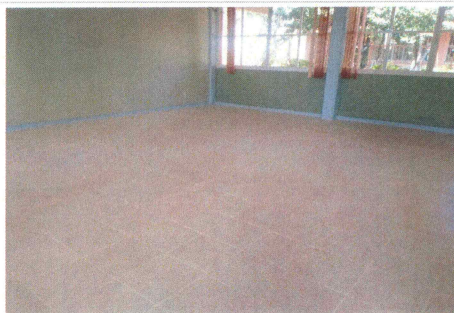
45.- Colocación de piso en aulas de edificio 2.
