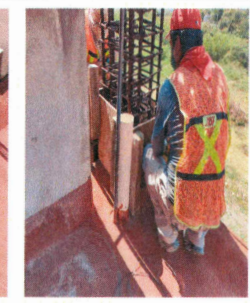
14.- Habilitado de cimbra en base de columnas de losa de entrepiso
