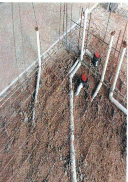
73.- Suministro y colocación de coladeras en área de sanitarios (Edificio CIB).
