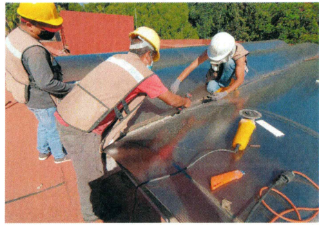
6.- Mantenimiento general a la tornillería de domos existentes.
