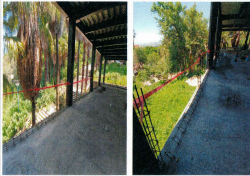
51.- Habilitado de acero para cadenas perimetrales en planta alta (Edificio CIB).
