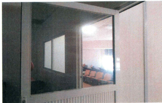
44.- Colocación de puerta de aluminio en cuarto de audio y vestidor
