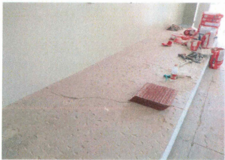
30.- Picoteo de piso en aulas de edificio 2.
