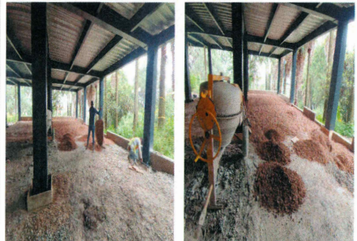
54.- Tendido de material de banco por medios manuales (Edificio CIB).
