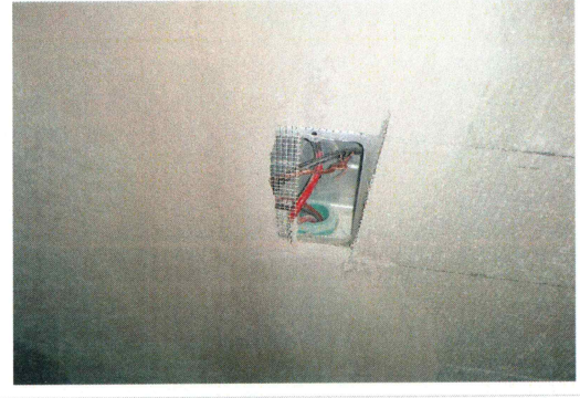
23.- Salidas para contactos en cuarto de audio y vestidor
