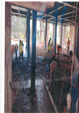
68.- Colado con concreto premezclado de firme de planta baja (Edificio CIB).
