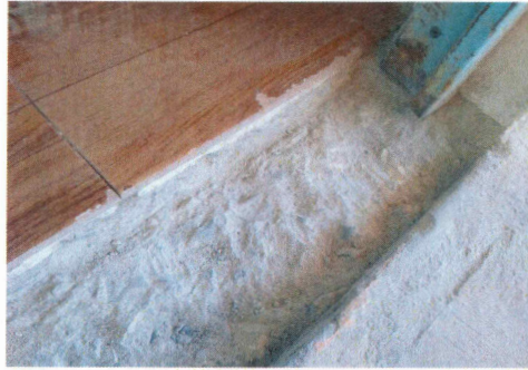
25.- Demolicion de concreto para forjado de canefa.
