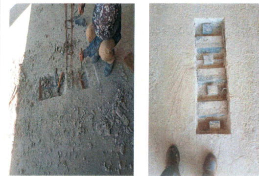
58.- Demolición de firme de concreto para anclaje de contraventeos (Edificio CIB).
