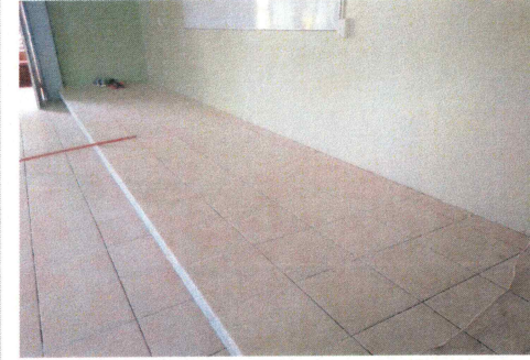
17.- Colocación de piso en aulas de edificio 4.
