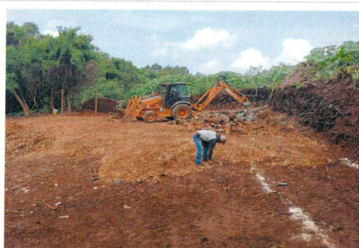
11.- Demolición de piedra por medios mecánicos (Almacén de residuos).
