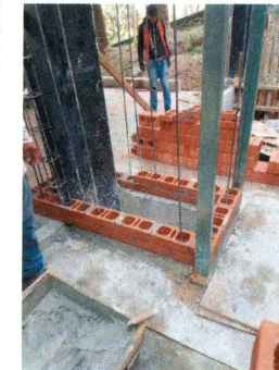
92.- Fabricación de muros aparentes de vintex en ampliación de columnas (Edificio CIB).
