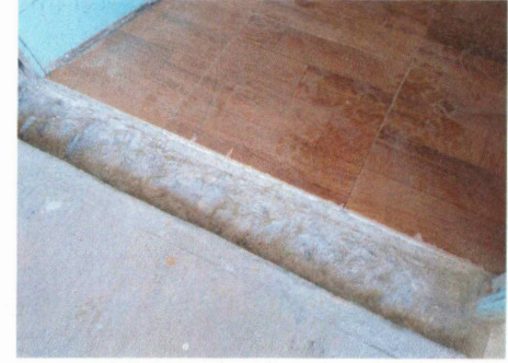
26.- Demolicion de concreto para forjado de canefa.
