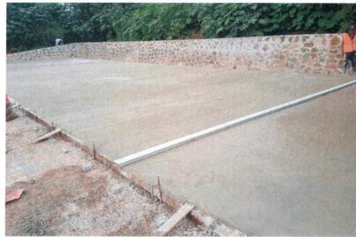
34.- Colado de plataforma con concreto premezclado acabado rayado (Almacén de residuos).
