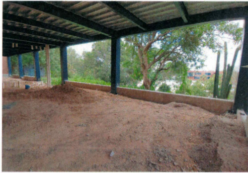
48.- Colado de cadenas perimetrales en planta baja (Edificio CIB).
