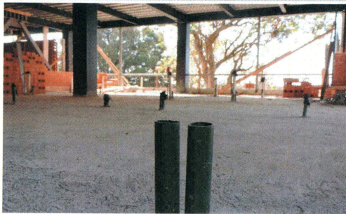
105.- Tendido de tubería de pvc pesado para alimentación eléctrica
