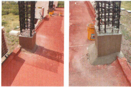
18.- Chuleado con mortero de base de columnas en losa de entrepiso
