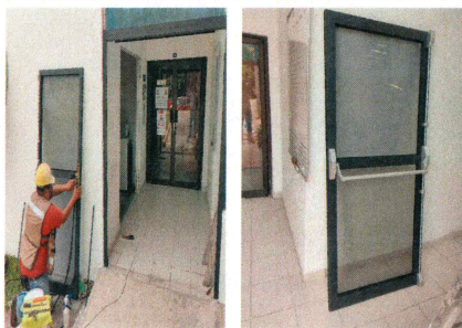
6.- Suministro y colocación de puerta de aluminio con barra antipánico de emergencia.
