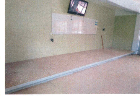
8.- Picoteo de piso en aulas de edificio 4.
