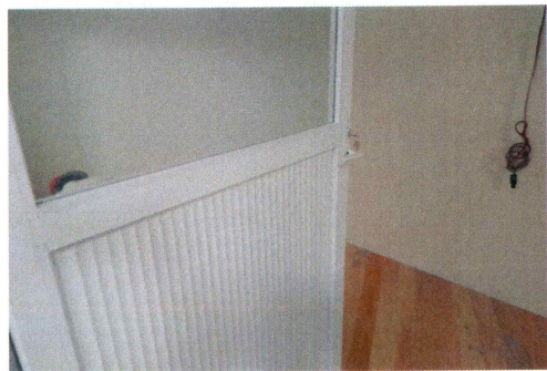
43.- Colocación de puerta de aluminio en cuarto de audio y vestidor
