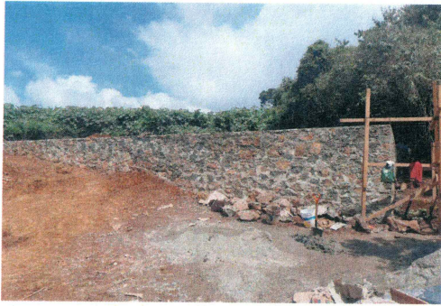
21.- Elaboración de muro de mampostería de piedra de sitio (Almacén de residuos).
