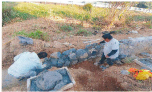
13.- Elaboración de rodaple de piedra de sitio (la piedra se le proporcionó al contratista)
