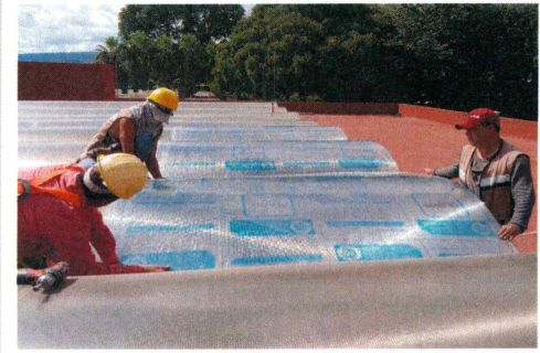
11.- Suministro y colocación de policarbonato por cambio de domos dañados
