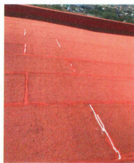
7.- Sellado de juntas abiertas entre tapetes existentes
