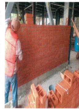
86.- Fabricación de muros divisorios aparentes de vintex (Edificio CIB).
