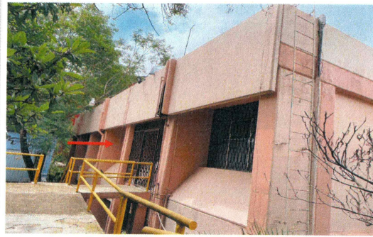
2.- Fachada Norte del Edificio donde se realizaron los trabajos.
