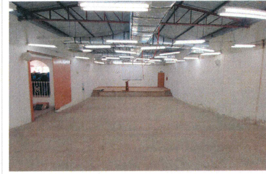
F10: Desmontaje de plafón existente
