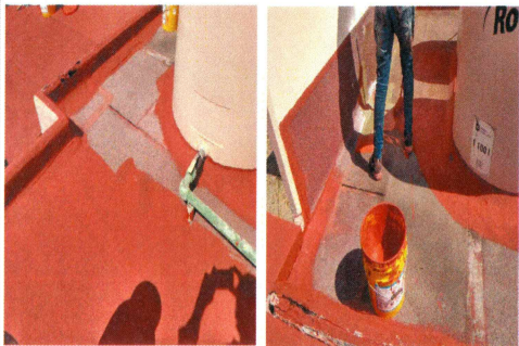
9.- Suministro y aplicación de impermeabilizante acrílico en losa de azotea
