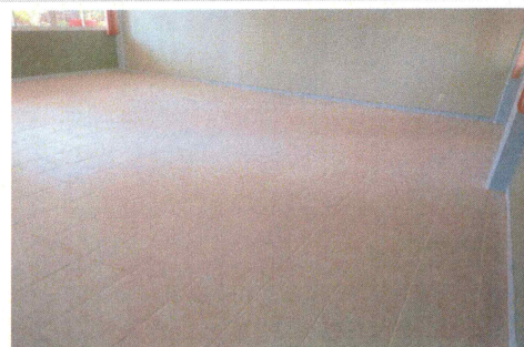
46.- Colocación de piso en aulas de edificio 2.
