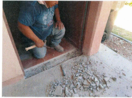
24.- Demolicion de concreto para forjado de canefa.
