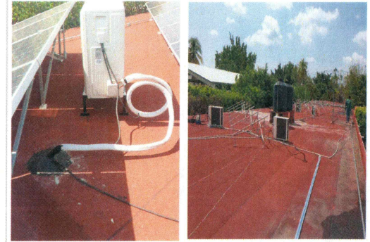
F17: Desmontaje y reubicación de equipos de aire acondicionado
