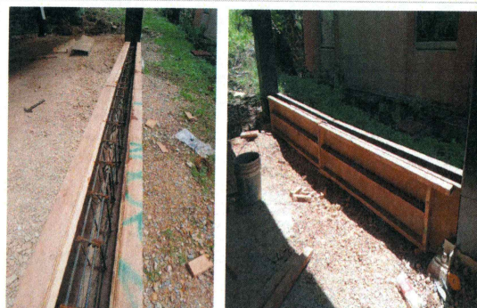
43.- Habilitado de cimbra para cadenas perimetrales en planta baja (Edificio CIB).
