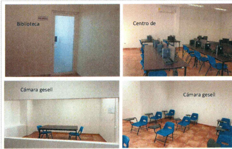
F4: Se ubicarán 2 Aires Acondicionados de 2 TR. en la Cámara de Gesell, 2 Aires Acondicionados en la Biblioteca y 1 Aire Acondicionado en el Centro de Cómputo de la EESMazatepec Subsede Miacatlán.
