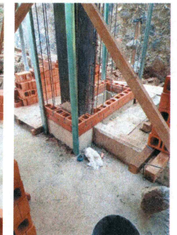
92.- Fabricación de muros aparentes de vintex en ampliación de columnas (Edificio CIB).
