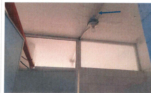
20.- Rehabilitación de apagadores
