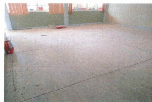
31.- Picoteo de piso en aulas de edificio 2.
