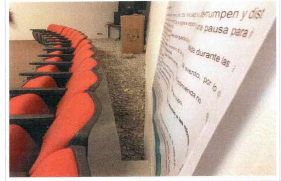
F8: Colocación de cancelería interior y exterior de aluminio así como suministro y colocación de puerta de aluminio
