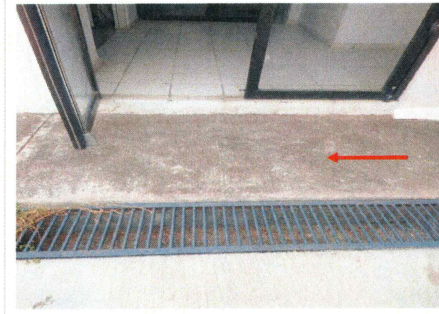
5.- Demolición de firme y construcción de rampa de concreto en salida de emergencia
