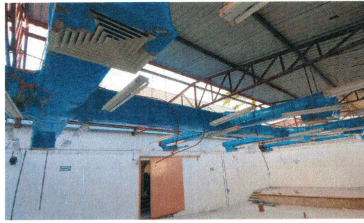
F21: Desmontaje de láminas metálica existentes con recuperación de materiales
