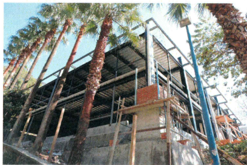
97.- Habilitación de columnas externas.
