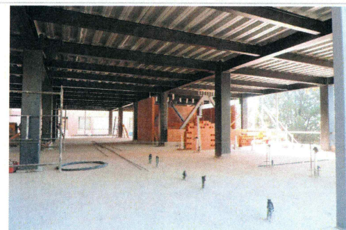
101.- Colado con concreto premezclado de firme de planta baja
