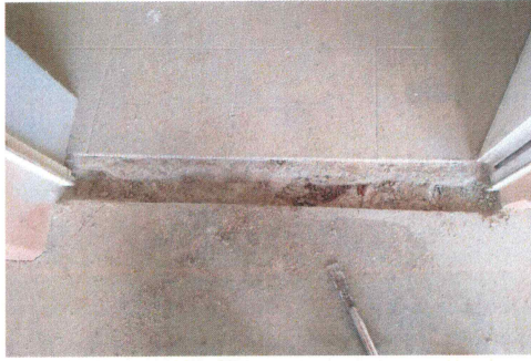
19.- Demolición de concreto para forjado de cancha.
