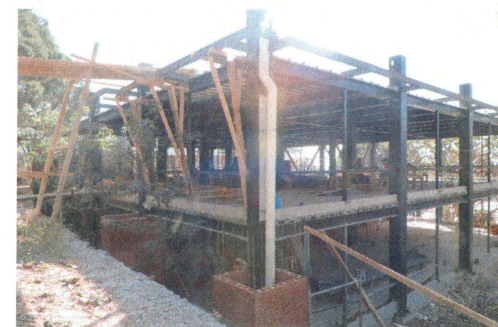
98.- Preparación de tubería de pvc para salidas sanitarias
