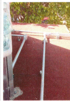
F14: Colocación de condulet tipo LL, LB y LR de 3/4"
