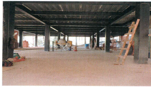
106.- Colado con concreto premezclado de firme de planta baja
