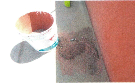
F13.-Limpieza de azotea de auditorio
