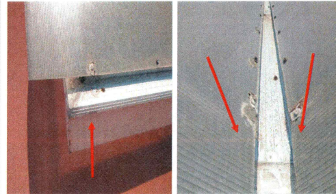
4.- Limpieza y sellado de perfil canaleta, refuerzo en sujeción de tramos longitudinales de placas de policarbonato
