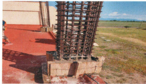
16.- Colado con concreto hecho en obra de base de columnas de losa de entrepiso
