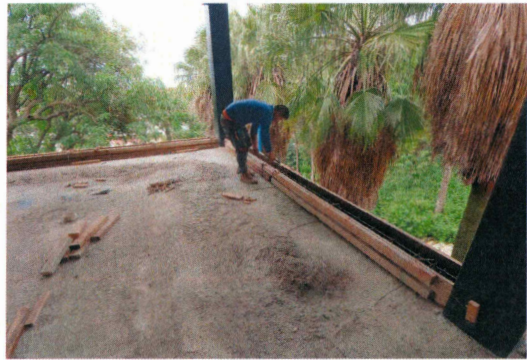
52.- Habilitado de cimbra para cadenas perimetrales en planta alta (Edificio CIB).
