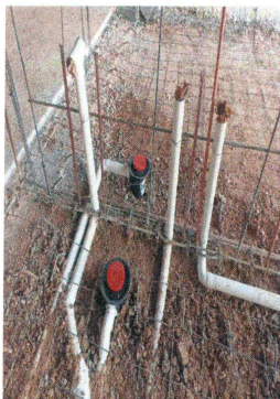
73.- Suministro y colocación de coladeras en área de sanitarios (Edificio CIB).
