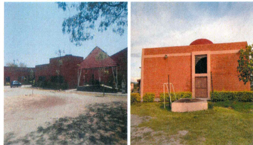
1- Fachada y acceso Principal del plantel, Entrada a Auditorio de la EES del Jicarero
