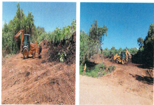
9.- Acarreo en camión de material de composta a nueva ubicación (Almacén de residuos).
