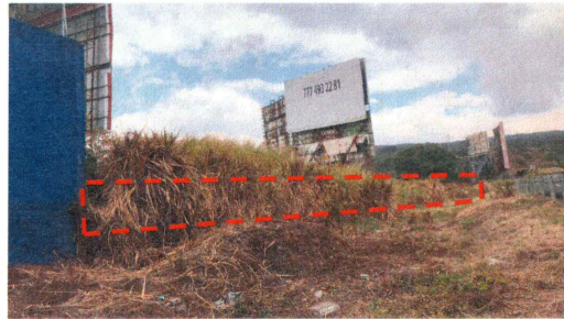
2.- Fachada Este, Mantenimiento en cerca perimetral con Autopista México-Cuernavaca.
