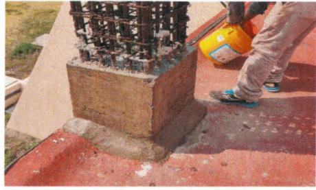
15.-Chuleado con mortero de base de columnas en losa de entrepiso
