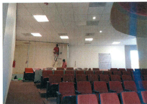
33.- Fabricación de muros de durock para vestidor
