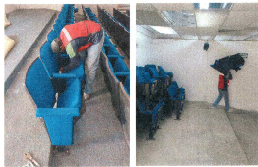
F9: Desmontaje de butacas existentes y acarreo para apile de material.
