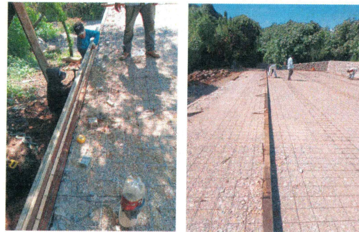
28.- Habilitado de cimbra perimetral (Almacén de residuos).
