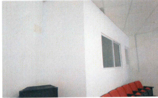
41.- Aplicación de pintura en muros de cuarto de audio
