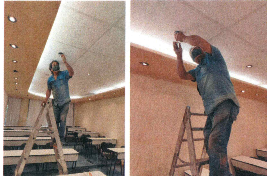
7.- Reemplazo de focos fundidos en auditorio
