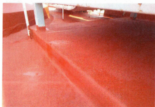
52.- Aplicación de impermeabilizante acrílico en azotea de auditorio
