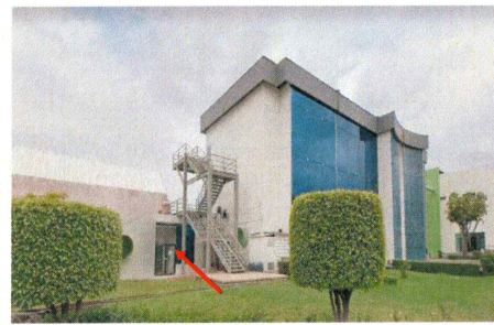
2.- Fachada lateral CIQ. Puerta de emergencia.
