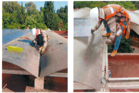
7.- Desmontaje de policarbonato dañado
