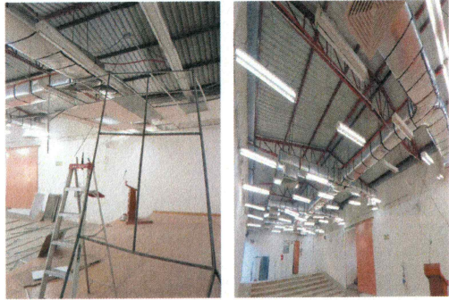
F14: Desmontaje de lámparas existentes con recuperación
