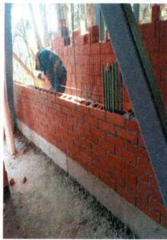
87.- Fabricación de muros divisorios aparentes de vintex (Edificio CIB).
