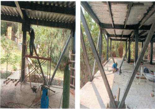
60.- Suministro, colocación y soldadura de contraventeos de acuerdo al dictamen estructural (Edificio CIB).
