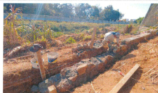
12.- Elaboración de rodapie de piedra de sitio (la piedra se le proporcionó al contratista)
