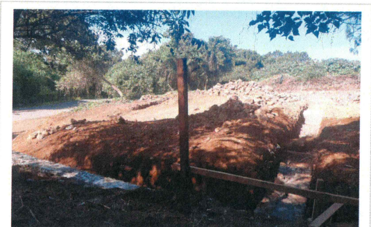
17.- Colado de plantilla con concreto hecho en obra (Almacén de residuos).
