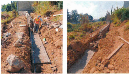
14.- Colado de plantilla de concreto hecho en obra
