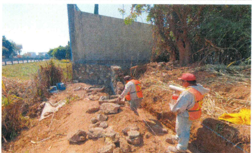
12.- Elaboración de rodapie de piedra de sitio (la piedra se le proporcionó al contratista)
