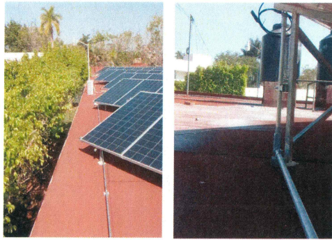
F15: Tendido de tubería galvanizada de 3/4" para instalación de paneles fotovoltaicos
