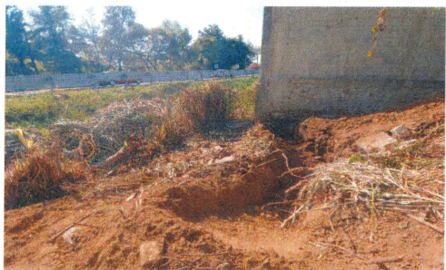
9.- Excavación de terreno para abertura de cepas
