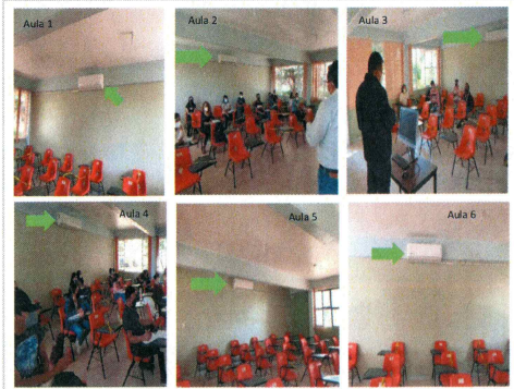
F9: 10 Aires Acondicionados de 2 tr se colocaran en Aula 1, 2, 3, 4, 5, 6, 7, 8, 9 y Biblioteca de la EESMazatepec.
