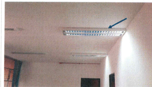
17.- Suministro y colocación de luminarias en cubículos
