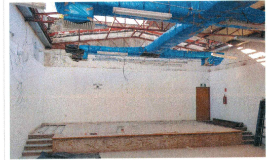
F19: Desmontaje de láminas metálicas existentes con recuperación de materiales
