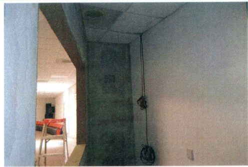
F18.- Fabricación de muros de durock para cuarto de audio
