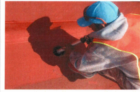
8.- Aplicación de sellador en coladeras de losa de entrepiso y azotea
