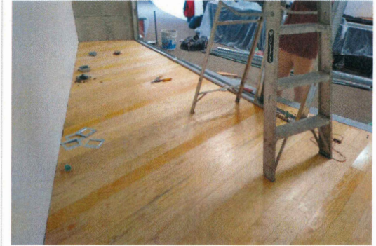
29.- Suministro y colocación de duela en vestidor
