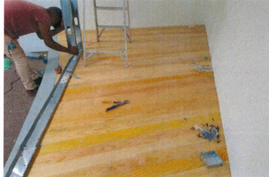
28.- Suministro y colocación de duela en vestidor
