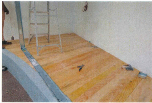
27.- Suministro y colocación de duela en vestidor
