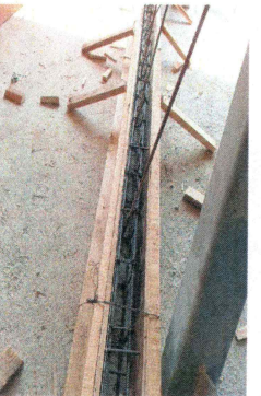
72.- Habilitado de acero y cimbra de cadenas interiores en planta alta (Edificio CIB).
