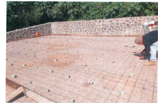
29.- Suministro y tendido de malla electrosoldada (Almacén de residuos).
