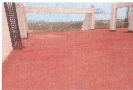
3- Impermeabilización de Azotea.
