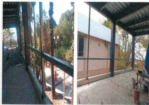
75.- Suministro y colocación de ptr para refuerzos de cancelería de aluminio (Edificio CIB).
