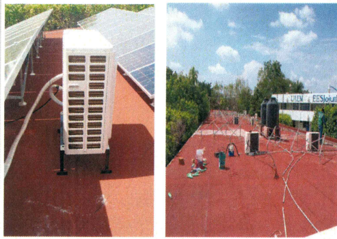
F18: Desmontaje y reubicación de equipos de aire acondicionado
