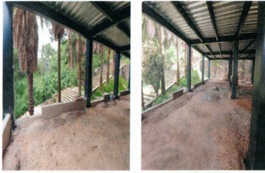
49.- Colado de cadenas perimetrales en planta baja (Edificio CIB).
