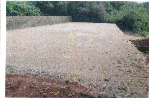
26.- Tendido y compactación de material de banco por medios mecánicos (Almacén de residuos).
