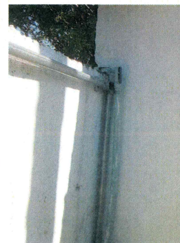
F13: Colocación de condulet tipo LL, LB y LR de 1 1/2"
