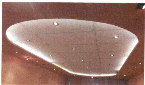
15.- Reemplazo de focos fundidos en auditorio
