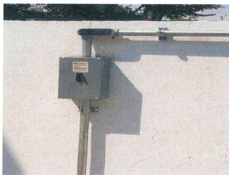
F24: Suministro y colocación de tablero de interconexión de sistema fotovoltaico
