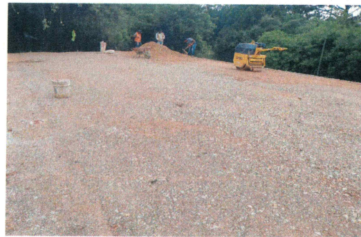
25.- Tendido y compactación de material de banco por medios mecánicos (Almacén de residuos).
