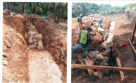
16.- Colado de plantilla con concreto hecho en obra (Almacén de residuos).
