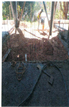
66.- Relleno y compactación por medios mecánicos en área de sanitarios de planta baja (Edificio CIB).
