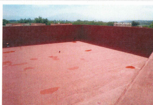
55.- Aplicación de impermeabilizante acrílico en azotea de auditorio
