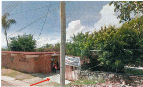
1.- Fachada principal E.E.S. Mazatepec
