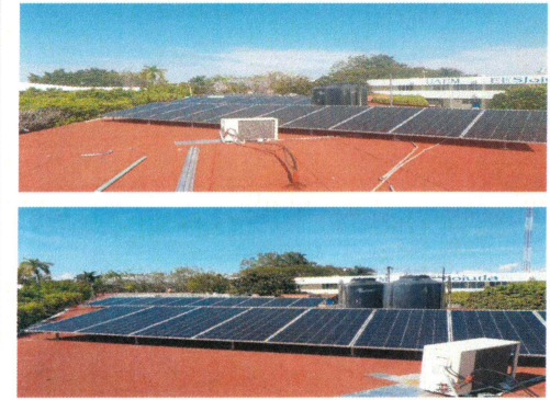
F20: Suministro y colocación de paneles fotovoltaicos
