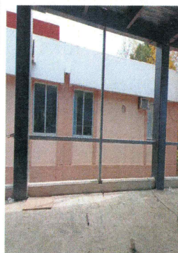
74.- Suministro y colocación de ptr para refuerzos de cancelería de aluminio (Edificio CIB).
