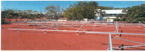
F7: Suministro y colocación de bases metálicas de soporte para paneles fotovoltaicos
