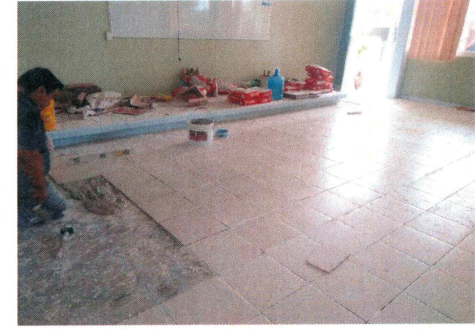
35.- Colocación de piso en aulas de edificio 2.
