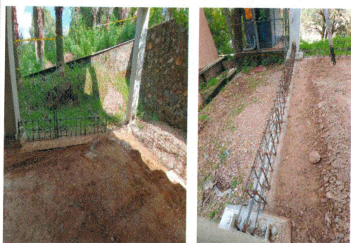
42.- Habilitado de acero para cadenas perimetrales en planta baja (Edificio CIB).
