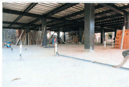
99.- Colado con concreto premezclado de firme de planta baja
