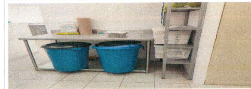
F32: 3 MESAS DE ACERO INOXIDABLE CON ZOCLO Y REPISA LABORATORIO DE ENFERMERIA QURÓFANO (AREA CEYE) EDIFICIO 15
