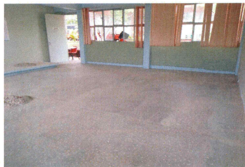
10.- Picoteo de piso en aulas de edificio 4.
