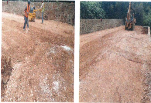
24.- Tendido y compactación de material de banco por medios mecánicos (Almacén de residuos).
