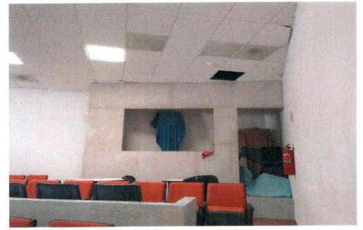
F20.- Fabricación de muros de durock para cuarto de audio
