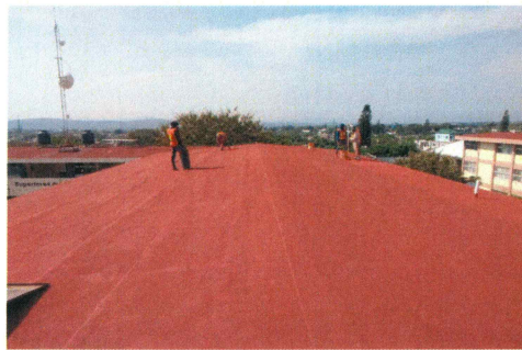
7.- Suministro y aplicación de impermeabilizante acrílico en losa de azotea
