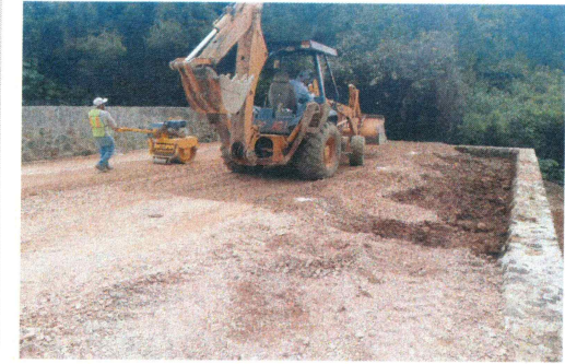
23.- Suministro y tendido de material de banco por medios mecánicos (Almacén de residuos).
