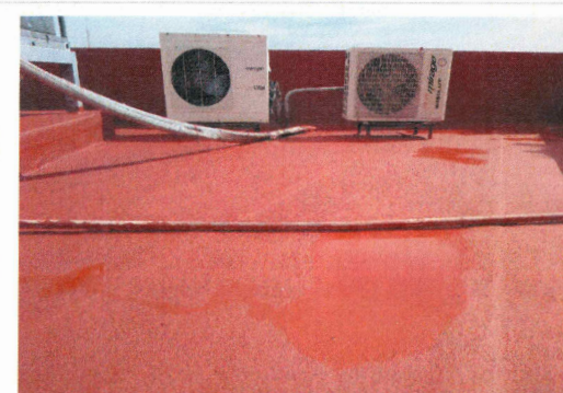
56.- Aplicación de impermeabilizante acrílico en azotea de auditorio
