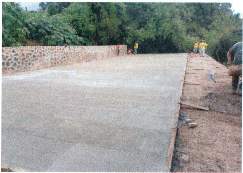
33.- Colado de plataforma con concreto premezclado acabado rayado (Almacén de residuos).
