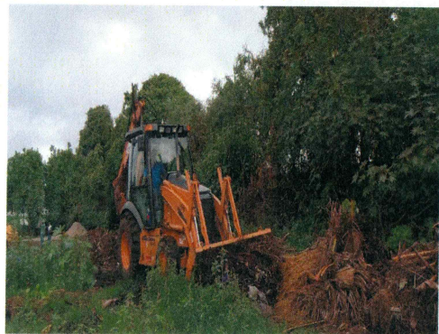
6.- Deshierbe de terreno natural (Almacén de residuos).
