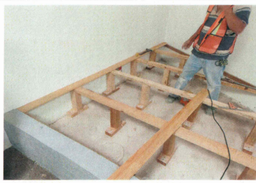
25.- Suministro y colocación de duela en vestidor
