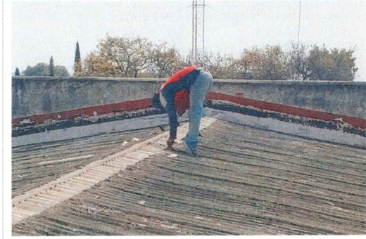
F13: Desmantelamiento de impermeabilizante existente
