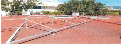
F6: Suministro y colocación de bases metálicas de soporte para paneles fotovoltaicos
