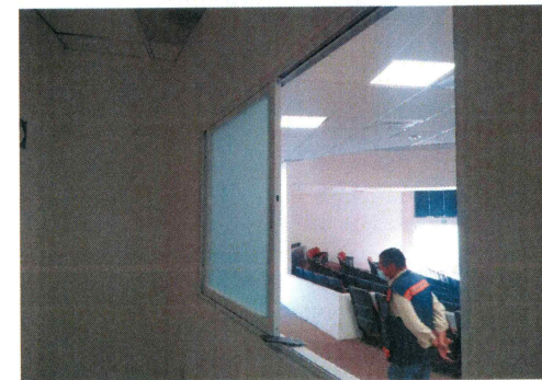
46.- Colocación de ventanas en cuarto de audio y vestidor
