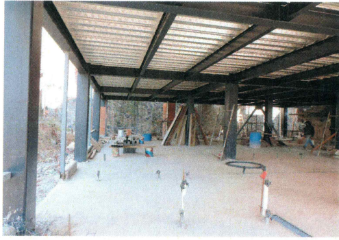
102.- Suministro y colocación de coladeras en área de sanitarios (Edificio CIB).
