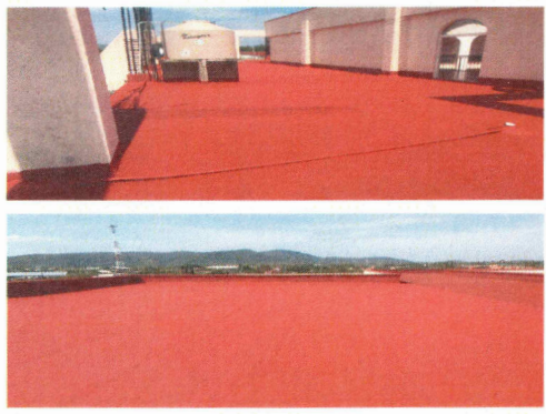
29.- Conclusión de aplicación de impermeabilizante acrílico en losa de azotea.
