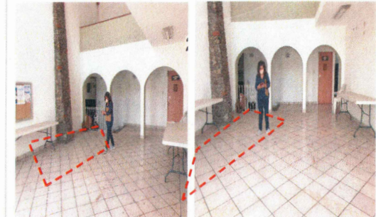
F5: Edificación de rampa en el vestíbulo de acceso a Auditorio del CITPsi, Unidad Los Volcanes.
