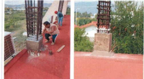
17.- Descimbrado de base de columnas de losa de entrepiso
