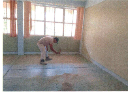
6.- Picoteo de piso en aulas de edificio 4.
