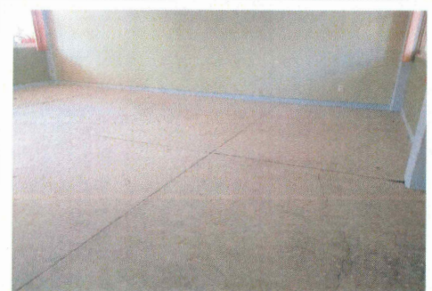
32.- Picoteo de piso en aulas de edificio 2.
