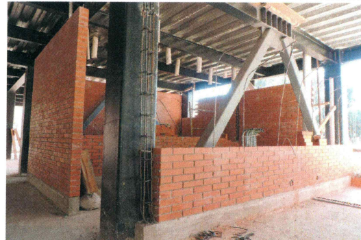
103.- Fabricación de muros divisorios aparentes de vintex
