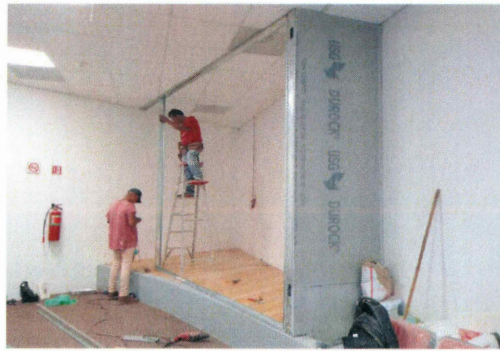
30.- Fabricación de muros de durock para vestidor
