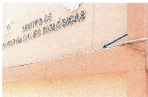
12.- Alimentación eléctrica para bombas de agua
