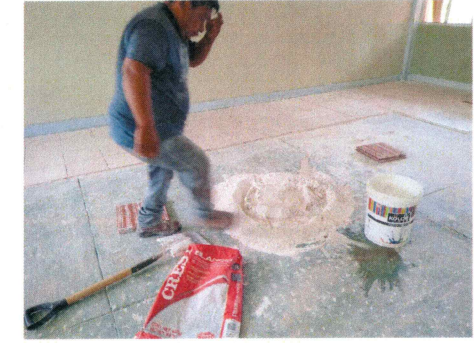
14.- Colocación de piso en aulas de edificio 4.
