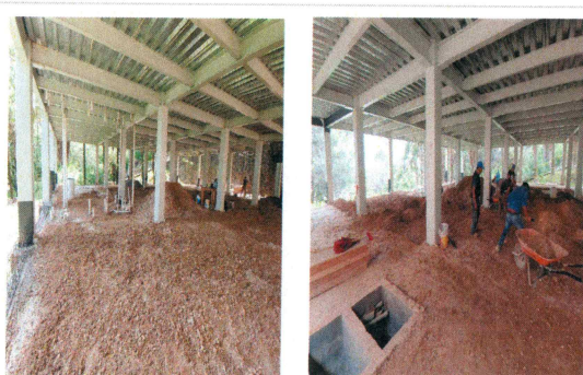
40.- Tendido de material de banco por medios manuales (Edificio CIB).
