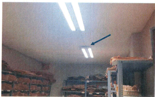
18.- Suministro y colocación de luminarias en cubículos
