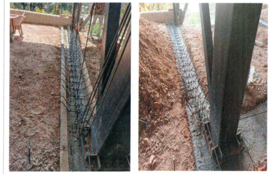
62.- Habilitado de acero y cimbra para cadenas interiores (Edificio CIB).
