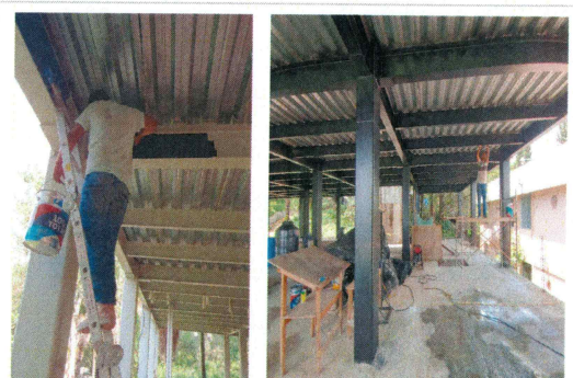
44.- Habilitado de cimbra para cadenas perimetrales en planta baja (Edificio CIB).
