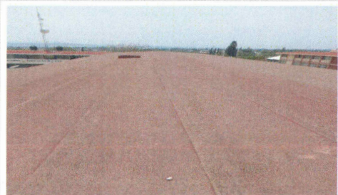
3.- Mantenimiento al Impermeabilizante del Edificio de la Unidad Académica.
