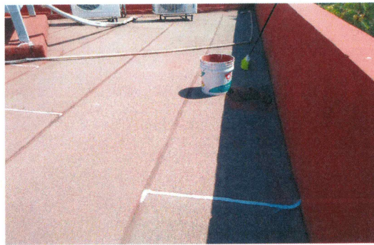
F16.-Sellado de carpeta existente
