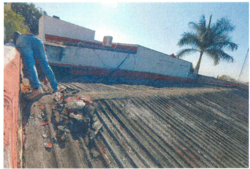
F11: Desmantelamiento de impermeabilizante existente
