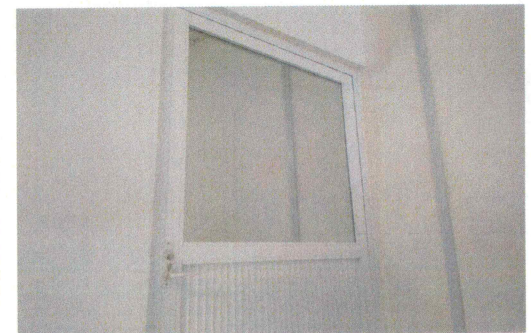
45.- Colocación de puerta de aluminio en cuarto de audio y vestidor
