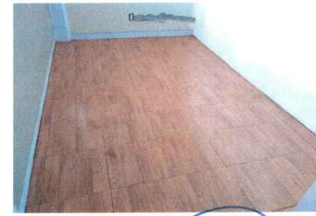
50.- Colocación de piso en sala de juicios orales y salón 9.
