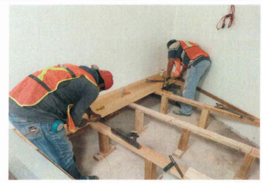
26.- Suministro y colocación de duela en vestidor
