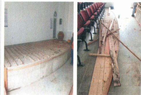
23.- Desmontaje de piso de duela existente para realizar repación de estrado de auditorio
