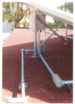
F14: Colocación de condulet tipo LL, LB y LR de 3/4"
