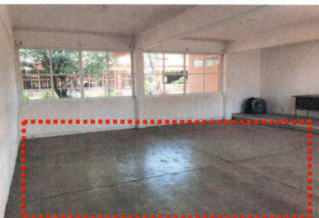
3.- Interior de Aula tipo - Se realizaran trabajos de colocación de loseta.
