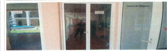
F5: Se ubicaran 11 mesas en el Centro de Cómputo de la EES Mazatepec subside Tetecala.
