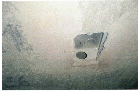
22.- Salidas para contactos en cuarto de audio y vestidor
