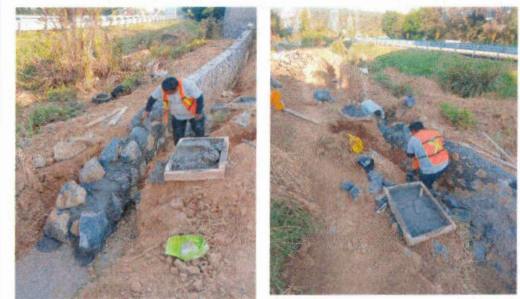
15.- Elaboración de rodaple de piedra de sitio (la piedra se le proporcionó al contratista)
