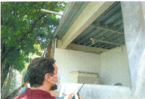
F12.-Suministro y colocación de cancel en edificio de laboratorios
