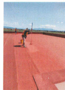
12.- Aplicación de impermeabilizante acrílico en losa de azotea
