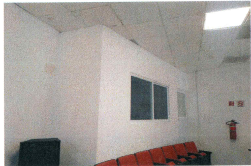
40.- Aplicación de pintura en muros de cuarto de audio
