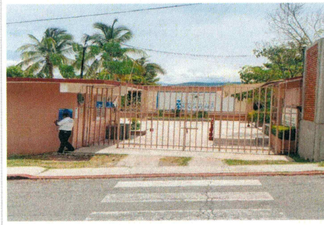
F1: Fachada principal EESMazatepec.
