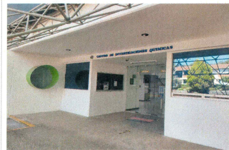
13.- Suministro y aplicación de pintura vilca color blanco sobre muros.
