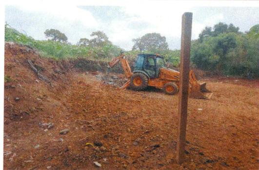
10.- Demolición de piedra por medios mecánicos (Almacén de residuos).
