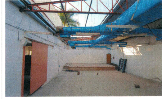
F22: Desmontaje de láminas metálica existentes con recuperación de materiales
