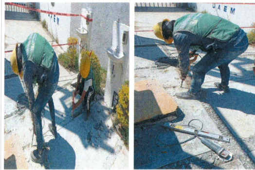
F22: Demolición de firme de concreto existente
