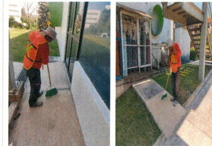
11.- Adecuación en piso de la puerta de emergencia.
