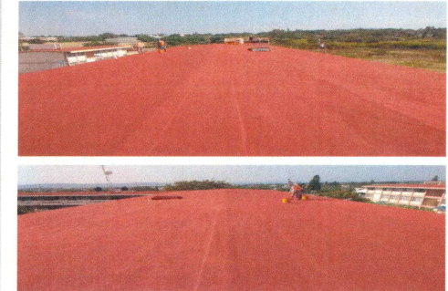
8.- Suministro y aplicación de impermeabilizante acrílico en losa de azotea
