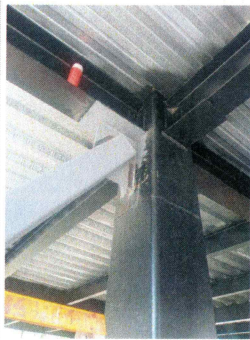
90.- Aplicación de primer en estructura metálica de contraventeos (Edificio CIB).
