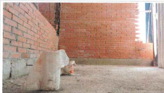
109.- Suministro y colocación de coladeras en área de sanitarios (Edificio CIB).
