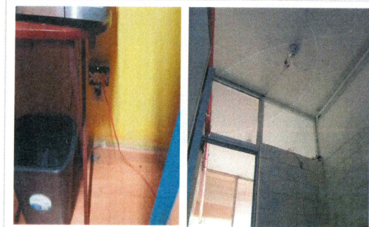
5.- Rehabilitación de contactos, apagadores y luminarias.
