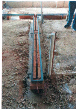
67.- Suministro y colocación de marcos de herrería para rejillas (Edificio CIB).
