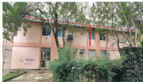
2.- Fachada lateral Este del CINCCO.
