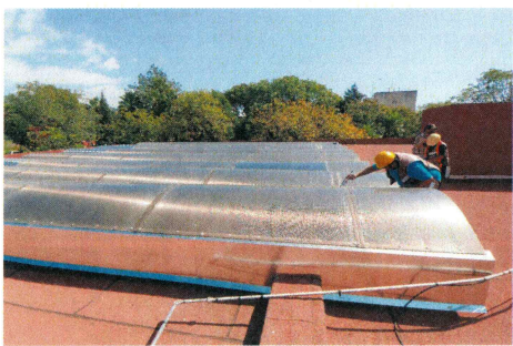
12.- Sellado de juntas de policarbonato existente
