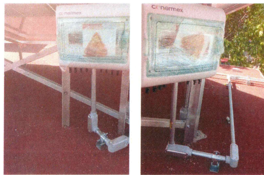
F16: Suministro y colocación de cajas combinadoras de paneles fotovoltaicos
