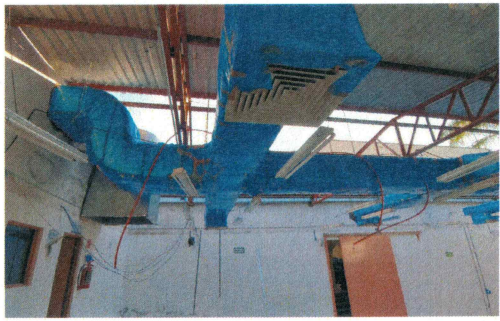
F20: Desmontaje de láminas metálica existentes con recuperación de materiales
