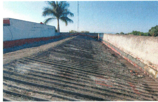
F12: Desmantelamiento de impermeabilizante existente
