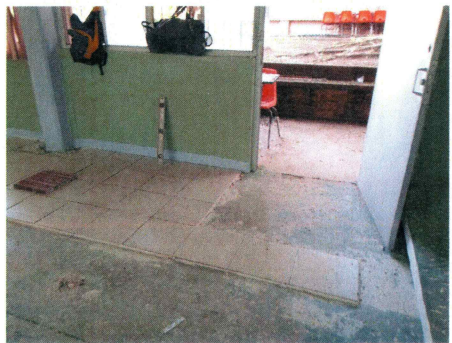
12.- Colocación de piso en aulas de edificio 4.
