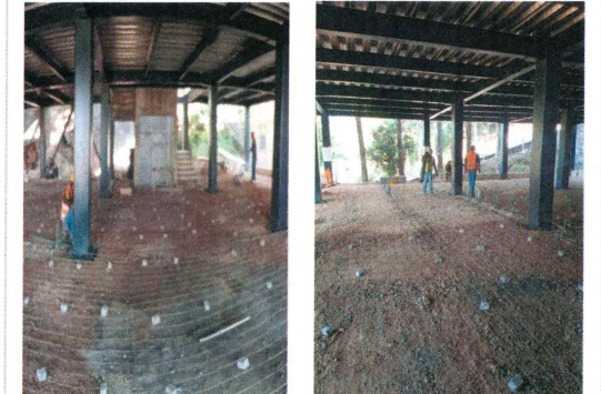
65.- Tendido de malla electrosoldada en planta baja (Edificio CIB).
