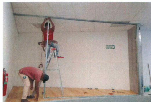
31.- Fabricación de muros de durock para vestidor
