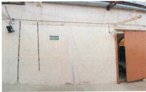
F17: Ranurado de muro para colocación de tuberías eléctricas
