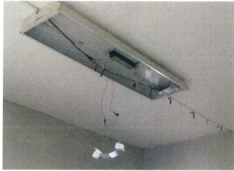
6.- Suministro y colocación de luminarias en cuclucos
