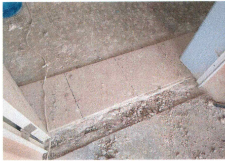
18.- Demolición de concreto para forjado de cancha.
