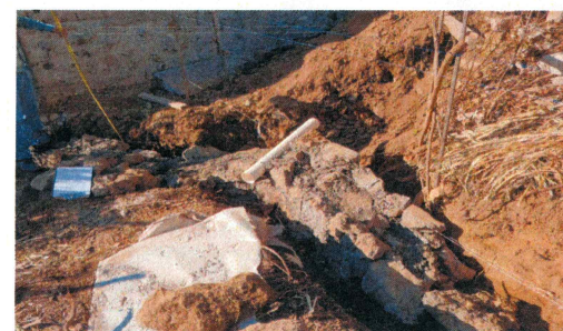
11.- Elaboración de rodapie de piedra de sitio (la piedra se le proporcionó al contratista)
