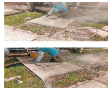
8.- Corte con cortadora manual en concreto dañado.
