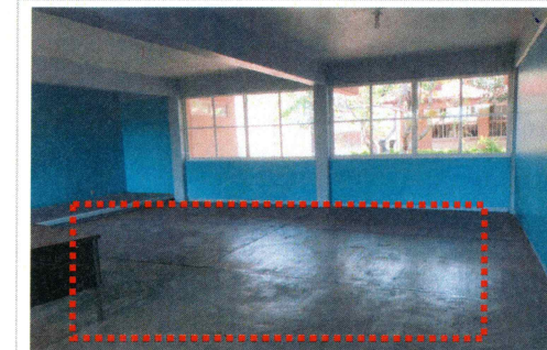
5.- Salón 9 colocación de loseta en Edificio 03.
