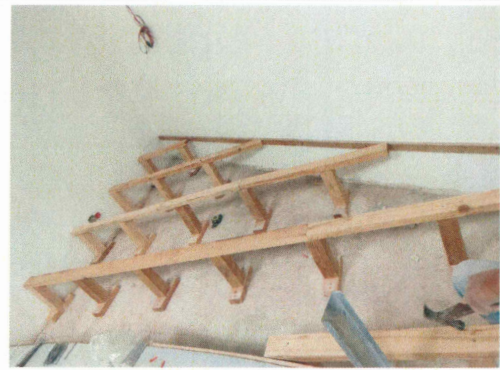
24.- Suministro y colocación de duela en vestidor
