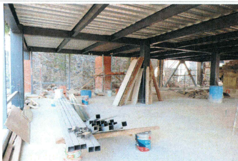
100.- Aplicación de pintura esmalte en estructura metálica
