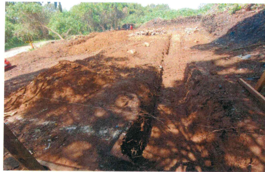
13.- Excavación de ceca por medios mecánicos (Almacén de residuos).
