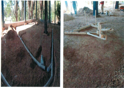
57.- Tendido de tubería de pvc para salidas sanitarias (Edificio CIB).
