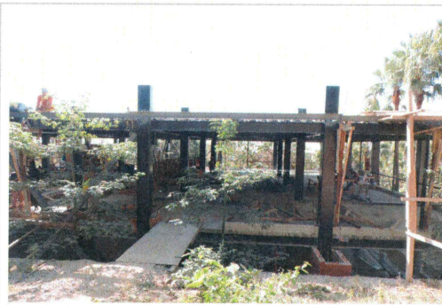
96.- Habilitación de columnas externas.
