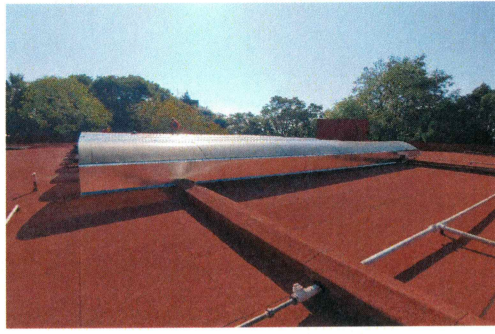
16.- Suministro y colocación de flashing en extremos este y oeste.
