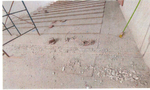
F18: Ranurado de piso de concreto para colocación de tuberías eléctricas
