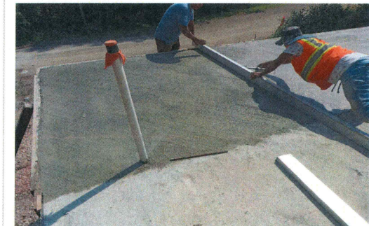
38.- Colado de plataforma con concreto premezclado acabado rayado
