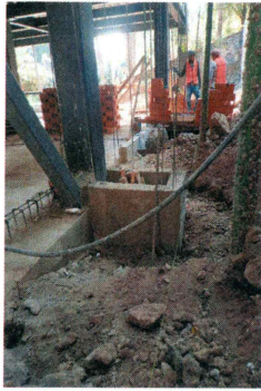
84.- Colado de concreto hecho en obra para ampliación de dados (Edificio CIB).
