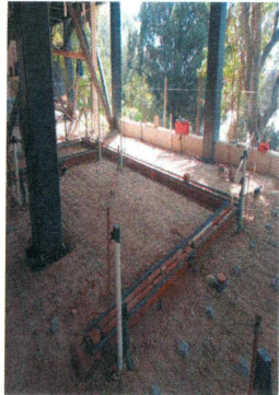
67.- Suministro y colocación de marcos de herrería para rejillas (Edificio CIB).
