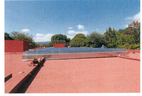
17.- Suministro y colocación de flashing en extremos este y oeste.
