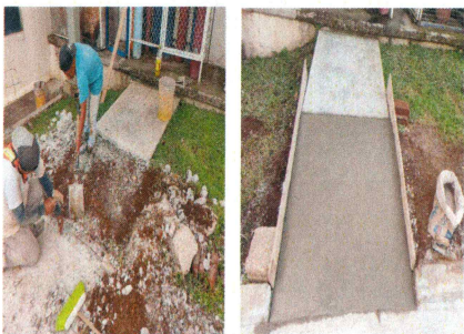
9.- Colado de firme de concreto hecho en obra.
