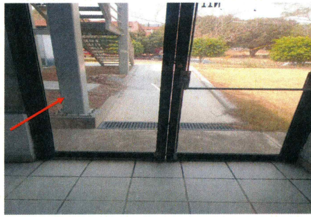
4.-espacio interior hacia salida de emergencia
