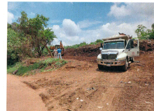
8.- Acarreo en camión de material de composta a nueva ubicación (Almacén de residuos).
