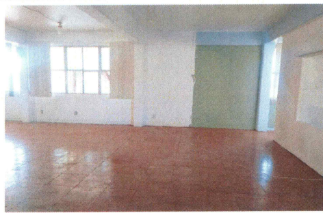
49.- Colocación de piso en sala de juicios orales y salón 9.
