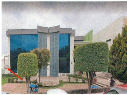
1.- Fachada Principal CIQ-ICBA. Puerta de emergencia.
