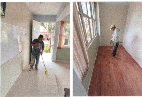
36.- Limpieza en interior y exterior de obra.
