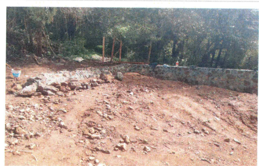
19.- Elaboración de muro de mampostería de piedra de sitio (Almacén de residuos).
