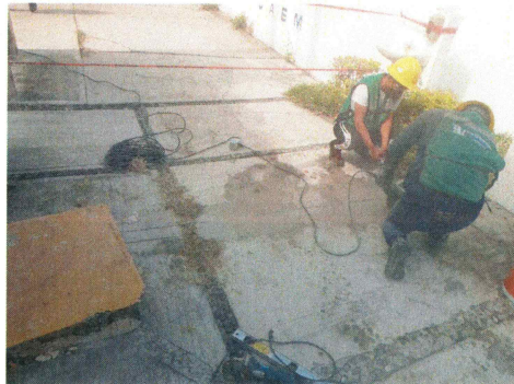
F21: Corte con cortadora manual de concreto existente
