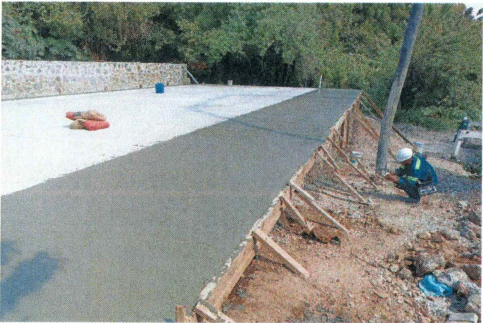
36.- Colado de plataforma con concreto premezclado acabado rayado
