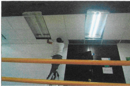
F10: Techo: suministro y colocación de galletas de falso plafón
