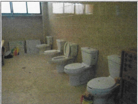
F12: Sanitarios: azulejo, piso y excusados nuevos (baño de hombres)
