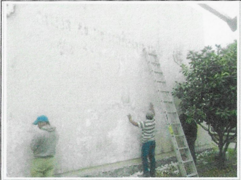
F6: TAMULBA: Limpieza de capas de pintura en mal estado sobre muros de fachada principal.
