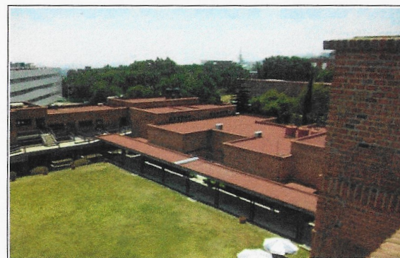
F8: Impermeabilizante terminado
