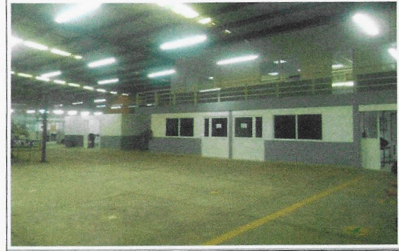
F19: LOU: trabajos de aplicación de pintura vinílica y de esmalte en áreas comunes interiores de edificio.
