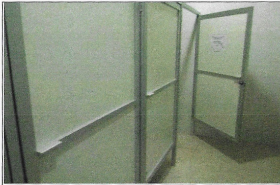
F9: Sanitarios: colocación de manparas existentes (baño hombres)
