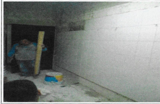
F7: Sanitarios: Colocación de azulejo en proceso.
