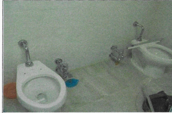
F13: azulejo, piso y sanitarios con fluxómetro de pedal nuevo terminado (mujeres)
