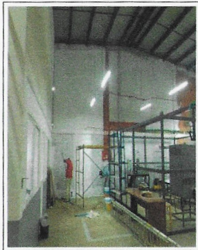
F11: LOU: Trabajos de aplicación de pintura vinílica en muros perimetrales al interior de la nave principal.
