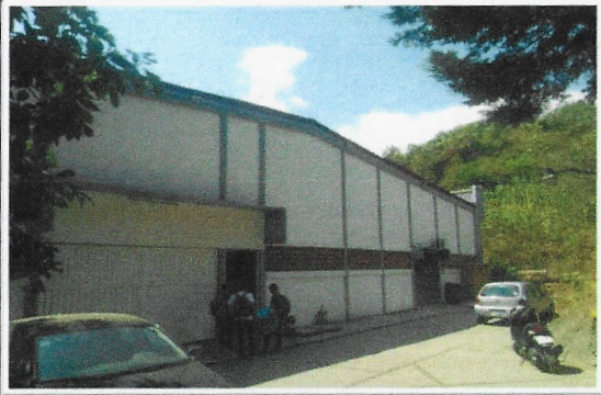
F18: LOU: trabajos concluidos de aplicación de pintura vinílica y de esmalte en fachada Principal.
