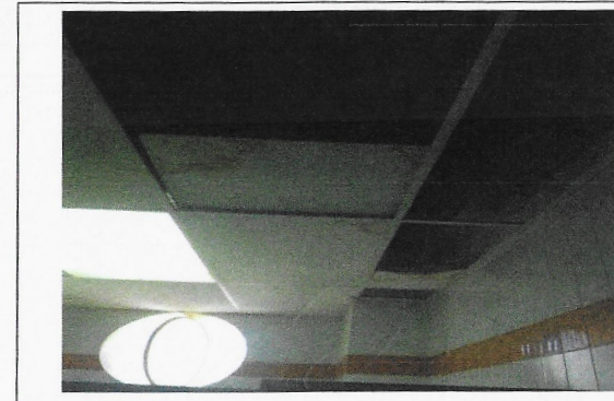
F5: Techo (Plafón)
