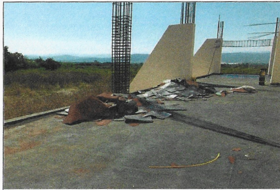
F4: Techo del edificio: Retiro de impermeabilizante prefabricado
