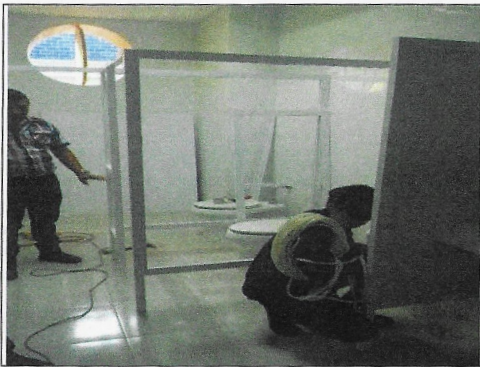
F9: Sanitarios: suministro y colocación de mamparas de aluminio (hombres)
