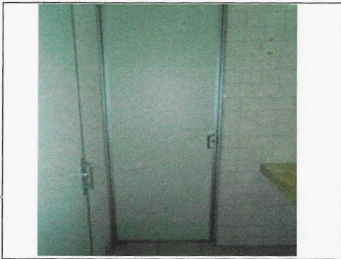
F6: Colocación de puertas
