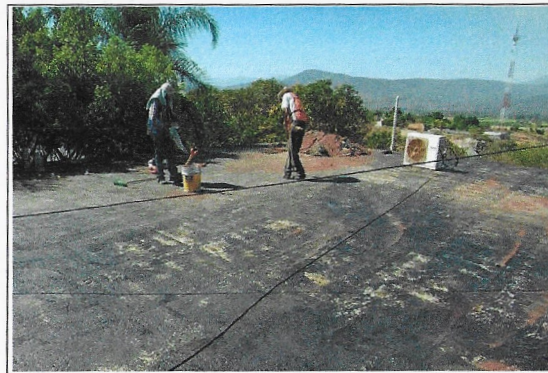
F9: Techo: trabajos de retiro de impermeabilizante prefabricado en edificio.
