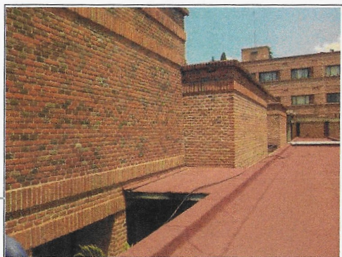
F6: Fachada principal limpia y barnizada
