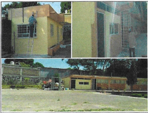
F6: Aplicación de pintura.
