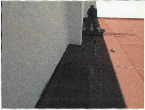
F6: Techo del edificio: suministro y colocación de impermeabilizante prefabricado
