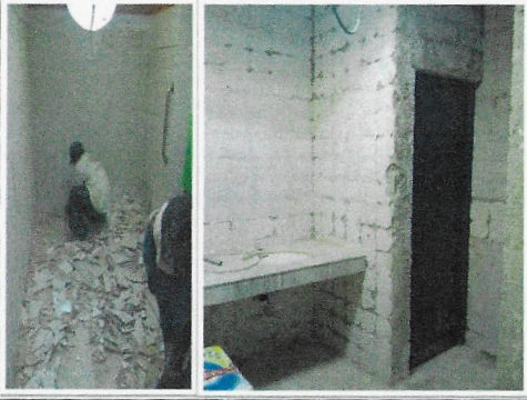
F6: Sanitarios: demolición de azulejo y piso.
