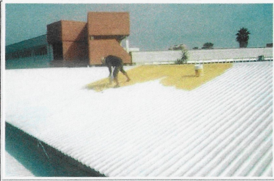
F10: Imagen de aplicación de poliurea color blanco sobre espuma de poliuretano, como acabado final.
