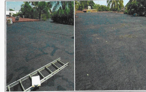
F10: Techo: trabajos de calafateo en grietas de losa en edificios.
