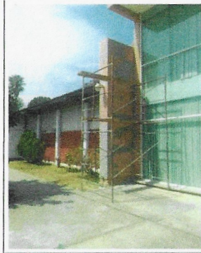
F7: TAMULBA: Sellado de fisuras en muros de fachada principal
