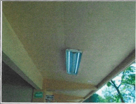
F6: Aulas, colocación de luminarias
