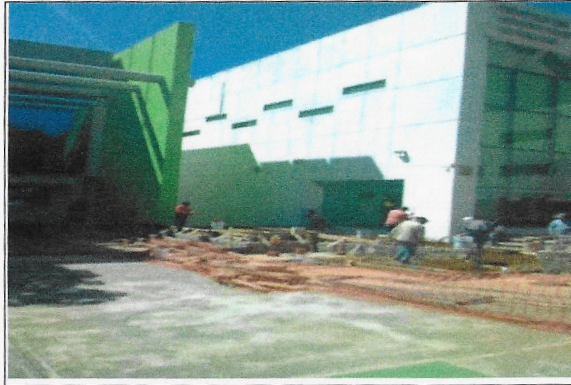
F2: Fachada Principal del Edificio 60
