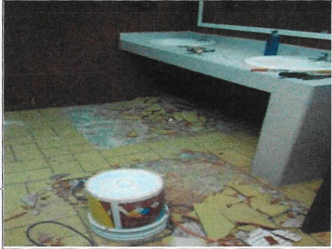
F6: Sanitarios: demolición de piso
