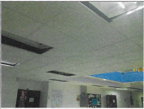
F9: Techo: suministro y colocación de falso plafón
