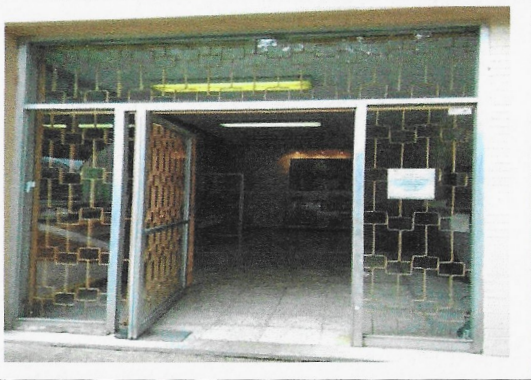
F1: Puerta de acceso (exterior)
