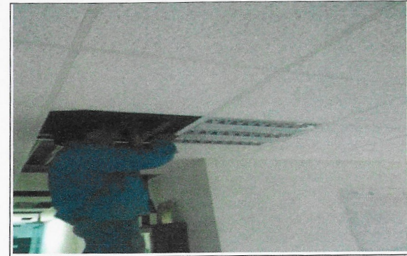
F11: Techo: colocación de lámpara en falso plafón
