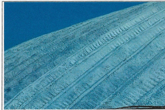
F4: Techo Edificio 49 en proceso con primer aplicado (impermeabilización).
