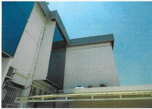
F1: Edificio 49 (exterior)
