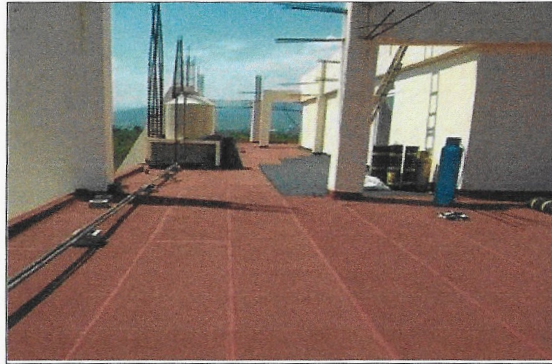
F7: Techo del edificio: suministro y colocación de impermeabilizante prefabricado
