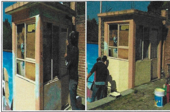
F7: Aplicación de pintura.
