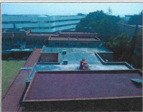
F3: Superficie preparada para recibir Impermeabilizante.
