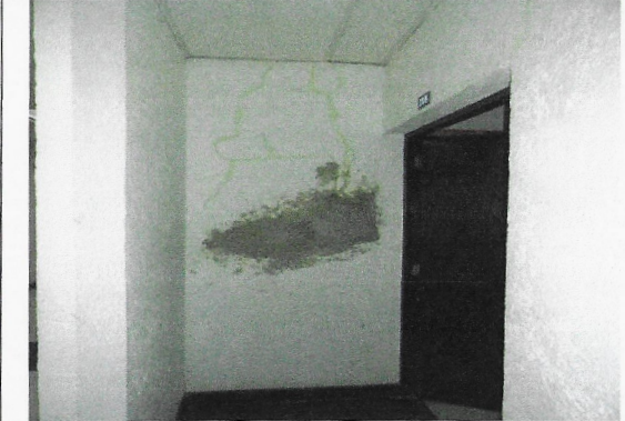
F2: Edificio 60 (interior)
