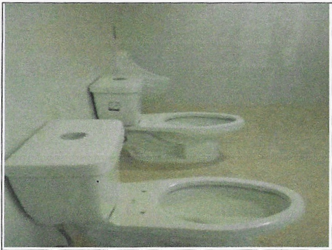
F8: Sanitarios: suministro y colocación de piso, azulejo, sanitarios, mingitorio ecológico (baño hombres)
