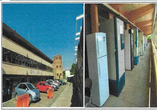
F4: Exterior del edificio
