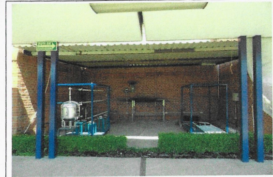
F5: Interior de aula (laboratorio)
