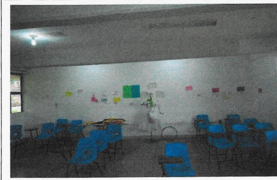
F5: Interior de aula
