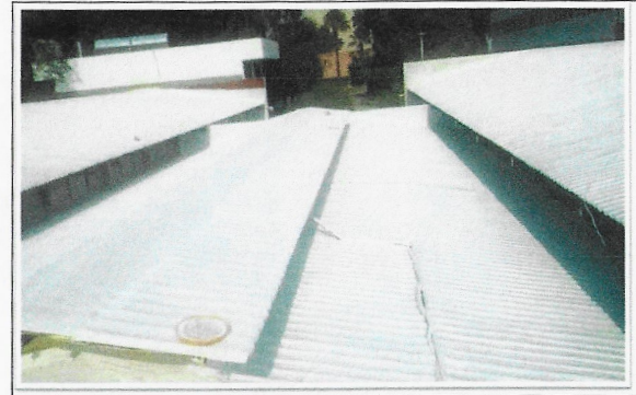
F11: Techo TAMULBA; Vista general de los trabajos terminados de impermeabilización a base espuma de poliuretano sobre cubiertas metálicas de edificio
