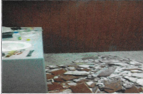
F7: Sanitarios: demolición de azulejo
