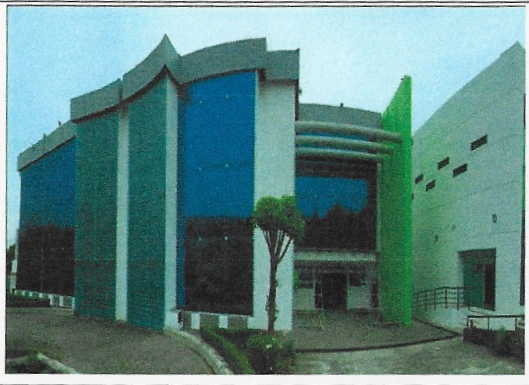
F1: Fachada principal edif. 49
