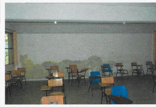
F2: Interior de aula
