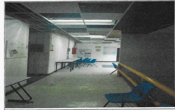
F11: Sanitarios: Colocación de falso plafón
