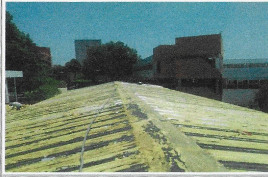
F7: Techo TAMULBA: Retiro de material deteriorado sobre laminas metálicas y cumbrera de cubierta, lado sur de edificio
