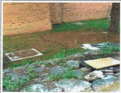
F3: Instalación sistema de tierras
