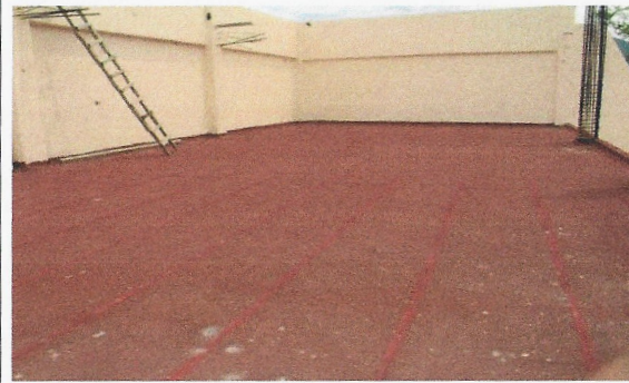
F2: Techo del edificio
