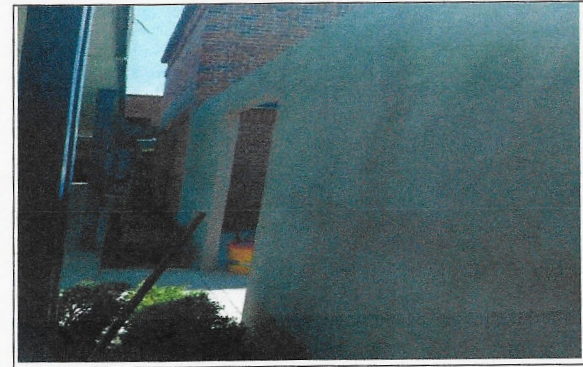
F10: Muro de Durock Terminado
