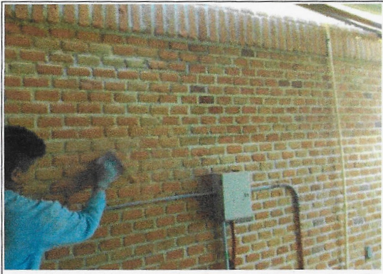
F1: Fachada principal (limpieza Limpieza de tabique aparente con lija y copillo de alambre
