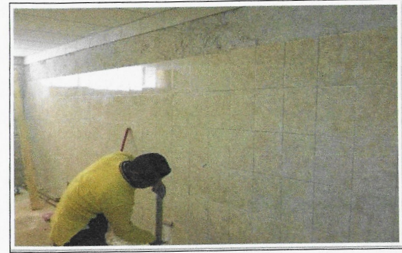
F11: Sanitarios: Colocación azulejo
