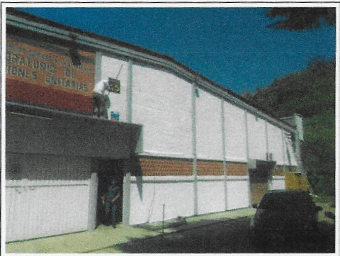
F10: LOU: Aplicación de pintura vinílica y de esmalte en muros de fachada principal.
