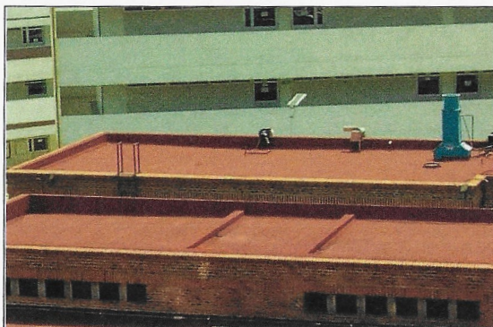
F7: Impermeabilizante terminado
