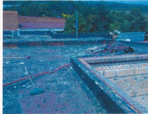
F2: Retiro de impermeabilizante anterior.
