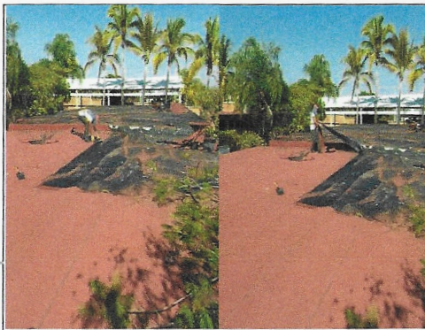
F8: Techo: trabajos de retiro de impermeabilizante prefabricado en edificio.
