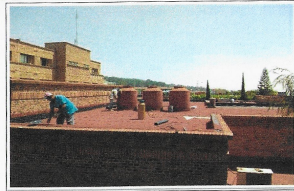
F5: Aplicación de impermeabilizante, en proceso.
