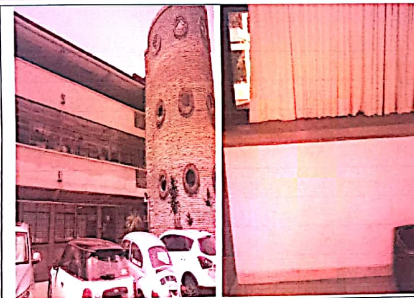
F1: Pintura de Edificio (interior y exterior)
