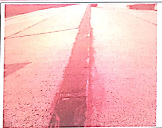
F3. Techo edificio 29
