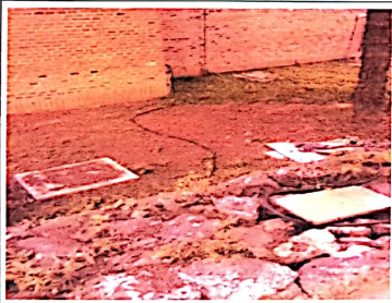
F3: Instalación sistema de tierras
