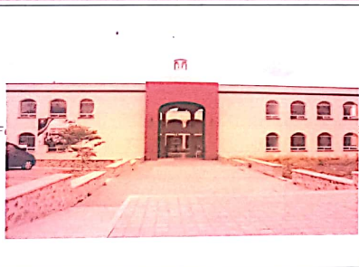
F1: Fachada principal
