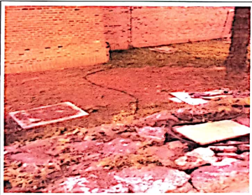
F3: Instalación sistema de tierras
