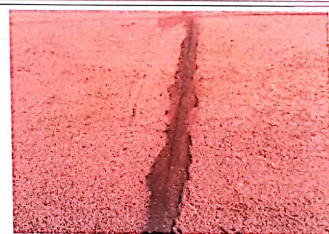
F5. Techo edificio 29
