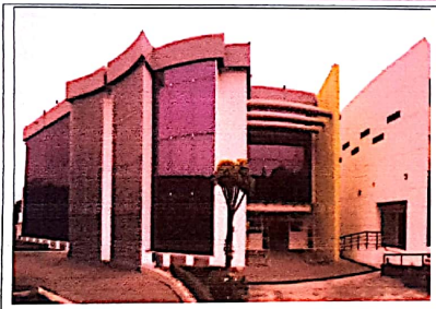
F1: Fachada principal edif. 49
