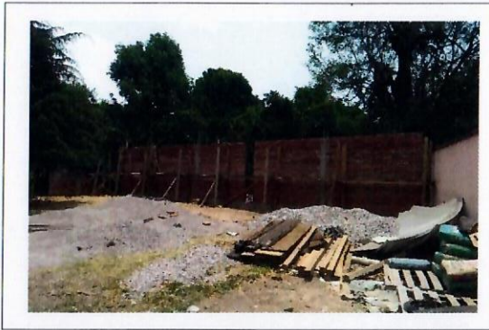
F6: Muro de colindancia en proceso
