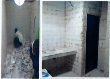
F6: Sanitarios: demolición de azulejo y piso.
