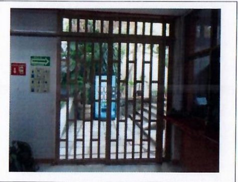
F12: Suministro y colocación de puerta de acceso principal.
