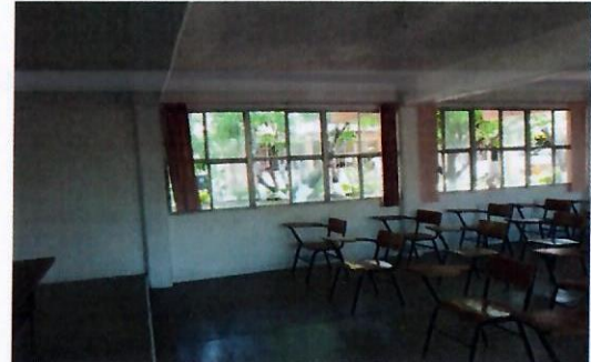
F28: Interior, ventanas aula
