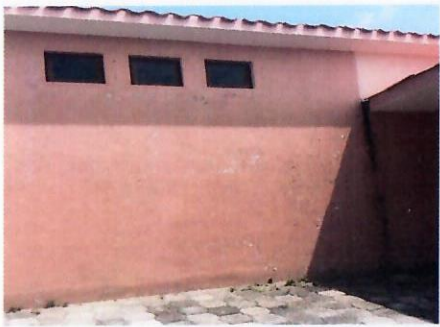
F9: Muros exteriores
