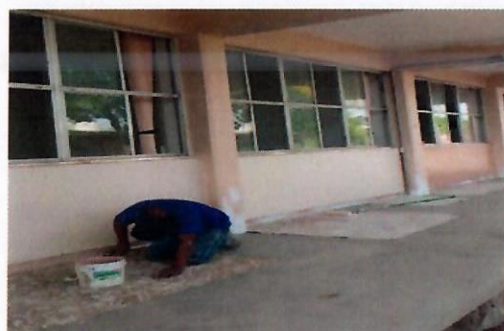
F18: Vista de los trabajos de suministro y aplicación de pintura vinilica acrílica edificio 4 y 3
