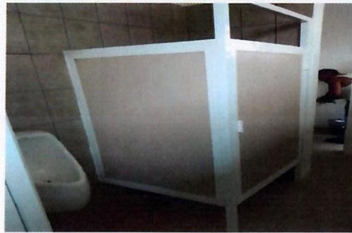
F10: Rehabilitación de sanitarios terminado
