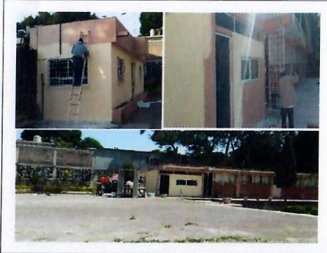
F6: Aplicación de pintura.
