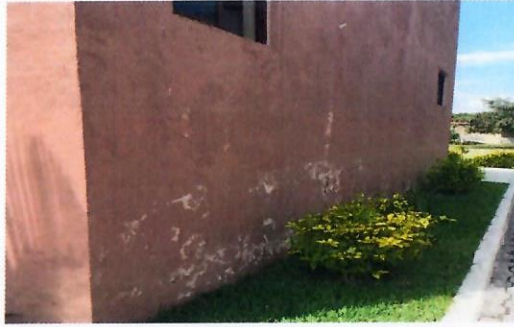
F7: Muros exteriores
