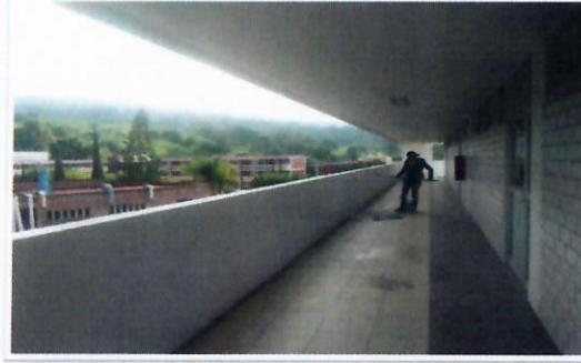
F18: Aplicación de pintura vinilica en pretilos y muros de pasillos principales, área exterior noroeste segundo nivel, edificio 35 FCQel.
