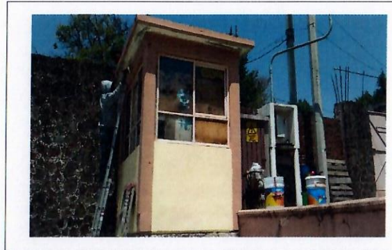
F8: Aplicación de pintura.
