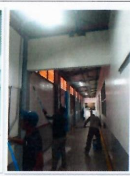
F8: TAMULBA: Aplicación de pintura vinílica y de esmalte en muros interiores de edificio
