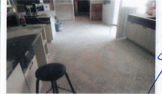
F16: Trabajos de retiro de pintura epóxica deteriorada en piso de laboratorio previo a la aplicación de pintura epóxica, primer nivel, lado sur de edificio 35, FCQEL.
