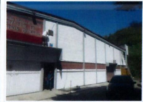
F10: LOU: Aplicación de pintura vinílica y de esmalte en muros de fachada principal.
