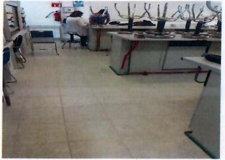
F15: Cambio de piso en laboratorio de biología, terminado.
