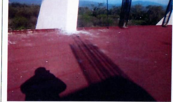
F8: Techo del edificio
