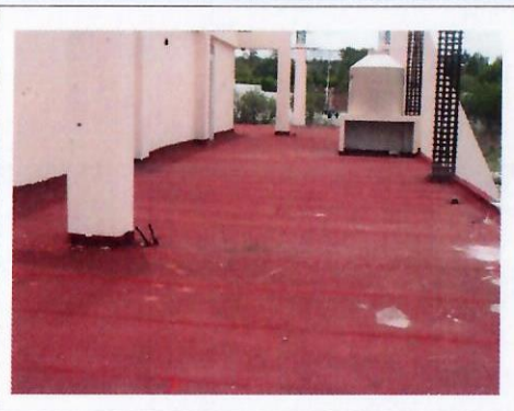
F3: Techo del edificio
