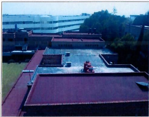
F3: Superficie preparada para recibir Impermeabilizante.
