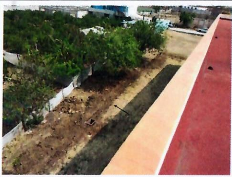
F6: El alimentador eléctrico está en proceso de construcción, que dará energía a las dos cisternas que se están construyendo
