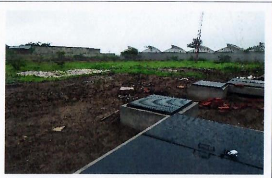
F13: Los trabajos en dos cisternas practicamente terminadas
