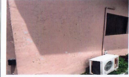
F11: Muros exteriores
