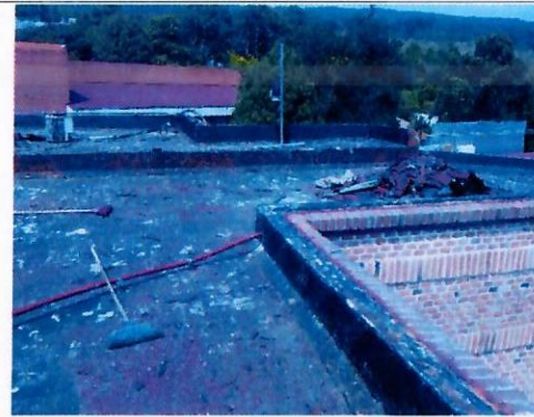
F2: Retiro de impermeabilizante anterior.
