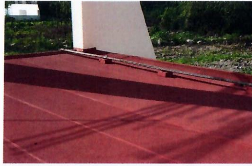
F24: Techo del edificio
