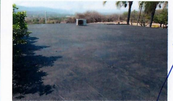
F13: Edificio 3 A
