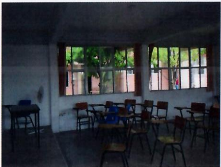
F3: Interior, ventanas aula
