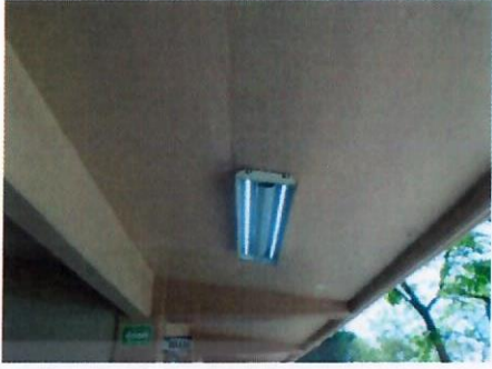
F6: Aulas, colocación de luminarias
