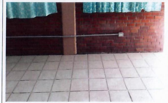
F8: Se termina de colocar la loseta en aulas
