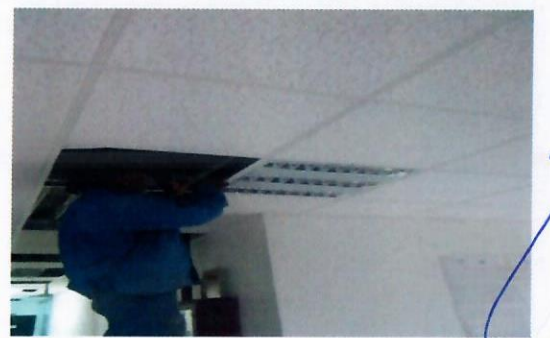
F14: Techo: colocación de lámpara en falso plafón
