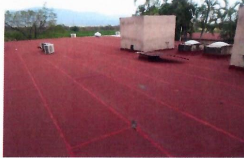
F4: Trabajos de impermeabilización terminados
