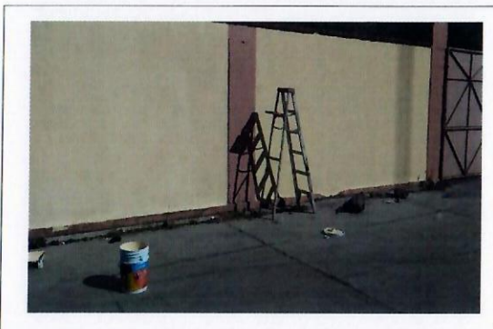
F10: Parte interior muro de fachada principal, se aplica pintura
