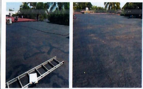
F10: Techo: trabajos de calafateo en grietas de losa en edificios 3A y 4.
