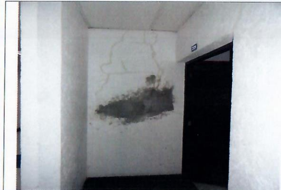
F2: Edificio 60 (interior)
