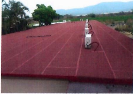
F3: Trabajos de impermeabilización terminados
