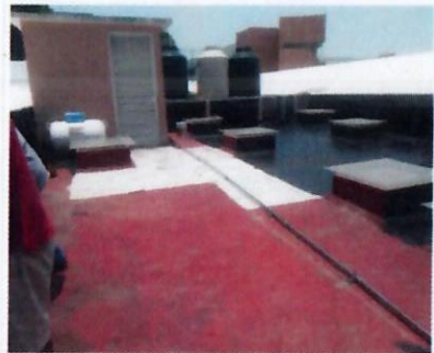
F12: Retiro de impermeabilizante deteriorado existente en cubierta de losa de acceso oeste a TABULBA.
