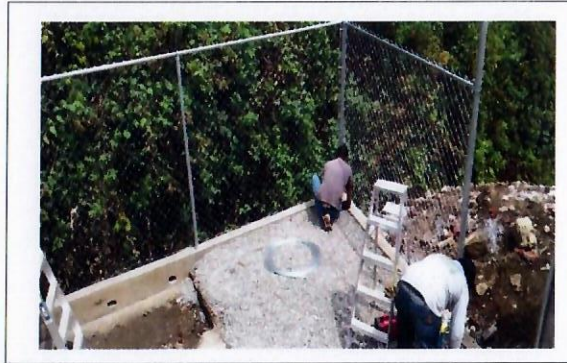
F10: Colocación de malla colicante, en proceso
