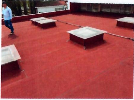
F22: Vista general de los trabajos terminados de colocación de membrana de impermeabilizante prefabricado en cubierta de TAMULBA.
