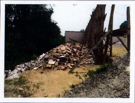
F8: Muro de colindancia en proceso
