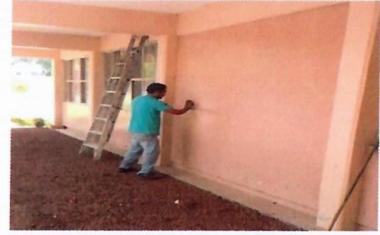
F16: Vista de los trabajos de preparación de la superficie para suministro y aplicación de pintura vinilica acrílica edificio 4 y 3
