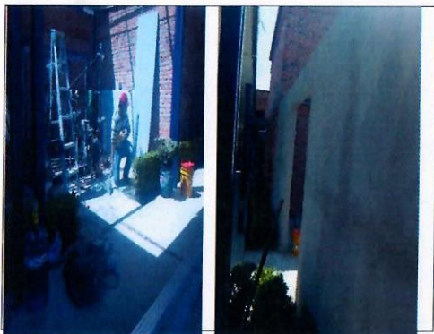
F6: Interior de aula (laboratorio), iniciando muro de Durock.
