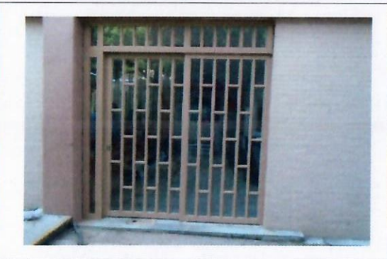
F13: Suministro y colocación de puerta de acceso principal.
