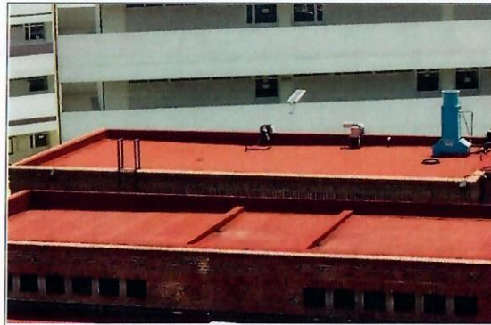
F7: Impermeabilizante terminado
