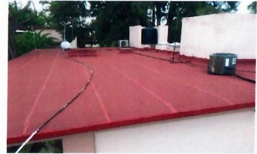
F5: Trabajos de impermeabilización terminados
