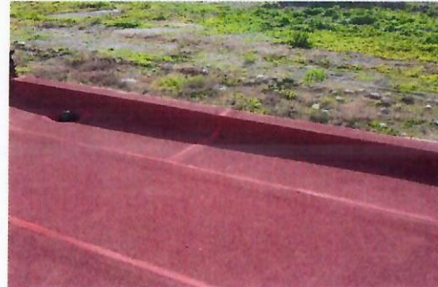
F30: Techo del edificio
