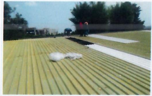
F19: Vista de los trabajos de retiro de lámina traslúcida y su sustitución por lámina metálica similar a la existente en cubierta del edificio de LOU, previo a la aplicación de impermeabilizante a base espuma de poliuretano.
