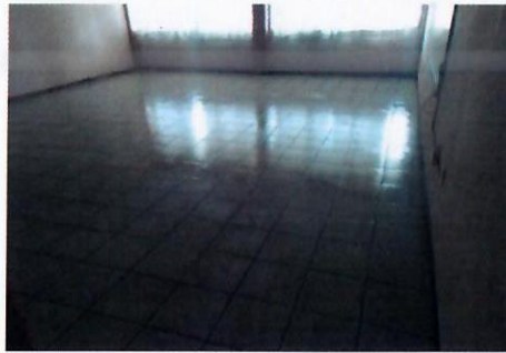
F7: Colocación de loseta en aulas terminado
