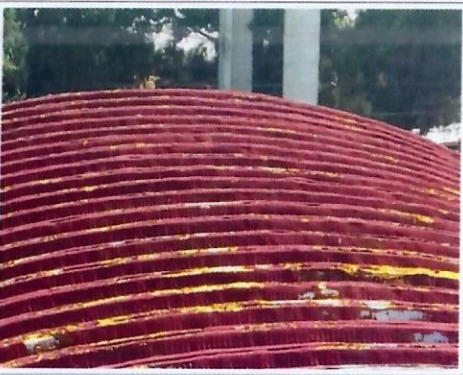
F3: Techo Edificio 49
