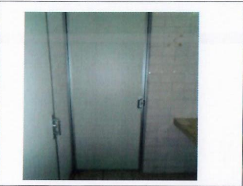
F9: Colocación de puertas
