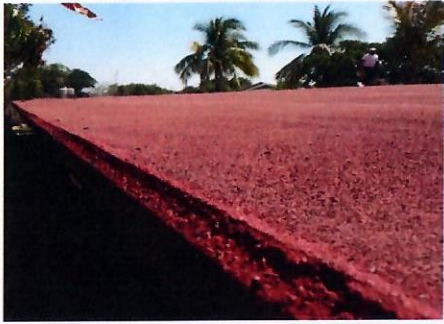
F23: Techo: Vista de los trabajos generales de impermeabilización.
