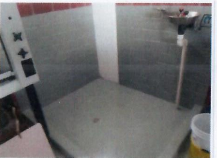
F36: Aplicación de pintura epóxica en muros y piso de área de lavajos y regadera, laboratorio primer nivel, edificio 35 FCQel
