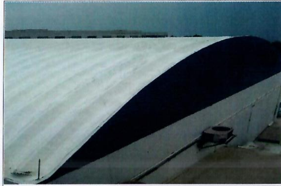
F7: Techo Edificio 48, impermeabilización con pintura elastometrica en arco techo
