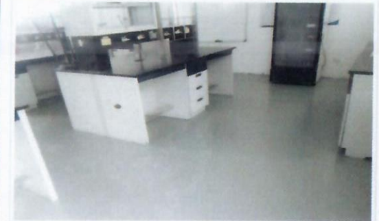
F35: Trabajos terminados de aplicación de pintura epóxica en piso de laboratorio primer nivel de edificio 35 FCQel.
