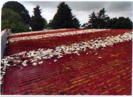
F15: Vista de los trabajos de retiro de impermeabilizante deteriorado de poliuretano en techumbre metálica de nave principal, lado norte de LOU.
