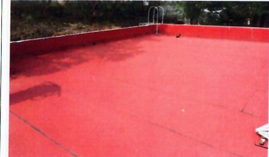
F24: Imagen de trabajos concluidos de impermeabilización con membrana prefabricado hacia fachada norte de anexo TAMULBA.
