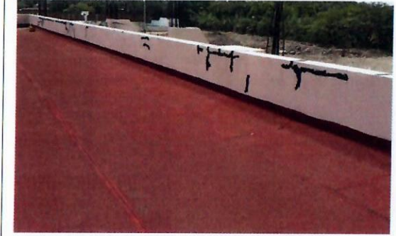
F16: Suministro y aplicación de impermeabilizante acrílico en azotea de segundo nivel del edificio
