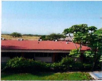
F6: Trabajos de impermeabilización terminados
