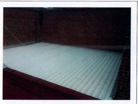
F15: Techumbre de lámina prepintada para el nuevo laboratorio
