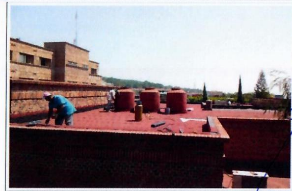
F5: Aplicación de Impermeabilizante, en proceso.
