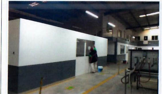
F13: LOU: Trabajos de aplicación de pintura vinílica y de esmalte en muros interiores.
