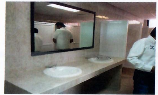
F17: Rehabilitación de sanitarios terminados. (sanitarios hombres)
