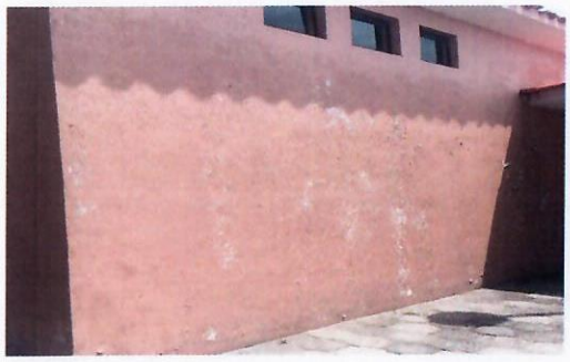
F10: Muros exteriores
