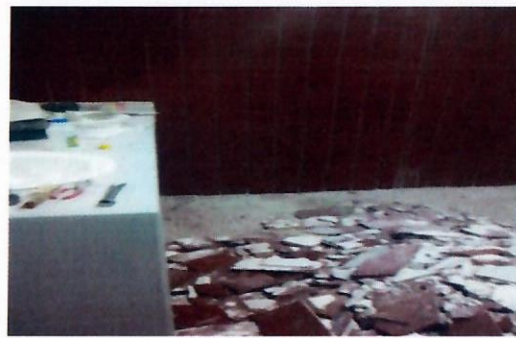
F7: Sanitarios: demolición de azulejo
