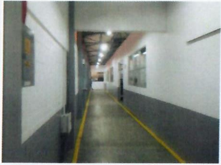
F21: TAMULBA-FCQel: Trabajos concluidos de aplicación de pintura vinílica y de esmalte en muros de pasillos interiores.
