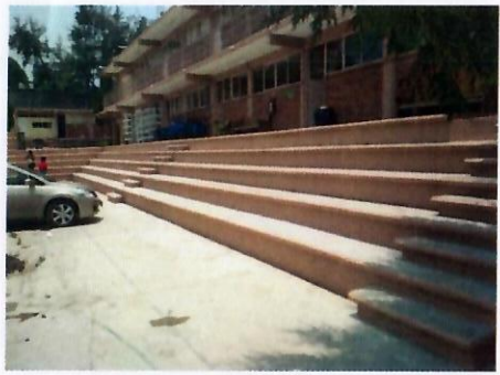
F15: La aplicación de pintura, en el interior del plantel, terminada, se realizan detalles
