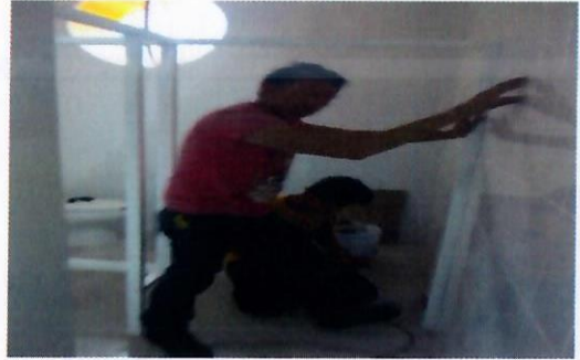
F10: Sanitarios: suministro y colocación de mamparas de aluminio (mujeres)
