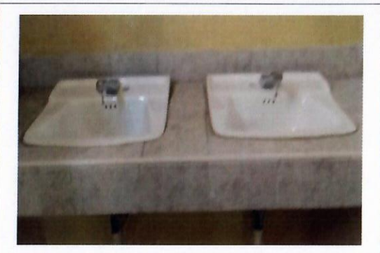
F13: Se concluyo el cambio de muebles sanitarios
