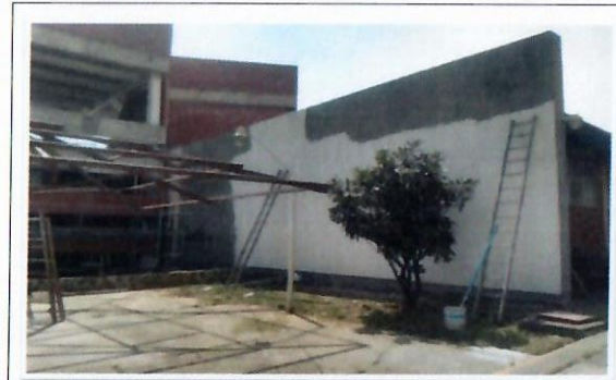
F9: TAMULBA: Aplicación de pintura en muros de fachada con preparación previa para recibir trabajos
