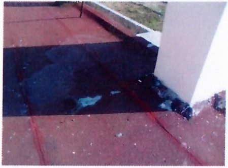
F6: Techo del edificio
