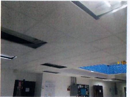
F12: Techo: suministro y colocación de falso plafón
