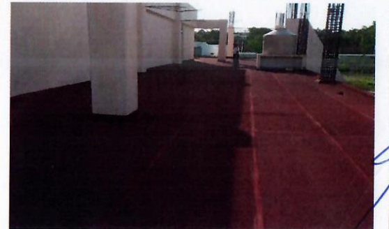
F22: Techo del edificio
