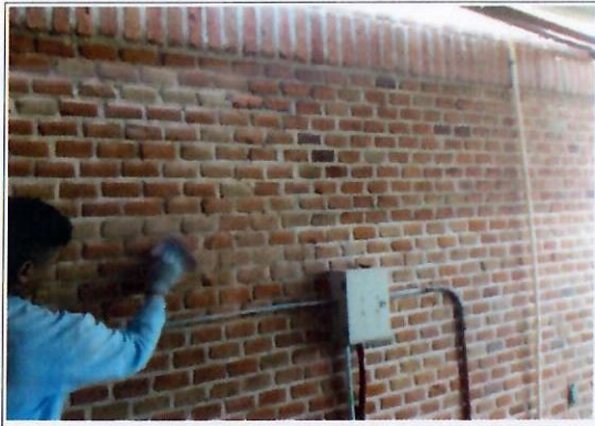
F1: Fachada principal (limpieza Limpieza de tabique aparente con lija y cepillo de alambre
