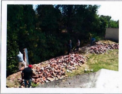
F5: Demolición de muro dañado
