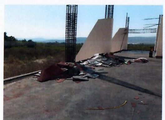
F12: Retiro de impermeabilizante prefabricado
