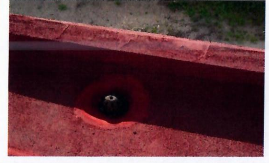
F28: Techo del edificio
