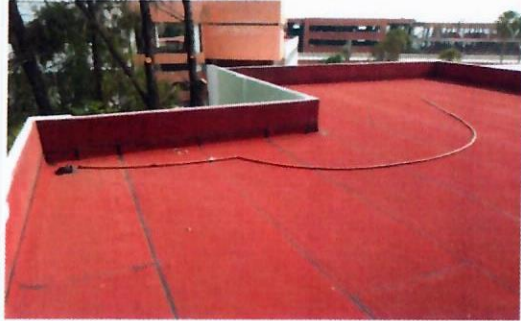
F23: Vista general de los trabajos terminados de impermeabilización prefabricado en losa de anexo TAMULBA.
