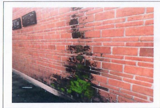
F4: Muros exteriores
