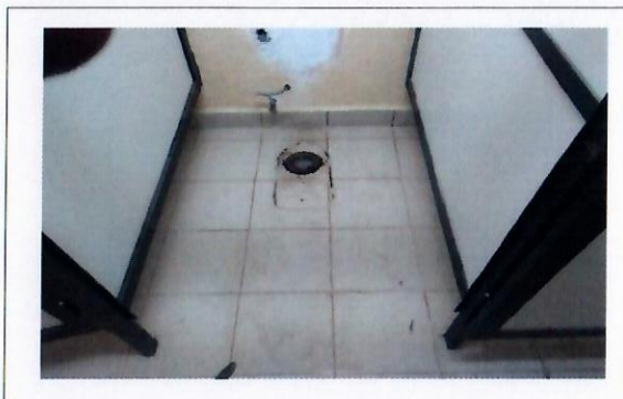
F11: Se desmontan muebles sanitarios
