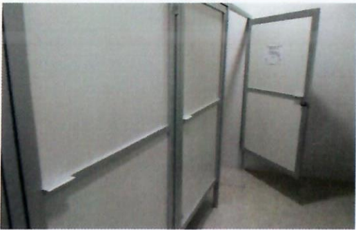
F9: Sanitarios: colocación de mamparas existentes (baño hombres)
