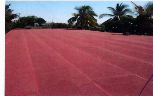
F22: Techo: Suministro y colocación de impermeabilizante prefabricado en edificio 2
