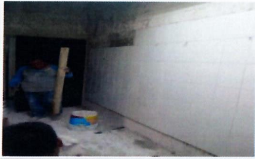
F7: Sanitarios: Colocación de azulejo en proceso.
