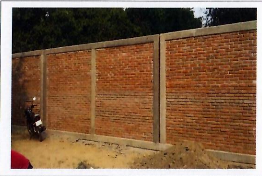
F9: Muro de colindancia detallando
