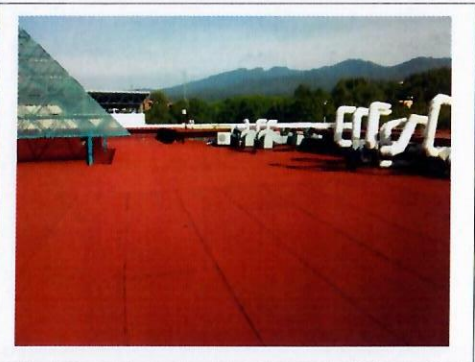
F8: Impermeabilización de techumbre
