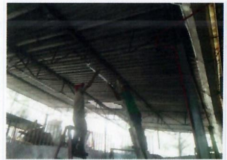
F14: Tamulba: Vista de los trabajos de retiro de luminarias existentes y colocación de luminarias ahorradoras de energía tipo LED.
