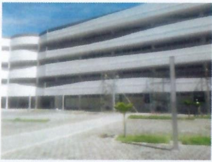
F20: Aplicación de sellador en fachafeta de cerámica esmaltada en muretes de fachada principal de primer nivel, edificio 35 FCQel.
