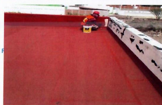
F18: Suministro y aplicación de impermeabilizante acrílico en azotea de segundo nivel del edificio
