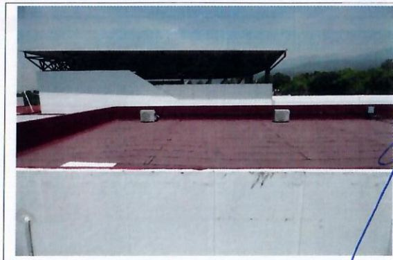
F5: Techo edificio 60
