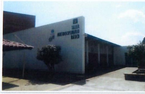
F22: TAMULBA-FCQel: Trabajos terminados de aplicación de pintura vinílica en muros de fachada principal así como de pintura de esmalte en estructura y puertas metálicas.
