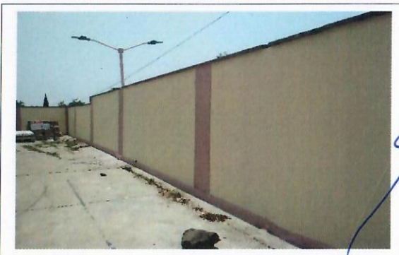
F14: Aplicación de pintura en fachada principal, terminada, detallando
