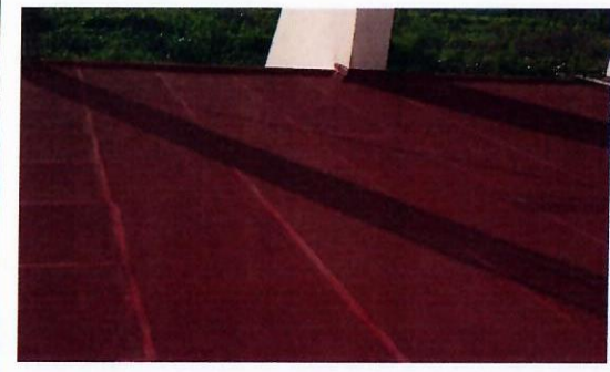
F25: Techo del edificio
