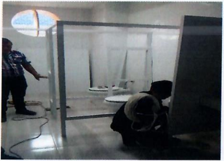
F9: Sanitarios: suministro y colocación de mamparas de aluminio (hombres)
