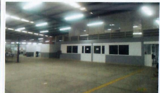
F26: LOU: trabajos de aplicación de pintura vinílica y de esmalte en áreas comunes interiores de edificio.
