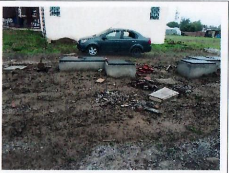
F12: Los trabajos en dos cisternas practicamente terminadas
