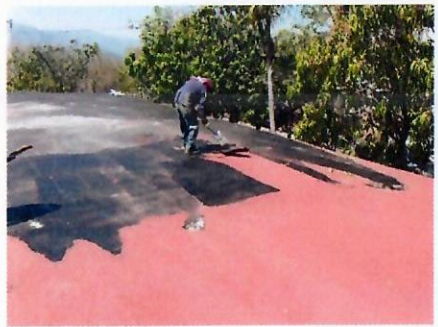
F11: Retiro de impermeabilizante prefabricado en edificio 2
