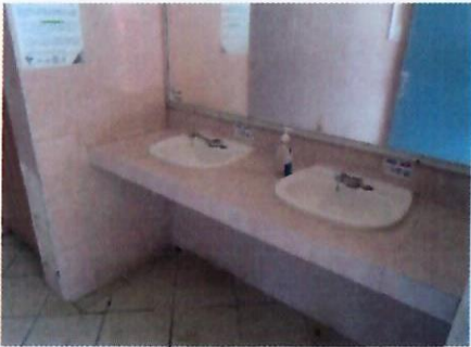
F8: Cambio de lavabos
