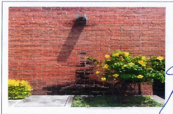
F5: Muros exteriores
