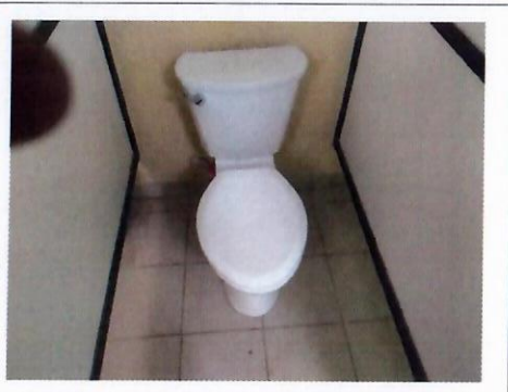
F12: Trabajo de cambio de muebles sanitarios
