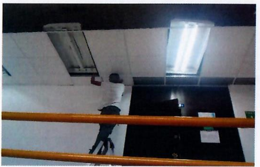
F13: Techo: suministro y colocación de galletas de falso plafón
