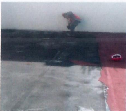
F11: Retiro de impermeabilizante prefabricado
