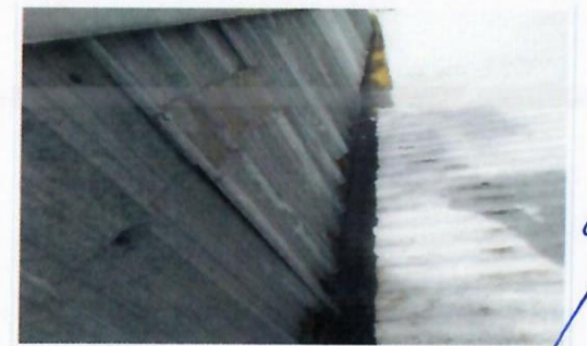
F20: Imagen de los trabajos de limpieza de láminas traslucidas existentes en cubierta metálica de LOU.
