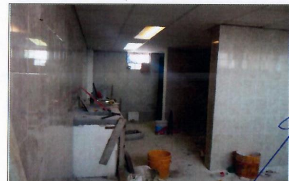
F14: Sanitarios: colocación de piso y azulejo en proceso (baño de mujeres)
