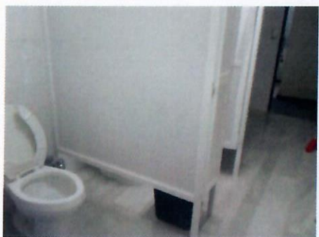
F18: Remodelación de sanitarios (avance)
