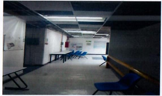
F11: Colocación de falso plafón
