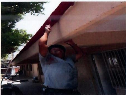
F17: Vista de los trabajos de suministro y aplicación de pintura vinilica acrílica edificio 4 y 3
