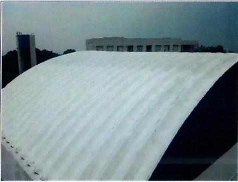
F6: Techo Edificio 49, impermeabilización con pintura elastometrica en arco techo
