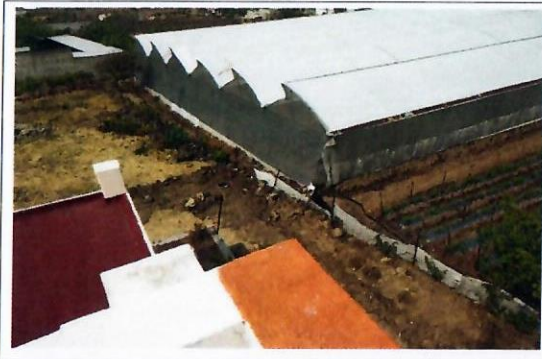
F7: El alimentador eléctrico está en proceso de construcción, que dará energía a las dos cisternas que se están construyendo
