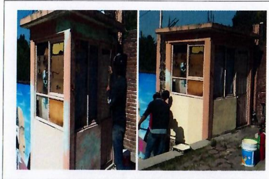
F7: Aplicación de pintura.
