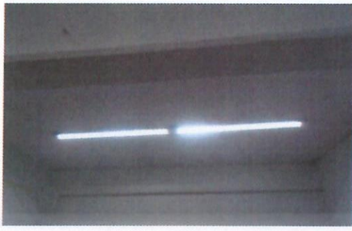
F7: Aulas, colocación de luminarias
