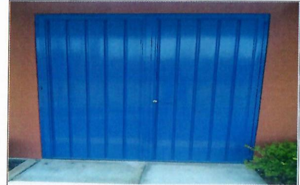
F11: Puerta de lámina acanalada terminada
