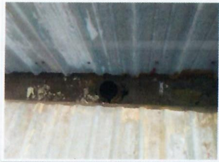
F18: Vista general de limpieza en canalones metálicos adyacentes a cubierta metálica de LOU, previos a su reparación en áreas deterioradas.
