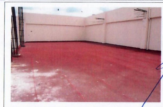
F5: Techo del edificio
