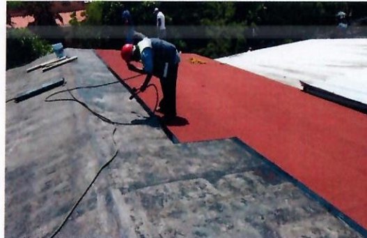
F2: Colocación de impermeabilización
