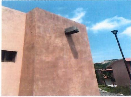
F6: Muros exteriores
