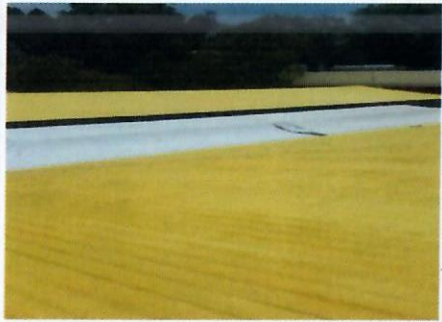
F9: Techo TAMULBA: Aplicación de mediante esprayado de espuma de poliuretano sobre cubierta metálica previa a recibir acabado final
