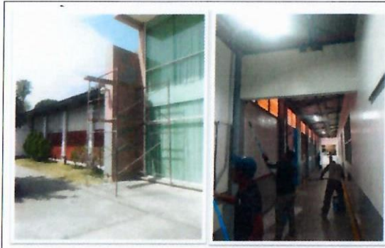
F7: TAMULBA: Sellado de fisuras en muros de fachada principal
