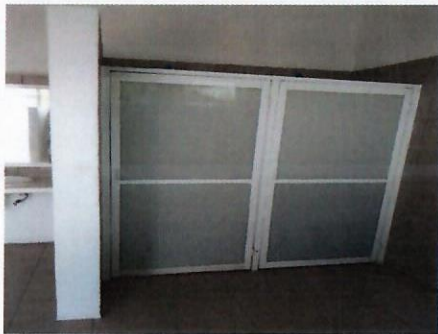
F9: Rehabilitación de sanitarios terminado
