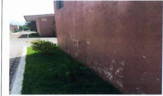
F8: Muros exteriores
