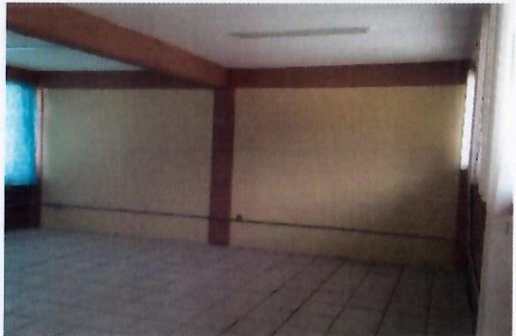
F7: Aula pintada y loseta de piso colocado
