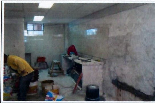
F10: Sanitarios: Colocación azulejo
