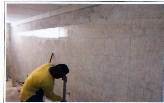
F11: Sanitarios: Colocación azulejo
