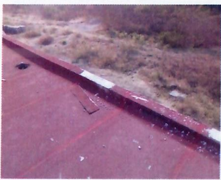
F9: Techo del edificio
