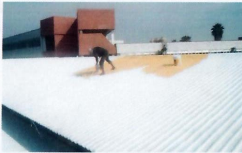
F10: Imagen de aplicación de poliurea color blanco sobre espuma de poliuretano, como acabado final.
