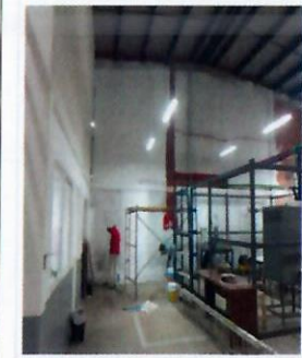
F11: LOU: Trabajos de aplicación de pintura vinílica en muros perimetrales al interior de la nave principal.
