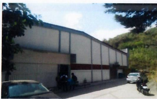
F25: LOU: trabajos concluidos de aplicación de pintura vinílica y de esmalte en fachada Principal.
