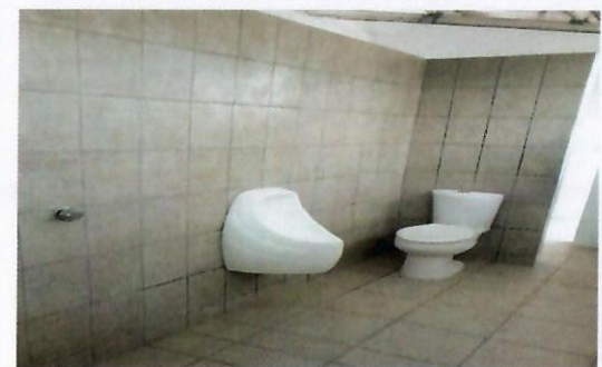
F11: Rehabilitación de sanitarios terminado
