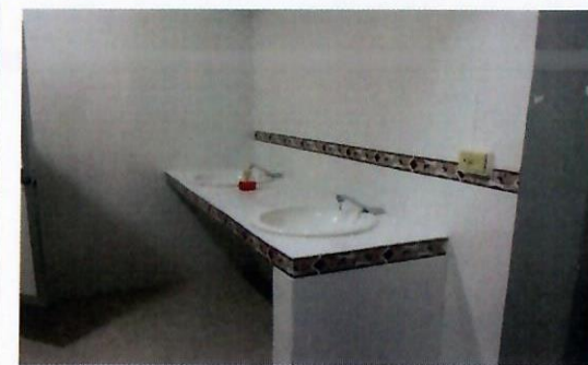
F10: Sanitarios: suministro y colocación de piso, azulejo, obalines con llaves economizadoras (Baño de hombres)
