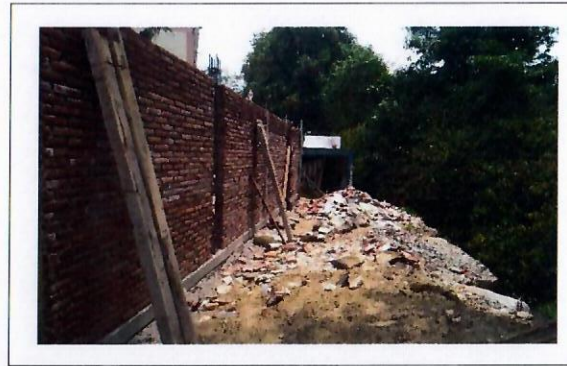
F7: Muro de colindancia en proceso
