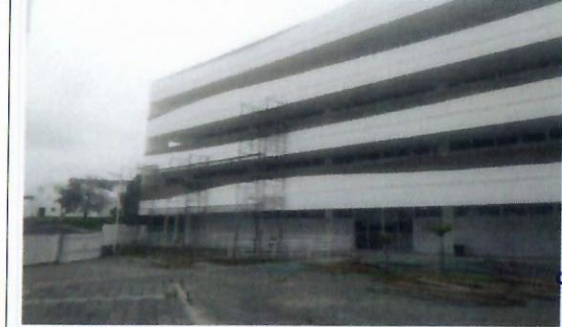
F19: Vista general de los trabajos de aplicación de pintura vinilica en muros de fachadas, primer y segundo nivel, área exterior sur de laboratorios edificio 35 FCQel.
