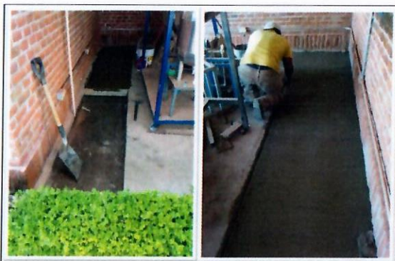
F7: Interior de aula (laboratorio) quitar adoscreto, para colocar concreto acabado pulido y rayado (foto izquierda). Acabado al concreto ya terminado (foto derecha).
