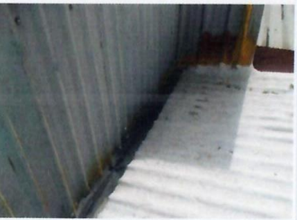
F21: Vista general de limpieza en canalones metálicos adyacentes a cubierta metálica de LOU, previos a su reparación en áreas deterioradas.
