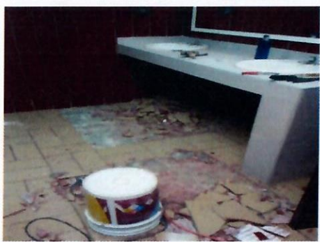
F6: Sanitarios: demolición de piso
