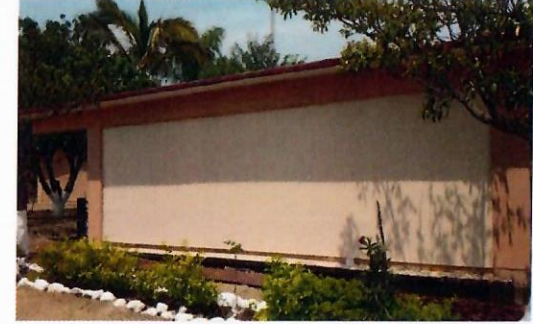
F25: Suministro y aplicación de pintura vinílica acrílica edificio 4 y 3
