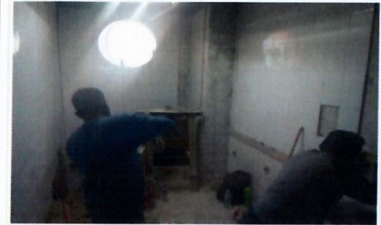
F8: Sanitarios: Colocación de azulejo en proceso.
