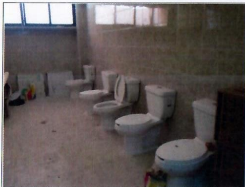
F12: Sanitarios: azulejo, piso y excusados nuevos (baño de hombres)
