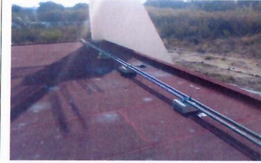
F7: Techo del edificio
