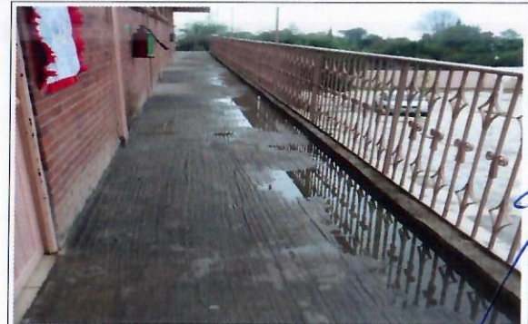
F5: Pasillo planta alta
