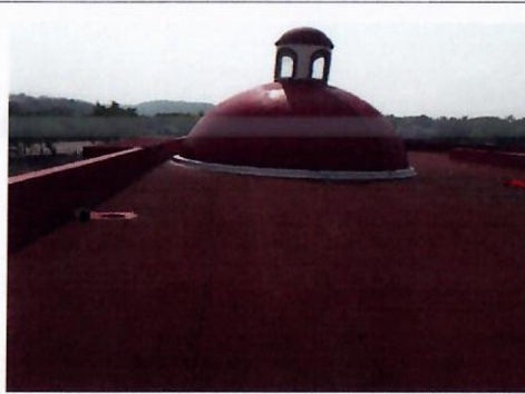
F27: Impermeabilización acrílico en azotea de segundo nivel del edificio
