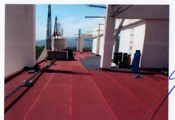
F13: Suministro y colocación de impermeabilizante prefabricado en losa
