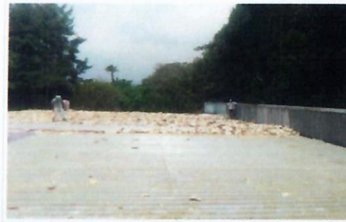
F16: Imagen de los trabajos de limpieza de residuos de impermeabilizante deteriorado de poliuretano existente en cubierta metálica, lado poniente de LOU.
