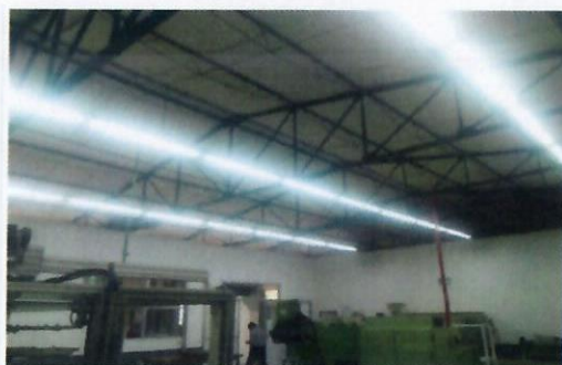
F28: Vista general de los trabajos concluidos de colocación de luminarias ahorradoras de energía tipo LED y su puesta en marcha. Laboratorios de TAMULBA
