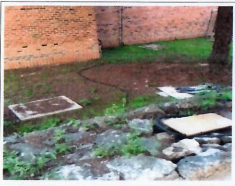
F3: Instalación sistema de tierras
