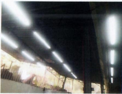
F27: Imagen de los trabajos concluidos de colocación de luminarias ahorradoras de energía tipo LED, en taller de TAMULBA.
