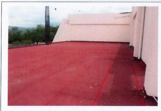
F4: Techo del edificio
