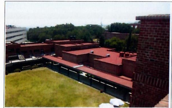
F8: Impermeabilizante terminado
