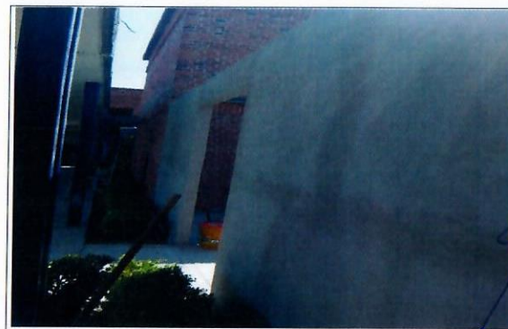
F8: Muro de Durock
