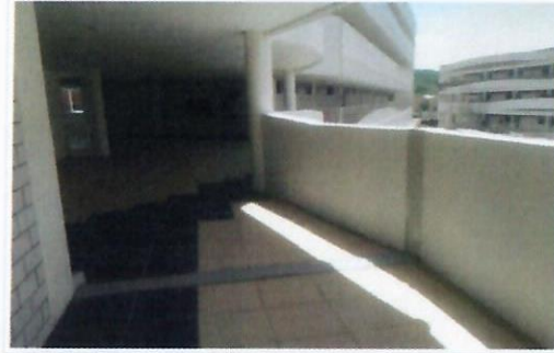
F31: Imagen de los trabajos terminados de aplicación de pintura vinílica en pretiles y muros, vestibulo principal de laboratorios, primer nivel edificio 35.
