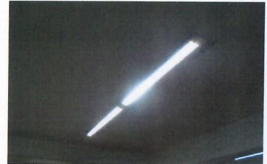
F10: Luminarias colocadas
