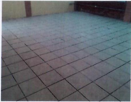
F6: Aulas: loseta de piso colocado en aulas didácticas
