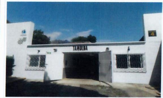
F23: TAMULBA-FCQel: Trabajos terminados de aplicación de pintura vinílica en muro y pintura de esmalte en puertas y protecciones de ventana.
