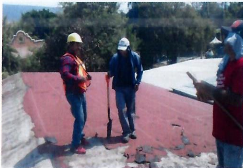
F1: Retiro de impermeabilización existente
