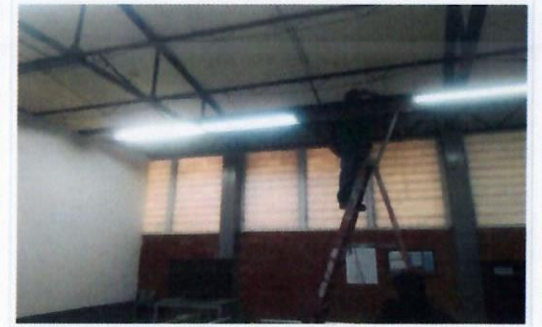
F15: Trabajos de retiro de luminarias en laboratorios de TAMULBA
