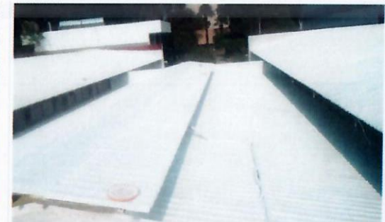
F11: Techo TAMULBA: Vista general de los trabajos terminados de impermeabilización a base espuma de poliuretano sobre cubiertas metálicas de edificio
