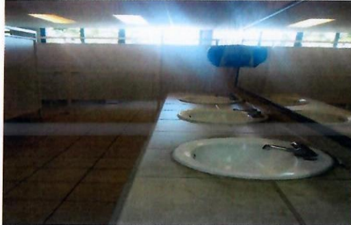
F16: Rehabilitación de sanitarios terminados. (sanitarios mujeres)
