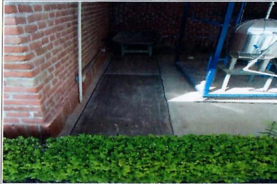
F10: Firme de concreto pulido y rayado terminado
