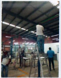
F12: LOU: Trabajos de aplicación de pintura de esmalte en tuberías interiores de instalaciones en diámetros varios.
