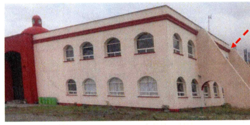
F2: Fachada principal de la E.E.S. de Tepalcingo
