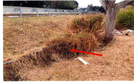
4.- Extremo sur de: Mantenimiento de áreas perimetrales: retiro de malla existente deteriorada, deshierbe y limpieza del área, excavación y construcción de rodapié de mampostería de piedra, colocación de malla ciclónica con postes metálicos.
