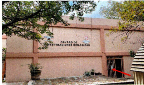
1.- Fachada principal del CIB.
