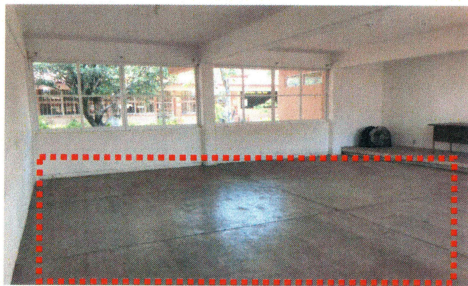
3.- Interior de Aula tipo - Se realizarán trabajos de colocación de loseta.
