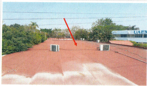
3.- Nivel azotea donde se colocaran los módulos fotovoltaicos. Edificio B
