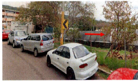
1.- Fachada principal de la Facultad de Ciencias Agropecuarias-Campo experimental
