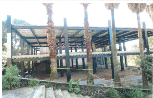
F6: Fachada Oeste -Construcción de la segunda etapa para la ampliación de laboratorios, cubículos de investigación, y oficinas académicas para el Centro de Investigaciones Biológicas antes CEIB (etapa final).
