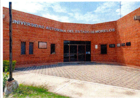
F1: Fachada principal
