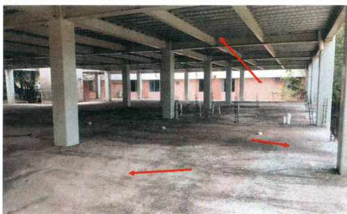
P9: Planta Baja - Se desarrollaran trabajos de construcción de cadena perimetral y firme de concreto, colocación de loseta de cerámica, muros divisorios de tablaroca, colocación de plafón, instalaciones, cancelería.
