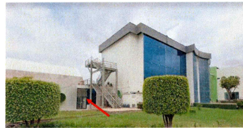
2.- Fachada lateral CIQ. Puerta de emergencia.
