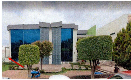
1.- Fachada Principal CIQ-ICBA. Puerta de emergencia.
