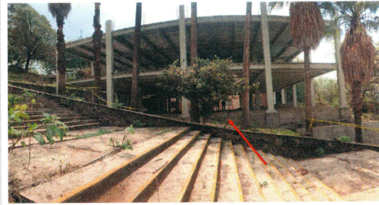
F2: Fachada Oeste - Construcción de la segunda etapa para la ampliación de laboratorios, cubículos de investigación, y oficinas académicas para el Centro de Investigaciones Biológicas antes CEIB (etapa final).
