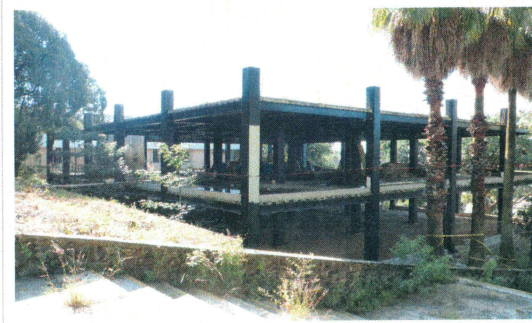
F4: Fachada Norte y Oeste - Construcción de la segunda etapa para la ampliación de laboratorios, cubículos de investigación, y oficinas académicas para el Centro de Investigaciones Biológicas antes CEIB (etapa final).
