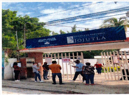
F1: Fachada Principal.
