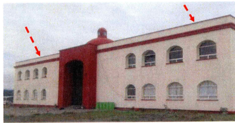
F1: Fachada principal de la E.E.S. de Tepalcingo
