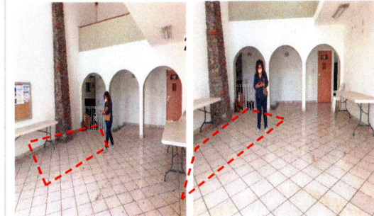
F5: Edificación de rampa en el vestíbulo de acceso a Auditorio del CITPsi, Unidad Los Volcanes.
