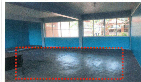
3.- Salón donde se colocará loseta.
