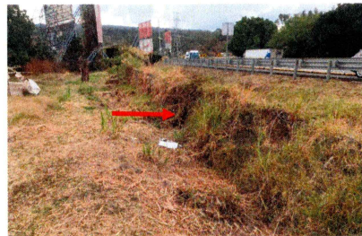
3.- Vista interior rea perimetral: retiro de malla existente deteriorada, deshierbe y limpieza del área, excavación y construcción de rodapié de mampostería de piedra, colocación de malla ciclónica con postes metálicos.
