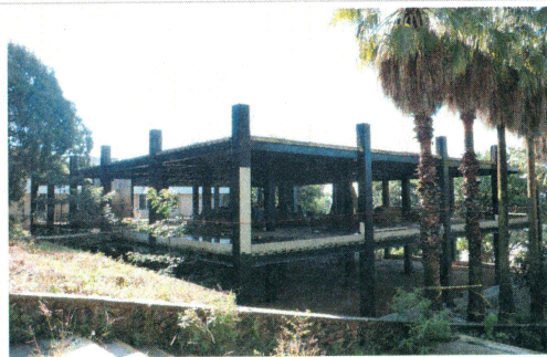
F3: Fachada Norte y Oeste - Construcción de la segunda etapa para la ampliación de laboratorios, cubículos de investigación, y oficinas académicas para el Centro de Investigaciones Biológicas antes CEIB (etapa final).
