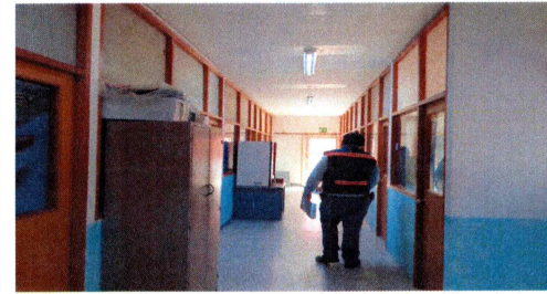
4.- Mantenimiento a red eléctrica: incluyendo colocación de luminarias y separación de circuitos
