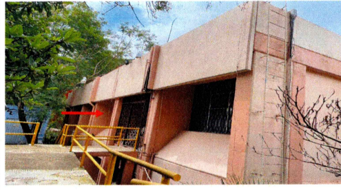
2.- Fachada Norte del Edificio donde se realizaran los trabajos.
