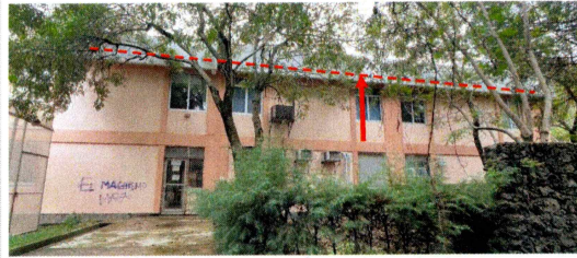
2.- Fachada lateral Este del CINCCO.
