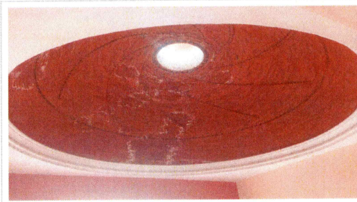
F4: Impermeabilización de Azotea y cupula
