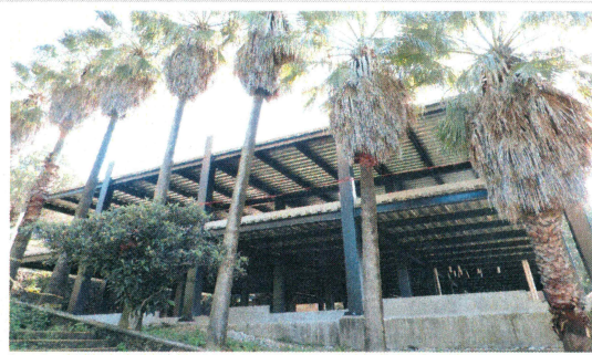
F7: Fachada Oeste -Construcción de la segunda etapa para la ampliación de laboratorios, cubículos de investigación, y oficinas académicas para el Centro de Investigaciones Biológicas antes CEIB (etapa final).
