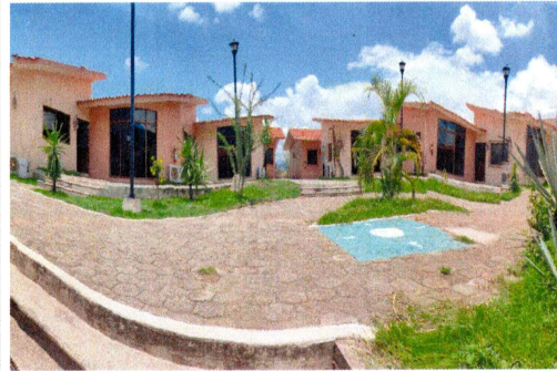
F2: Distribución Edificio 6 Y 7 Aire acondicionado.
