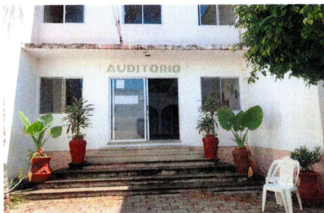
F3: Se realizará rampa en en Interior de auditorio.
