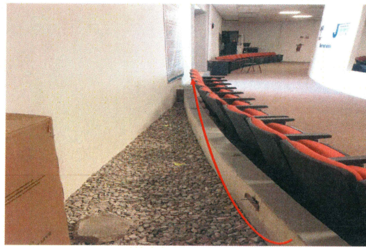
F6: Muro a base de placa de cemento durock.
