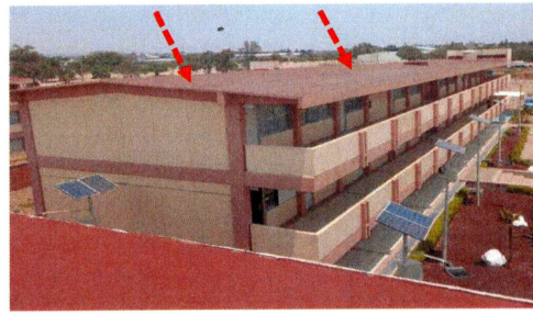
F2: Fachada lateral de edificio donde se realizarán los trabajos
