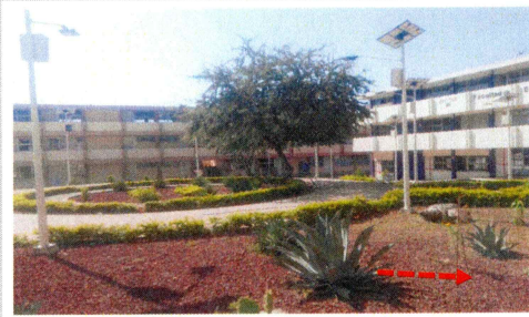
F1: Fachada principal de edificios de la Facultad de estudios superiores de Cuautla.
