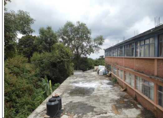
F2: Edificio Principal
