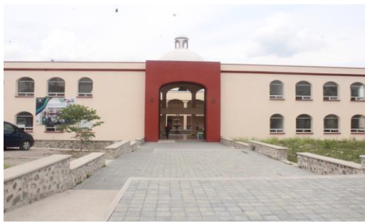
F1: Fachada principal
