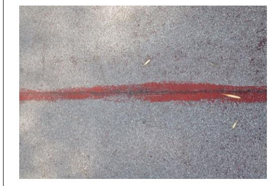
F4: Techo edificio 29
