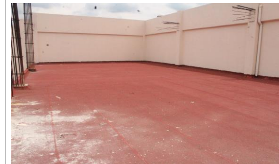
F5: Techo del edificio
