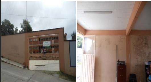
F1: Edificio Principal
