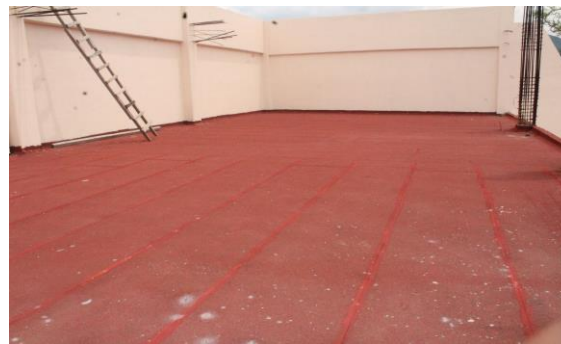
F2: Techo del edificio
