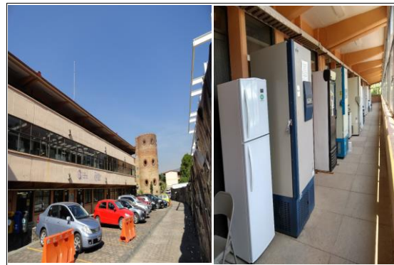
F4: Exterior del edificio
