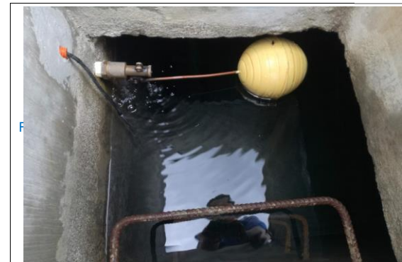
F5: Interior de cisterna
