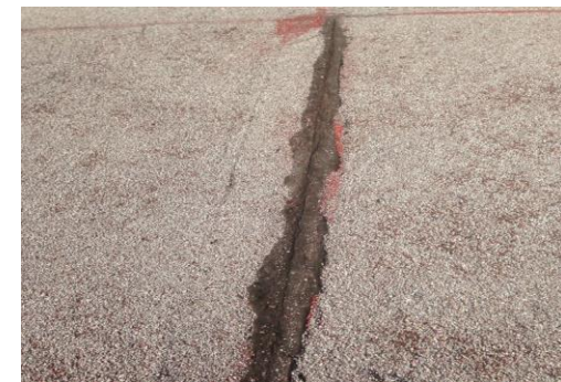
F5: Techo edificio 29
