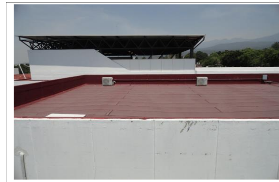
F5: Techo edificio 60
