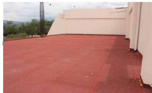
F4: Techo del edificio
