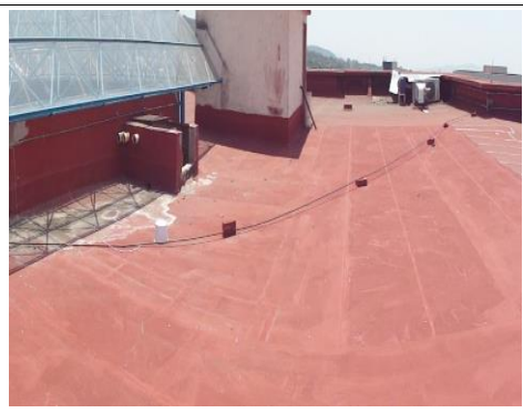
F3: Techo Edificio 49
