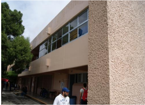
F1: Fachada principal
