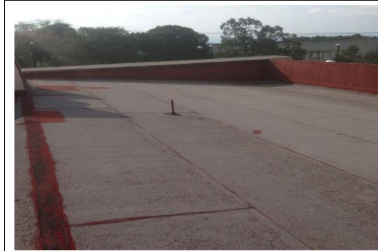
F2: Techo edificio 29
