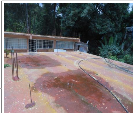
F3: Edificio Principal
