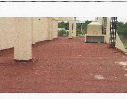
F3: Techo del edificio
