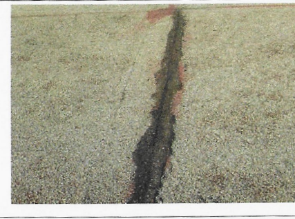
F5: Techo edificio 29
