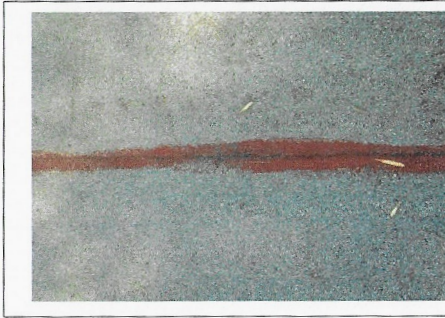
F4: Techo edificio 29
