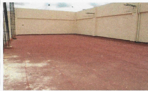
F5: Techo del edificio
