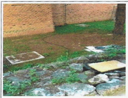
F3: Instalación sistema de tierras
