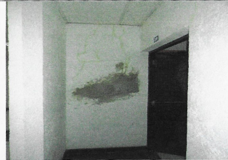
F2: Edificio 60 (interior)
