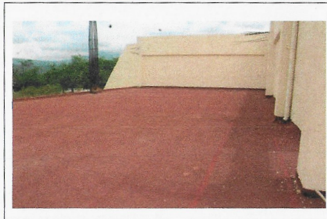
F4: Techo del edificio
