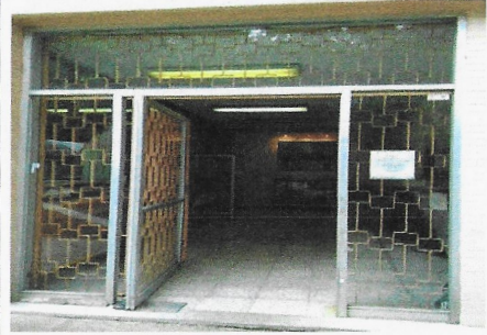
F1: Puerta de acceso (exterior)
