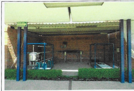
F5: Interior de sala (laboratorio)
