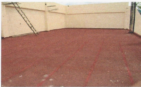
F2: Techo del edificio
