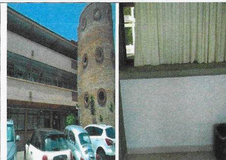
F1: Pintura de Edificio (interior y exterior)
