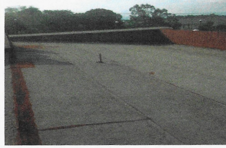
F2: Techo edificio 29
