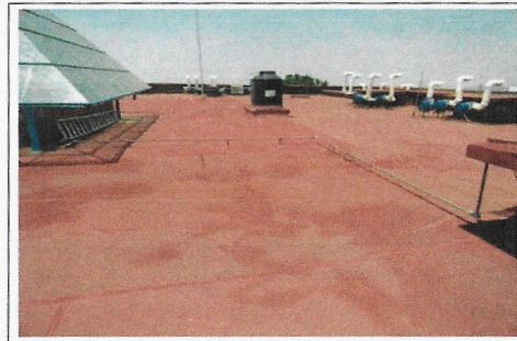
F4: Techo Edificio 49
