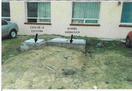
F1: Sistema hidráulico
