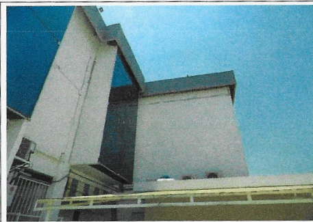
F1: Edificio 49 (exterior)
