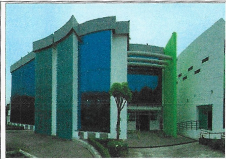
F1: Fachada principal edif. 49
