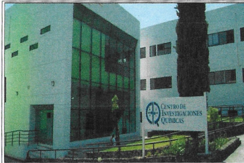
F2: Fachada Principal del Edificio 60
