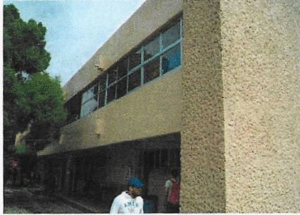
F1: Fachada principal
