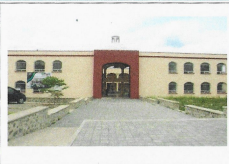
F1: Fachada principal
