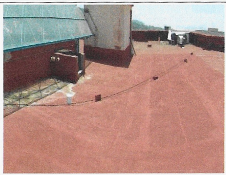
F3: Techo Edificio 49
