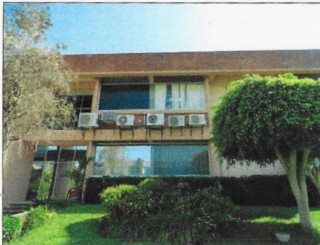
F3: Aires acondicionados
