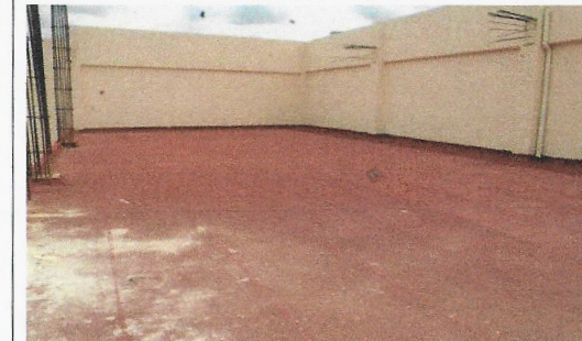
F5: Techo del edificio
