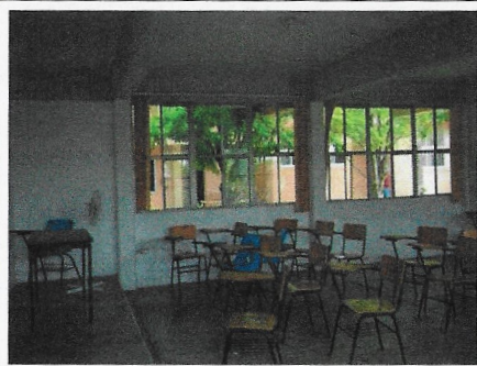
F3: Interior, ventanas aula
