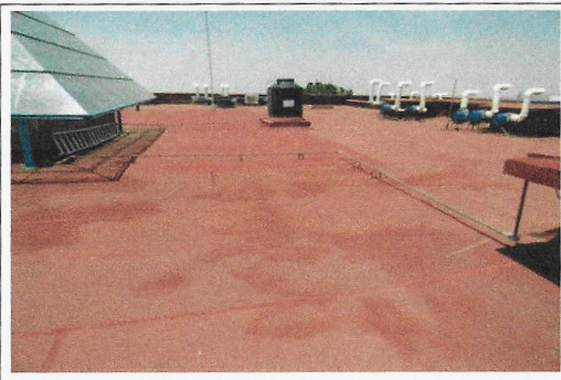
F4: Techo Edificio 49
