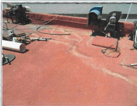
F3: Fachada posterior
