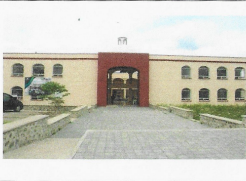
F1: Fachada principal
