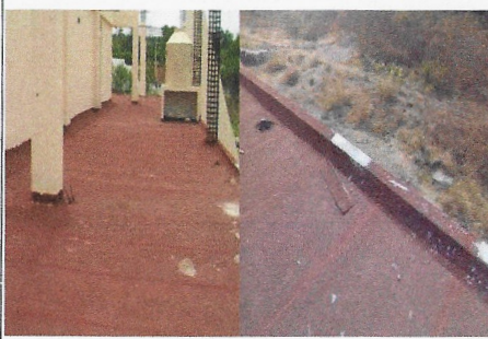
F3: Techo del edificio
