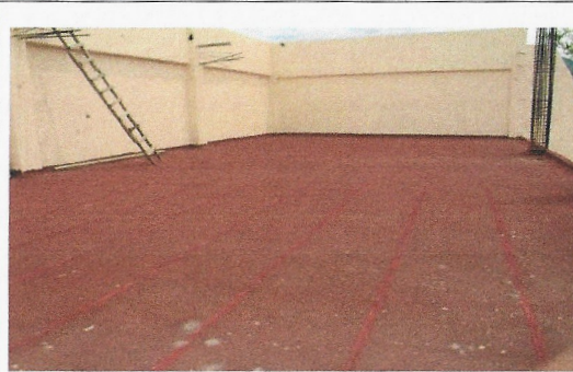
F2: Techo del edificio
