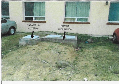
F1: Sistema hidráulico
