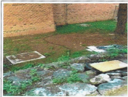
F3: Instalación sistema de tierras
