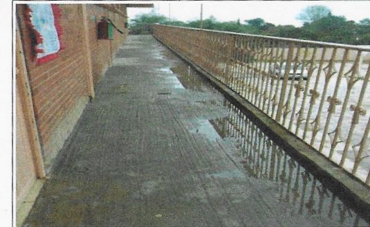
F5: Pasillo planta alta
