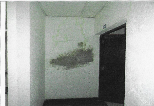
F2: Edificio 80 (interior)
