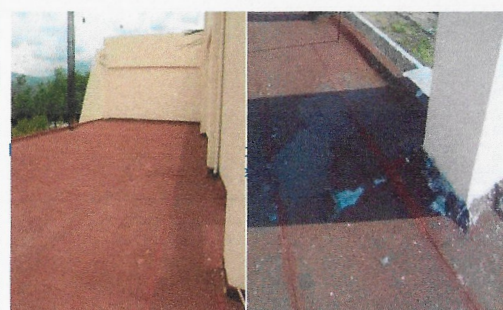
F4: Techo del edificio
