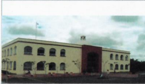
F1: Fachada principal
