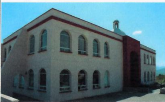
F1: Fachada principal
