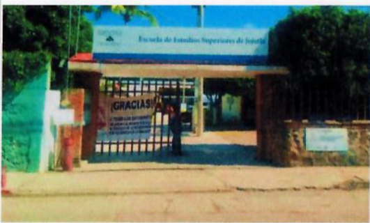
F1: Fachada principal
