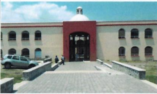
F1: Fachada principal
