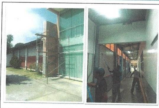
F7: TAMULBA: Sellado de fisuras en muros de fachada principal
