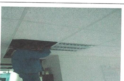
F14: Techo: colocación de lámpara en falso plafón
