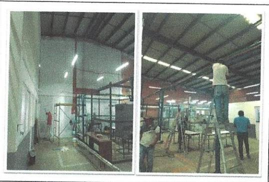
F11: LOU: Trabajos de aplicación de pintura vinílica en muros perimetrales al interior de la nave principal.
