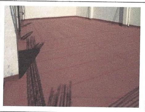
F20: Impermeabilización acrílica en azotea de segundo nivel del edificio
