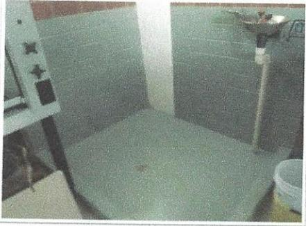
F33: Aplicación de pintura epóxica en muros y piso de área de lavajos y regadera, laboratorio primer nivel, edificio 35 FCO61
