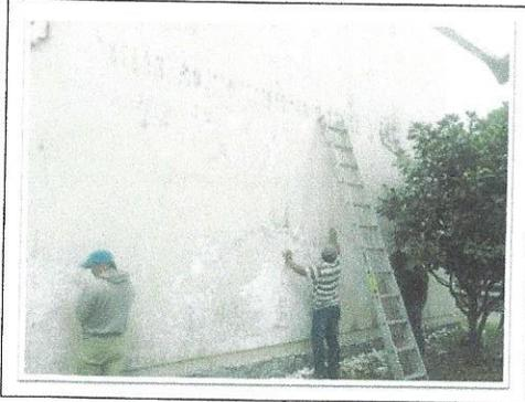
F6: TAMULBA: Limpieza de capas de pintura en mal estado sobre muros de fachada principal.
