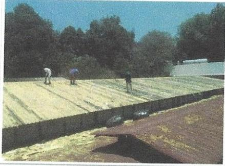
F6: Techo TAMULBA: retiro de material de espuma de poliuretano existente en mal estado, sobre cubierta metálica del edificio
