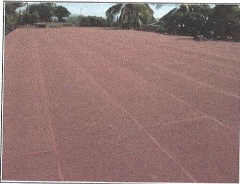
F20: Vista de los trabajos de suministro y colocación de impermeabilizante prefabricado en edificio 4
