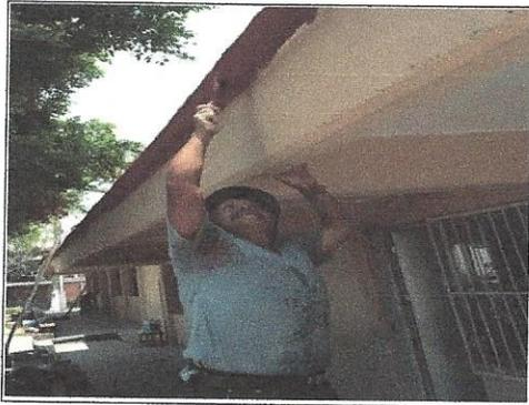
F17: Vista de los trabajos de suministro y aplicación de pintura vinílica acrílica edificio 4 y 3
