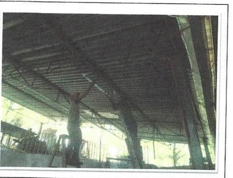
F14: Tamulba: Vista de los trabajos de retiro de luminarias existentes y colocación de luminarias ahorradoras de energía tipo LED.
