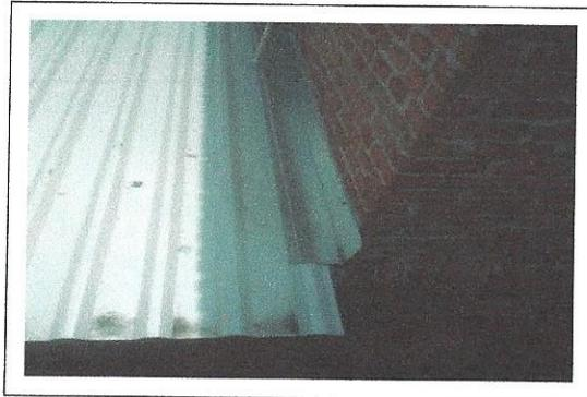
F16: J Moldura de lámina para evitar se trasmite el agua de lluvia
