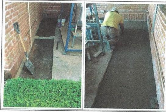
F7: Interior de aula (laboratorio) quitar adocreto, para colocar concreto acabado pulido y rayado (foto izquierda). Acabado al concreto ya terminado (foto derecha).
