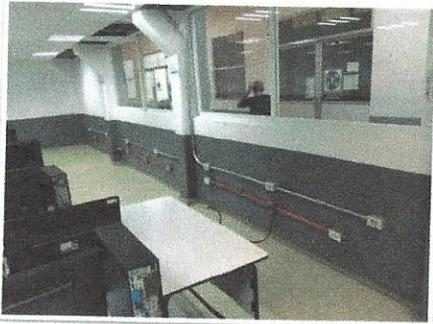
F21: TAMULBA-FCQel: trabajos de aplicación de pintura de esmalte en parte baja de muros así como en tuberías de instalaciones con diámetros variados.
