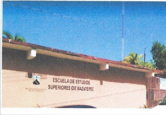
F1: Fachada principal
