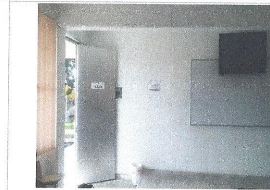
F5: Interior de aula
