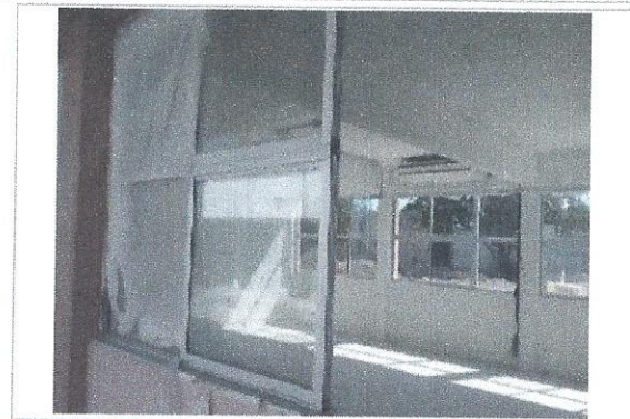
F5: Interior de aula
