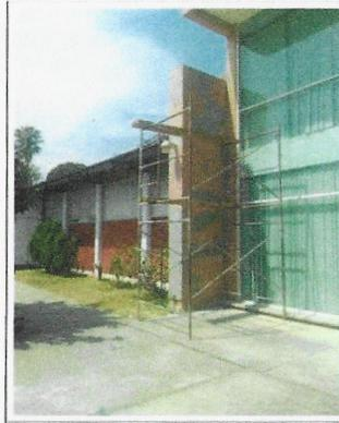
F7: TAMULBA: Sellado de fisuras en muros de fachada principal
