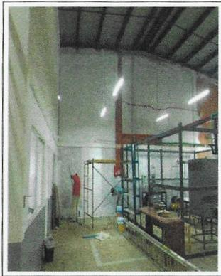
F11: LOU: Trabajos de aplicación de pintura vinílica en muros perimetrales al interior de la nave principal.
