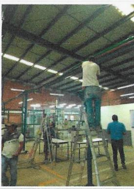
F12: LOU: Trabajos de aplicación de pintura de esmalte en tuberías interiores de instalaciones en diámetros varios.
