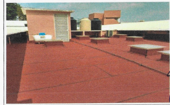
F14: Colocacion de membrana de impermeabilizante prefabricado en losa de acceso oeste.
