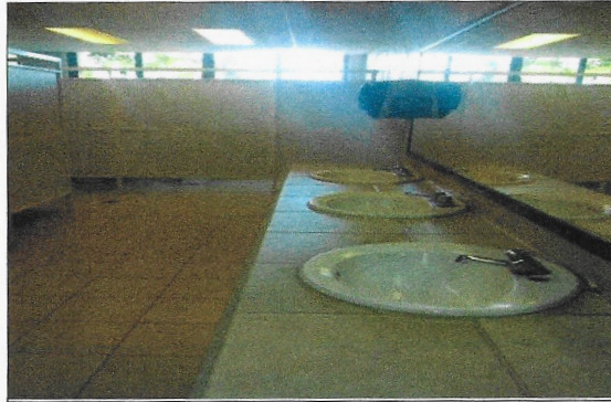
F16: Rehabilitación de sanitarios terminados. (sanitarios mujeres)
