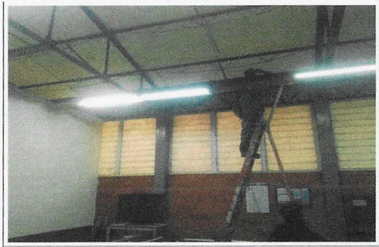
F15: Trabajos de retiro de luminarias en laboratorios de TAMULBA.
