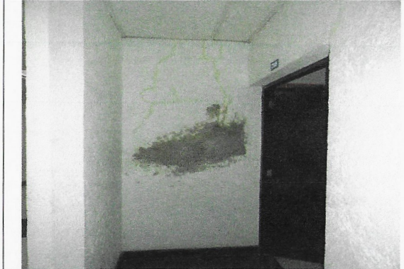
F2: Edificio 60 (interior)
