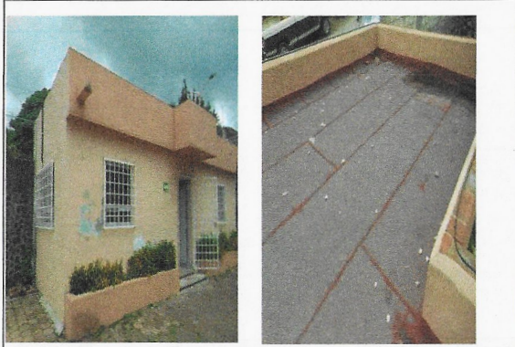
F1: Edificio de Dirección
