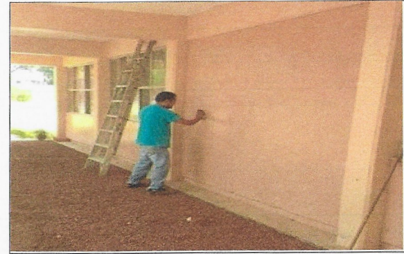
F16: Vista de los trabajos de preparación de la superficie para suministro y aplicación de pintura vinílica acrílica edificio 4 y 3
