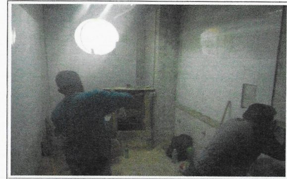
F8: Sanitarios: Colocación de azulejo en proceso.
