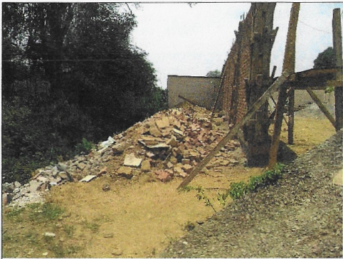
F8: Muro de colindancia en proceso
