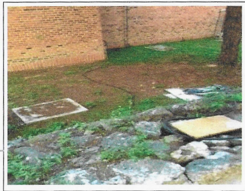
F3: Instalación sistema de tierras
