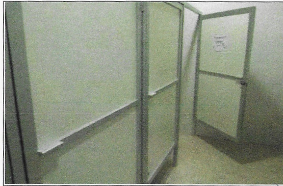
F9: Sanitarios: colocación de mamparas existentes (baño hombres)
