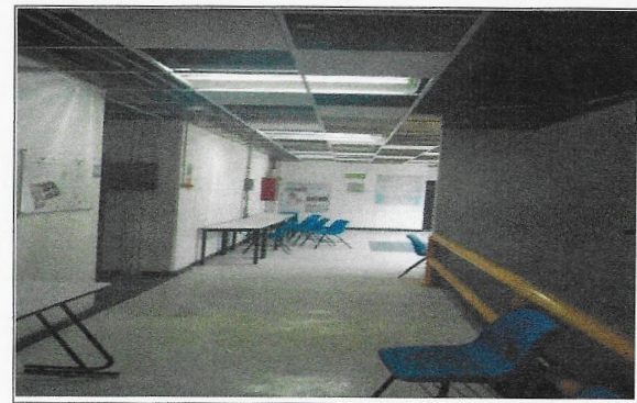
F11: Colocación de falso plafón.
