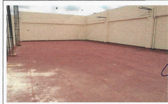
F5: Techo del edificio
