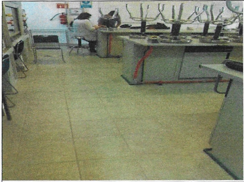
F15: Cambio de piso en laboratorio de biología, terminado.
