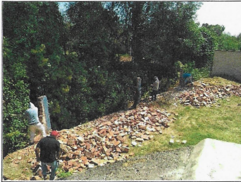
F5: Demolición de muro dañado
