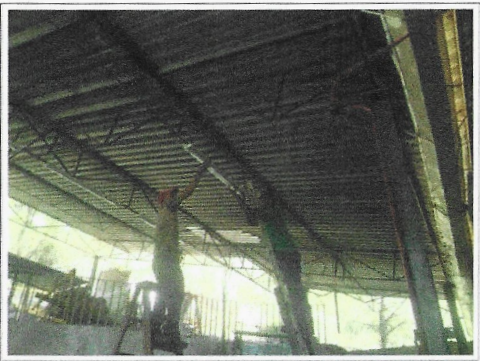
F14: Tamulba: Vista de los trabajos de retiro de luminarias existentes y colocación de luminarias ahorradoras de energía tipo LED.
