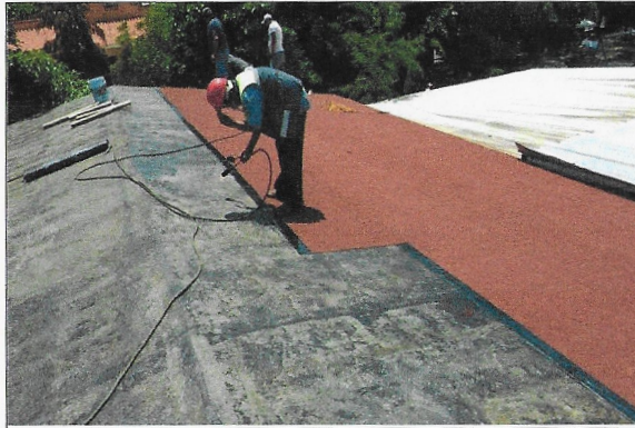
F2: Colocación de impermeabilización
