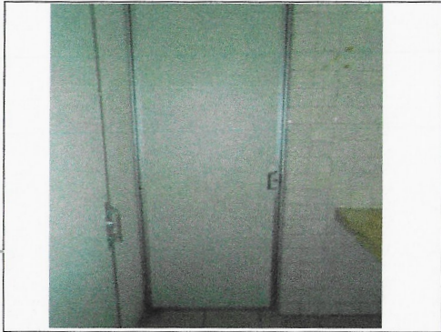
F6: Colocación de puertas
