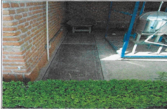
F10: Firma de concreto pulido y rayado terminado
