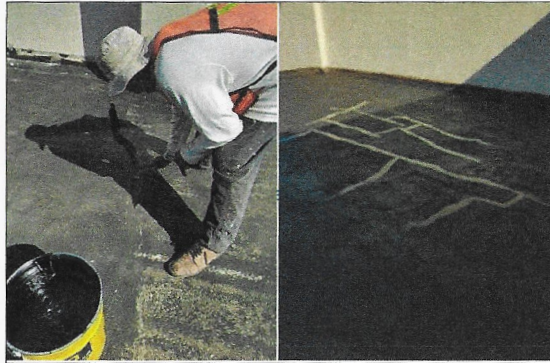
F15: Techo del edificio; Vista de los trabajos de calafateo en grietas de losa
