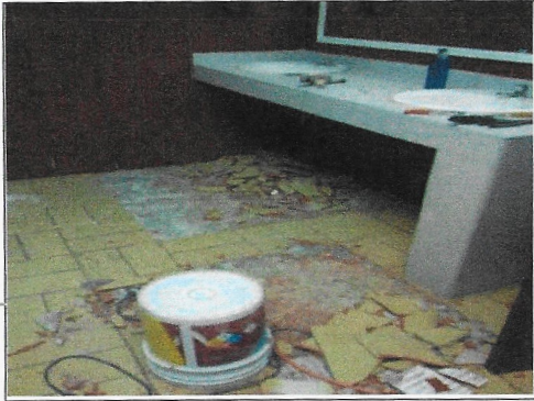
F6: Sanitarios: demolición de piso
