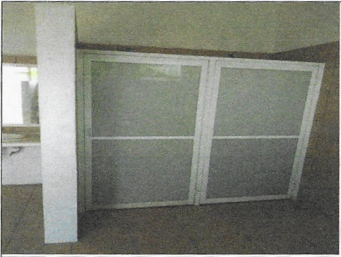
F9: Rehabilitación de sanitarios terminado
