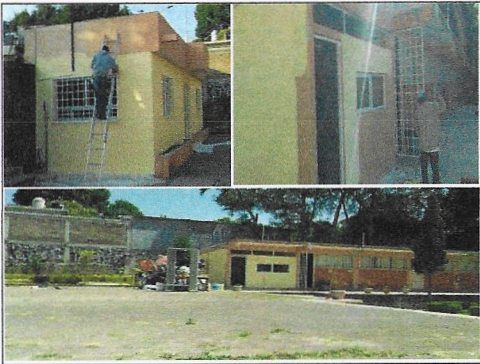
F6: Aplicación de pintura.
