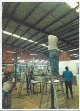
F12: LOU: Trabajos de aplicación de pintura de esmalte en tuberías interiores de instalaciones en diámetros varios.
