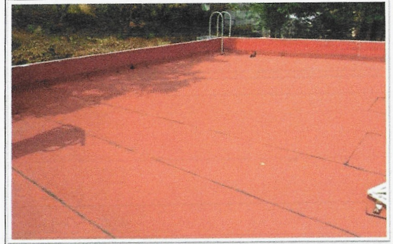
F17: Imagen de trabajos concluidos de impermeabilización con membrana prefabricado hacia fachada norte de anexo TAMULBA.
