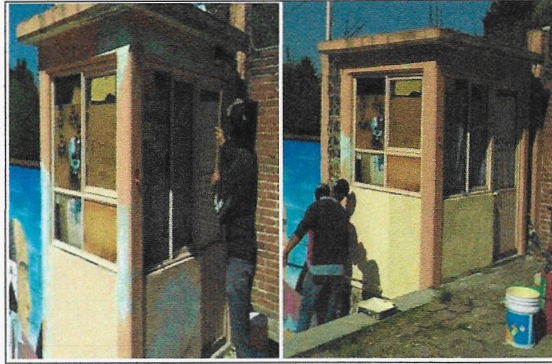
F7: Aplicación de pintura.
