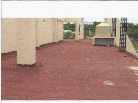
F3: Techo del edificio
