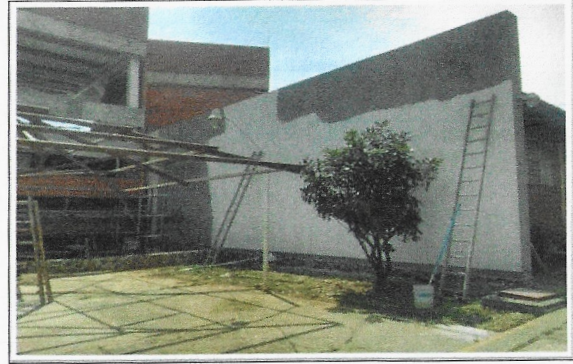
F9: TAMULBA: Aplicación de pintura en muros de fachada con preparación previa para recibir trabajos.
