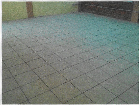
F6: Aulas: loseta de piso colocado en aulas didácticas
