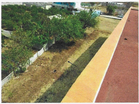
F6: El alimentador eléctrico está en proceso de construcción, que dará energía a las dos cisternas que se están construyendo
