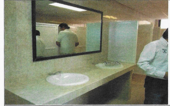
F17: Rehabilitación de sanitarios terminados. (sanitarios hombres)
