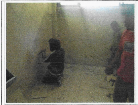
F9: Sanitarios: demolición de azulejo.
