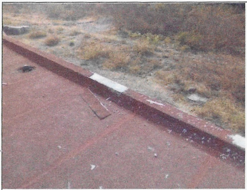
F9: Techo del edificio
