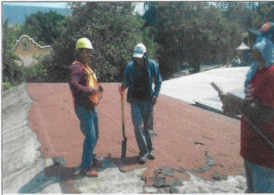
F1: Retiro de impermeabilización existente
