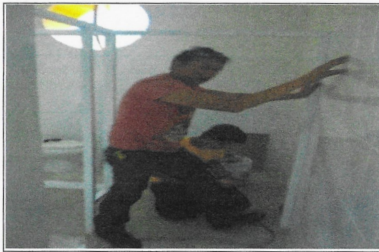
F10: Sanitarios: suministro y colocación de mamparas de aluminio (mujeres)
