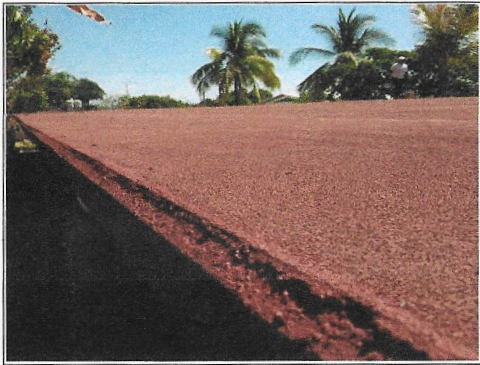
F23: Techo: Vista de los trabajos generales de impermeabilización.
