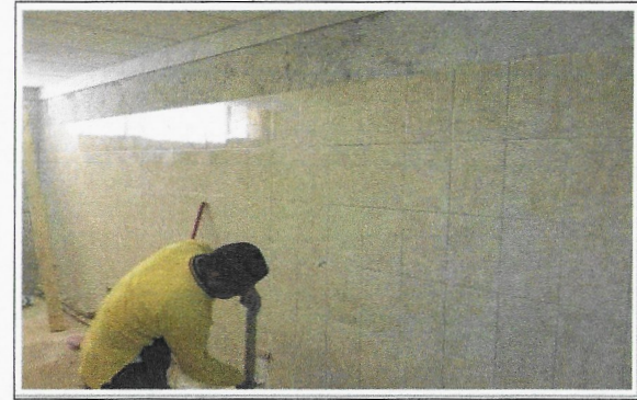
F11: Sanitarios: Colocación azulejo
