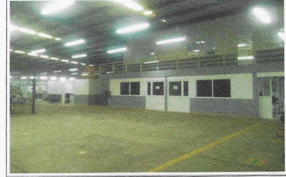
F22: LOU: trabajos de aplicación de pintura vinílica y de esmalte en áreas comunes interiores de edificio.
