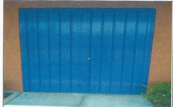
F11: Puerta de lámina acanalada terminada
