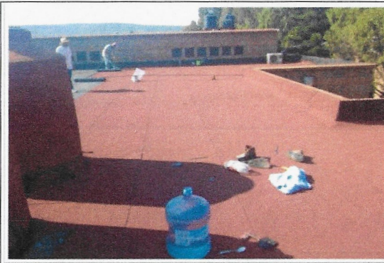
F4: Aplicación de Impermeabilizante, en proceso.
