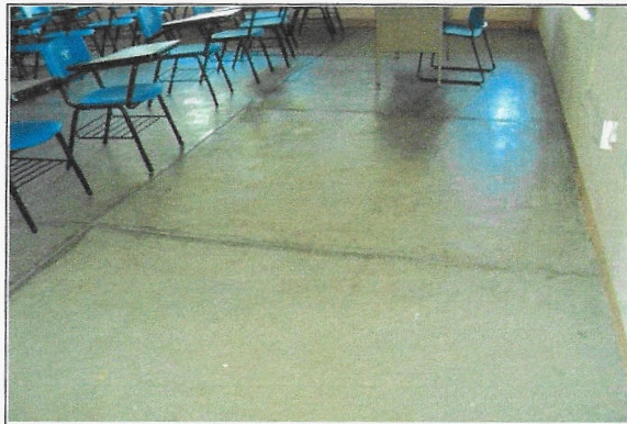
F2: Laboratorio E-6 y E-7 para colocación de loseta en el piso
