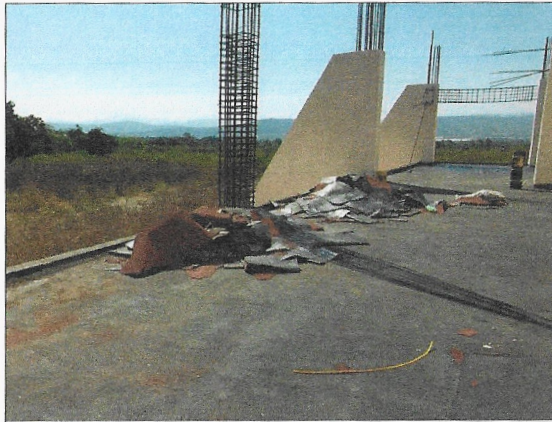
F12: Retiro de impermeabilizante prefabricado
