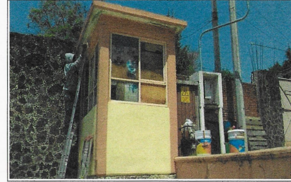
F8: Aplicación de pintura.
