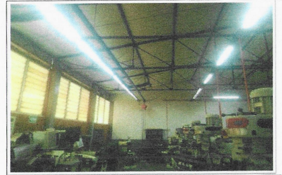
F25: Trabajos de aplicación de pintura vinílica y de esmalte en muros interiores.
