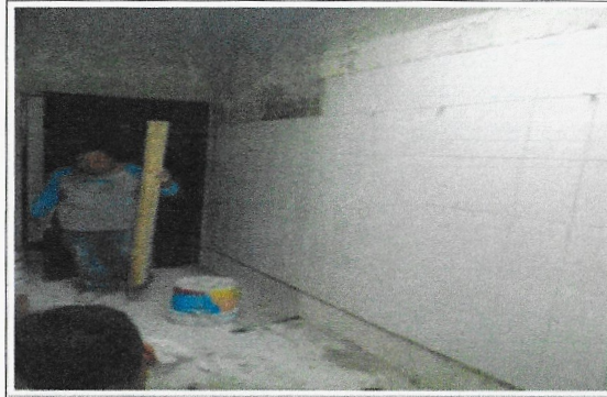
F7: Sanitarios: Colocación de azulejo en proceso.
