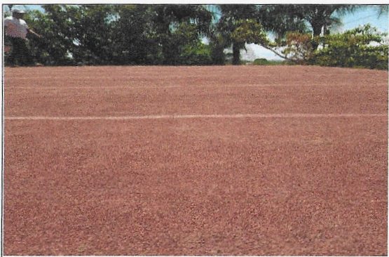
F21: Vista de los trabajos de suministro y colocación de impermeabilizante prefabricado en edificio 3-A
