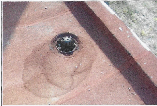
F10: Techo del edificio
