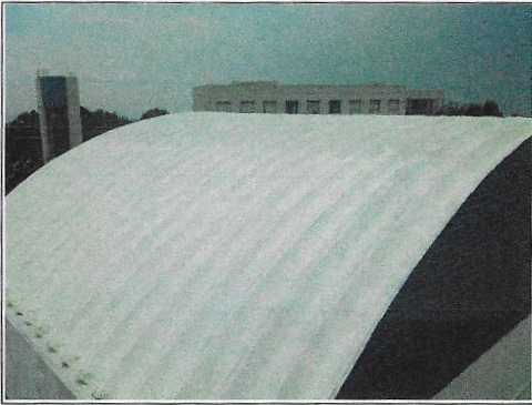
F6: Techo Edificio 49, impermeabilización con pintura elastométrica en arco techo
