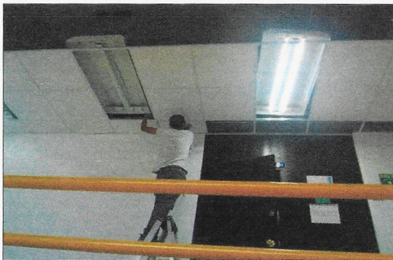
F13: Techo: suministro y colocación de galletas de falso plafón
