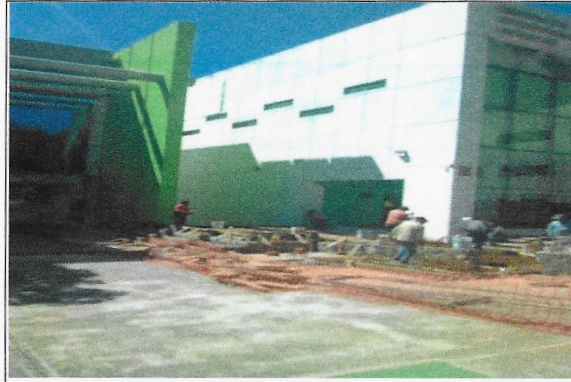
F2: Fachada Principal del Edificio 60
