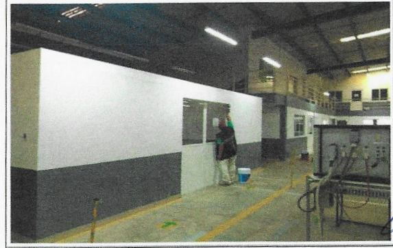
F13: LOU: Trabajos de aplicación de pintura vinílica y de esmalte en muros interiores.
