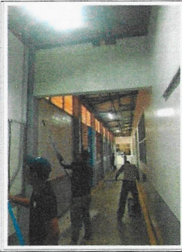
F8: TAMULBA: Aplicación de pintura vinílica y de esmalte en muros interiores de edificio.
