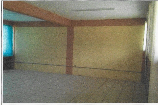
F7: Aula pintada y loseta de piso colocado
