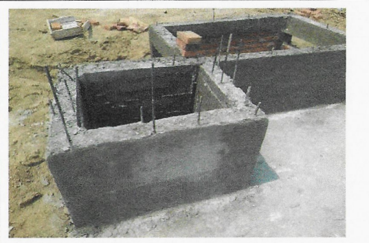
F10: Trabajos en el carcamo seco y paso de las dos cisternas
