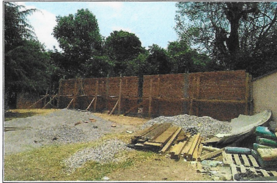
F6: Muro de colindancia en proceso
