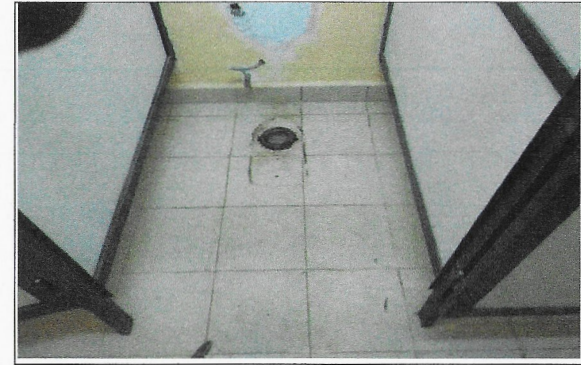
F11: Se desmontan muebles sanitarios
