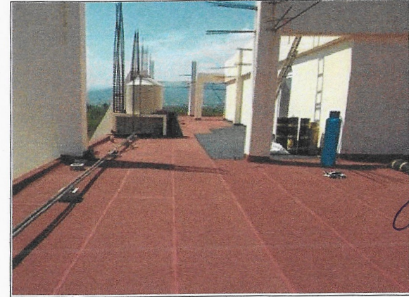
F13: Suministro y colocación de impermeabilizante prefabricado en losa
