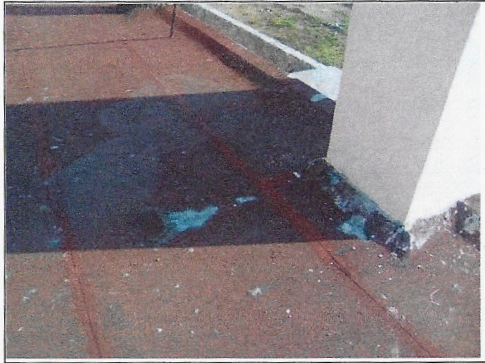
F6: Techo del edificio
