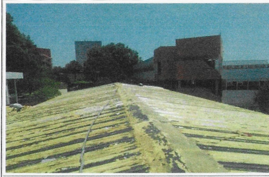
F7: Techo TAMULBA: Retiro de material deteriorado sobre laminas metálicas y cumbreira de cubierta, lado sur de edificio
