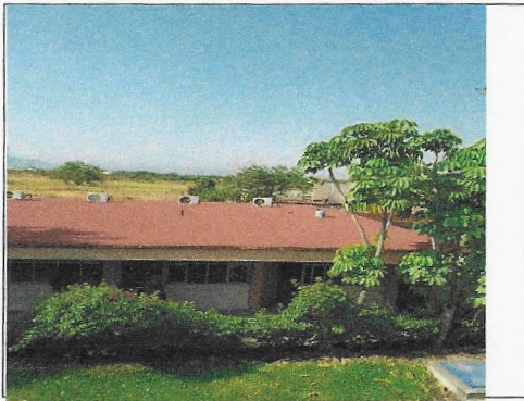
F6: Trabajos de impermeabilización terminados
