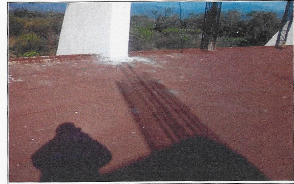
F8: Techo del edificio
