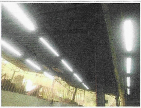
F23: Imagen de los trabajos concluidos de colocación de luminarias ahorradoras de energía tipo LED, en taller de TAMULBA.
