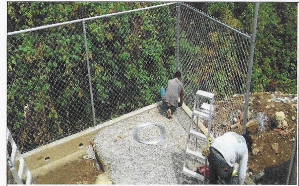
F10: Colocación de malla colindante, en proceso
