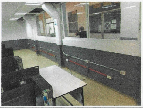
F20: TAMULBA-FCQel: trabajos de aplicación de pintura de esmalte en parte baja de muros así como en tuberías de instalaciones con diámetros variados.
