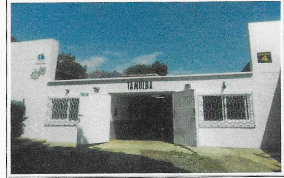
F19: TAMULBA-FCQel: Trabajos terminados de aplicación de pintura vinílica en muro y pintura de esmalte en puertas y protecciones de ventana.
