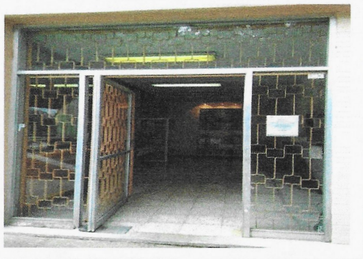
F1: Puerta de acceso (exterior)
