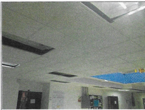
F12: Techo: suministro y colocación de falso plafón
