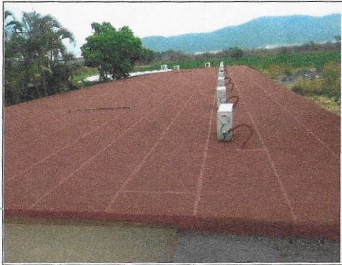
F3: Trabajos de impermeabilización terminados
