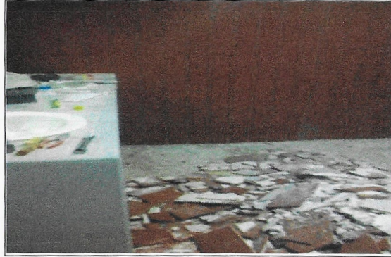
F7: Sanitarios: demolición de azulejo
