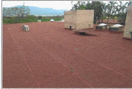
F4: Trabajos de impermeabilización terminados
