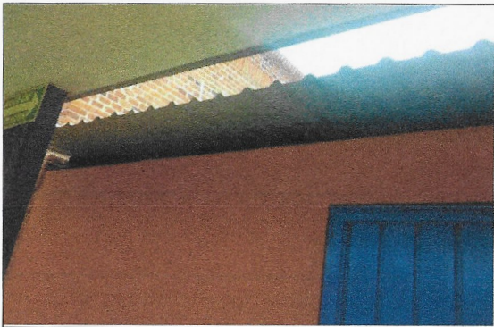
F13: Techumbre de lámina galvanizada prepintada a fuego
