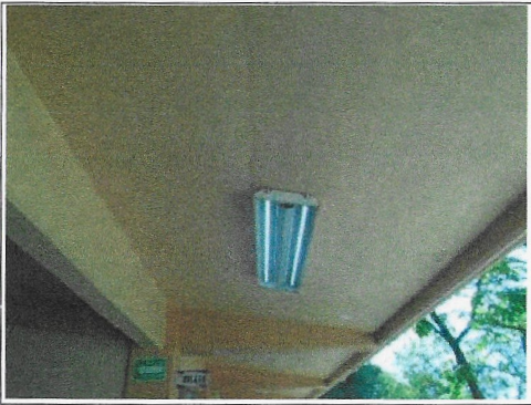
F6: Aulas, colocación de luminarias
