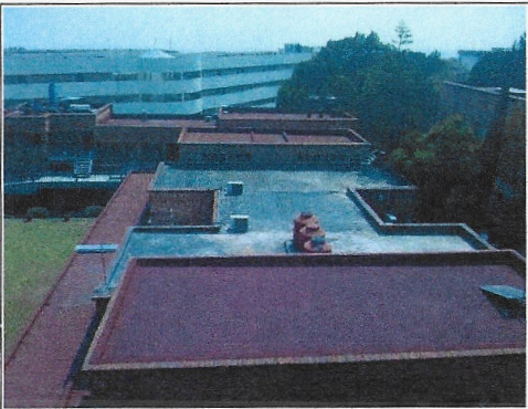
F3: Superficie preparada para recibir Impermeabilizante.
