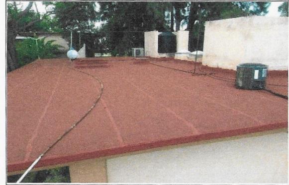
F5: Trabajos de impermeabilización terminados
