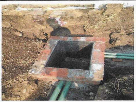
F9: Alimentador eléctrico de las dos cisternas
