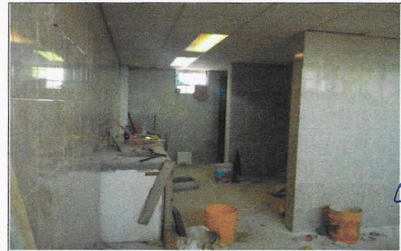
F14: Sanitarios: colocación de piso y azulejo en proceso (baño de mujeres)
