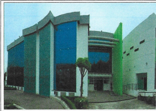
F1: Fachada principal edif. 49
