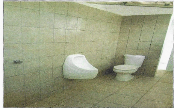
F11: Rehabilitación de sanitarios terminado
