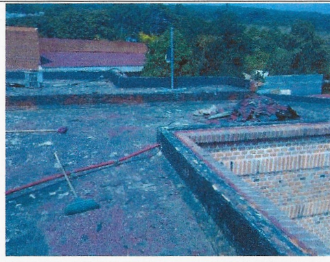
F2: Retiro de Impermeabilizante anterior.
