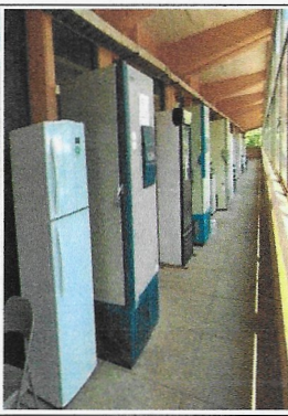
F5: Equipos de refrigeración y aires acondicionados.
