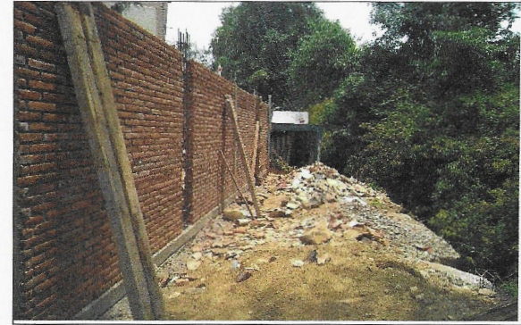
F7: Muro de colindancia en proceso
