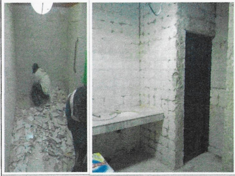
F6: Sanitarios: demolición de azulejo y piso.
