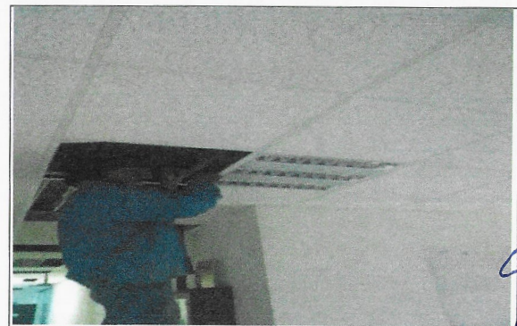
F14: Techo: colocación de lámpara en falso plafón
