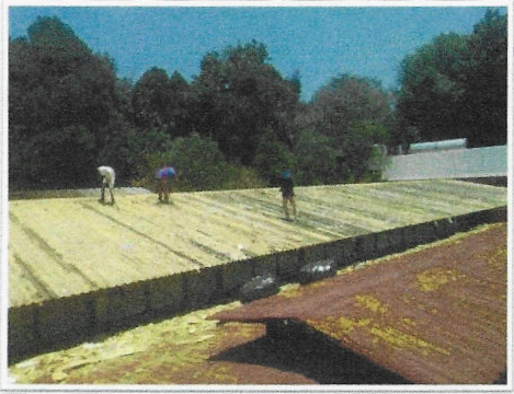
F6: Techo TAMULBA: retiro de material de espuma de poliuretano existente en mal estado, sobre cubierta metálica del edificio
