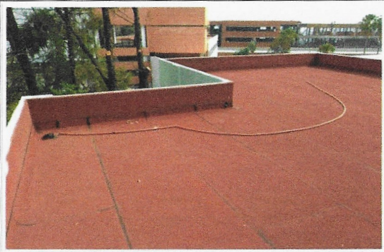
F16: Vista general de los trabajos terminados de impermeabilización prefabricado en losa de anexo TAMULBA.
