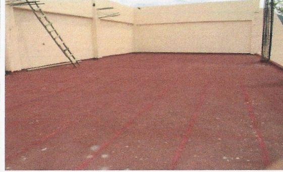
F2: Techo del edificio
