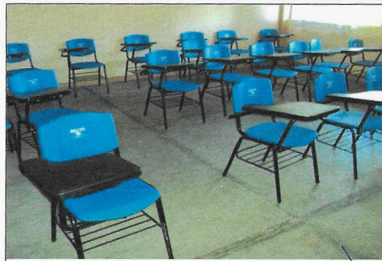
F4: Interior Laboratorio E-6 para colocación de loseta en el piso
