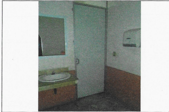
F7: Colocación de puertas
