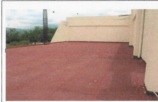
F4: Techo del edificio
