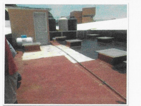
F12: Retiro de Impermeabilizante deteriorado existente en cubierta de losa de acceso oeste a TABULBA.
