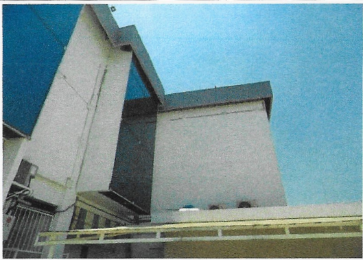
F1: Edificio 49 (exterior)
