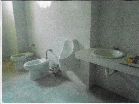
F15: Azulejo, piso, sanitarios con fluxómetro de pedal, mingitorio ecológico y barra con oballines, todo nuevo (hombres)
