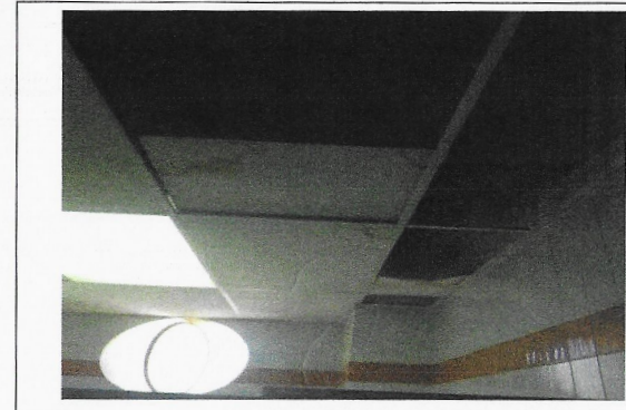
F5: Techo (Plafón)
