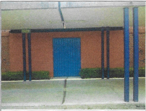
F12: Pintura vinilica en muro de durock nuevo
