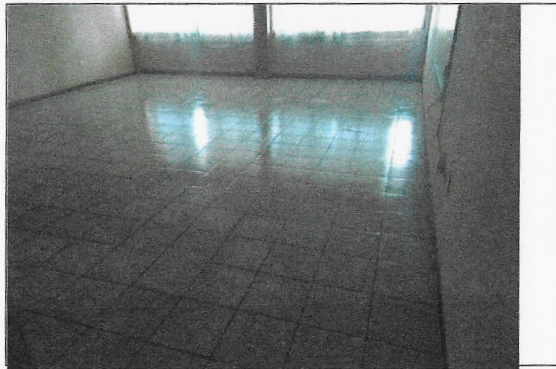
F7: Colocación de loseta en aulas terminado
