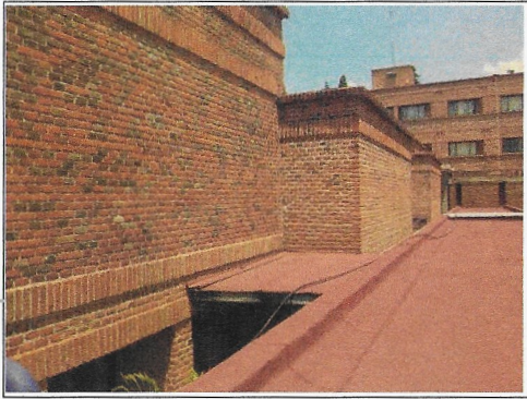
F6: Fachada principal limpia y barnizada
