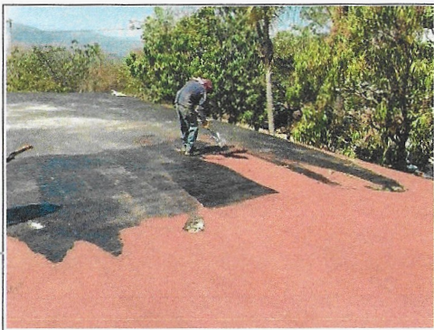
F11: Retiro de impermeabilizante prefabricado en edificio 2
