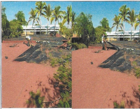
F8: Trabajos de retiro de impermeabilizante prefabricado en edificio 4.
