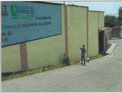
F9: Fachada principal de la sede, se aplica pintura.
