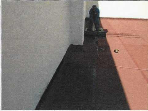
F14: Techo del edificio; suministro y colocación de impermeabilizante prefabricado
