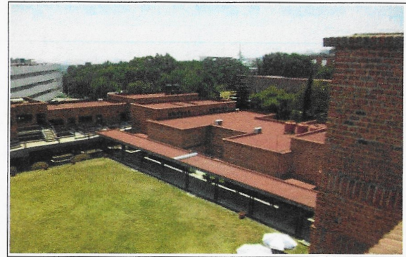
F8: Impermeabilizante terminado
