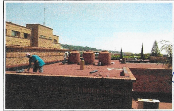
F5: Aplicación de Impermeabilizante, en proceso.
