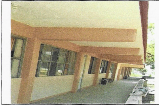
F24: Suministro y aplicación de pintura vinílica acrílica edificio 4 y 3
