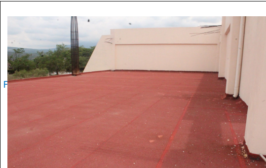
F4: Techo del edificio
