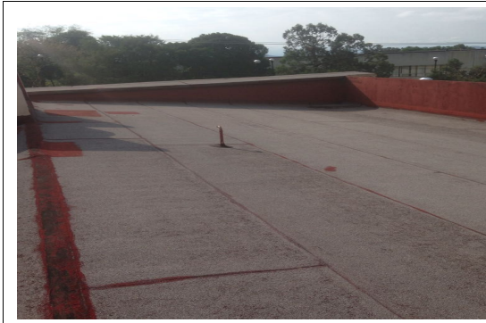
F2: Techo edificio 29
