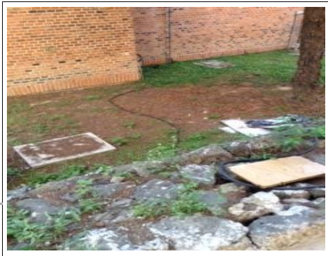
F3: Instalación sistema de tierras
