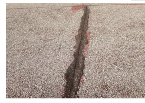
F5: Techo edificio 29
