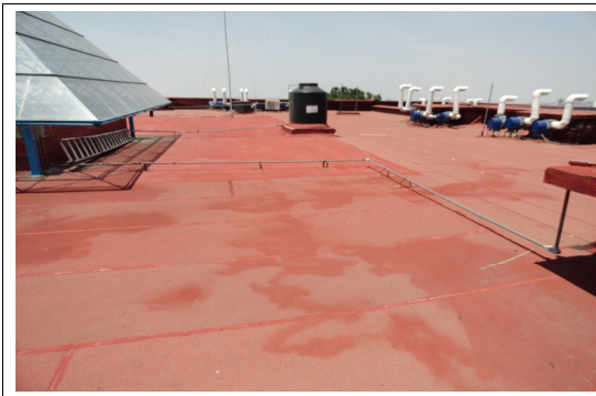
F4: Techo Edificio 49
