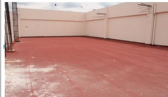
F5: Techo del edificio
