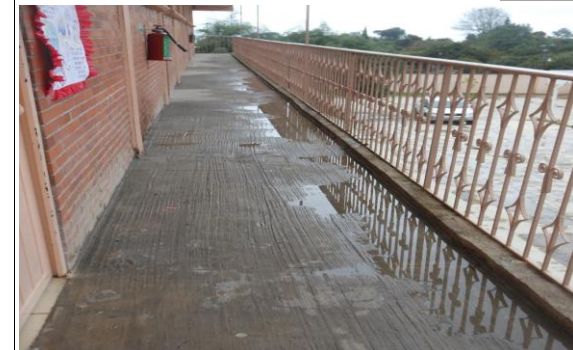
F5: Pasillo planta alta
