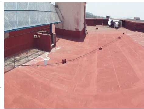
F3: Techo Edificio 49
