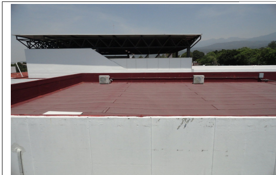
F5: Techo edificio 60
