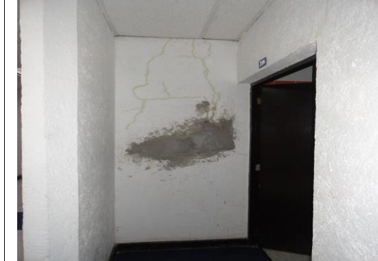
F2: Edificio 60 (interior)
