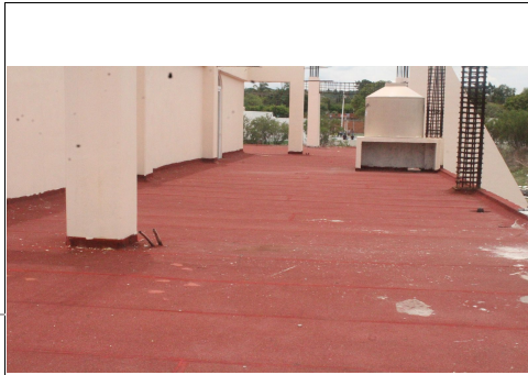
F3: Techo del edificio
