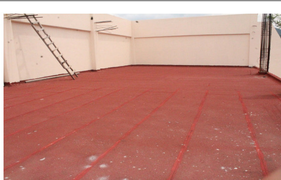
F2: Techo del edificio
