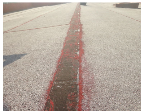
F3: Techo edificio 29
