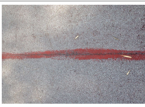
F4: Techo edificio 29
