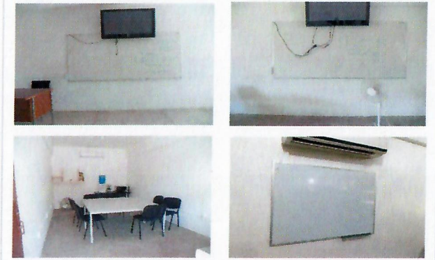
F17: Instalación de Pizarrones en Aulas, sala de reuniones y Biblioteca.
