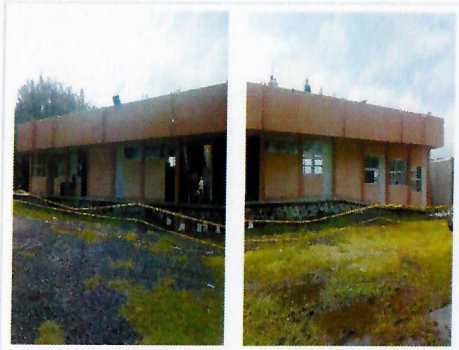
F6: Estado actual del inmueble.
