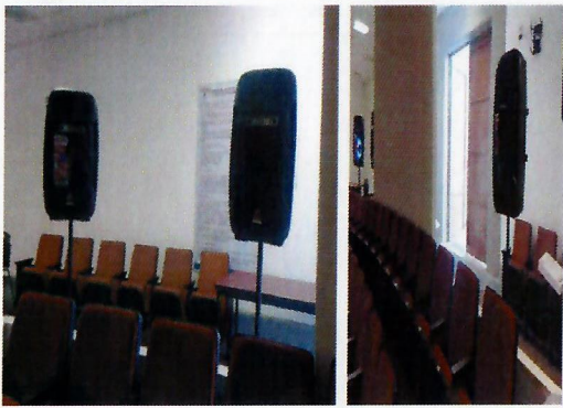
F22: Baffles instalados
