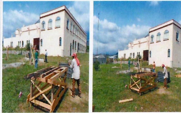
F7: Habilitado de acero para contrafuertes.
