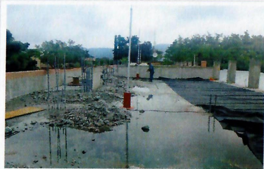
F8: Demolición de concreto pobre que recubría al acero de columnas.
