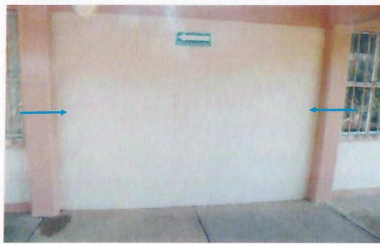
F7: Se colocaran Lockers en Pasillo edificio 3
