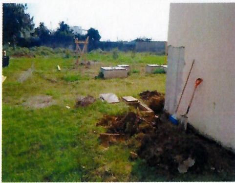
F9: Excavación para contrafuertes.
