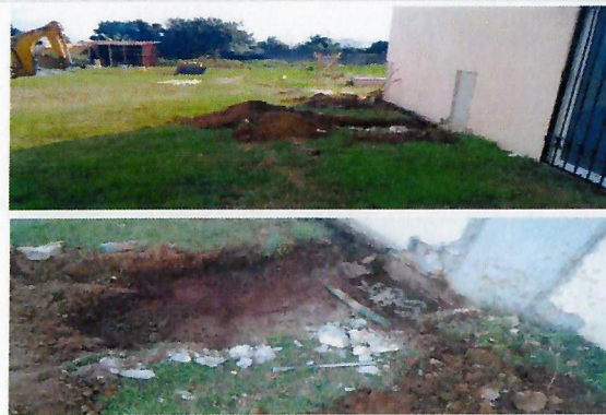
F10: Excavación para contrafuertes.
