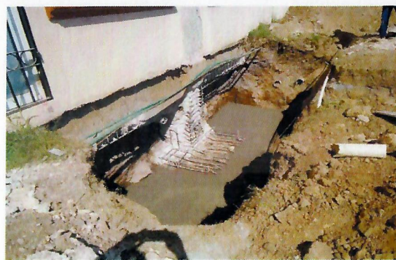
F13: Plantilla de concreto.
