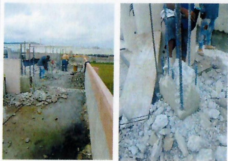
F10: Demolición de concreto pobre que recubría al acero de columnas.
