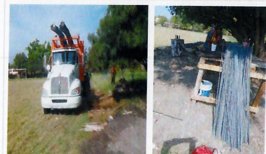
F12: Suministro y habilitado de acero.
