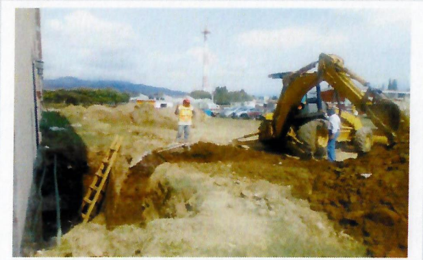
F11: Excavación de terreno
