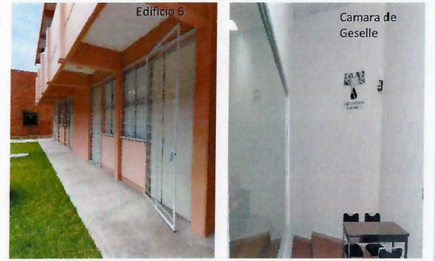
F11: Se colocarán extintores en Edificio 6 y Camara de Geselle.
