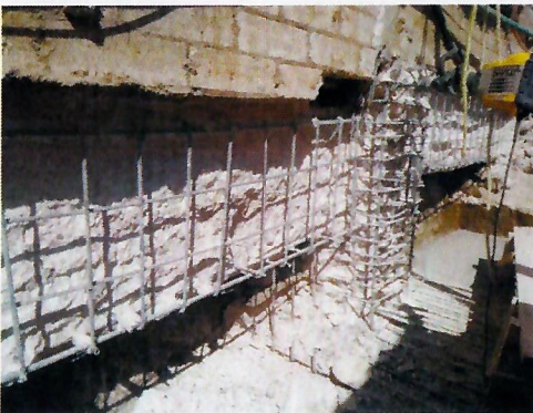
F12: Demolición de elementos estructurales para empotramiento en cimentación.
