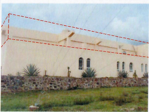
F3: Fachada posterior
