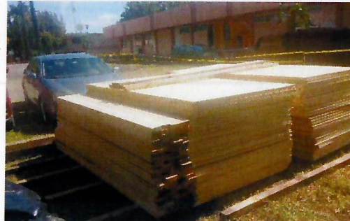
F11: Suministro de madera para cimbra.
