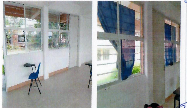
F14: Se colocaran 56 persianas en las aulas de los edificios 6 ,12 y 13.
