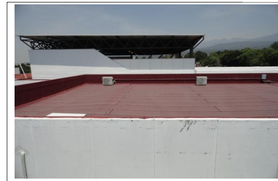
F5: Techo edificio 60
