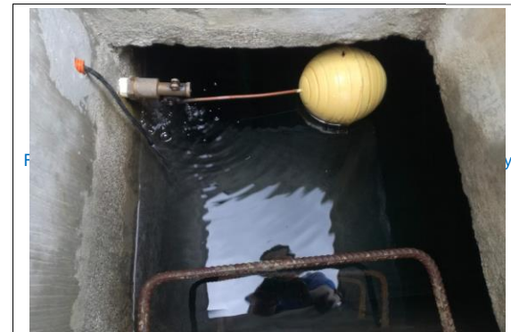
F5: Interior de cisterna
