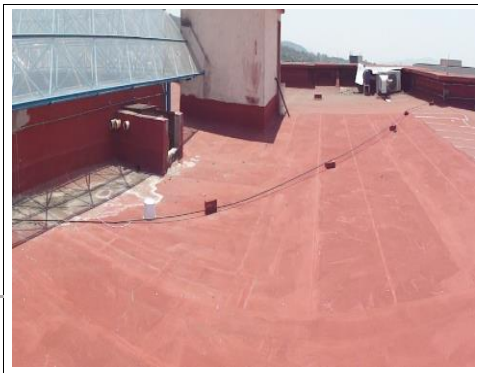
F3: Techo Edificio 49
