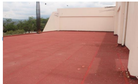
F4: Techo del edificio
