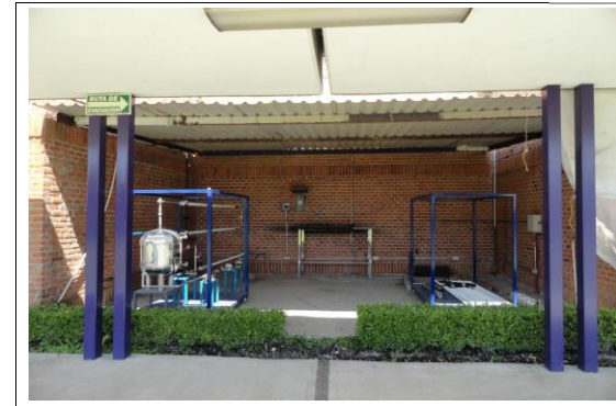
F5: Interior de aula (laboratorio)
