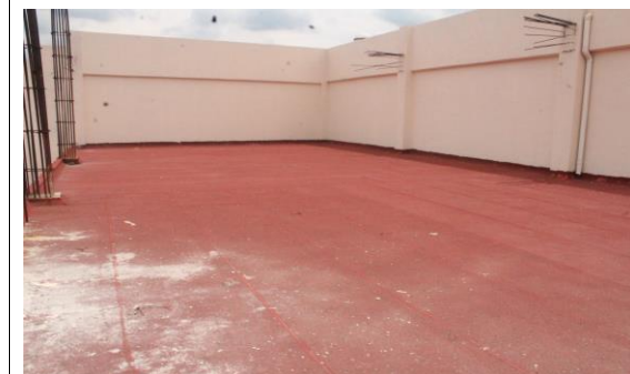
F5: Techo del edificio
