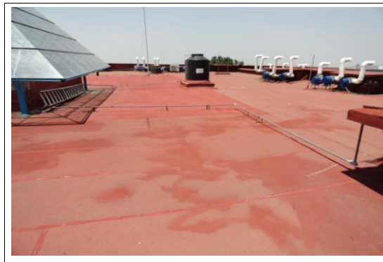
F4: Techo Edificio 49
