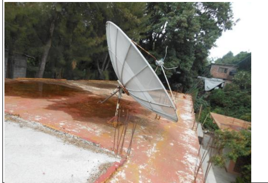
F4: Centro de Cómputo
