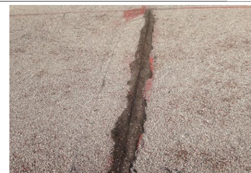
F5: Techo edificio 29
