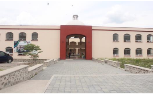
F1: Fachada principal
