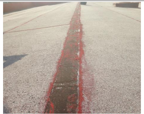
F3: Techo edificio 29
