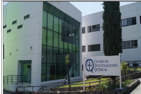
F2: Fachada Principal del Edificio 60
