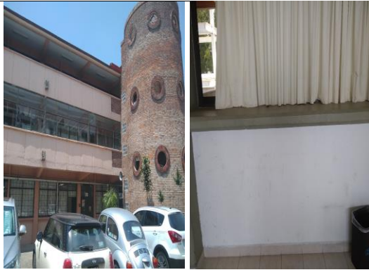
F1: Pintura de Edificio (interior y exterior)
