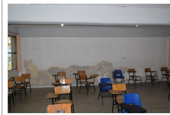
F2: Interior de aula
