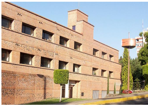
F1: Fachada principal
