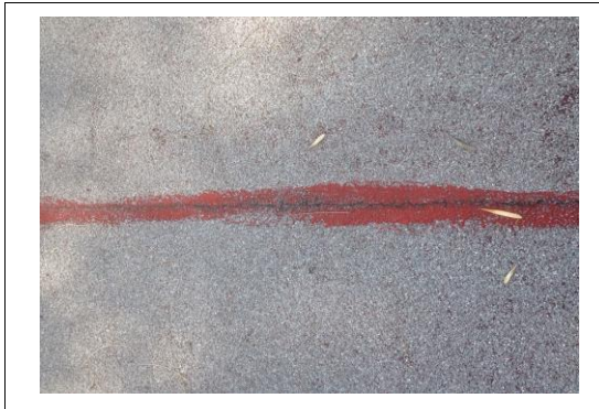
F4: Techo edificio 29
