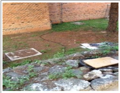
F3: Instalación sistema de tierras
