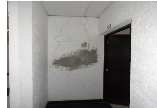
F2: Edificio 60 (interior)
