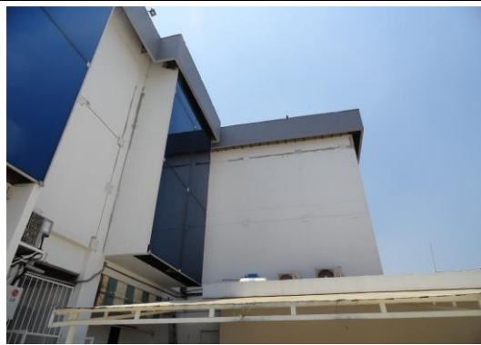
F1: Edificio 49 (exterior)
