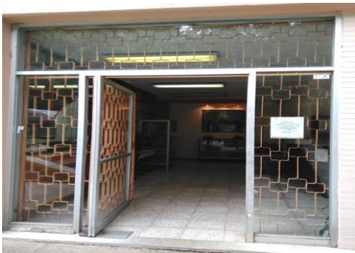
F1: Puerta de acceso (exterior)
