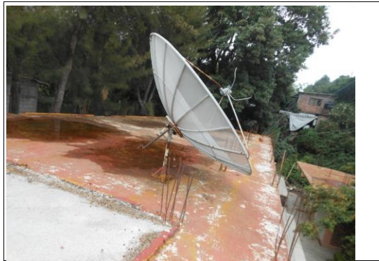
F4: Centro de Cómputo
