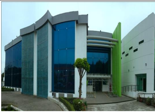
F1: Fachada principal edif. 49
