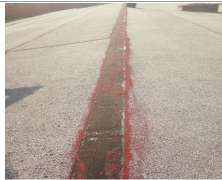
F3: Techo edificio 29
