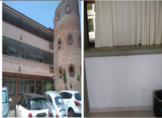
F1: Pintura de Edificio (interior y exterior)
