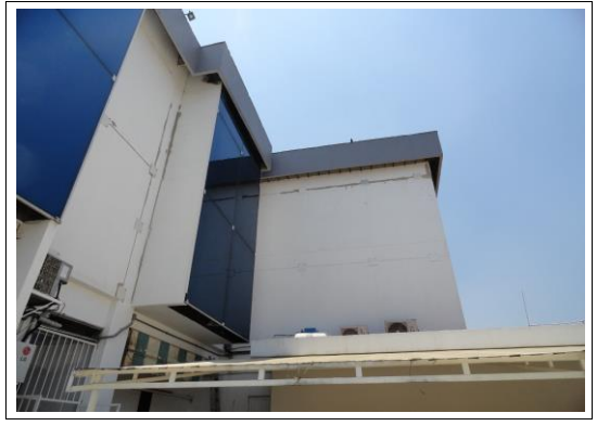
F1: Edificio 49 (exterior)
