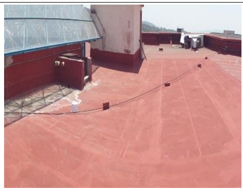
F3: Techo Edificio 49
