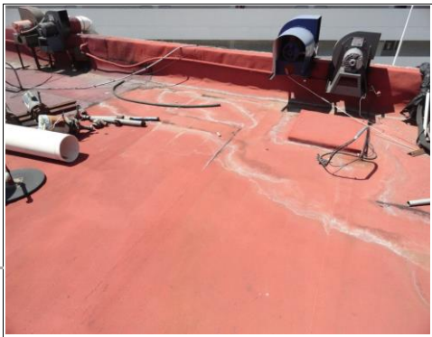
F3: Fachada posterior
