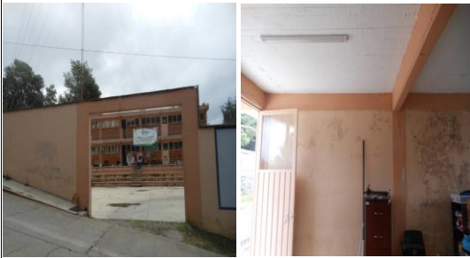
F1: Edificio Principal
