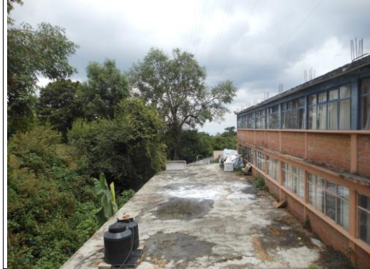
F2: Edificio Principal
