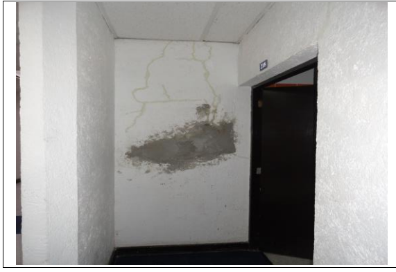
F2: Edificio 60 (interior)
