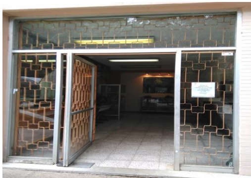
F1: Puerta de acceso (exterior)
