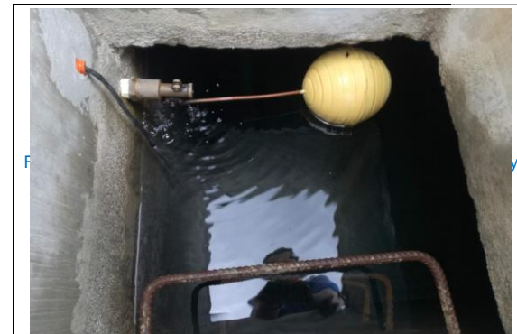
F5: Interior de cisterna
