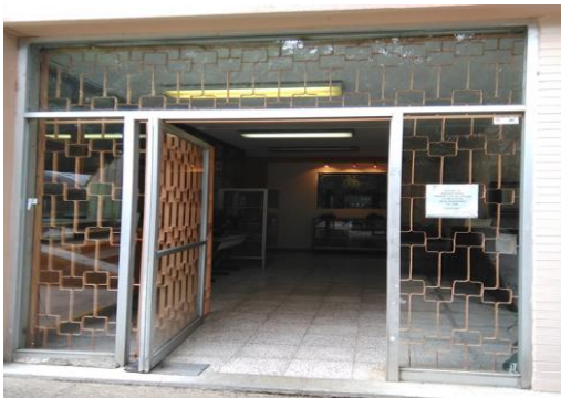
F1: Puerta de acceso (exterior)
