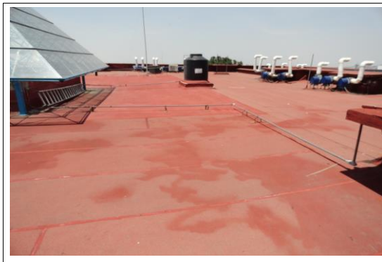
F4: Techo Edificio 49
