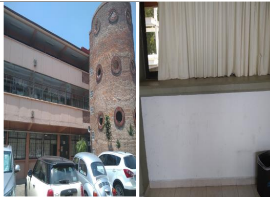
F1: Pintura de Edificio (interior y exterior)
