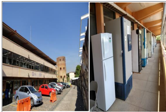
F4: Exterior del edificio
