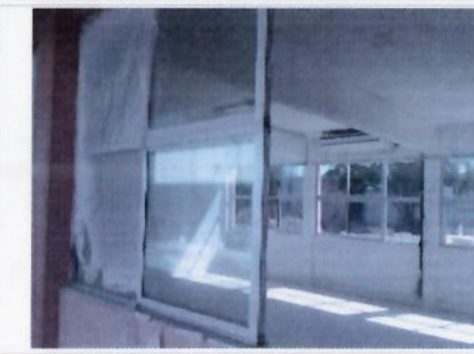
F5: interior de aula
