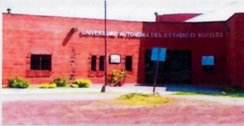
F1: Fachada principal
