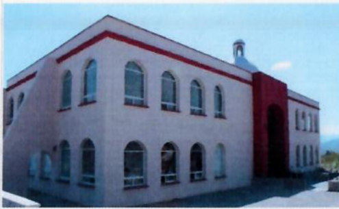
F1: Fachada principal
