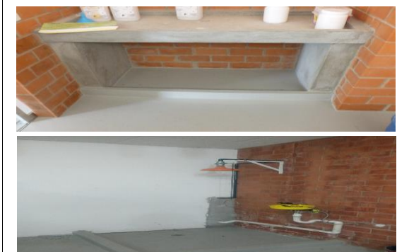
F5: FCQel-LOU Aplicación de pintura.
