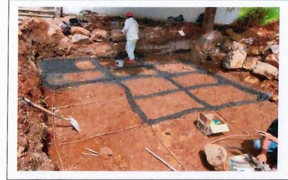
F25: Proceso de instalaciones de tierras físicas
