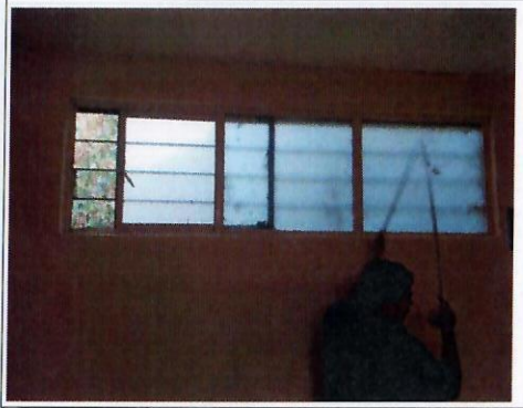
F26: Desmontaje de ventanas
