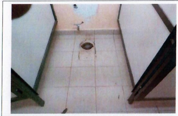
F34: Se desmontan muebles sanitarios
