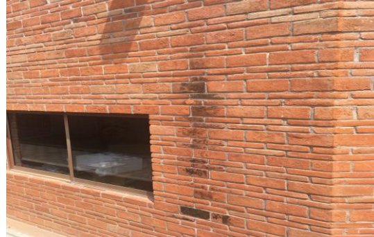
F2: Muros exteriores
