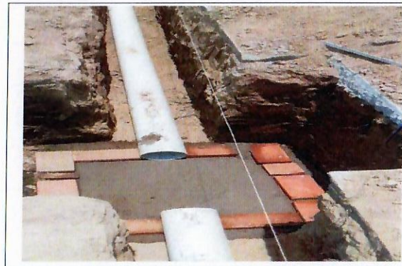
F22: Rehabilitación de un Dren Pluvial
