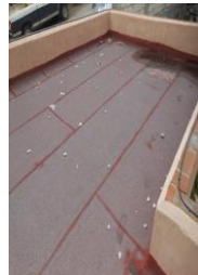
F1: Aplicación de Impermeabilización en azotea de Edificio de Dirección
