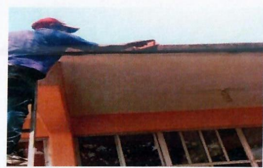
F19: Vista de los trabajos de preparación de la superficie para suministro y aplicación de pintura vinílica acrílica edificio 4 y 3
