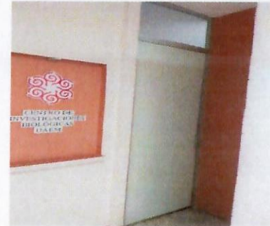
F13: Colocación de puertas , CIB.
