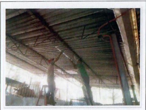
F23: TAMULBA. Vista de los trabajos de retiro de luminarias existentes y colocación de luminarias ahorradoras de energía tipo LED.
