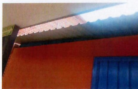
F30: Techumbre de lamina galvanizada protegida a fuego
