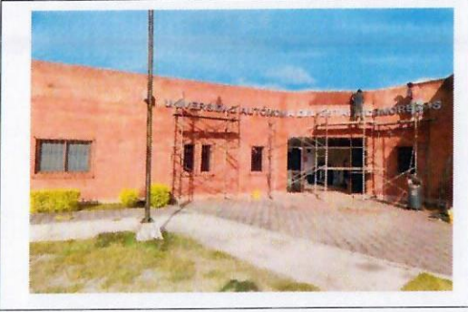
F28: Muros exteriores
