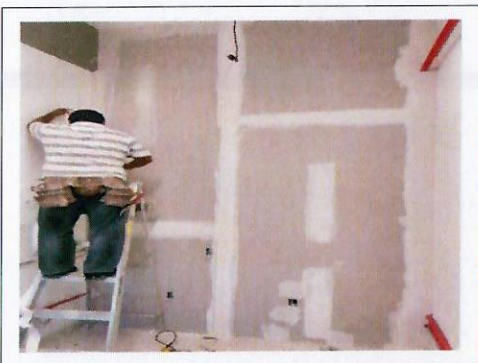
F26: Proceso de instalación de muro de tabla roca
