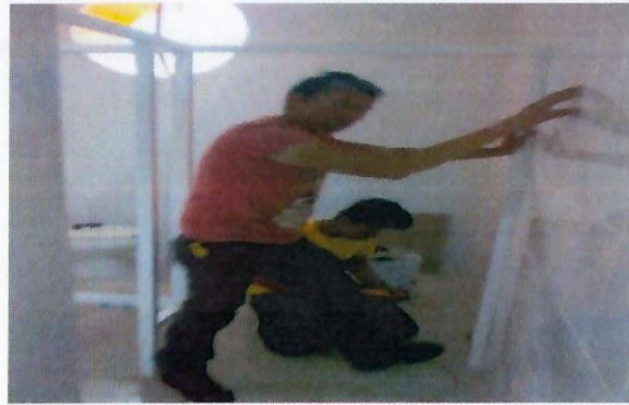
F16: Sanitarios: suministro y colocación de mamparas de aluminio (mujeres)
