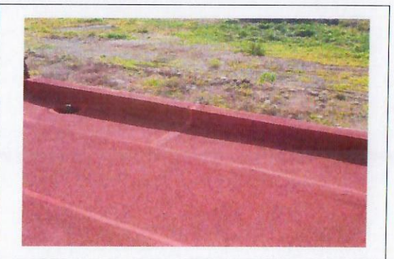
F30: Techo del edificio
