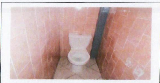
F9: Se realizó el suministro y colocación de baños
