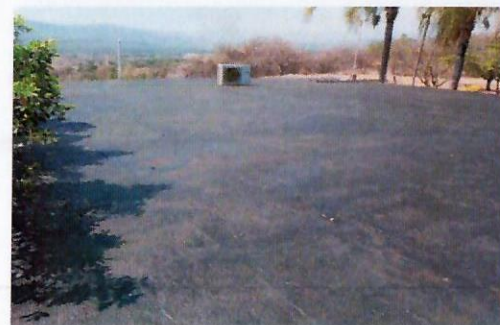
F13: Edificio 3 A
