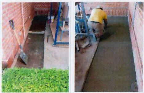
F16: Interior de aula (laboratorio) quitar adobe, para colocar concreto acabado pulido y rayado (foto izquierda). Acabado al concreto ya terminado (foto derecha)
