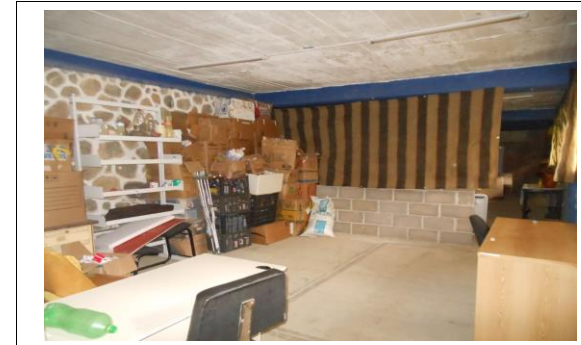
F5: Colocación de loseta en Salón de Usos Múltiples
