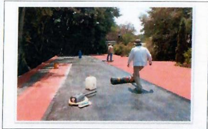
F14. Cobro de los trabajos impermeabilizante prefabricado a un metro de 4 m en superficie de losa de azotea.
