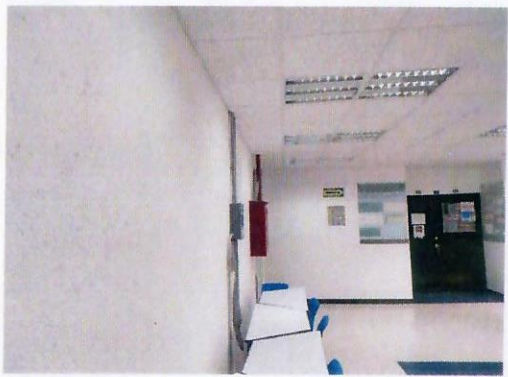
F46: Interior con aplicación de pintura
