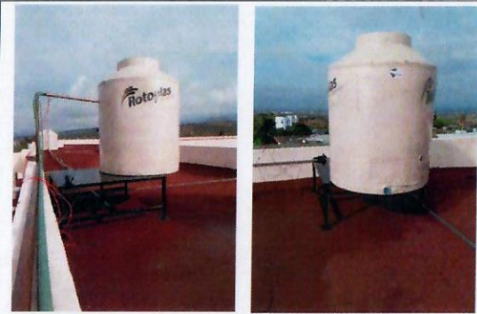
F17: Tinacos colocados.
