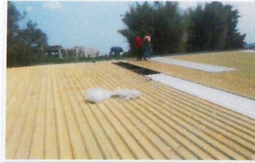
F22: Vista de los trabajos de retiro de lámina traslúcida y su sustitución por lámina metálica similar a la existente en cubierta del edificio de LOU, previo a la aplicación de impermeabilizante a base espuma de poliuretano.
