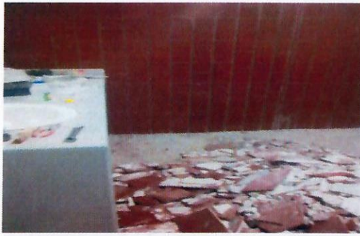
F7: Sanitarios: demolición de azulejo
