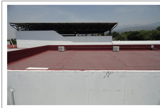
F4: Techo edificio 60
