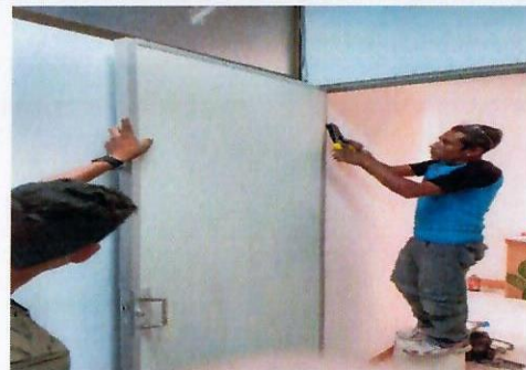
F12: Colocación de puertas , CIB.
