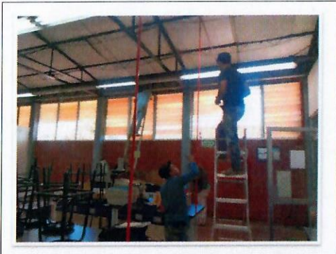
F35: Aplicación de pintura de esmalte en tuberías de instalaciones en interior de laboratorios. (TAMULBA)
