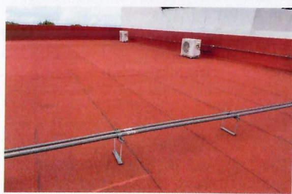
F41: Impermeabilización edificio 60
