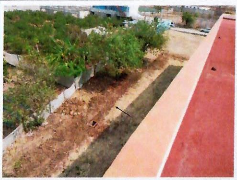
F6: El alimentador eléctrico está en proceso de construcción, que dará energía a las dos cisternas.
