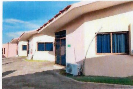
F34: Muros exteriores
