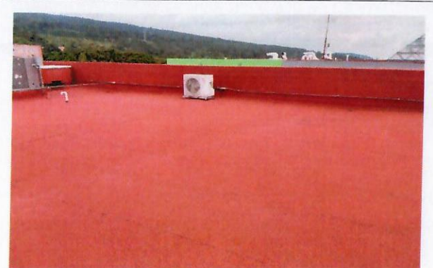
F42: Impermeabilización edificio 60
