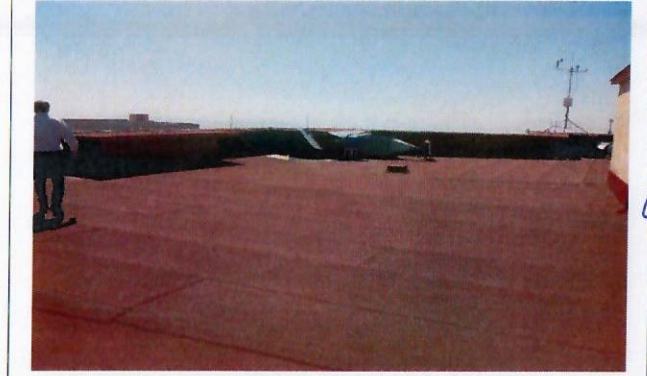
F8: Impermeabilización edificio 49
