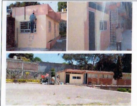
F29: Aplicación de pintura
