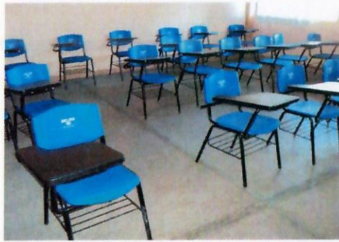
F9: Demolición de piso de concreto, y colocación de loseta en el piso
