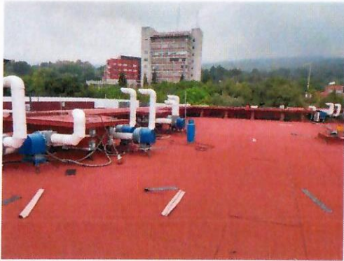
F43: Impermeabilización edificio 49
