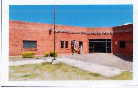
F29: Muros exteriores
