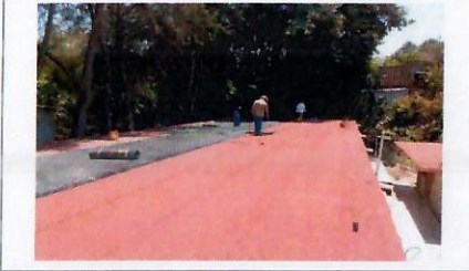
F16. Vista general de los trabajos de colocación de impermeabilizante prefabricado.
