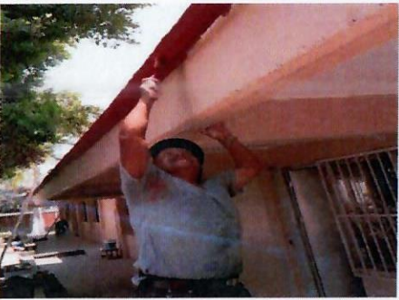
F17: Vista de los trabajos de suministro y aplicación de pintura vinílica acrílica edificio 4 y 3
