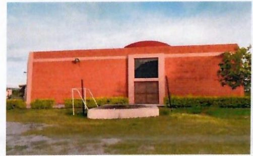
F35: Muros exteriores
