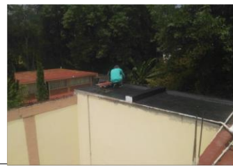
F10: Colocación de impermeabilizante
