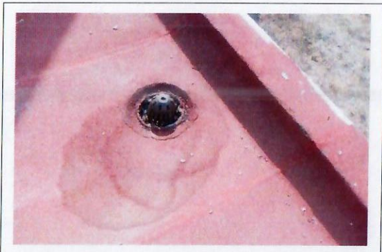
F10: Techo del edificio
