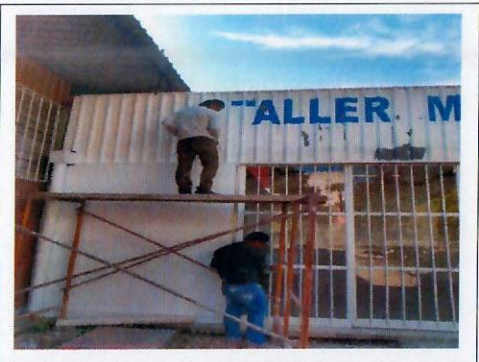
F38: TAMULBA, Proceso de pintura.
