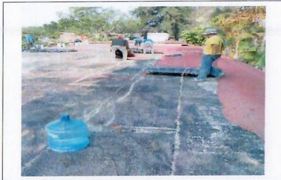
F19: Retiro de impermeabilizante en E.E.S. Xalostoc
