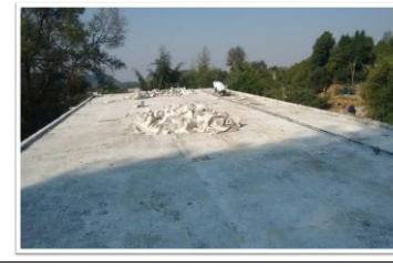
F11: Retiro de material de impermeabilizante existente.
