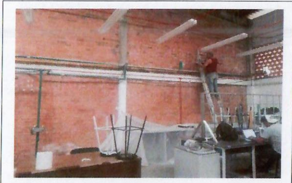
F11: Tubería antes de aplicarle pintura de esmalte. LOU
