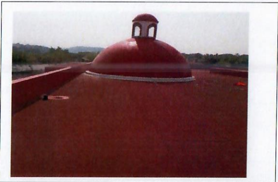
F27: Impermeabilización acrílico en azotea de segundo nivel del edificio
