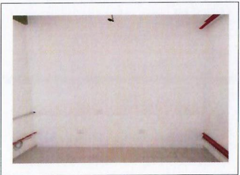
F46: Muro de tablaroca terminado
