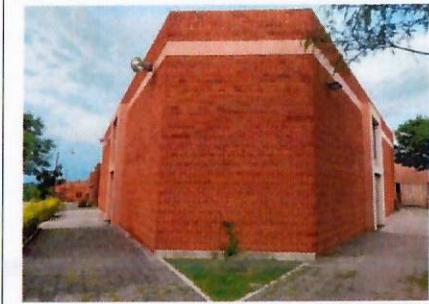
F33: Muros exteriores
