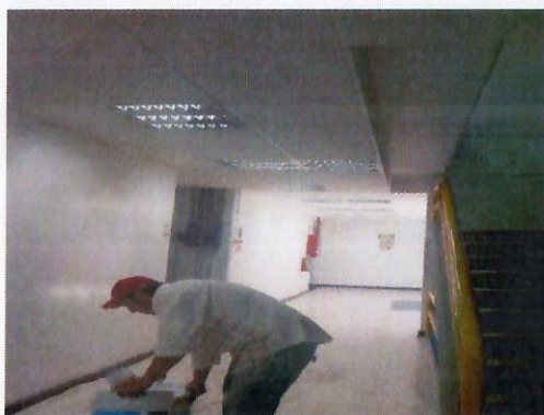
F33: Proceso de pintura en interiores
