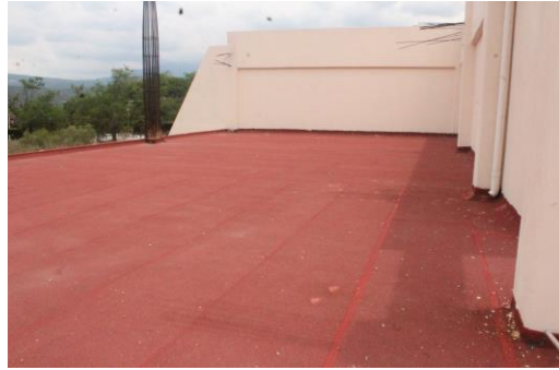
F4: Techo del edificio
