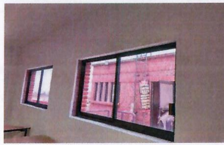
F25: Proceso de aplicación de pintura
