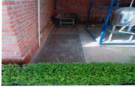
F27: Frente de concreto pulido y zapato terminado
