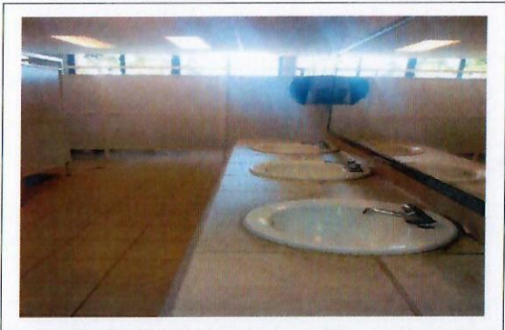
F32: Rehabilitación de sanitarios terminados. (sanitarios mujeres)
