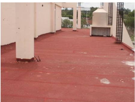
F3: Techo del edificio
