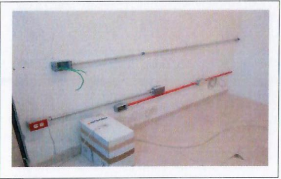
F47: Muro de tablaroca terminado
