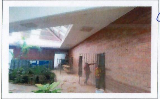
F14: Muros exteriores
