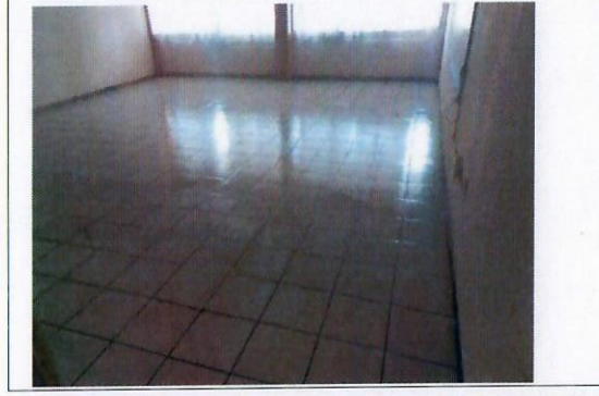
F28: Colocación de loseta en aulas terminado
