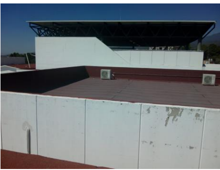
F3: Suministro y aplicación de Pintura Edificio 60 (exterior)
