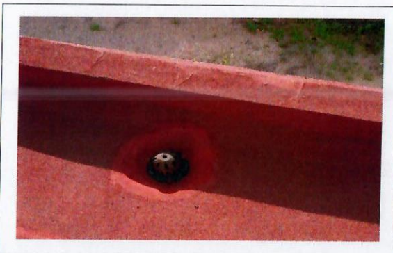
F28: Techo del edificio
