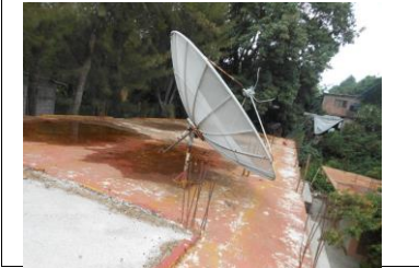
F4: Aplicación de Impermeabilización en azotea de Centro de Cómputo
