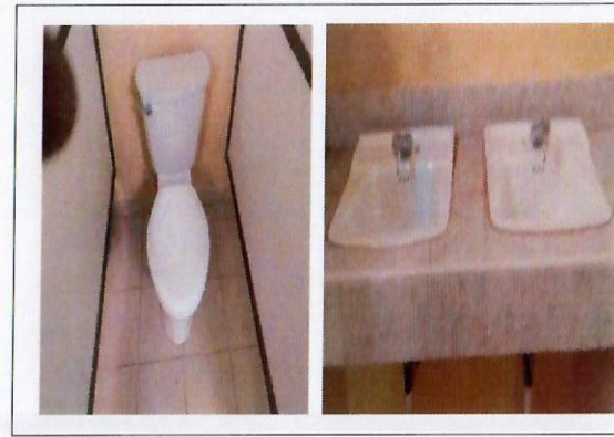
F37: Colocación de sanitarios y lavabos
