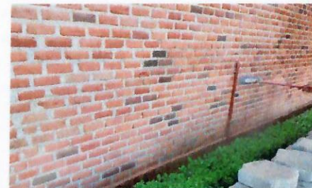
F11: como se encontraba antes de impermeabilizar
