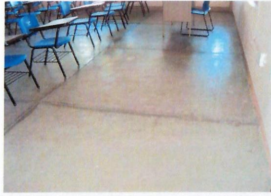
F7: Demolición de piso de concreto, y colocación de loseta en el piso
