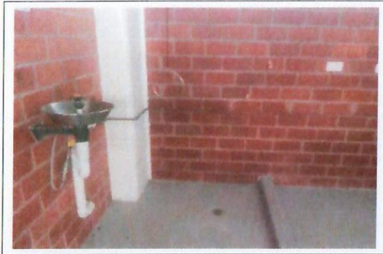
F7: Se aplicará Pintura epóxica en paredes de laboratorios (sardineles y piso de regaderas.) LOU
