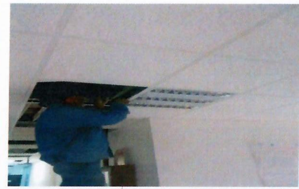
F20: Techo: colocación de lámpara led
