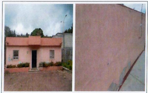
F10: Mantenimiento al Edificio de Dirección
