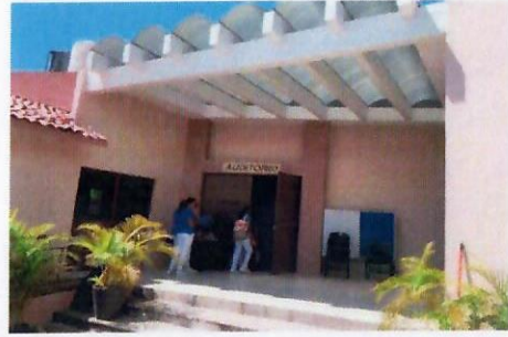
F37: Muros exteriores
