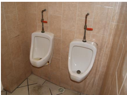
F3: Realizar el suministro y colocación de mingitorios
