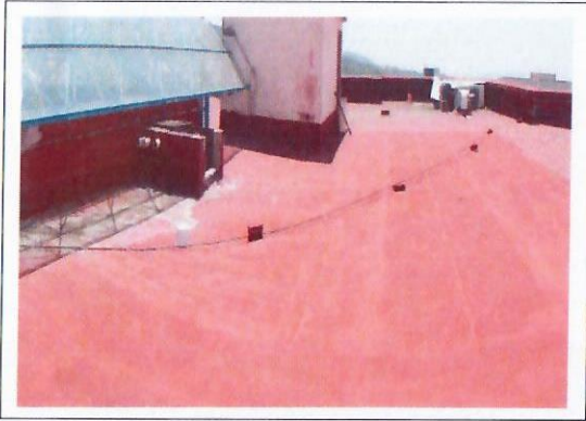
F6. Techo Edificio 49
