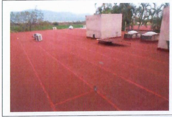
F25: Trabajos de impermeabilización terminados
