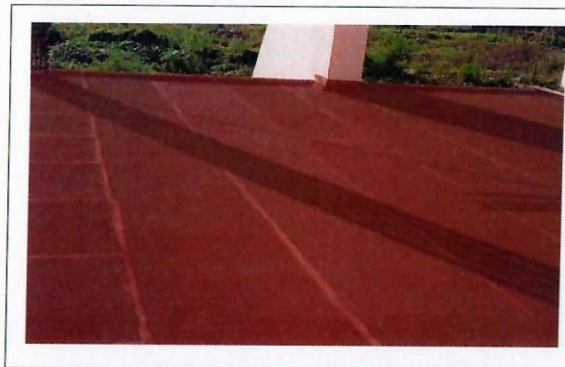
F25: Techo del edificio
