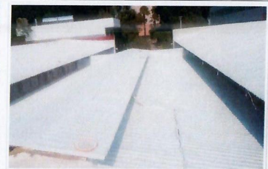
F26: Vista general de los trabajos terminados de impermeabilización a base espuma de poliuretano sobre cubiertas metálicas de edificio. TAMULBA.
