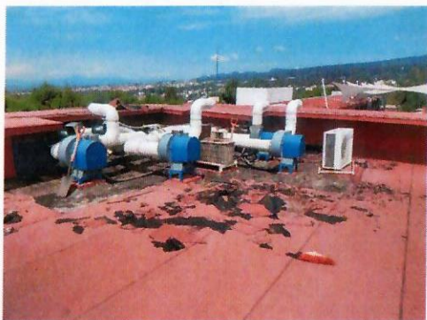
F27 Impermeabilización edificio 49
