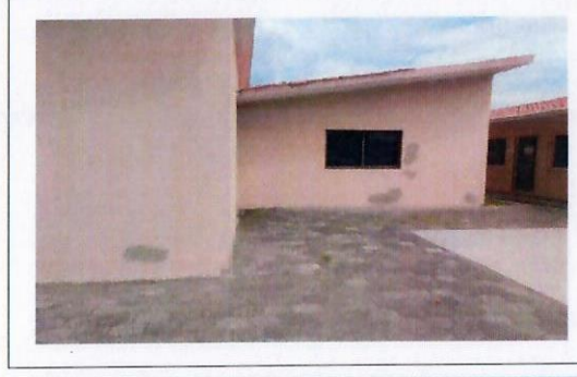
F23: Muros exteriores
