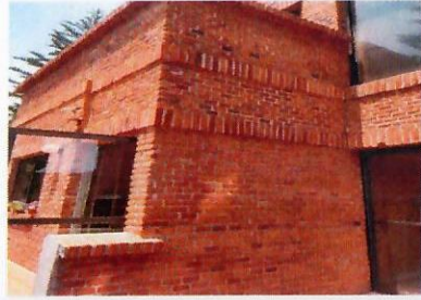
F-44: fachadas ya con impermeabilizantes SIKAGUARE
