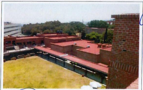
F12: Impermeabilizante terminado (Esf. en forma de N)
