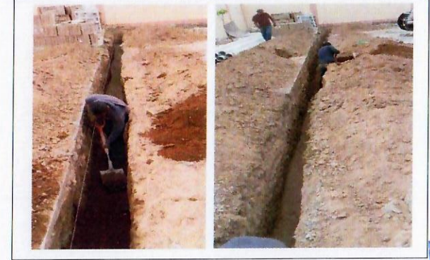
F28: Excavación para la rehabilitación del dren pluvial
