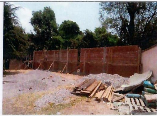
F18: Barda perimetral en proceso
