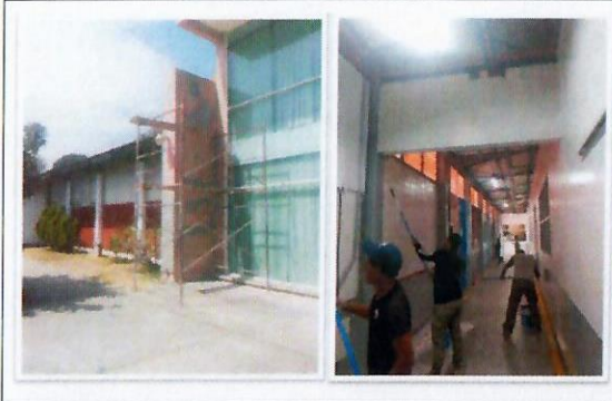
F17: TAMULBA. Aplicación de pintura vinílica y de esmalte en muros interiores de edificio.
