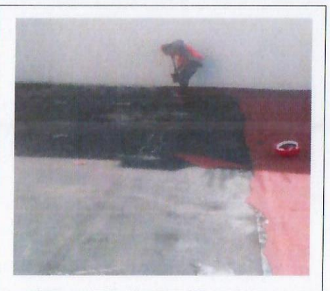
F11: Retiro de impermeabilizante prefabricado
