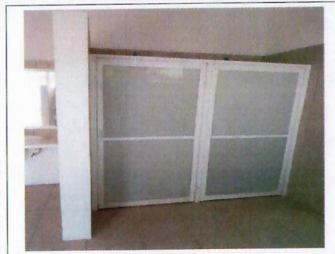
F30: Rehabilitación de sanitarios terminado
