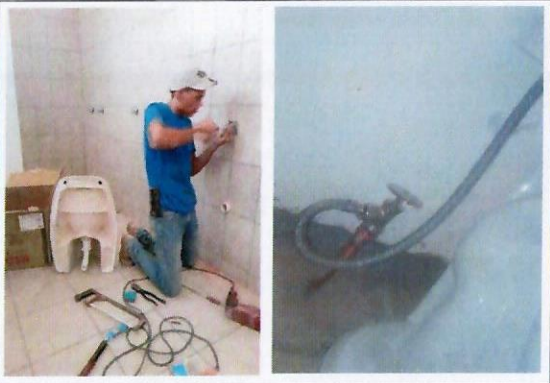
F23: Rehabilitación de salidas hidrosanitarias
