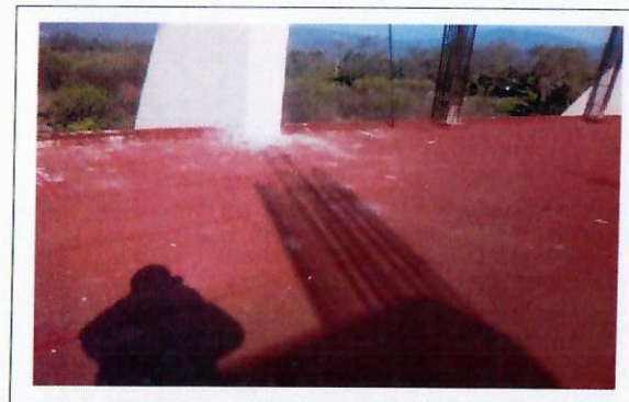
F8: Techo del edificio
