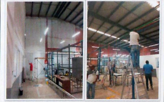
F20: LOU. Trabajos de aplicación de pintura vinílica en muros perimetrales al interior de la nave principal.
