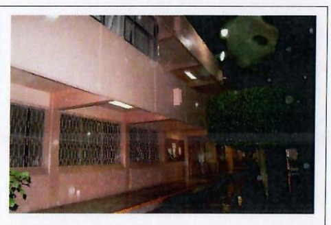
F11: Instalación de luminaria
