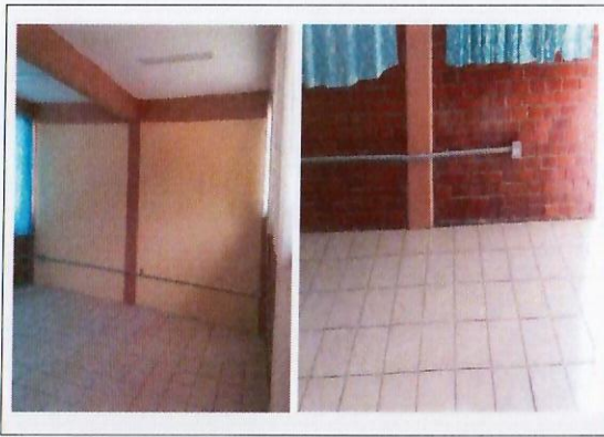
F36: Aula pintada y loseta de piso colocado
