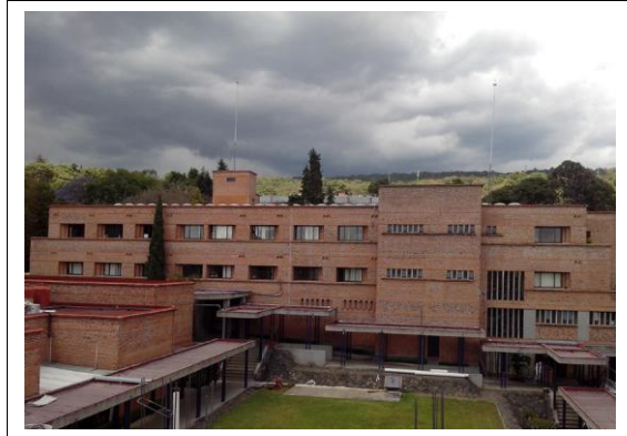
F:2 Fachada lateral
