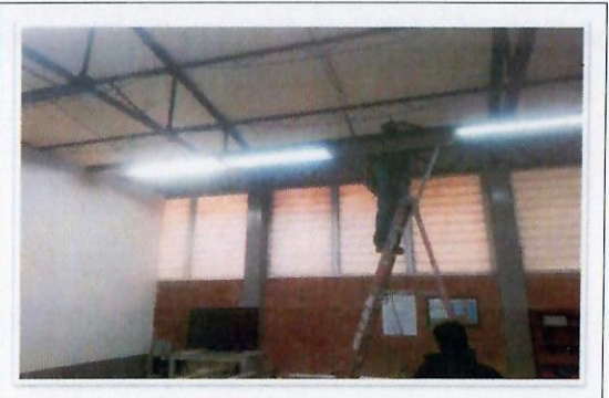
F24: Trabajos de retiro de luminarias en laboratorios de TAMULBA.
