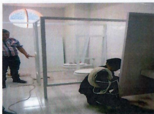
F15: Sanitarios: suministro y colocación de mamparas de aluminio (hombres)
