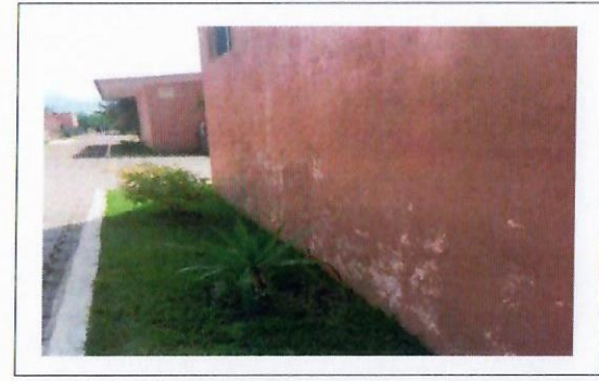
F8: Muros exteriores
