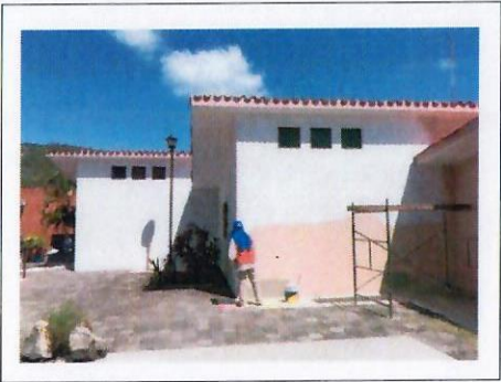
F21: Muros exteriores
