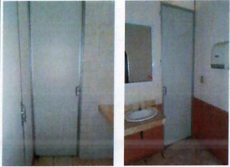
F14: Colocación de puertas
