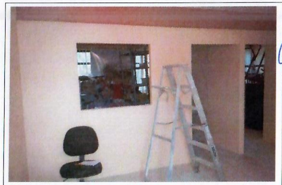
F49: Muros de Tabla Roca Nuevos.
