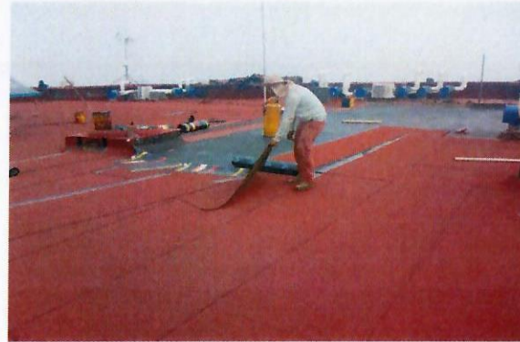
F25: Impermeabilización edificio 49
