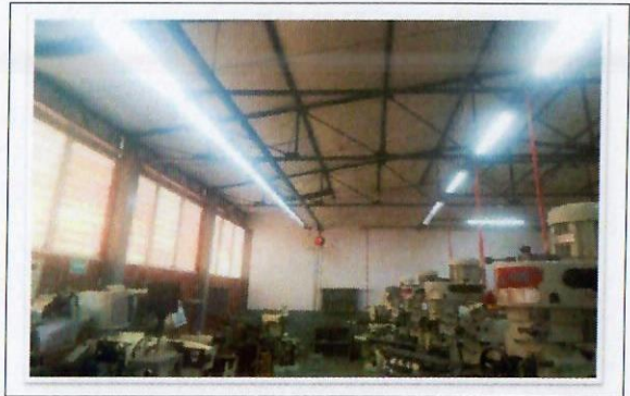
F49: Trabajos de aplicación de pintura vinílica y de esmalte en muros interiores. LOU
