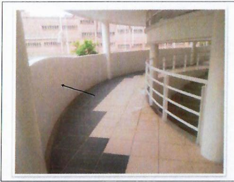
F53: Aplicación de Pintura de esmalte en barandales de herrería y columnas metálicas de vestíbulo principal, área de laboratorios edificio 35 FCQel
