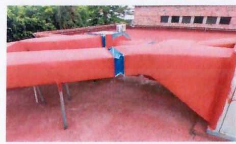
F43: Alas terminado su mantenimiento
