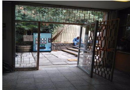
F2: Puerta de acceso lateral (interior)
