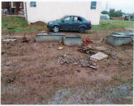
F13: Trabajo terminado de cisterna
