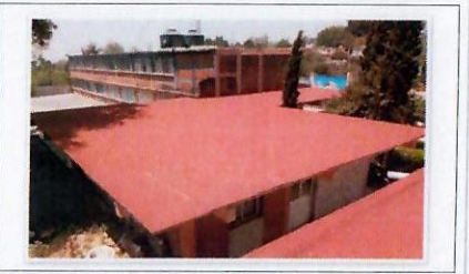
F19. Trabajos concluidos en zona de azotea de planta baja, edificio planta suel.
