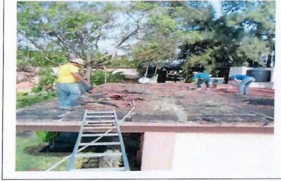
F17: Retiro de impermeabilizante
