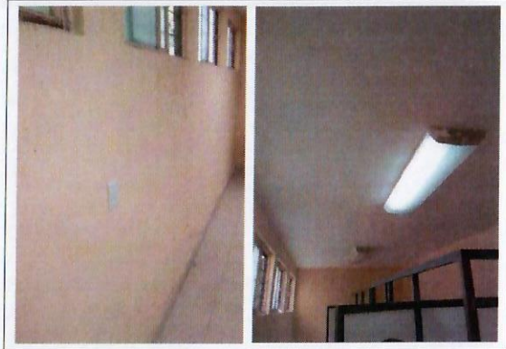
F46: Rehabilitación de salidas eléctricas.
