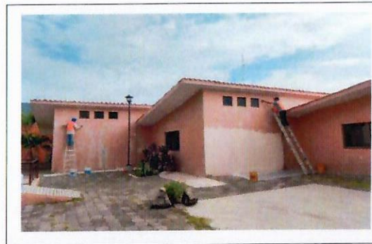
F17: Muros exteriores
