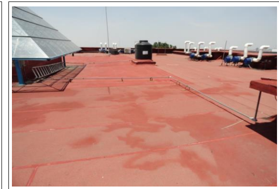
F5: Techo Edificio 49
