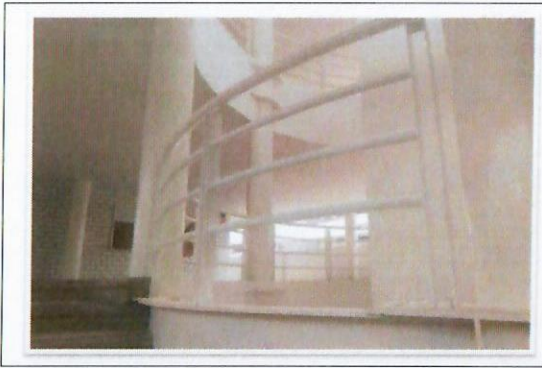
F54: Imagen de los trabajos terminados de aplicación de pintura de esmalte en barandales de vestíbulo principal, área de laboratorios primer nivel edificio 35 FCQel.
