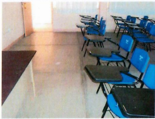
F6: Demolición de piso de concreto, y colocación de loseta en el piso
