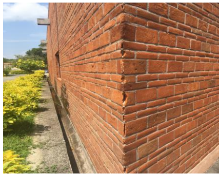
F3: Muros exteriores
