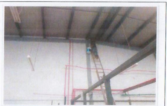
F33: Trabajos de aplicación de pintura vinílica en muros perimetrales al interior de la nave principal. (LOU)
