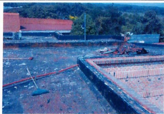
F7: Retiro de impermeabilizante anterior.
