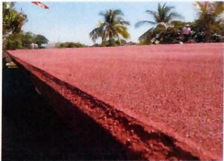
F23. Techo: Vista de los trabajos generales de impermeabilización.
