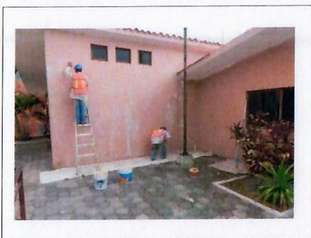
F18: Muros exteriores
