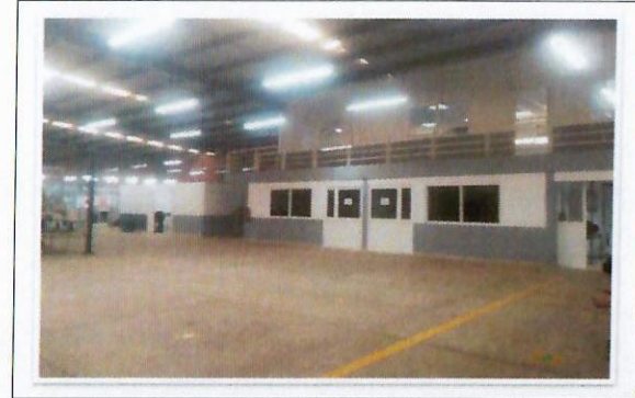
F46: LOU: trabajos de aplicación de pintura vinílica y de esmalte en áreas comunes interiores de edificio.
