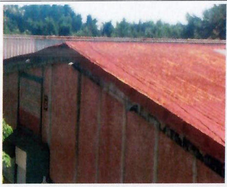
F9: Vista del Techo, impermeabilizante que se retirara LOU
