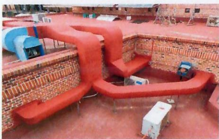
F42: Alas terminado su mantenimiento
