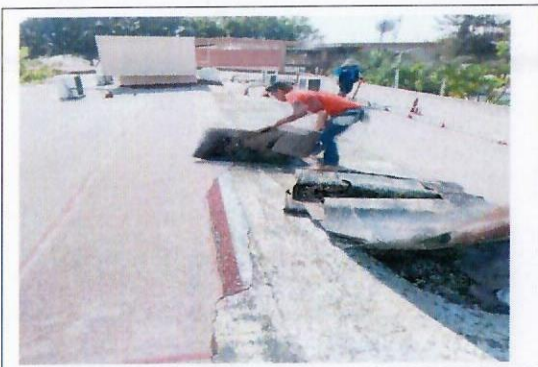
F18: Retiro de impermeabilizante en E.E.S. Xalostoc
