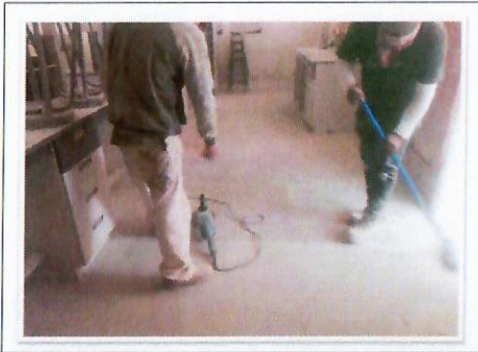
F26: Imagen de retiro de residuos previo a los trabajos de aplicación de pintura epóxica en piso de laboratorio, primer nivel lado sur de edificio 35 FCQel.
