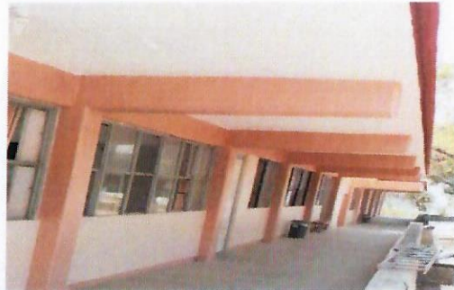
F24. Suministro y aplicación de pintura vinílica acrílica edificio 4 y 3
