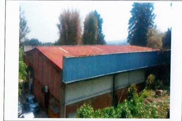
F8: Vista del Techo, impermeabilizante que se retirara LOU
