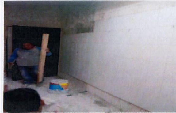
F13: Sanitarios: Colocación de azulejo en proceso.
