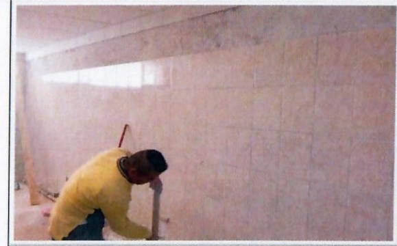
F19: Sanitarios: Colocación azulejo
