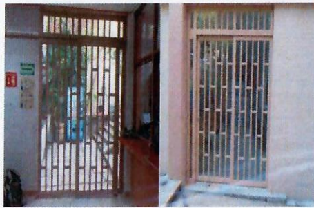
F17: Suministro y colocación de puerta de acceso principal
