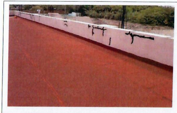
F16: Suministro y aplicación de impermeabilizante acrílico en azotea de segundo nivel del edificio
