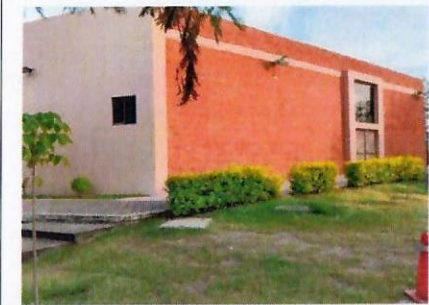
F36: Muros exteriores
