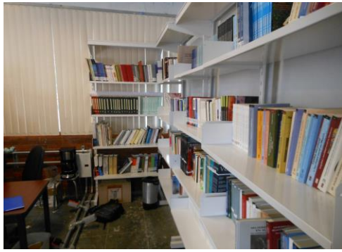
F1:Cambio de piso de Biblioteca
