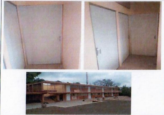
F45: Colocación de puertas.
