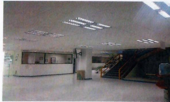
F38: Falso Plafon colocado
