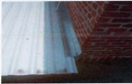
F33: Molitura de lamina para evitar se transpire el agua de lluvia
