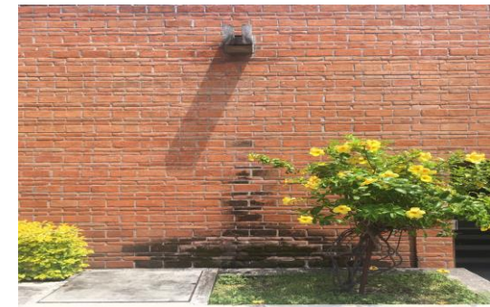
F5: Muros exteriores
