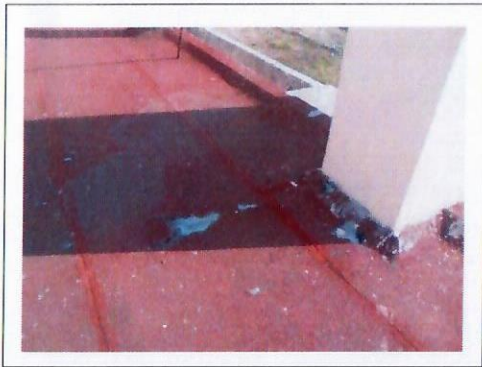
F6: Techo del edificio
