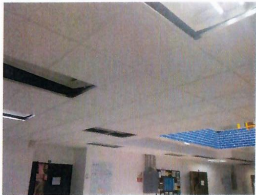
F18: Techo: suministro y colocación de falso plafón
