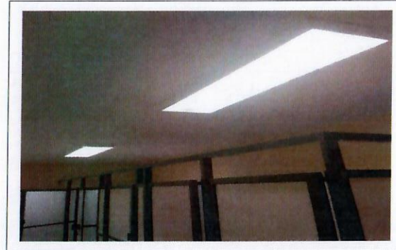
F43: Rehabilitación de salidas eléctricas en sanitario
