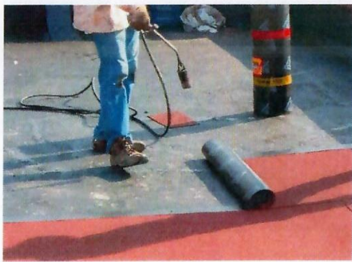
F24: Impermeabilización edificio 60
