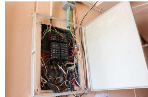
F5: Rehabilitación y reparación de salidas eléctricas del Cableado Eléctrico
