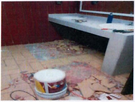
F6: Sanitarios: demolición de piso
