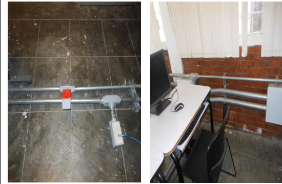
F2: Cambio de piso Centro de Cómputo y rehabilitación de salidas eléctricas.
