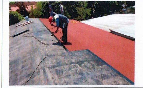
F16: Colocación de impermeabilización
