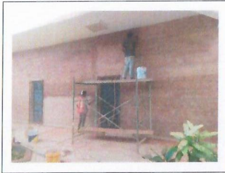
F24: Muros exteriores
