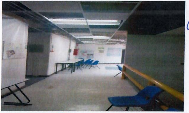
F17: Colocación de falso plafón
