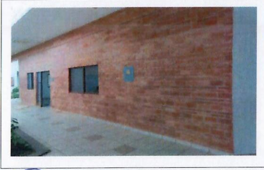
F32: Muros exteriores
