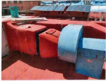
F18: Mantenimiento obra acondicionada
