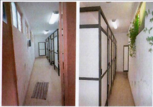
F16: Cambio de muebles sanitarios
