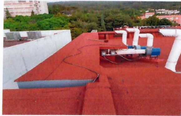
F44: Impermeabilización edificio 49
