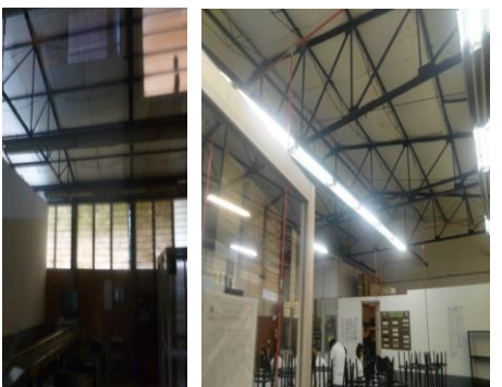
F3: TAMULBA-FCQel Desmontaje, suministro y colocación de lamparas led.
