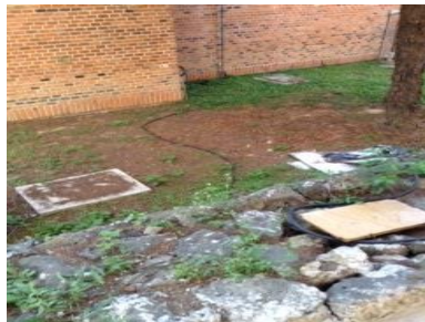
F3: Instalación sistema de tierras
