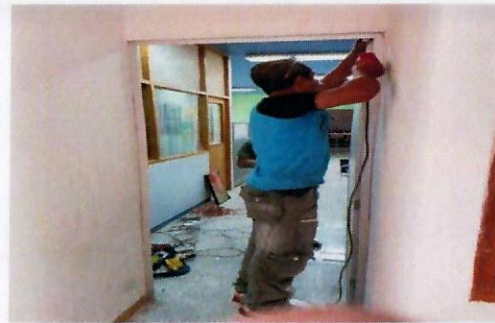
F9: Colocación de puertas , CIB.
