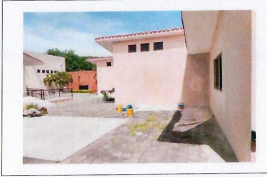
F22: Muros exteriores
