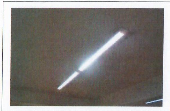
F7: Aulas, colocación de luminarias
