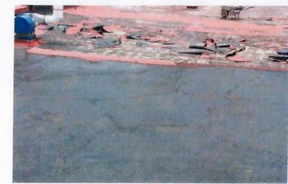
F26: Impermeabilización edificio 49
