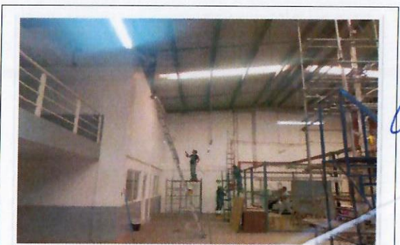
F34: Trabajos de aplicación de pintura vinílica en muros de esmalte en estructuras metálicas interiores. (LOU)
