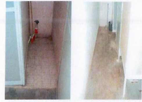
F11: Suministro y colocación de loseta cerámica en Sanitarios
