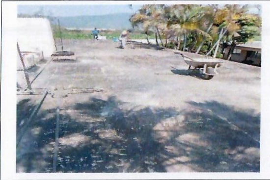
F20: Retiro de impermeabilizante en E.E.S. Xalostoc
