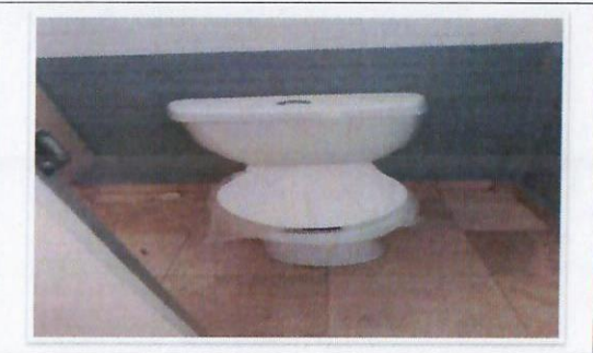
F60: Colocación de excusados ahorradores en área de módulo sanitario de edificio (TAMULBA)
