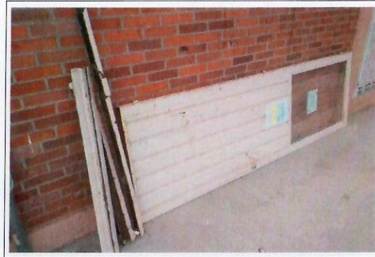
F24: Proceso de colocación de puertas
