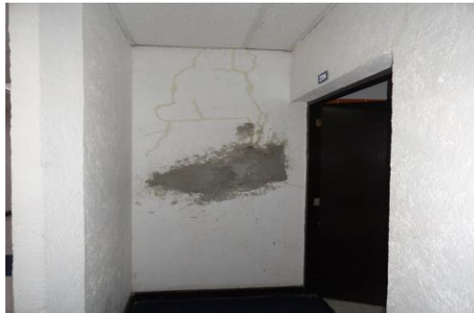
F2: Suministro y aplicación de Pintura Edificio 60 (interior)
