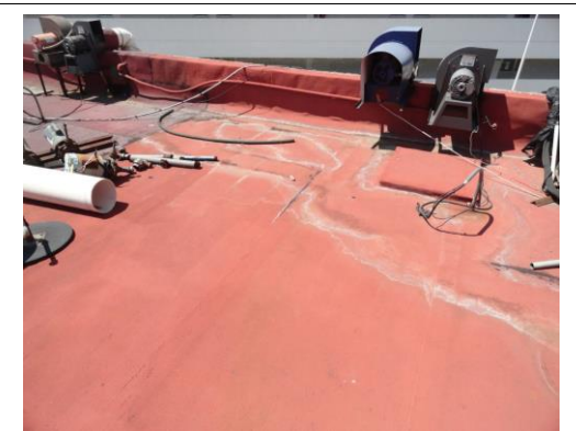
F3: Retiro, suministro y aplicación de Impermeabilizante
