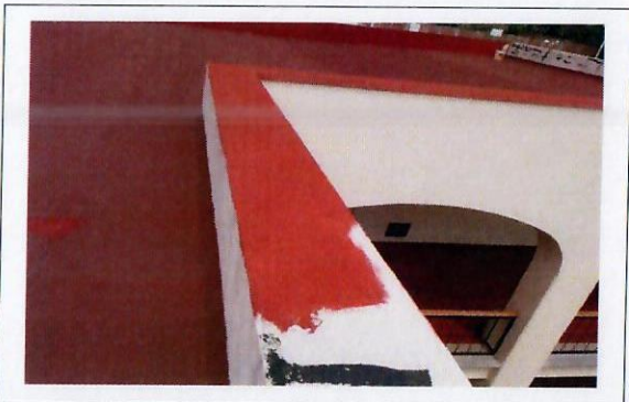
F19: Suministro y aplicación de impermeabilizante acrílico en azotea de segundo nivel del edificio
