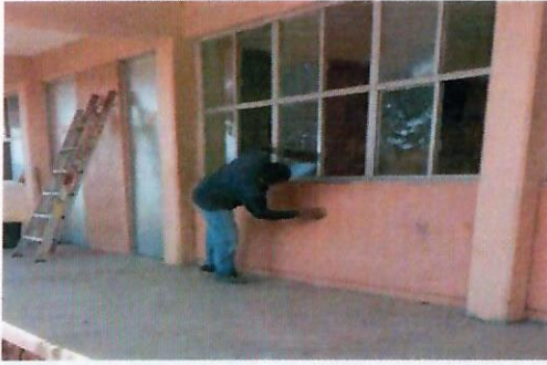
F15: Vista de los trabajos de preparación de la superficie para suministro y aplicación de pintura vinílica acrílica edificio 4 y 3
