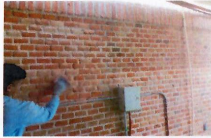
F19: Fachada principal (limpieza Limpieza de tabiques aparente con fijo y cepillo de alambre
