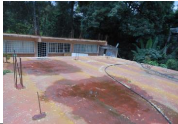
F3: Aplicación de Impermeabilización en azotea de Edificio Principal
