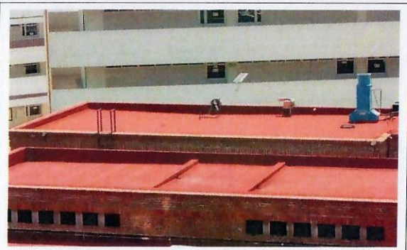
F11: Impermeabilizante terminado
