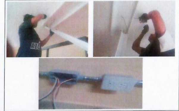
F25: Proceso de salidas eléctricas
