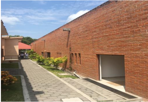
F1: Muros exteriores
