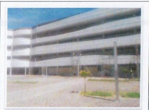
F29: Aplicación de sellador en fichaleta de cerámica esmaltada en mureles de fachada principal de primer nivel, edificio 35 FCQel.
