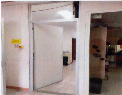
F11: Colocación de puertas , CIB.
