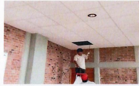
F20: Dismantaje del sistema de iluminación
