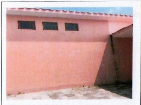
F9: Muros exteriores
