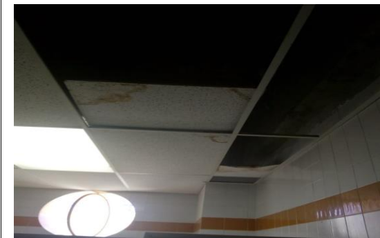
F5: Mantenimiento de Techo (Plafón)
