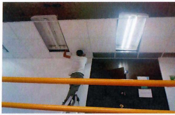
F19: Desmontar lamparas de gabinete, suministro y colocación de galletas de falso plafón
