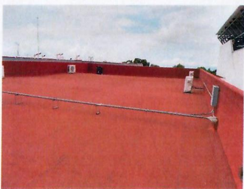
F40: Impermeabilización edificio 60
