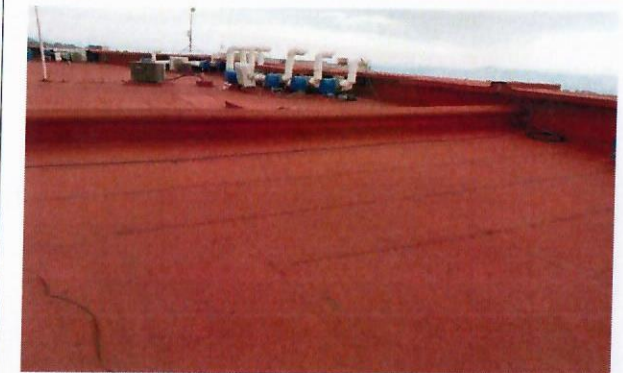
F45: Impermeabilización edificio 49
