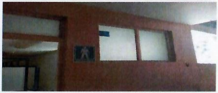
F15: Desmontaje de ventanas
