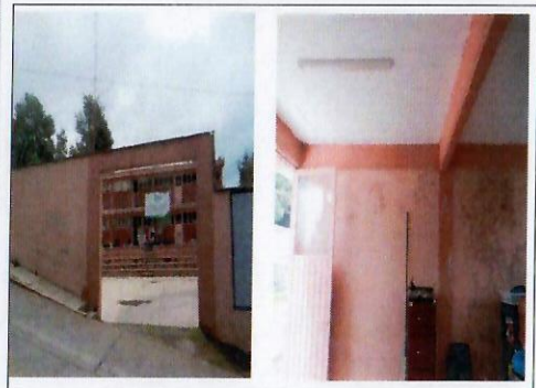
F9: Se pintará el Edificio Principal
