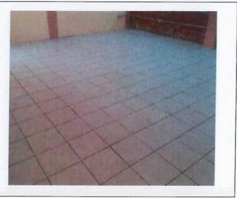
F35: Aulas: loseta de piso colocado en aulas didácticas
