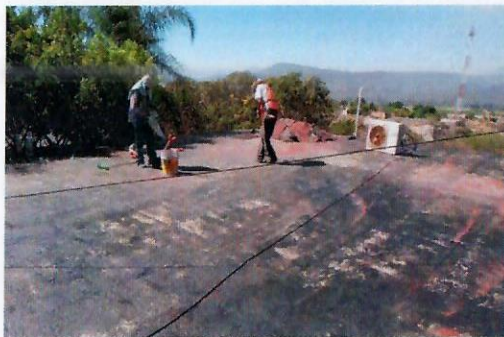
F9: Techo: trabajos de retiro de impermeabilizante prefabricado en edificio 3A.
