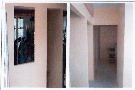
F48: Muros de Tabla Roca Nuevos.
