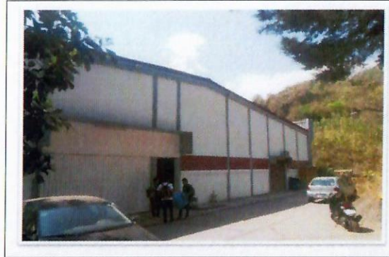
F45: LOU: trabajos concluidos de aplicación de pintura vinílica y de esmalte en fachada Principal.
