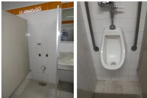
F4: Suministro y aplicación de muebles Sanitarios
