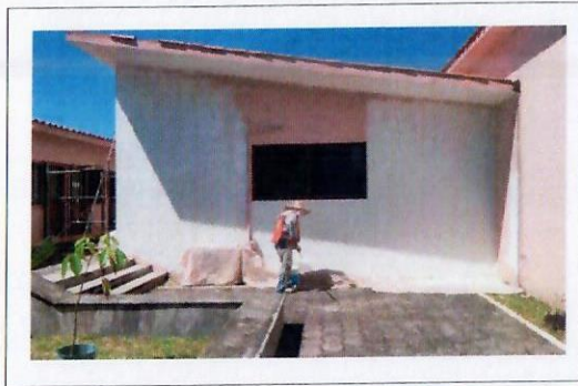
F19: Muros exteriores
