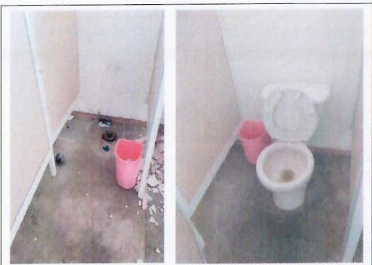
F21: Proceso del desmontaje de muebles sanitarios
