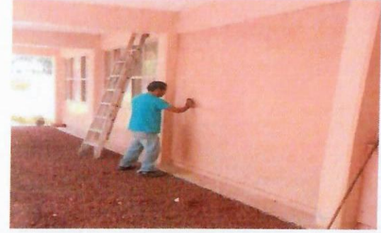
F16: Vista de los trabajos de preparación de la superficie para suministro y aplicación de pintura vinílica acrílica edificio 4 y 3
