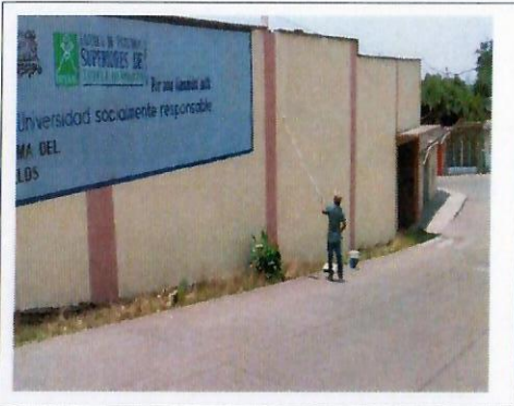
F32: Fachada principal de la sede, se aplica pintura.
