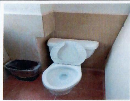
F16: Instalación de muebles sanitarios.
