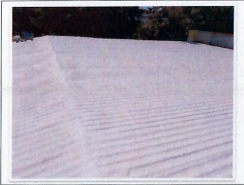
F39. Imagen de los trabajos terminados de aplicación de impermeabilizante de espuma de poliuretano con acabado final sobre cubierta metálica del edificio LOU.
