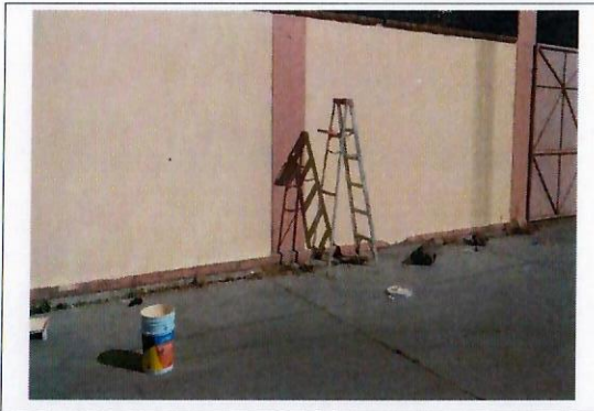
F33: Fachada principal de la sede, se aplica pintura.
