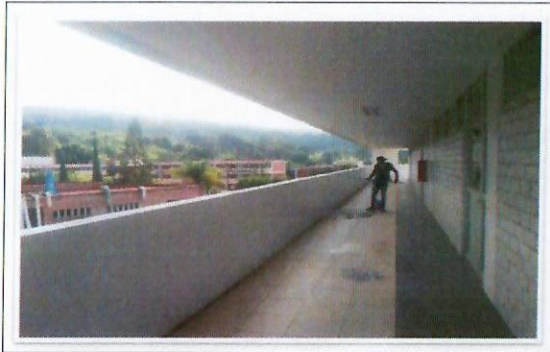
F27: Aplicación de pintura vinílica en pretilas y muros de pasillos principales, área exterior noroeste segundo nivel, edificio 35 FCQel.
