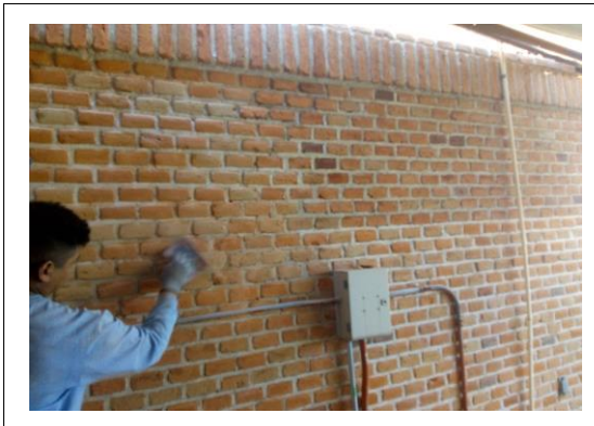
F5: Retiro, suministro y aplicación de Impermeabilizante
