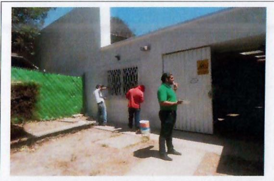
F39: TAMULBA, Proceso de pintura.
