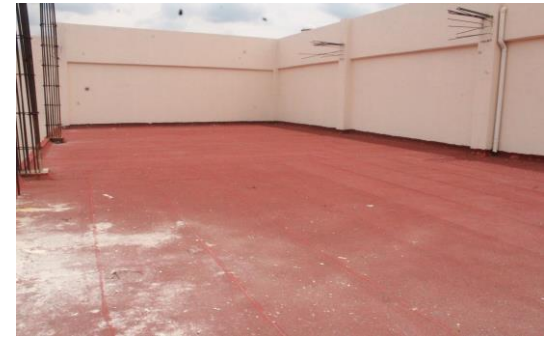
F5: Techo del edificio
