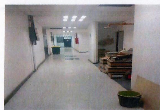
F22: Avance en Colocación de lamparas
