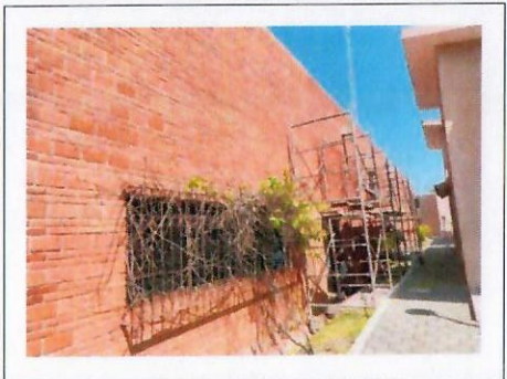
F12: Muros exteriores
