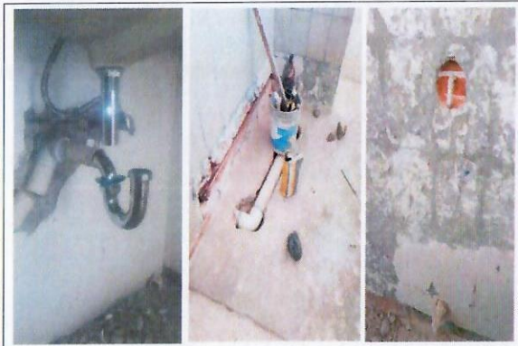
F22: Rehabilitación de salidas hidrosanitarias
