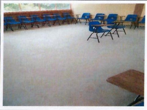
F41: Aulas, loseta de piso colocado en aulas didácticas
