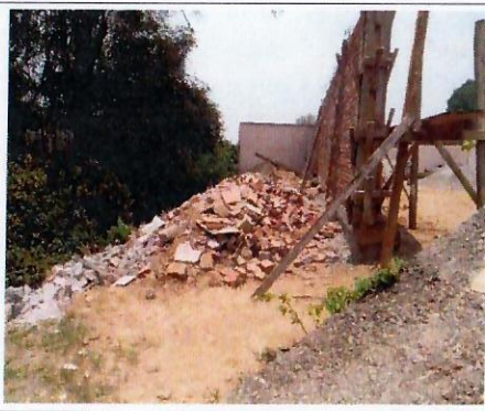
F20: Barda perimetral en proceso
