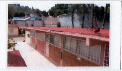
F17. Trabajos concluidos en edificio de laboratorios de zona norte, perteneciente a la Unidad Académica.
