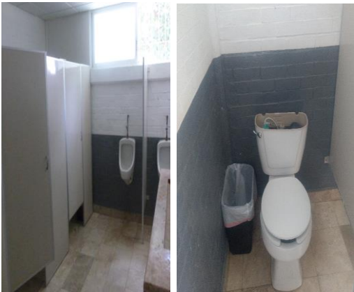
F1: Suministro y colocación de muebles Sanitarios
