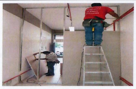
F14: Antes de instalar el muro de tabla roca
