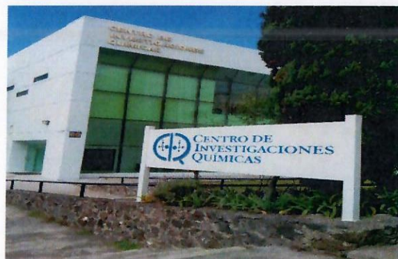
F31: Proceso de pintura en exteriores.
