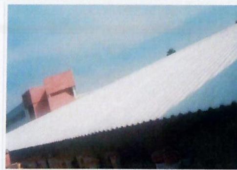
F25: Imagen de aplicación de poliurea color blanco sobre espuma de poliuretano, como acabado final, TAMULBA.
