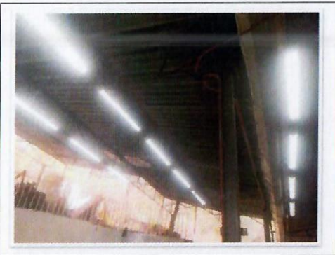
F47: Imagen de los trabajos concluidos de colocación de luminarias ahorradoras de energía tipo LED, en taller de TAMULBA.
