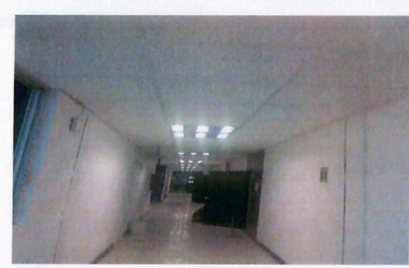
F23: Avance en Colocación de Plafón falso
