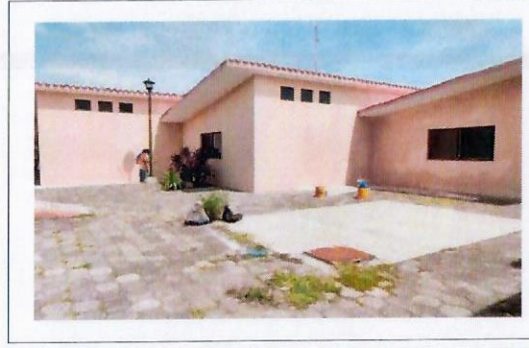
F20: Muros exteriores
