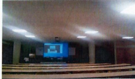
F36: Sistema de Iluminación nueva
