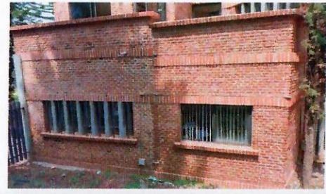
F-45: fachadas ya con impermeabilizantes SIKAGUARE
