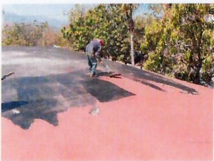
F11: Retiro de impermeabilizante prefabricado en edificio 2
