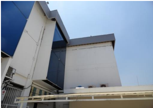
F1: Suministro y aplicación de Pintura Edificio 49 (exterior)
