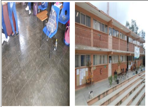
F3: Cambio de Piso Aulas
