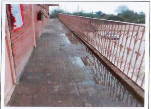
F12: Colocación en Pasillo planta alta
