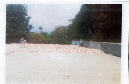
F19: Imagen de los trabajos de limpieza de residuos de impermeabilizante deteriorado de poliuretano existente en cubierta metálica, lado poniente de LOU.
