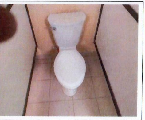
F38: Trabajo de cambio de muebles sanitarios
