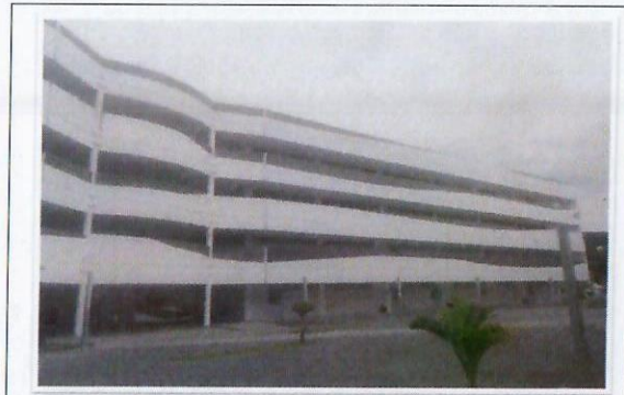
F58: Imagen de los trabajos de terminados de aplicación de pintura vinílica en muretas y faldón así como sellador en fachaletas de cerámica esmaltada de fachada principal edificio 35 FCQel.
