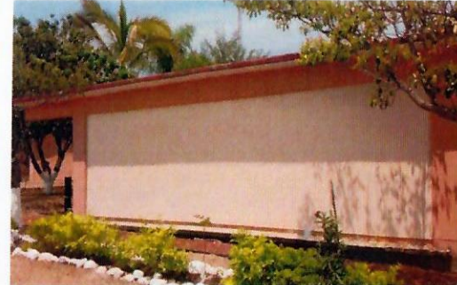
F25. Suministro y aplicación de pintura vinílica acrílica edificio 4 y 3
