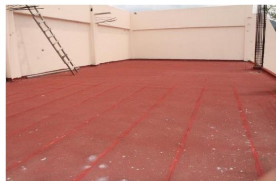
F2: Techo del edificio
