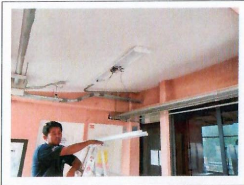
F23: Proceso de desmontaje de lámparas
