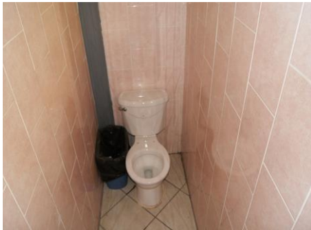
F1: Realizar el suministro y colocación de WC
