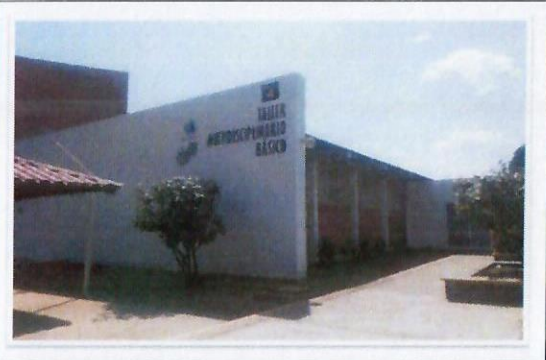
F42: TAMULBA-FCQel: Trabajos terminados de aplicación de pintura vinilica en muros de fachada principal así como de pintura de esmalte en estructura y puertas metálicas.
