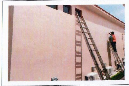
F16: Muros exteriores
