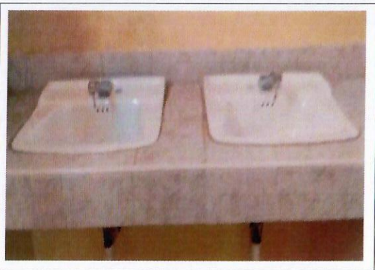
F39: Se concluyó el cambio de muebles sanitarios
