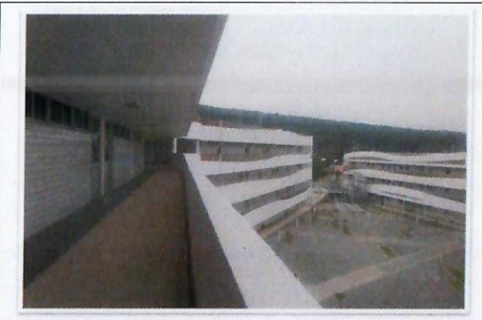
F57: Imagen de los trabajos terminados de aplicación de pintura vinílica en pretilos y muros, vestíbulo principal de tercer nivel edificio 35, FCQel.
