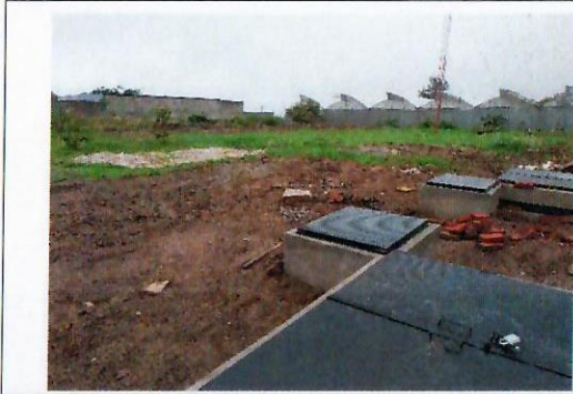
F14: Trabajo terminado de cisterna
