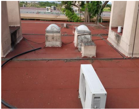
F1: Retiro y colocación de impermeabilización en el Laboratorio E-5
