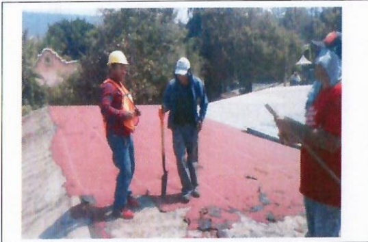
F15: Retiro de impermeabilizante existente
