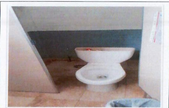
F30: Retiro de mobiliario sanitario existente en edificio. (TAMULBA)
