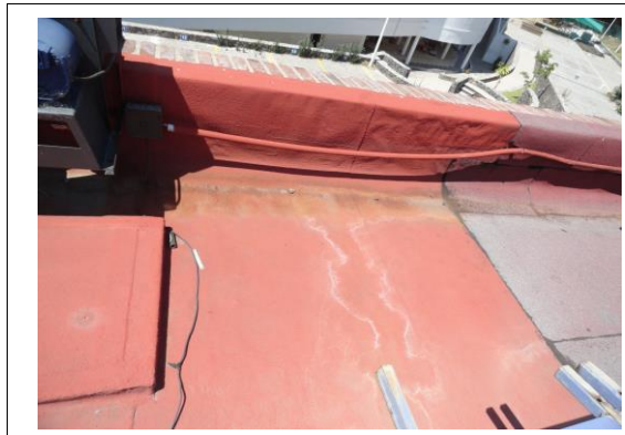
F4: Retiro, suministro y aplicación de Impermeabilizante
