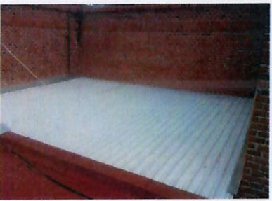
F32: Techumbre de lamina preplastada para el nuevo laboratorio
