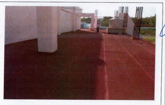
F22: Techo del edificio
