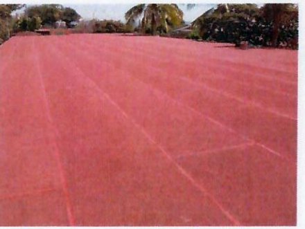
F20: Vista de los trabajos de suministro y colocación de impermeabilizante prefabricado en edificio 4
