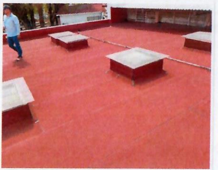
F27: Vista general de los trabajos terminados de colocación de membrana de impermeabilizante prefabricado en cubierta de TAMULBA.
