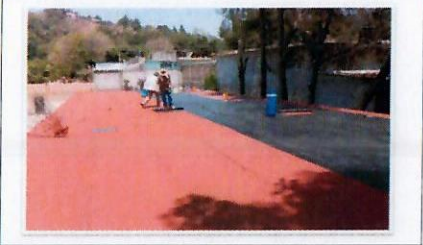
F15. Vista general de los trabajos de colocación de impermeabilizante prefabricado.
