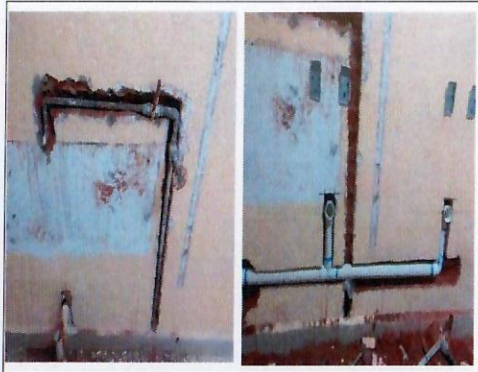
F23: Proceso de instalación hidrosanitaria
