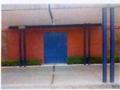
F29: Pintura sintetica en muro de ladrillo nuevo
