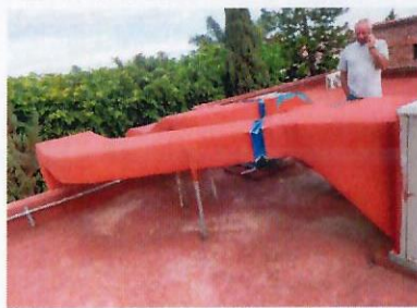
F41: Alas terminado su mantenimiento
