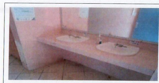
F10: Se realizó el cambio de llaves Economizadora
