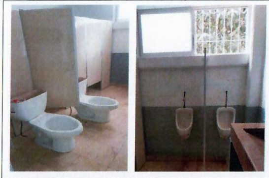
F36: Proceso de cambio de muebles sanitarios, (w.c. y mingitorios)
