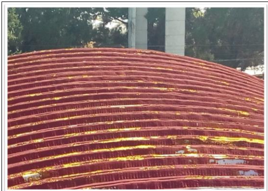
F3: Techo Edificio 49
