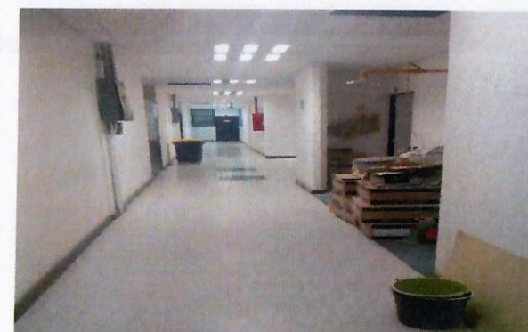
F32: Proceso de pintura en interiores.
