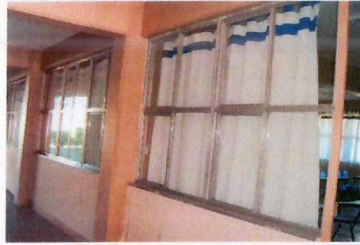
F10: Dasmontaje de puerias y ventanas metálicas
